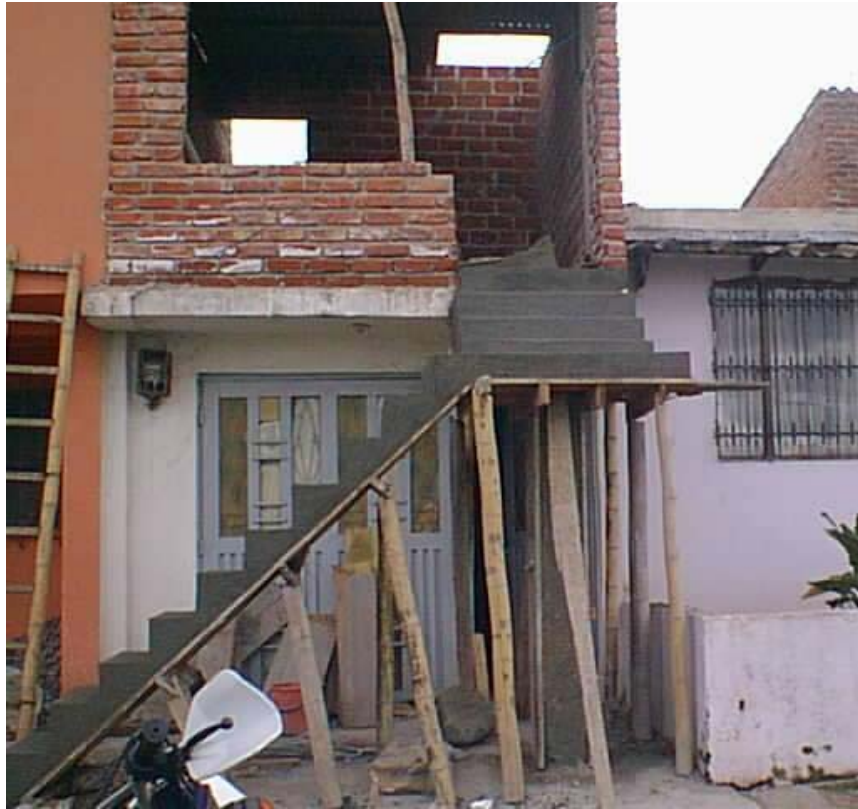
Figura 6. Gradas exteriores en concreto.
