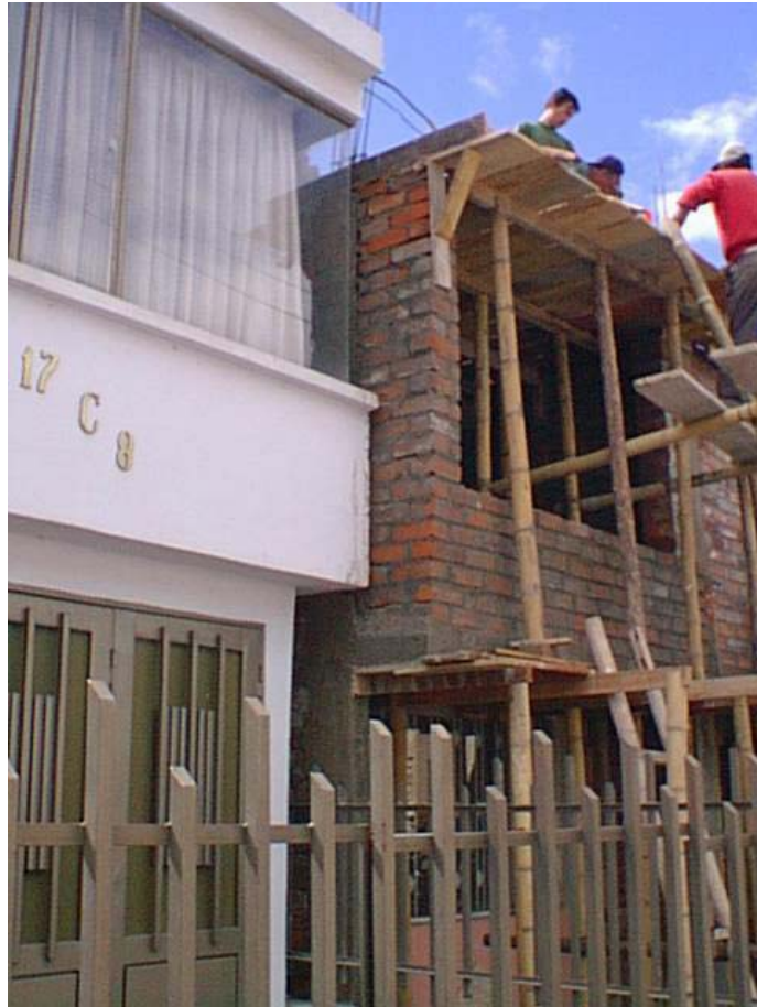
Figura 3. Construcción fuera del paramento.
