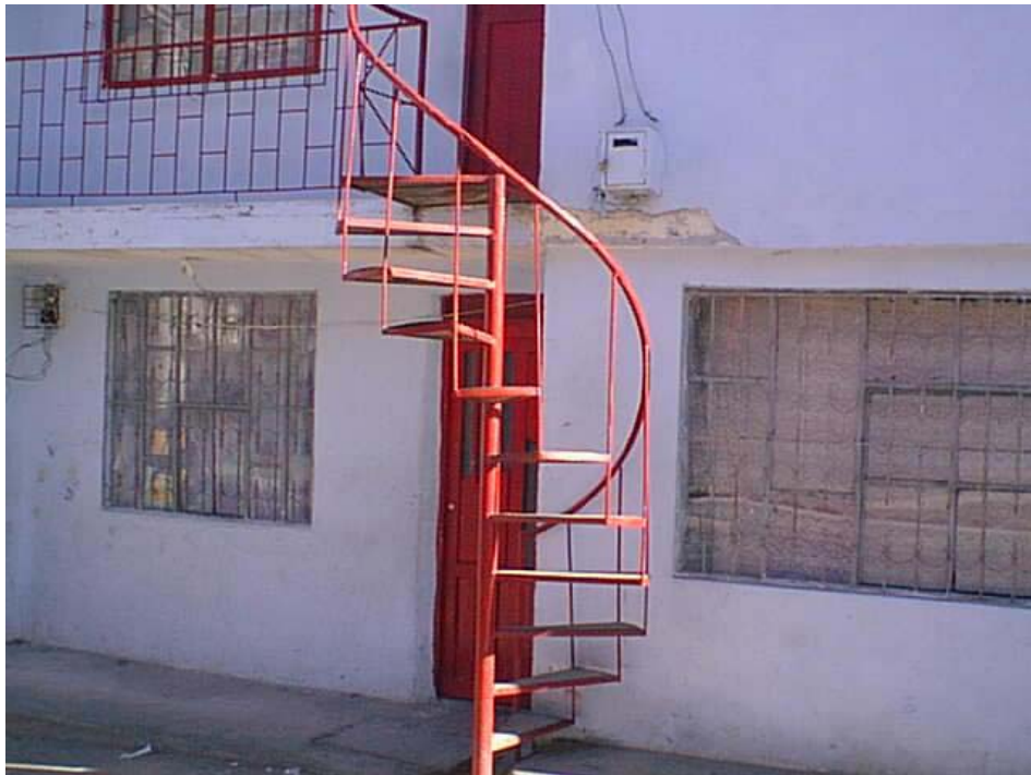
Figura 5. Gradas exteriores metálicas.
