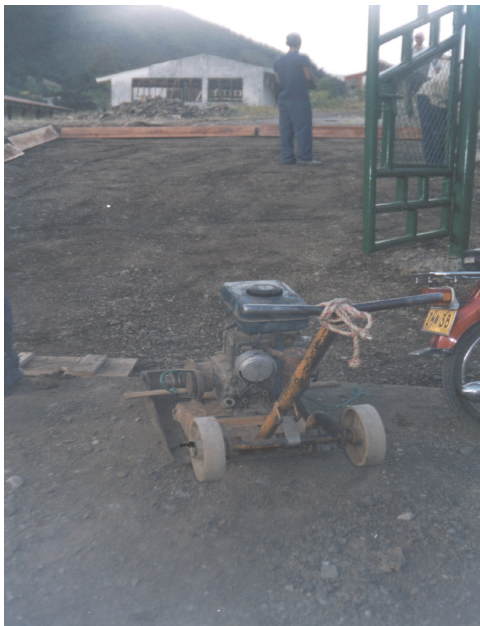
Figura 22. Compactación de la vía de acceso
