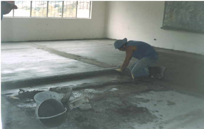
Figura 11. Nivelación de piso con mortero
