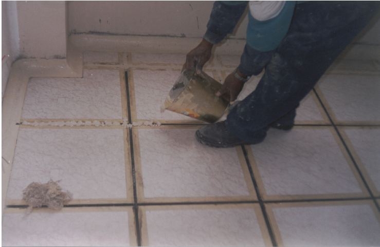
Figura 29. Aplicación de producto epóxico sobre juntas asépticas.
