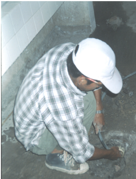
Figura 14. Sondeo a tuberías
