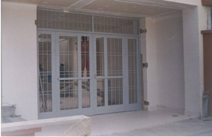
Figura 36. Instalación portón entrada principal
