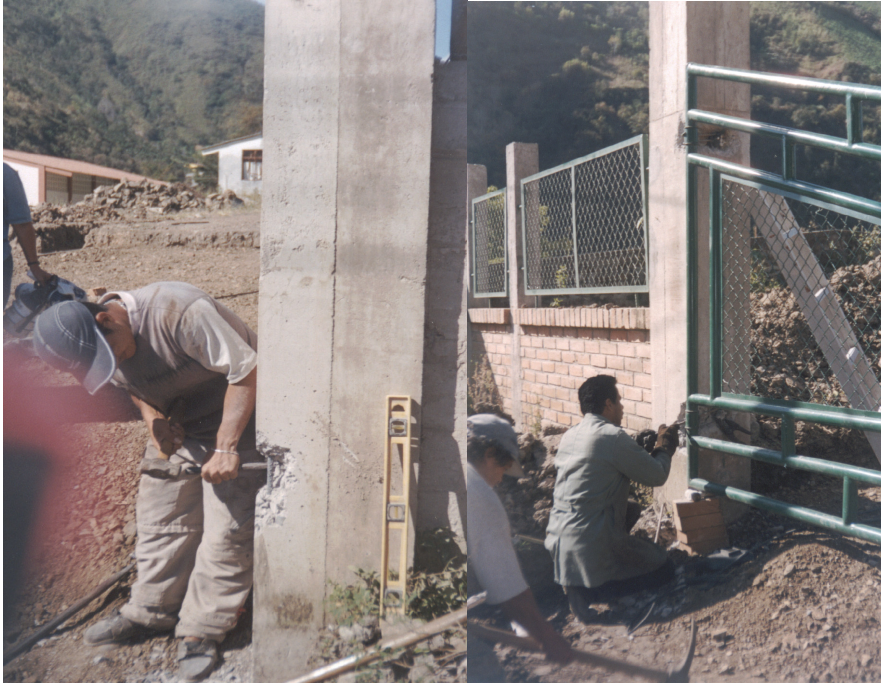
Figura 27. Instalación portón de entrada principal
