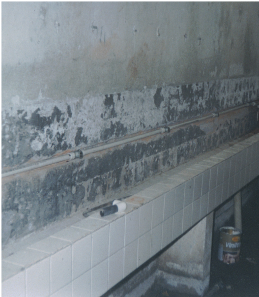
Figura 16. Instalación de tubería de agua potable
