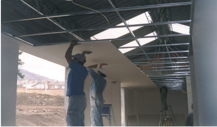
Figura 33. Instalación de placas de panel yeso
