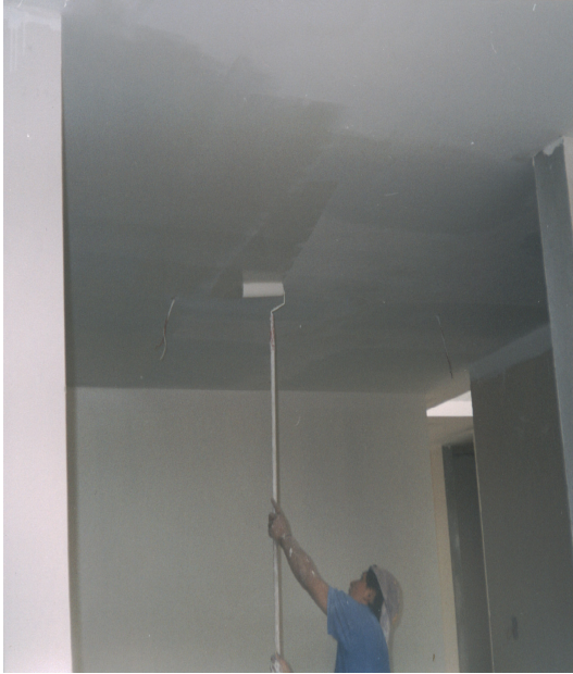
Figura 36. Pintura de cielo falso
