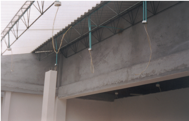
Figura 30. Instalación tubería y cajas para alumbrado
