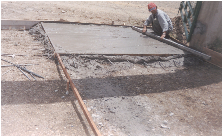
Figura 24. Nivelado del pavimento
