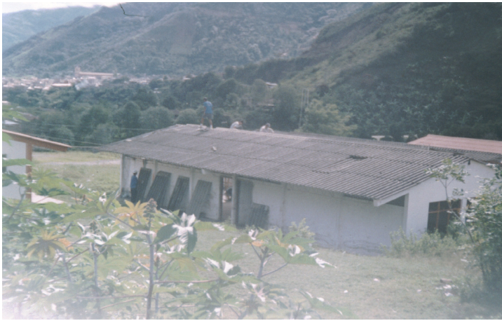
Figura 9. Retiro y limpieza de tejas de eternit
