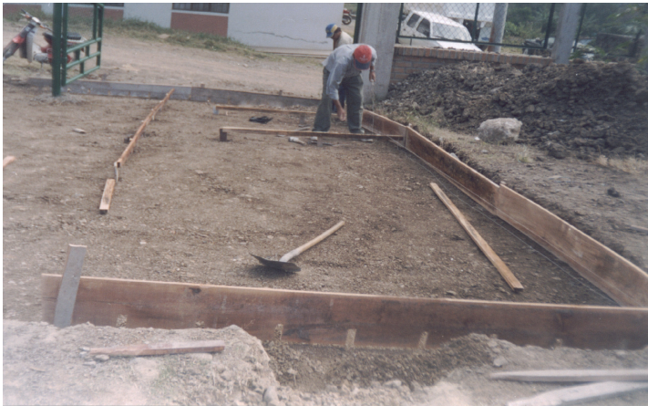
Figura 23. Colocación de formaleta
