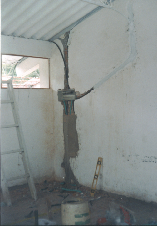
Figura 19. Instalación de tablero y ductos
