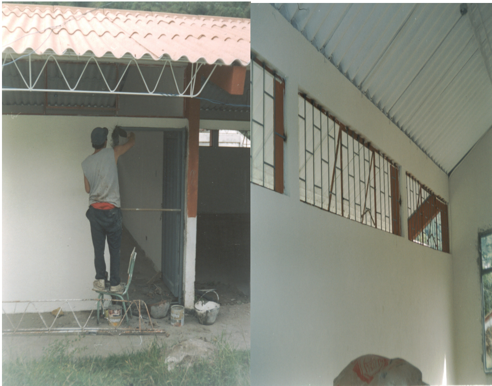
Figura 26. Instalación de puertas y rejillas metálicas
