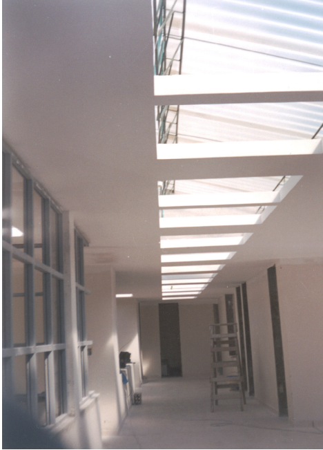
Figura 35. Resane de juntas y huecos con cinta y estuco
