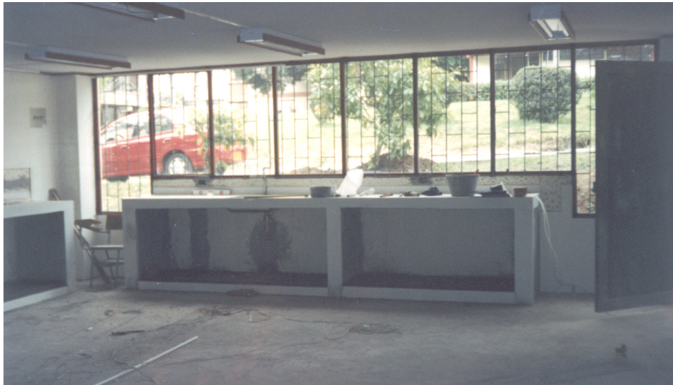
Figura 3. Construcción mesones con acabado en granito pulido
