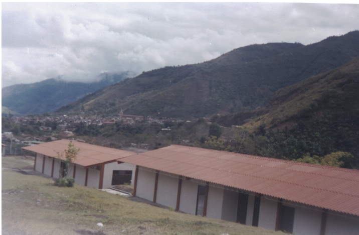
Figura 10. Colocación de cubierta pintada
