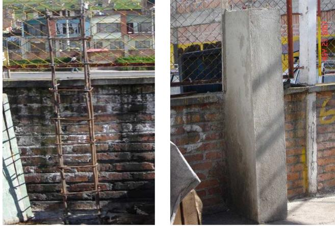
**FIGURA 17. - Armadura para columna y columna fundida**
