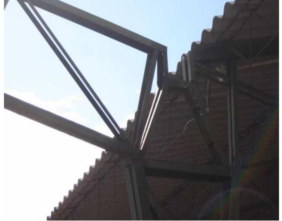
**FIGURA 19.** - Montaje de cercha metálica
