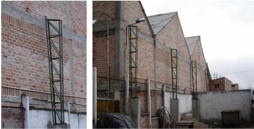
**FIGURA 18. - Montaje de columna metálica**
