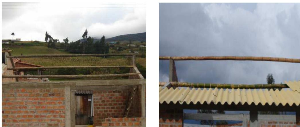
**FIGURA 29.** - Instalación de guadua y cubierta
