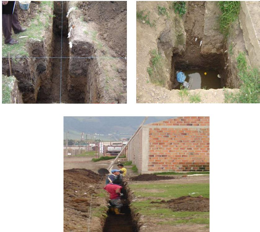
**FIGURA 6.** - Excavaciones pozos de inspección y tubería
