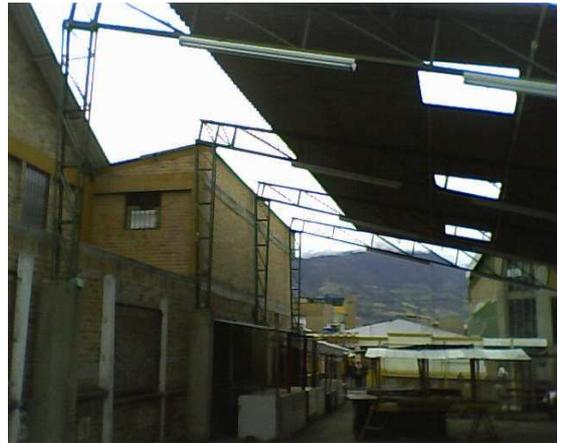
**FIGURA 20.** - Montaje de correas y cubierta
