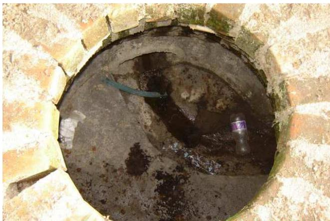
**FIGURA 8.** - Pozo de inspección construido
