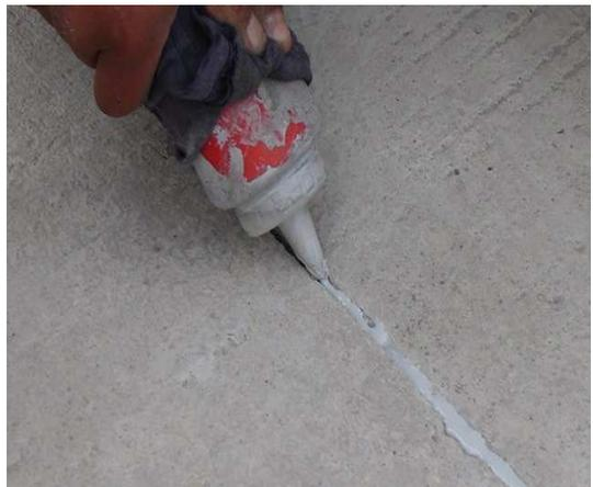
**FIGURA 24. - Fundición de sardineles y sellado de juntas**
