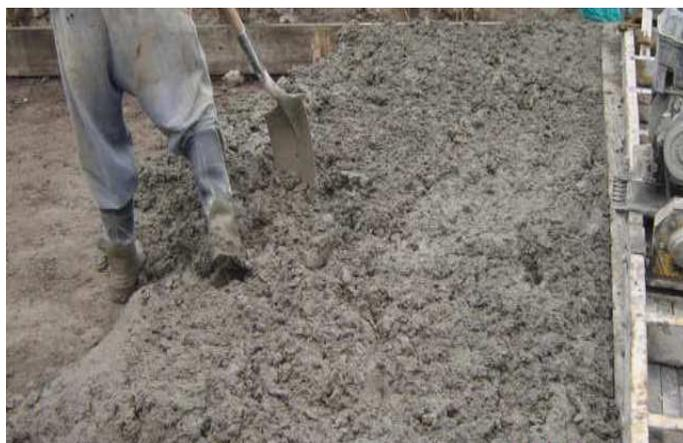
**FIGURA 22.** - Fundición de losa
