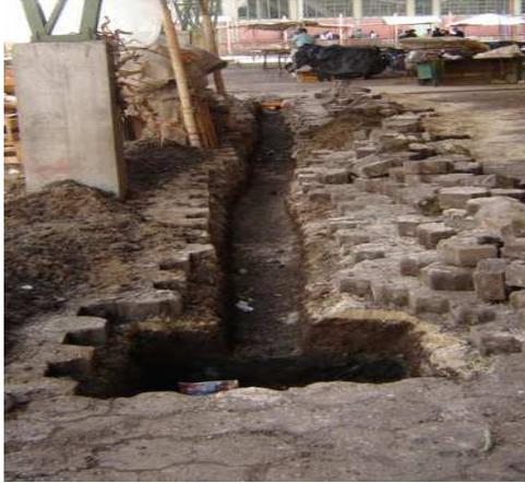
**FIGURA 14.** - Levantamiento de adoquín
