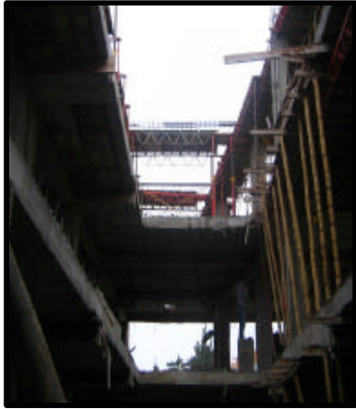
Figura 118. Formaletería reinicio de la obra.
