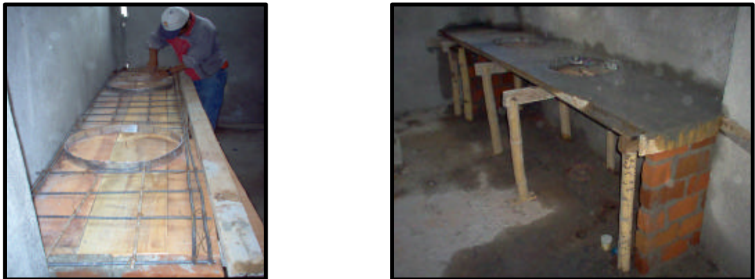
Figura 125. Fundición de mesones.
