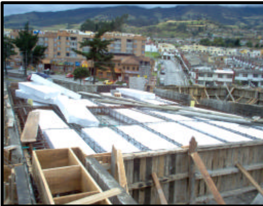
Figura 119. Colocación de casetones y ductos eléctricos.
