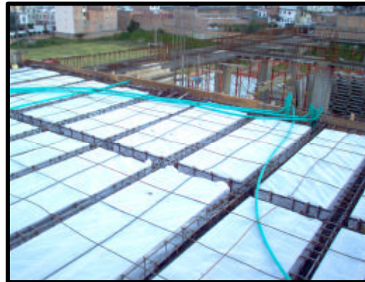
Figura 119. Colocación de casetones y ductos eléctricos.
