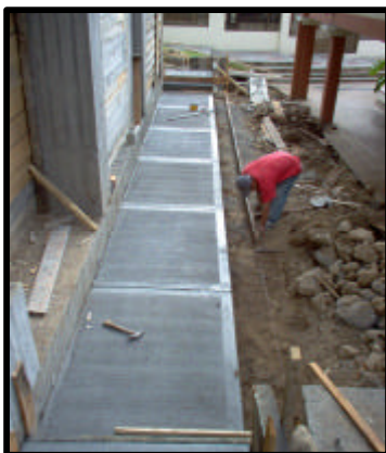
Figura 108. Terminado de andenes y cañuelas.
