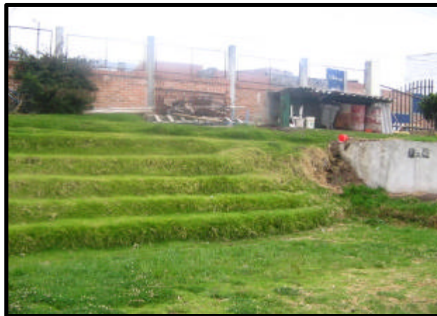
Figura 90. Área para construcción de Unidad sanitaria.
