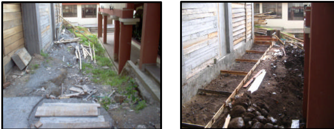
Figura 106. Armado de andenes.
