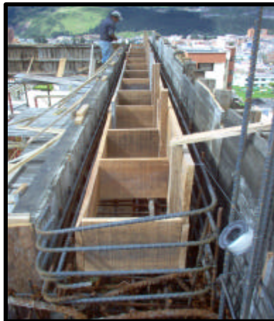
Figura 112. Formaletería en vigas canal.
