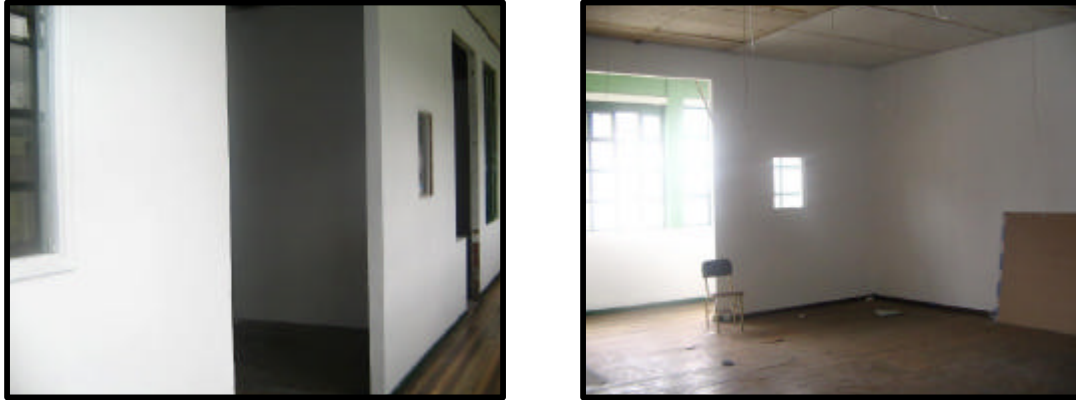
Figura 32. Espacio muro de ladrillo demolido y división en thermowall.
