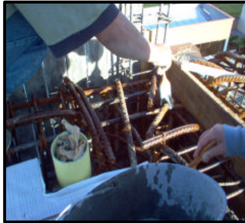
Figura 111. Aplicación de Pintóxido.
