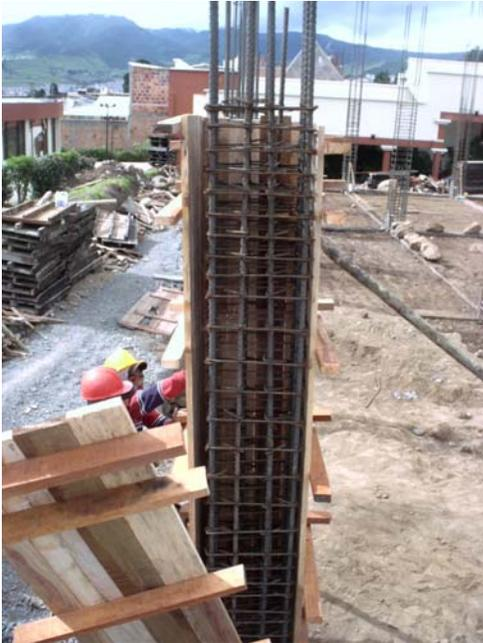
Figura 48. Alineación y aplome de columna
