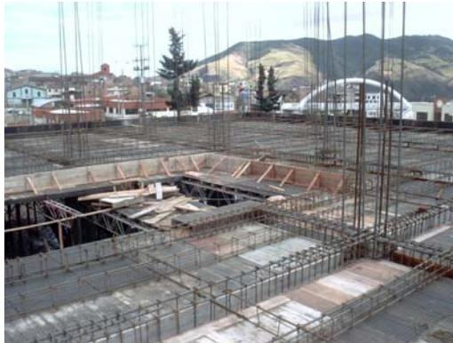
Figura 112. Refuerzo para losa de 3er.
