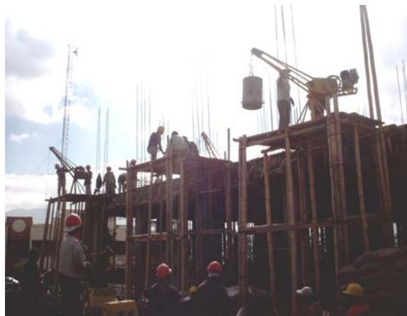
Figura 119. Fundición de losa 3er. Piso
