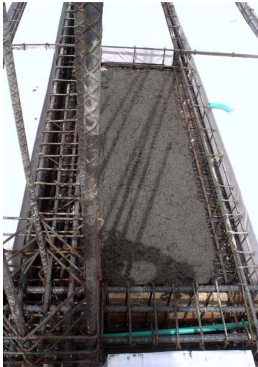
**4.7.11 Colocación de casetones.** A medida que se va colocando la capa de mortero se colocan los casetones previamente verificada su correspondiente sección.
