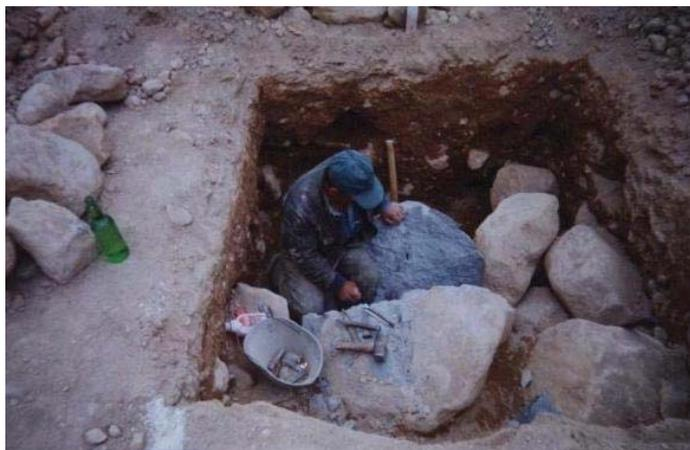
Desde el 16 de marzo, además de las excavaciones y cortes de piedra para zapatas, se comienza a hacer el desalojo interno o retiro de material excavado, hasta un área del patio de trabajo dispuesta para este fin.
