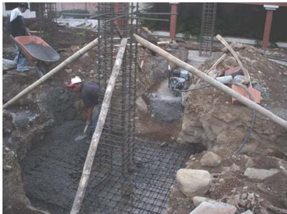
Figura 27. Vista general de las zapatas del bloque 2
