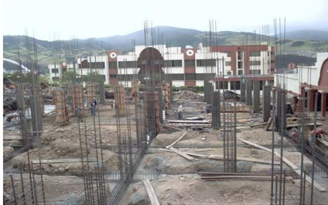
Figura 32. Encofrado de vigas de cimentación
