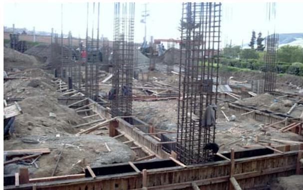
Figura 33. Vista general de la obra, encofrado de vigas de cimentación
