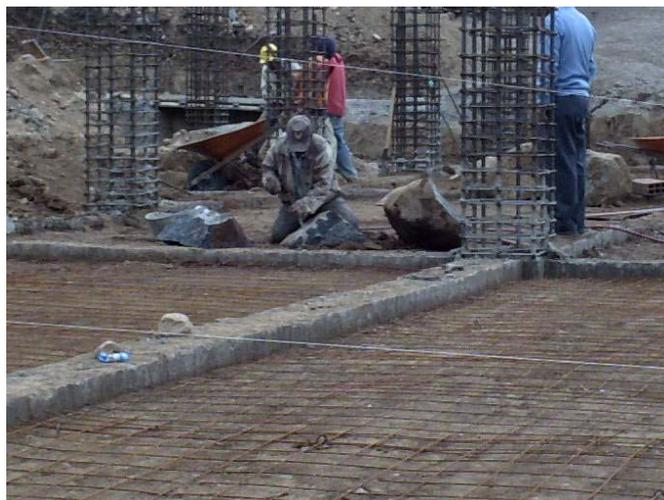
Figura 40. Malla electrosoldada
