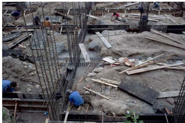
**4.4.7 Fundición de vigas de cimentación en concreto de 3000psi.** Una vez listo el refuerzo de las vigas de cimentación y colocados los tableros laterales de éstas, se funden las vigas con un concreto de dosificación 1:2:3 para 3000psi.
