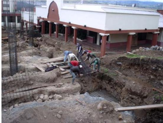
Se arman los tableros de formaleta para columnas y se encofran las columnas del bloque 1.
