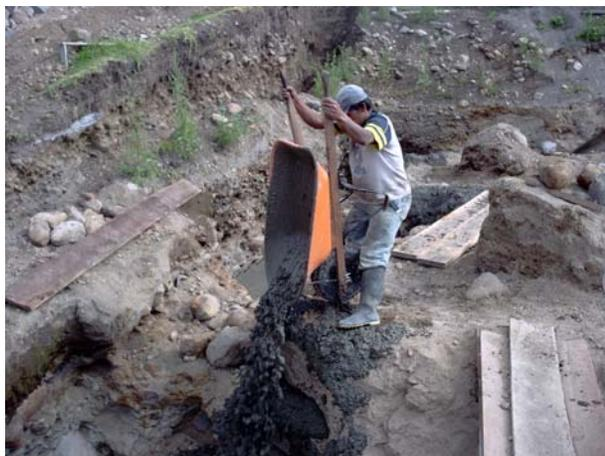
El concreto ciclópeo se prepara utilizando aproximadamente un 60% de rajón, en este caso se utilizó el proveniente de los cortes de piedra realizados durante las excavaciones; y un 40% del concreto de 3000psi utilizado en la cimentación. Se
