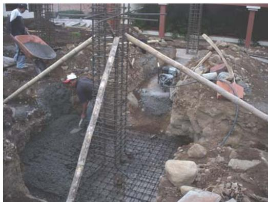
El 18 de junio se funden solados de limpieza con concreto pobre elaborado con 1 bulto de cemento, 16 baldes de arena y 12 baldes de triturado por cochada.
