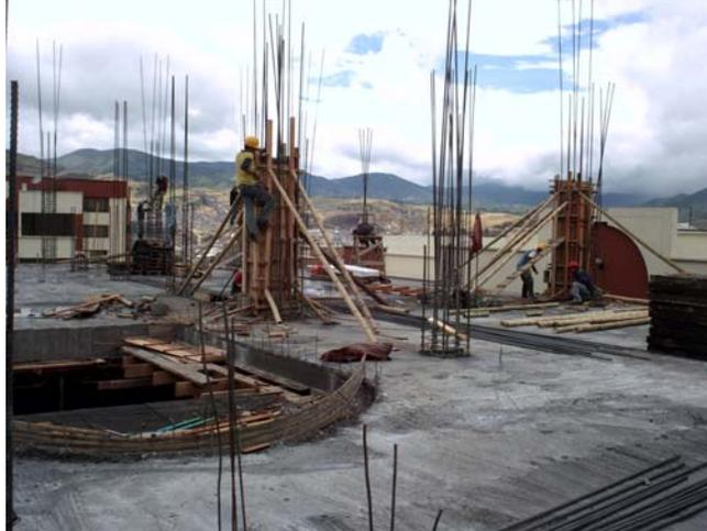
Figura 101. Fundición de columnas de 2do. Piso bloque 1
