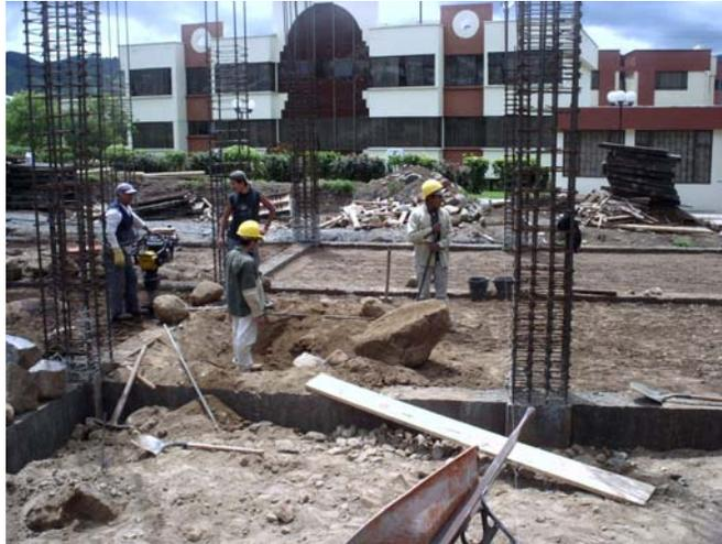
**4.5.2 Colocación de refuerzo para placa de piso.** Se tiende una malla electrosoldada sobre la superficie del suelo, con el propósito de controlar los esfuerzos de retracción y temperatura producidos por el concreto y así evitar que se produzcan fisuras. Para lograr que el refuerzo quede situado a la mitad de la altura de la placa se colocan soportes de material granular que ayudan a levantar la malla y así se logra uniformidad.
