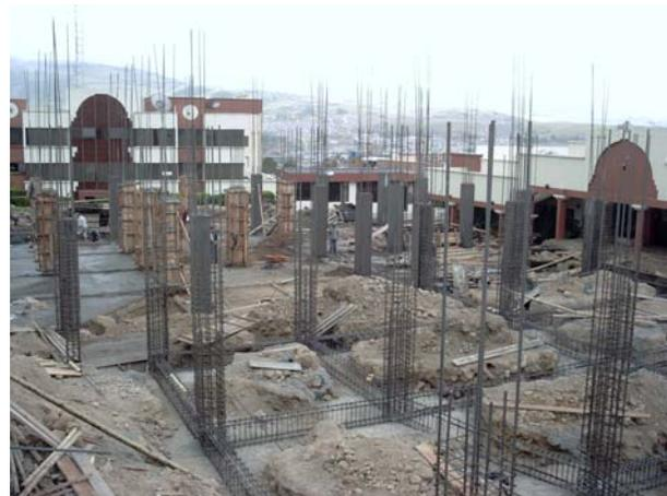
El 26 de julio se comienza a armar formaleta para vigas de 2do. Piso del bloque 1 y se arregla el piso del bloque 2.
