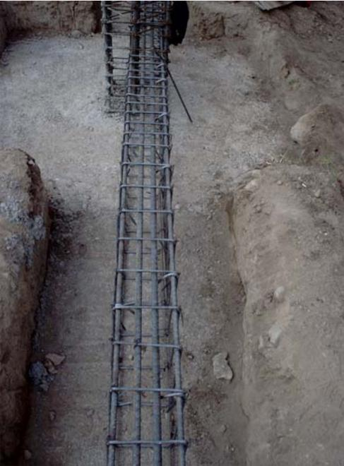
Figura 30. Detalle de intersección de refuerzo de columna y viga de cimentación
