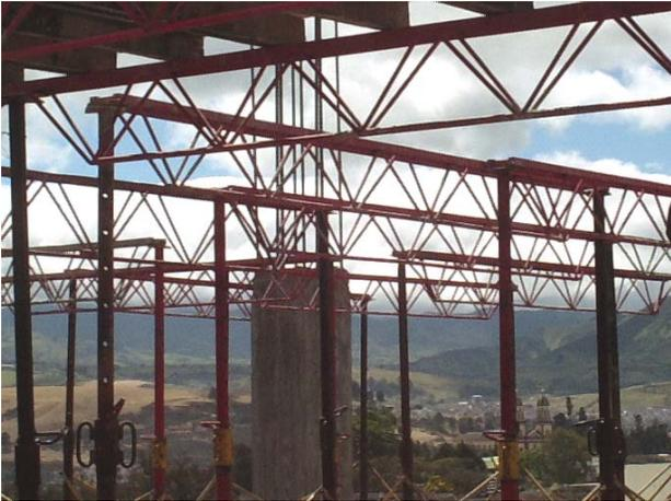
Figura 106. Armado de losa de 3er. Piso
