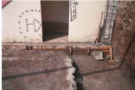
Figura 139. Detalle de la base del muro de contención en concreto ciclópeo
