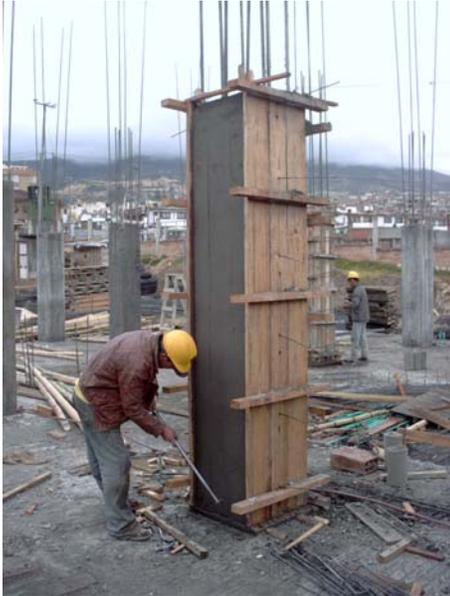
El 1 de septiembre se comienza a armar la formaleta para las vigas de 3er piso del bloque 1, una vez formaleteado, se procede a amarrar las vigas, armar la formaleta de la losa de 3er. piso del bloque 1 y tender y amarran los nervios de la losa.
