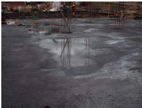
El 21 de agosto se funde la losa de 2do piso del bloque 2, luego se inicia el armado de columnas de 2do piso, las cuales después de ser revisadas, se funden, desencofran y curan.
