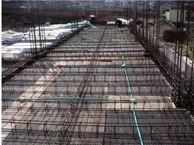
13 de agosto se funde el solado inferior de la losa de 2do piso del bloque 1 con un mortero de dosificación 1:4.
