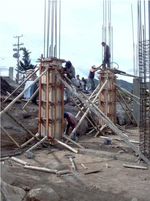
**4.6.5 Fundición de columnas.** Antes de comenzar la fundición se hace una revisión de la verticalidad y se autoriza la fundición. Es necesario que la base este húmeda antes de vaciar el concreto. A medida que se funde la columna se vibra el concreto.
