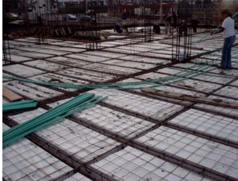
Figura 117. Fundición de solado inferior de losa 3er. Piso
