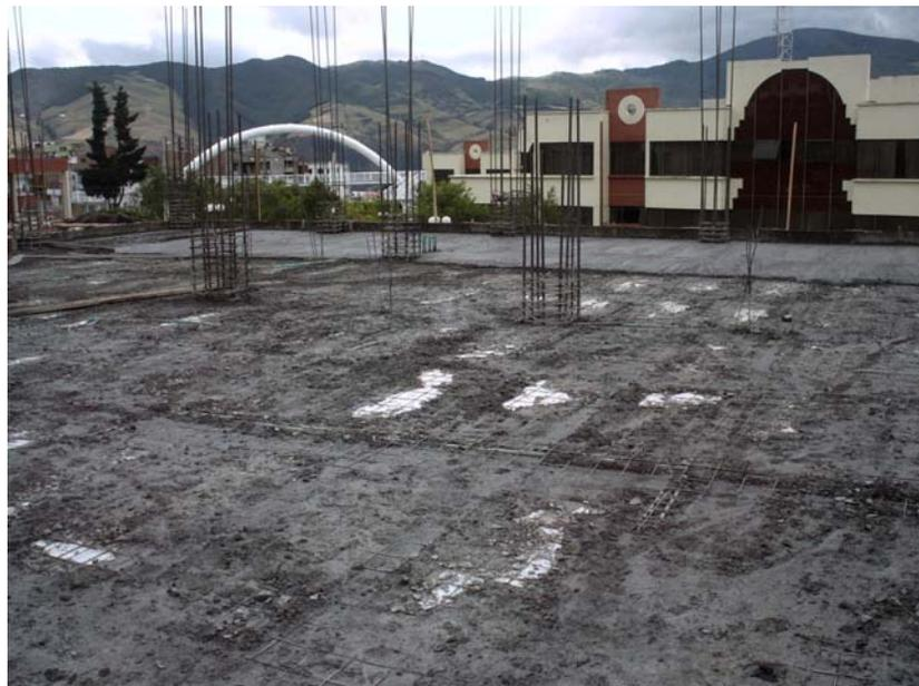
**4.7.14 Curado del concreto para losas.** Al día siguiente de haber fundido las losas empieza el proceso de curado el cual continua durante varios días. Se hace mediante el rociado de agua varias veces al día y algunas veces en la noche con el fin de que permanezca siempre húmedo.
