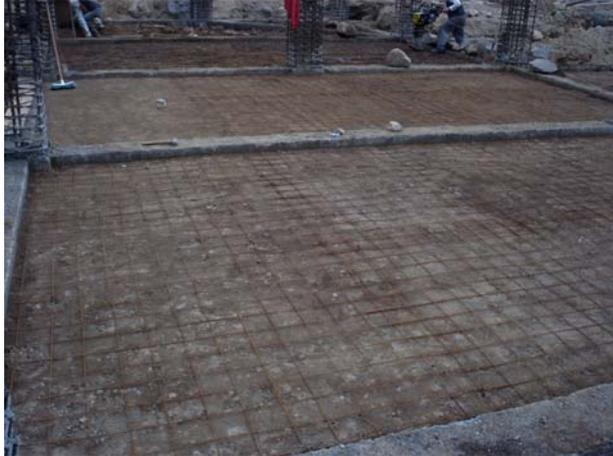
Figura 86. Vista general – losa de piso
