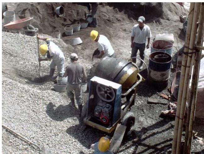
**3.5.2 Transporte de concreto.** El concreto es transportado por medio de carretillas hasta el lugar de vaciado. Fue necesario también utilizar rampas y pontones armados con tablones y guaduas y para la fundición en los niveles superiores, se elevó el concreto con pluma grúa.
