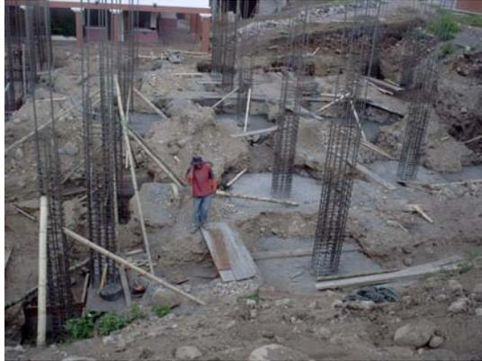
**4.4.5 Cimentación de solado en concreto pobre para vigas de cimentación.** Se limpia, adecua y humedece la superficie del suelo antes de fundir un solado en concreto pobre de 8cm. Este solado de limpieza, como su nombre lo indica, permite que el concreto de la viga de cimentación no se contamine.
