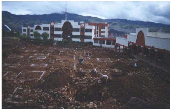
En estos días se hace el levantamiento topográfico necesario para el diseño de la nueva área de parqueadero que albergará los vehículos de los usuarios de las dependencias de la VIPRI.
