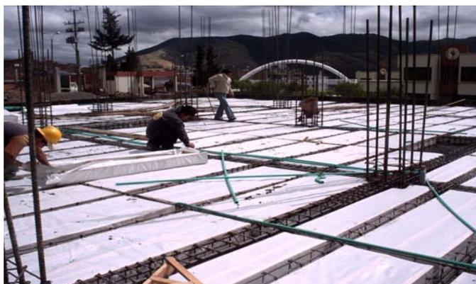
**4.7.10 Fundición de solado inferior de losa.** Antes de proceder a la fundición de esta loseta se colocan los casetones con el fin de verificar que no queden espacios. Una vez hecho esto se retiran y se procede a fundir la placa de mortero que servirá como cielo raso del piso inferior. Se utiliza una mezcla de mortero con una dosificación 1:4.
