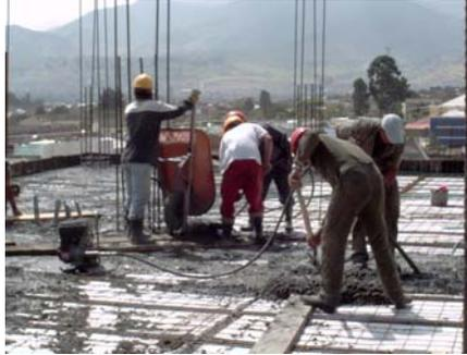
Figura 120. Fundición de losa 3er. Piso bloque 1
