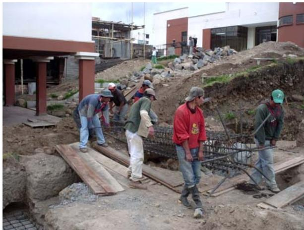
Figura 83. Hincado de castillo para columna
