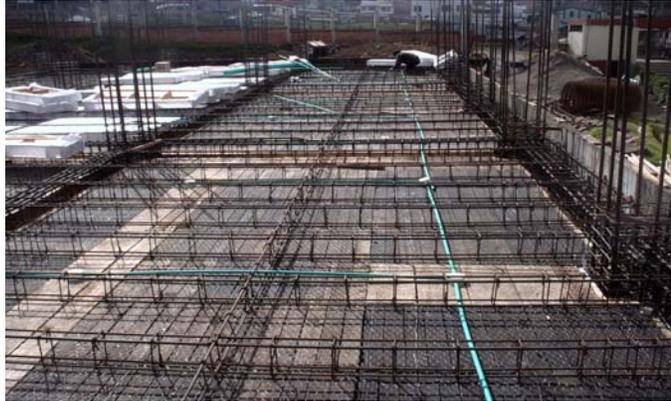
Figura 56. Colocación de casetones en losa de bloque 1
