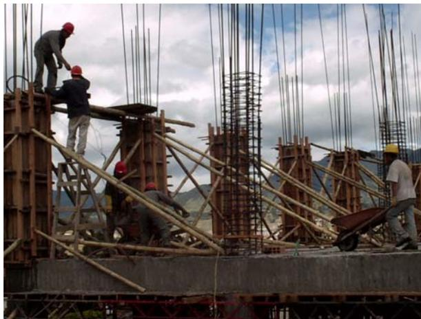
Figura 102. Fundición de columnas de 2do. Piso bloque 2
