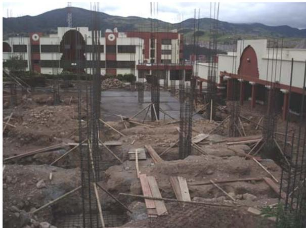
Después de chequear la alineación y la verticalidad de las columnas, se comienza a fundir las columnas del bloque 1.
