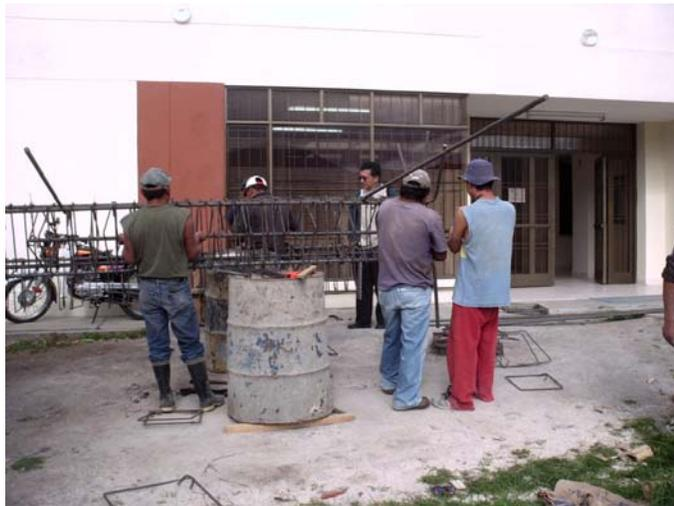
**4.6.3 Levantamiento y alineación de castillos para columnas.** Una vez armados los castillos, se procede a trasladarlos hasta su sitio en donde se hincan por medio de cuerdas y con cables hechos con alambre de amarre. Se alinean los castillos por medio de un hilo guía y se aploman antes de fundir las zapatas.
