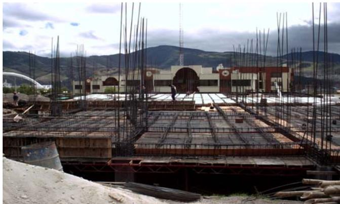
Figura 57. Colocación de casetones y tubería eléctrica
