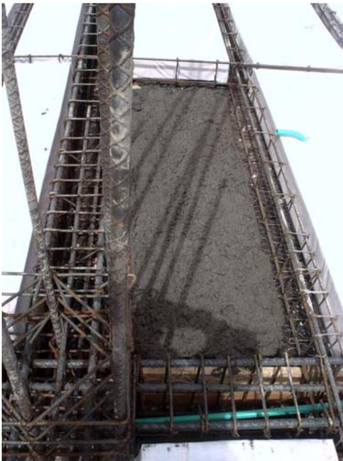
Figura 95. Colocación de casetones
