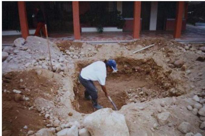
Figura 68. Corte de piedra encontrada en excavación de zapata
