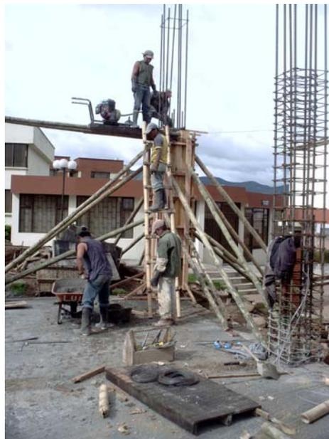
El 20 de julio se comienza a fundir solados para vigas de cimentación del bloque 2 y se funde la otra parte de la losa de piso del bloque 1.
