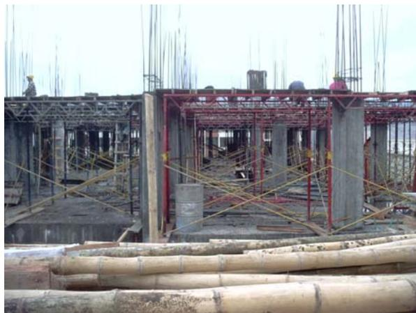
Figura 110. Armado de refuerzo para losa de 3er. Piso bloque 2
