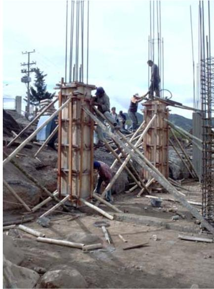
Figura 88. Fundición de columna 1er. Piso
