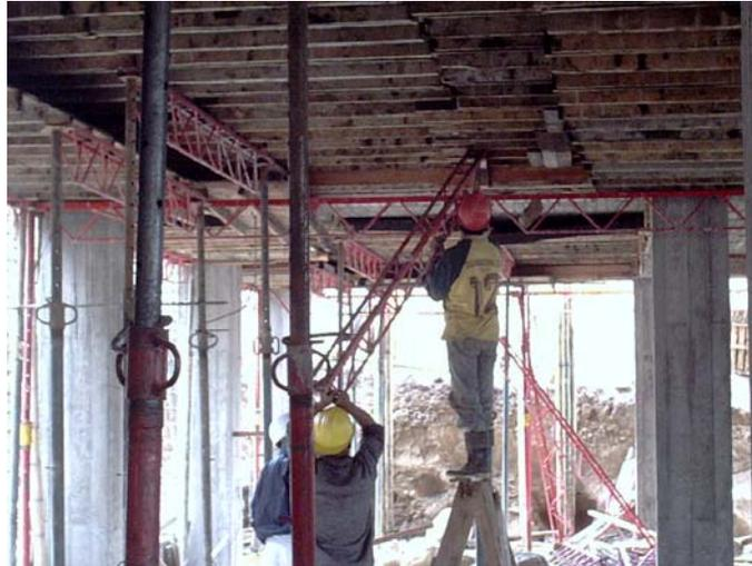
Figura 125. Detalle de losa con viga descolgada
