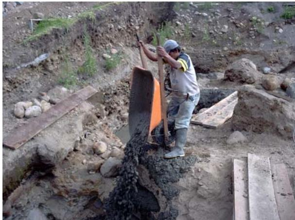
El 10 de julio se funden las vigas de cimentación del bloque 1 y se comienza a armar castillos para columnas del bloque 2.
