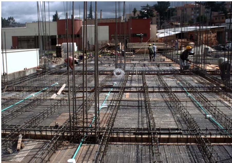
Figura 55. Colocación de tubería de red para instalaciones eléctricas, voz y datos
