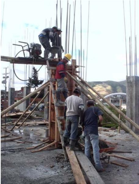
Figura 103. Retiro de formaleta de columnas
