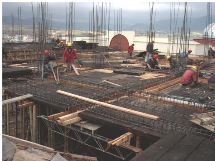
**4.7.5 Distribución de nervios.** Los nervios en la losa no se distribuyeron de acuerdo a los planos de plantas estructurales, ya que en estos figuraban los nervios entre ejes de columnas, los cuales los convertían en elementos estructurales de los pórticos, sabiendo que los nervios son elementos no estructurales encargado de distribuir la carga a las vigas.
