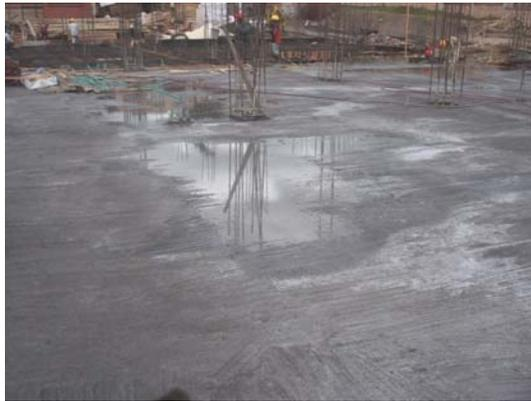
**4.7.15 Desencofrado.** Después de que se ha comprobado en laboratorio mediante el ensayo de cilindros a compresión que la resistencia de la losa excede del 70% de la requerida, intervectoría da la autorización de quitar la formaleta. De esta forma se comienza a desencofrar la losa retirando uno a uno los elementos que hacen parte de la formaleta.
