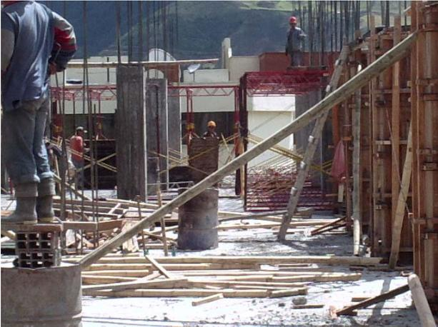
Figura 105. Detalle de formaleta para losa de 3er. Piso
