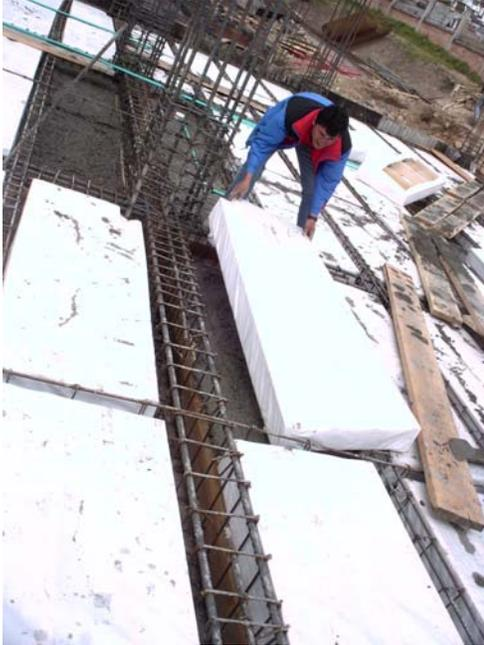
Figura 96. Colocación de casetones y tubería para instalaciones eléctricas
