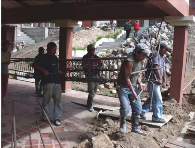
Figura 46. Levantamiento de castillos para columnas
