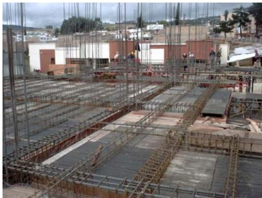
Figura 113. Detalle de nudo de refuerzo para losa de 3er. Piso
