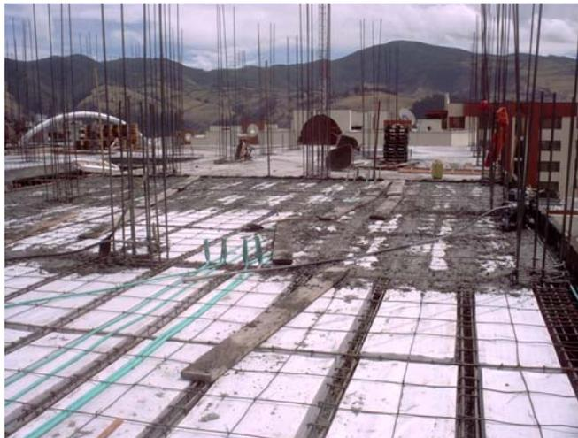
23 de septiembre se desencofra la losa del 1er piso del bloque 2
