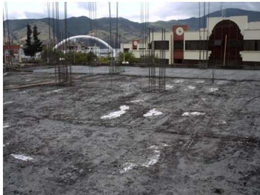
Figura 99. Curado de losa
