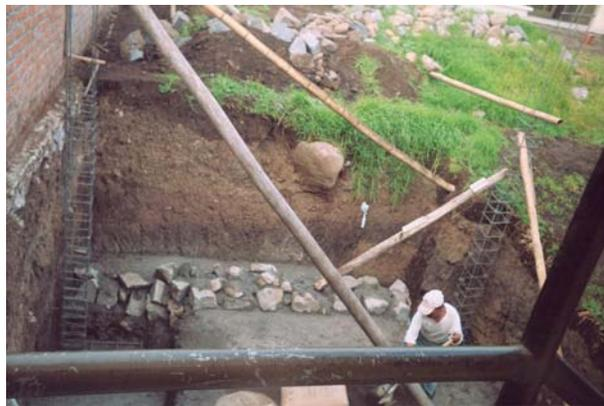
Figura 140. Solado para la base del muro de contención en concreto reforzado
