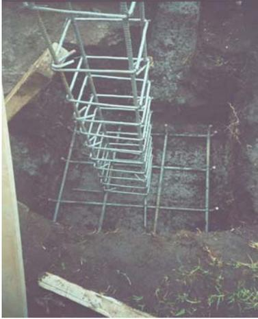
Figura 138. Conformación de vigas de cimentación
