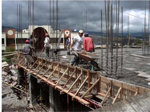
Figura 98. Fundición de losa
