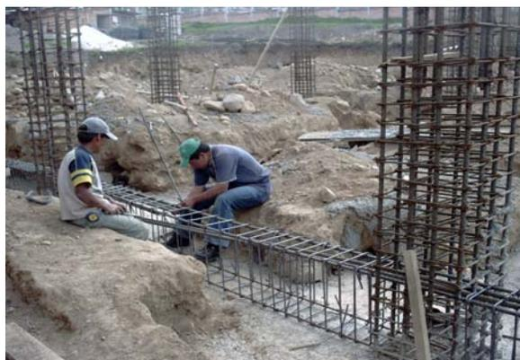
Figura 29. Detalle de vigas de cimentación
