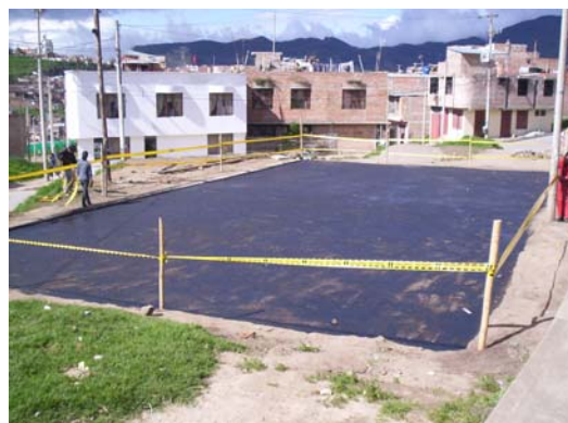
FIGURA 58.- Base imprimada con emulsión asfáltica, vista sur norte del polideportivo
