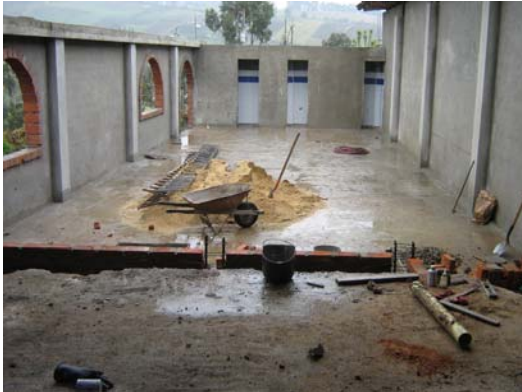
FIGURA 131.- Repello interior de muros.
