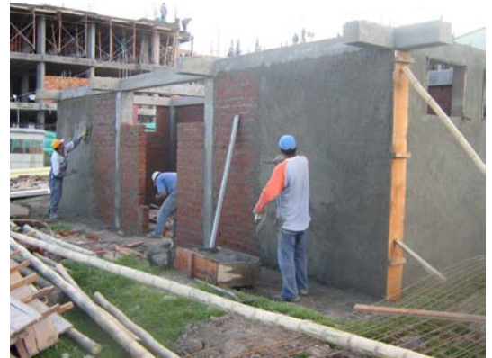
FIGURA 117.- Repello de Muros en la parte exterior de la batería sanitaria.
