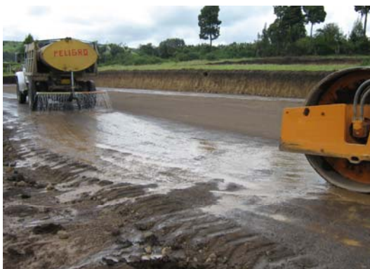
FIGURA 68.- Compactación de base en recebo cancha de chaza inferior e=0.15 m
