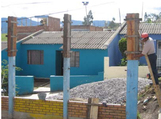
FIGURA 93.- Formaleta para columnas parte sur del polideportivo
