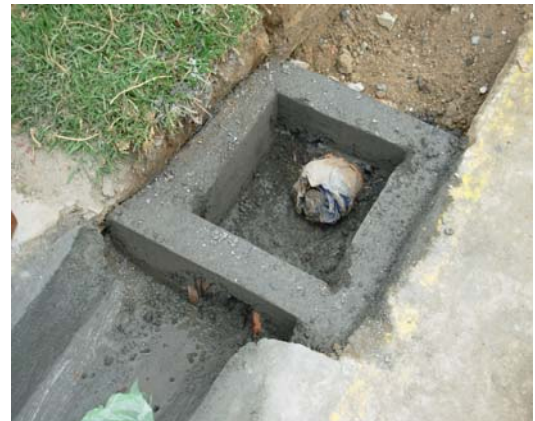
FIGURA 10.- Cajilla con conexión
