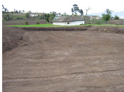
FIGURA 67.- Excavación a máquina polideportivo
