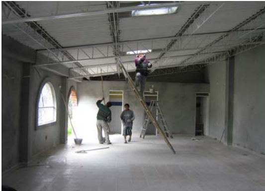
FIGURA 138.- Pintura en vinilo de cielo raso de cubierta.
