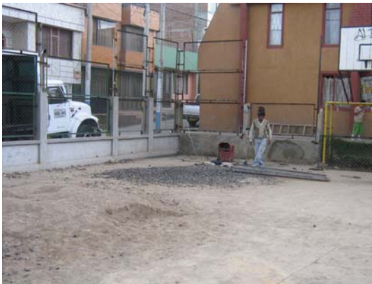
FIGURA 13.- Instalación de cerramiento reparado
