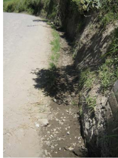
FIGURA 106.- Limpieza y rocería de cuneta de la vía.
