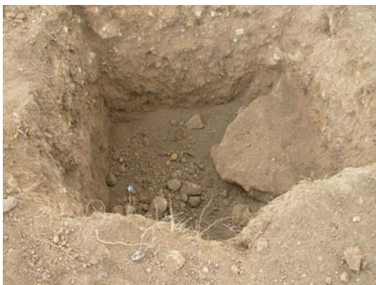
FIGURA 15.- Apíque en el terreno ubicado a 2.50 m de la parte lateral derecha, 10.0 m. sentido norte sur del terreno en construcción.
