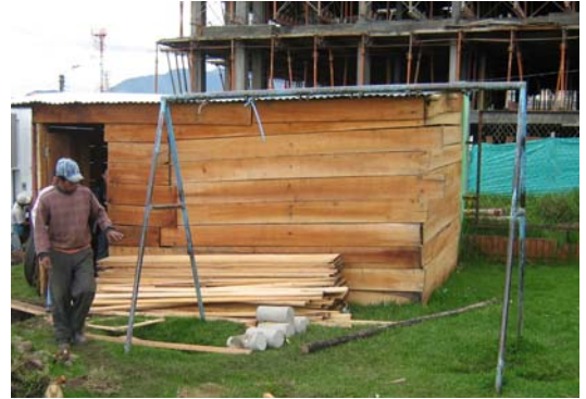
FIGURA 108.- Campamento de la obra.
