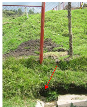
FIGURA 100.- Salida de aguas lluvias del polideportivo hacia la escuela
