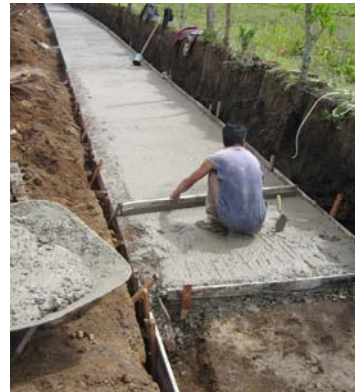
FIGURA 71.- Fundición de andenes en concreto
