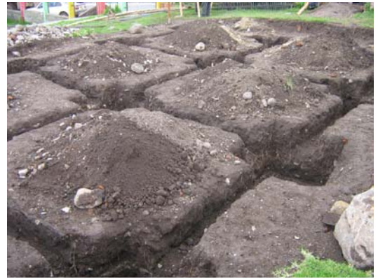
FIGURA 110.- excavación manual para la cimentación.
