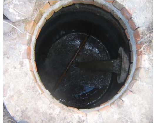
FIGURA 37.- Pozo de inspección
