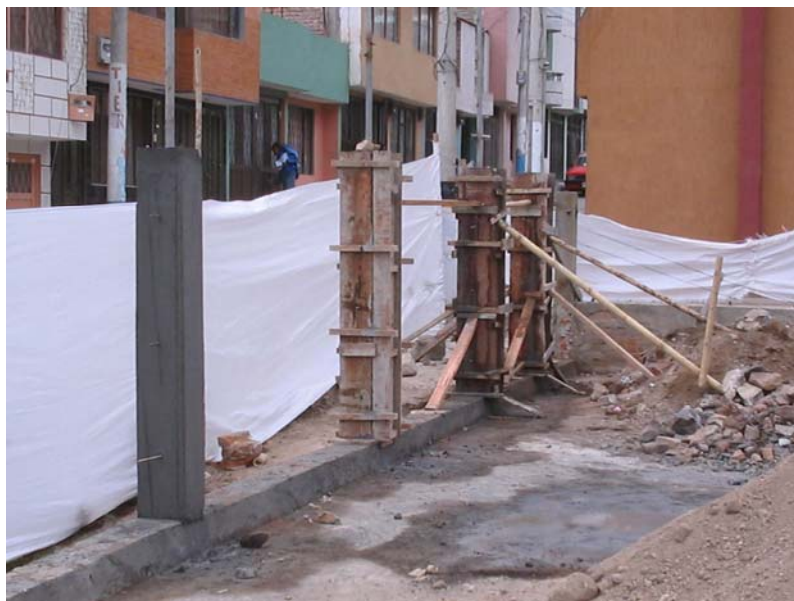
FIGURA 8.- Columnas en concreto reforzado sobre muro de contención
