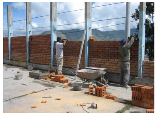
FIGURA 94.- Muro en mampostería y columnas fundidas, parte lateral derecha del polideportivo
