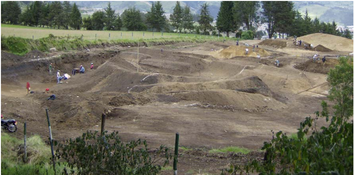
FIGURA 44.- Estado del proyecto hasta la fecha de terminación de pasantía, vista desde la parte lateral izquierda del acceso a la pista
