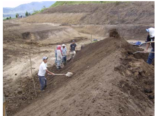
FIGURA 39.- Conformación de montículos
