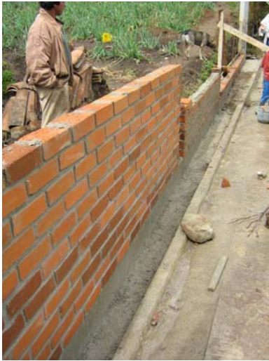
FIGURA 120.- Muro en mampostería, lado derecho del polideportivo.
