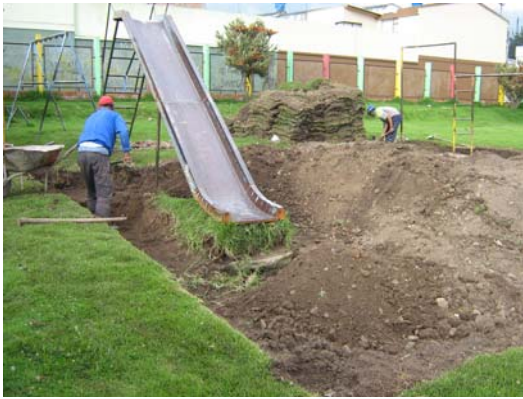
FIGURA 109.- Descapote, excavación manual y demolición de juegos infantiles existentes.
