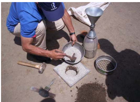
FIGURA 57.- Ensayo de densidad in situ (cono y arena) en la parte sur central del polideportivo
