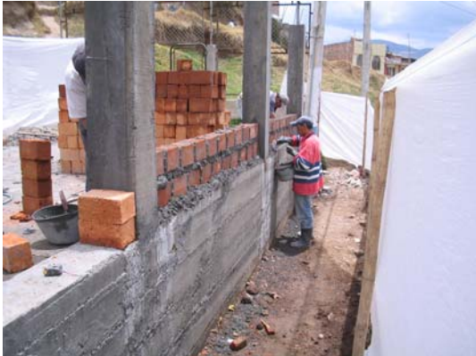
FIGURA 11.- Muro en mampostería
