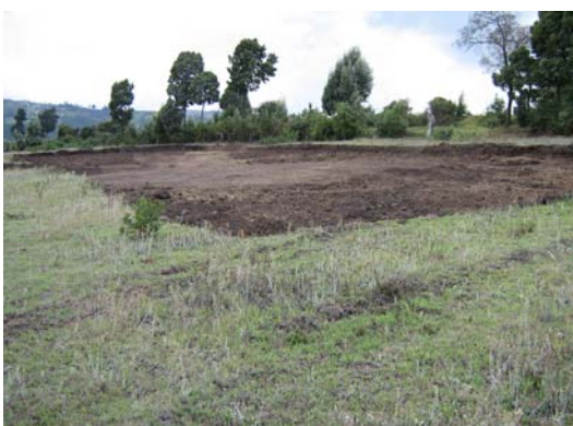
FIGURA 66.- Excavación a máquina cancha de chaza superior
