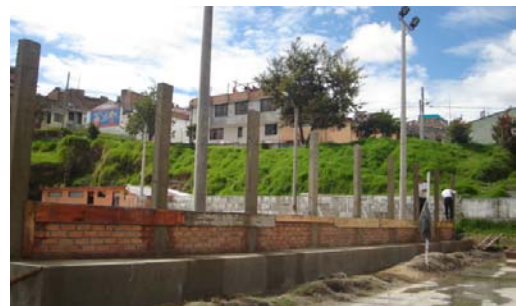
FIGURA 86.- Columnas y viga sobre muro fundidas en concreto reforzado.
