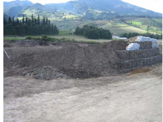
FIGURA 41.- Muro en gaviones en la primera curva de pista
