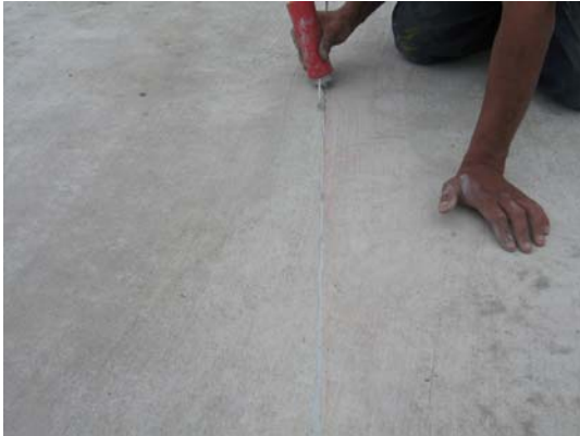
FIGURA 27.- Sellado de juntas
