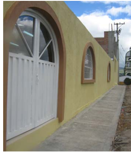
FIGURA 143.- Pintura en vinilo de la parte exterior del salón, andén en concreto, carpintería metálica y vidrios
