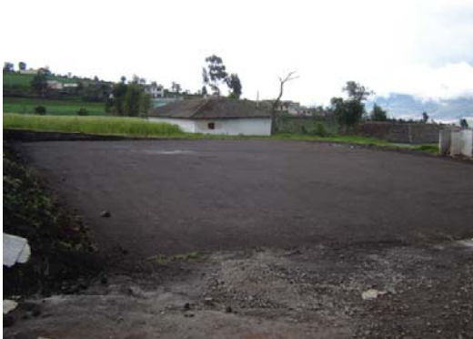
FIGURA 70.- Base granular compactada en polideportivo e=0.15 m
