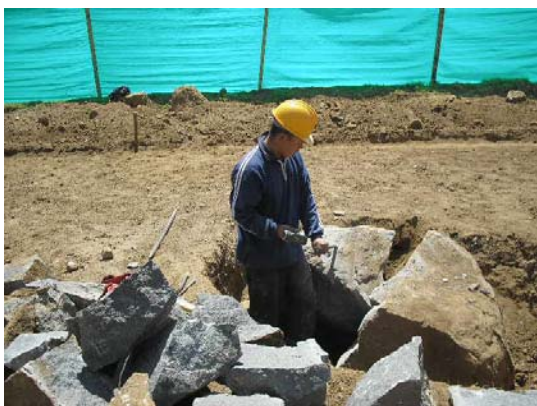
FIGURA 17.- Corte de roca ubicada a 2.5 m. lateral, 16.3 m sentido norte sur del terreno.
