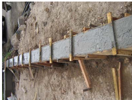
FIGURA 147.- Viga de cimentación fundida en concreto.
