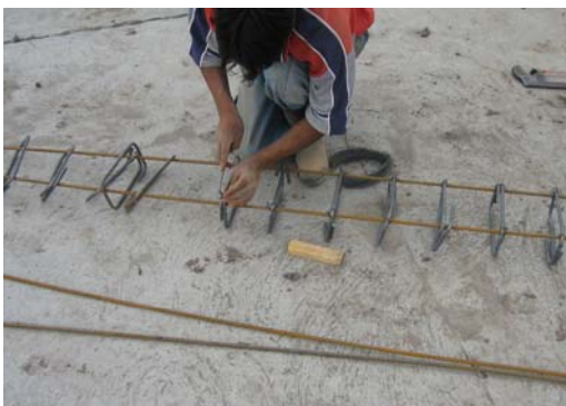
FIGURA 79.- Armado de acero de refuerzo para columnas.
