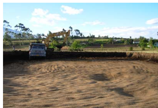
FIGURA 65.- Excavación a máquina y desalojo de material orgánico
