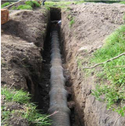
FIGURA 36.- Instalación de tubería en concreto de 16”
