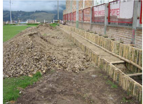
FIGURA 50.- Relleno con recebo de la gradería y mallas pintadas e instaladas
