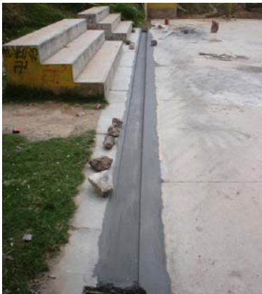
FIGURA 9.- Cuneta en concreto, lado derecho de cuneta.
