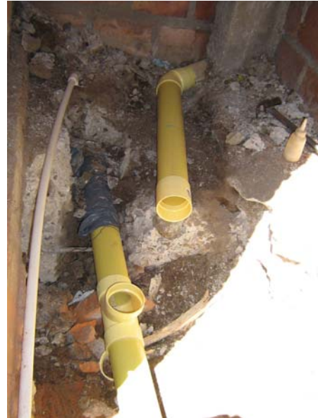
FIGURA 130.- Instalación de redes hidráulicas de ½" en PVC y sanitarias de 4" en PVC, vista interior en los baños.
