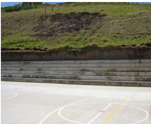
FIGURA 99.- Talud lateral derecho junto a polideportivo
