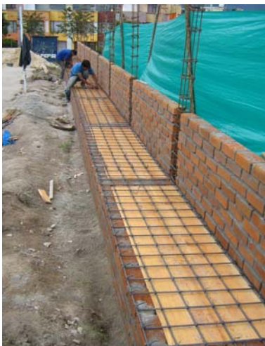
FIGURA 81.- Muro de protección en ladrillo y construcción de gradería (Armado de acero de refuerzo para placa en concreto)
