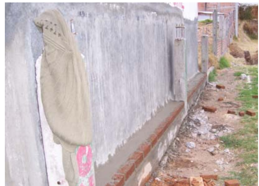
FIGURA 46.- Desmonte de cerramiento en malla y ángulo existente
