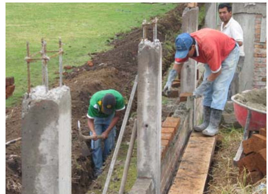
FIGURA 48.- Construcción de muro en mampostería y excavación manual para gradería
