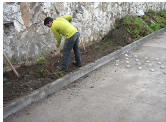
FIGURA 92.- Excavación manual para andenes en la parte exterior del polideportivo
