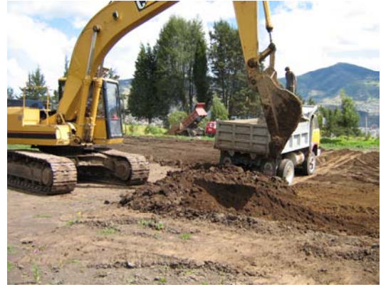
FIGURA 31.- Nivelación de terreno parte central de la futura pista.
