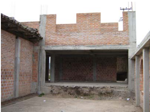
FIGURA 125.- Estado inicial del salón cultural, vista hacia la tarima.
