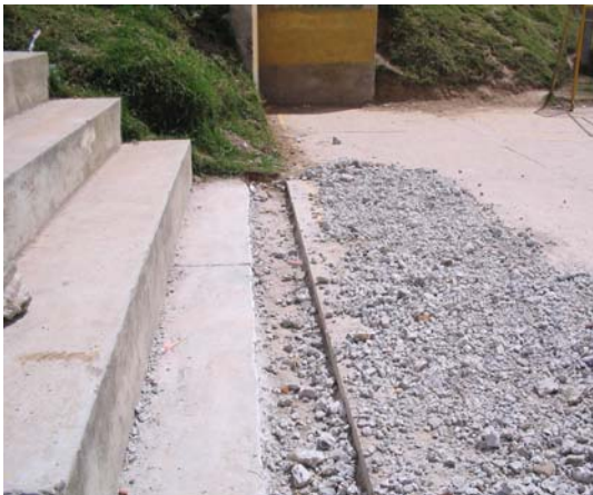
FIGURA 4.- Demolición cuneta existente.
