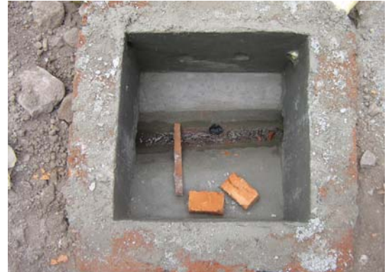
FIGURA 115.- Detalle caja de derivación que recoge el agua servida de las duchas, ubicada en la parte central de la batería sanitaria.
