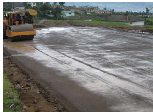
FIGURA 69.- Compactación de base en recebo cancha de chaza inferior e=0.15 m
