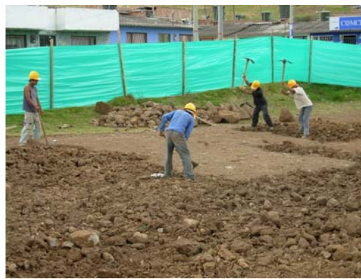
FIGURA 16.- Excavación manual en la parte norte del polideportivo
