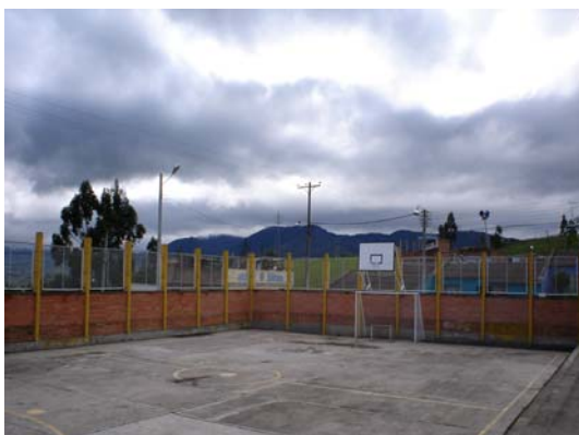
FIGURA 97.- Proyecto terminado, vista interior, sentido norte sur
