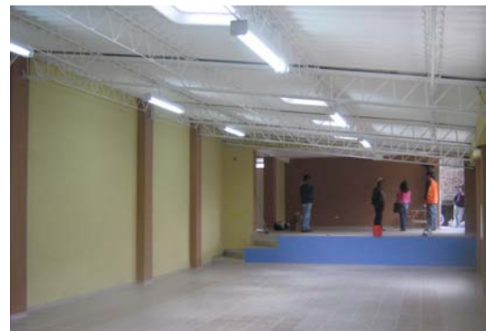
FIGURA 141.- Pintura en vinilo de la tarima del salón cultural, instalaciones eléctricas.
