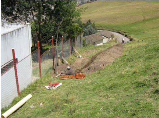
FIGURA 101.- Excavación manual de zanja
