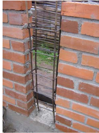
FIGURA 121.- Acero de refuerzo para columnas, lado derecho del polideportivo.
