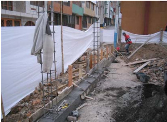
FIGURA 6.- Muro de contención en concreto ciclópeo.
