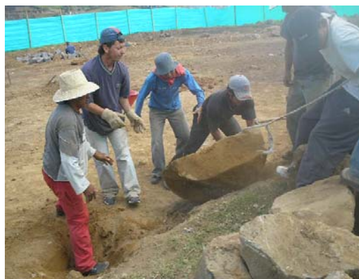
FIGURA 18.- Desalojo de roca que no fue demolida
