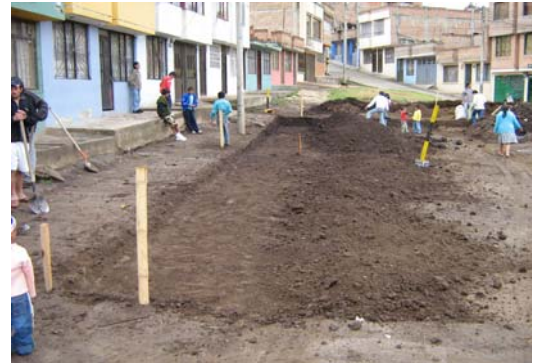
FIGURA 54.- Excavación manual parte lateral izquierda
