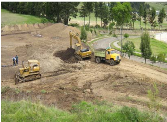
FIGURA 32.- Desalojo de material proveniente de excavación
