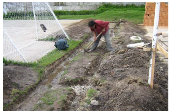
FIGURA 78.- Excavación manual para cimentación de muro de cerramiento y graderías.
