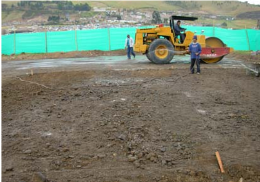
FIGURA 19.- Compactación de base en recebo
