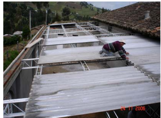
FIGURA 135.- Instalación de cubierta en asbesto cemento.
