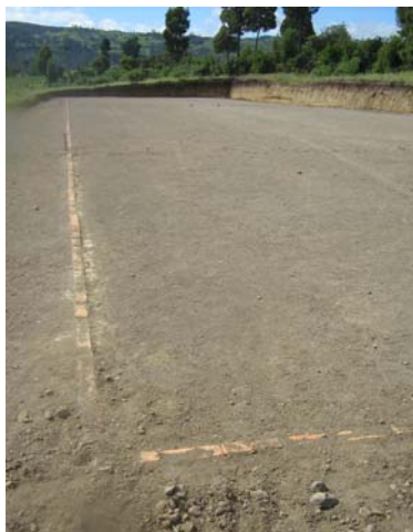
FIGURA 74.- Líneas de demarcación en ladrillo cancha de chaza superior
