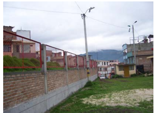
FIGURA 52.- Cerramiento costado derecho terminado
