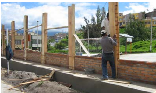
FIGURA 85.- Formaleta de Columnas y gradería terminada.
