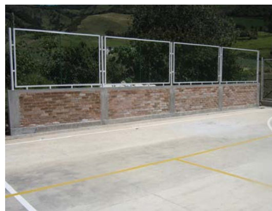
FIGURA 124.- Cerramiento de protección costado derecho terminado
