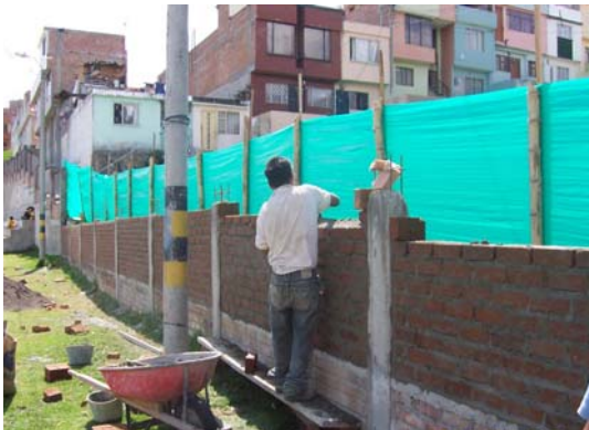
FIGURA 47.- Construcción muro en mampostería costado derecho de la cancha
