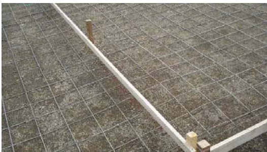
FIGURA 21.- Formaleta y malla electro soldada
