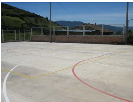
FIGURA 123.- Cerramiento de protección costado izquierdo terminado
