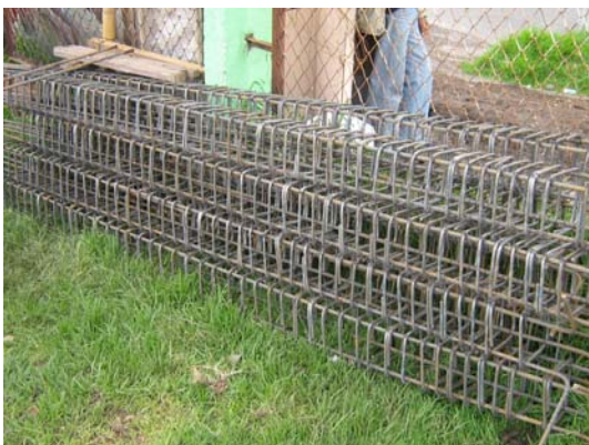
FIGURA 111.- Acero de refuerzo para estructura en concreto
