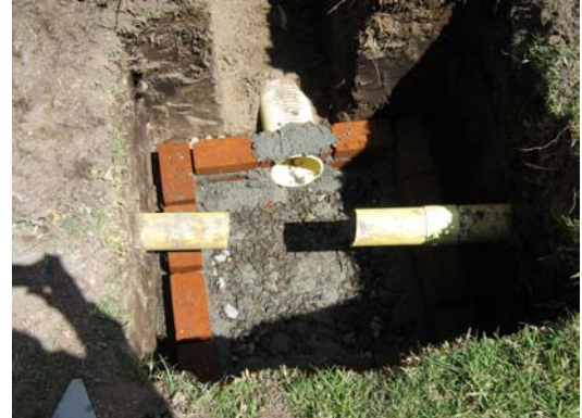
FIGURA 102.- Tubería PVC 10" instalada, construcción caja en mampostería e interrupción de la tubería existente
