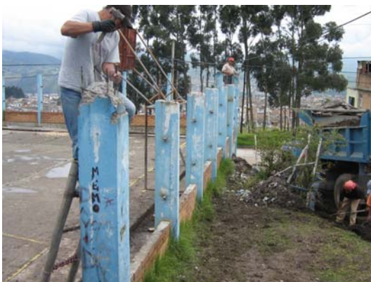
FIGURA 91.- Demolición de 25 cm. de columnas en concreto en la parte sur del polideportivo
