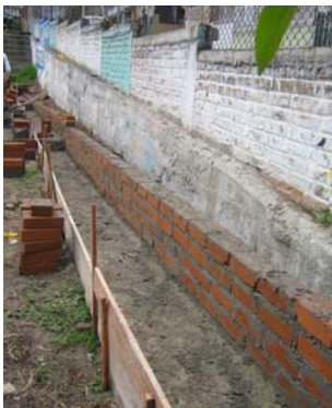
FIGURA 83.- Construcción de gradería 2.
