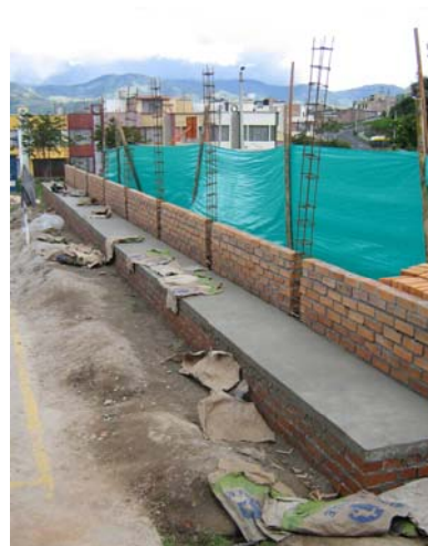
FIGURA 82.- Placa en concreto de gradería terminada
