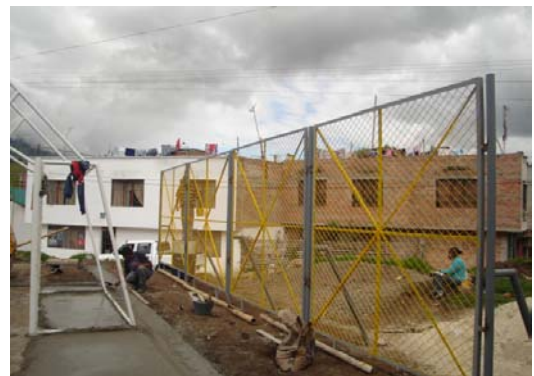
FIGURA 62.- Instalación de cerramiento de protección en la parte norte del polideportivo.
