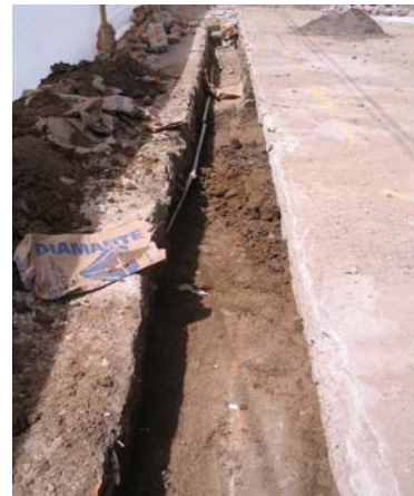
FIGURA 5.- Excavación manual para muro de contención.
