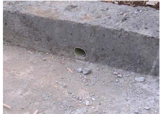
FIGURA 7.- Orificio de evacuación de agua lluvia en el muro de contención.
