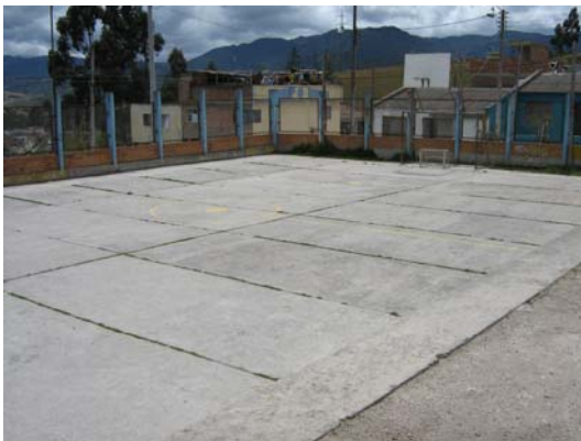
FIGURA 89.- Estado inicial del escenario deportivo, vista sentido norte sur
