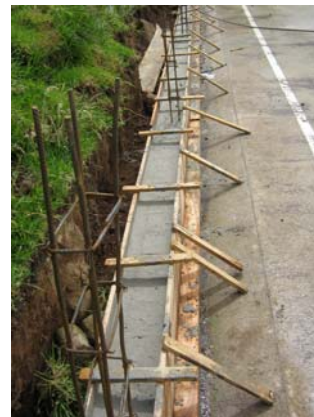
FIGURA 119.- Cimentación del cerramiento lado izquierdo del polideportivo.
