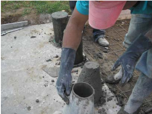
FIGURA 23.- Toma de cilindros y ensayo de slump, en la placa fundida a 6.66 m. de la esquina sur occidental del polideportivo.
