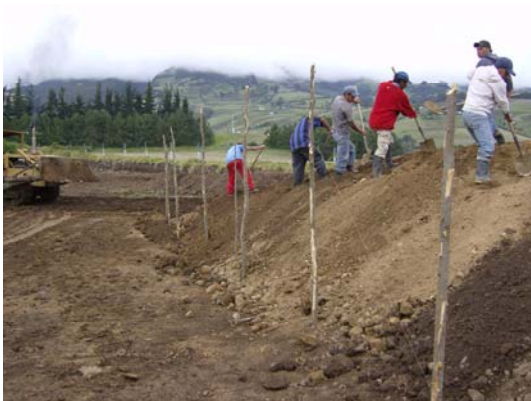
FIGURA 38.- Conformación de montículos
