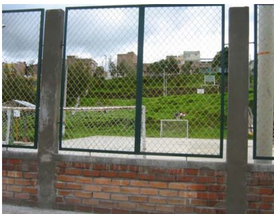
FIGURA 87.- Cerramiento en malla y ángulo instalado y pintado
