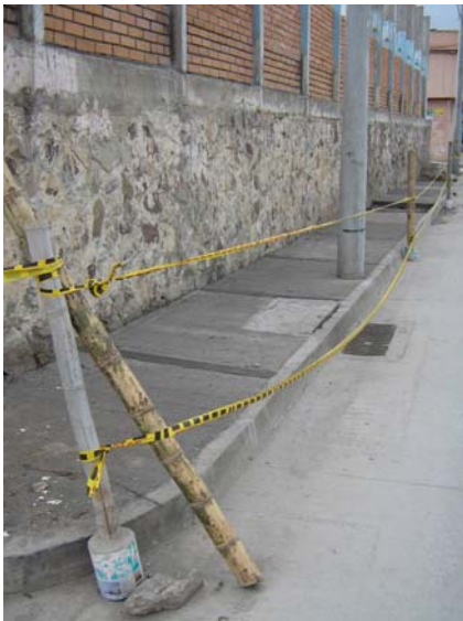
FIGURA 95.- Andenes en concreto, parte exterior del polideportivo
