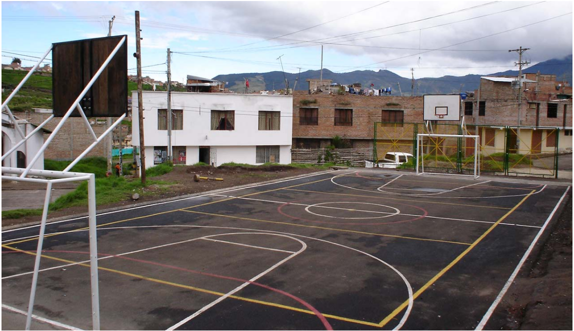
FIGURA 63.- Polideportivo terminado, vista sur norte.
