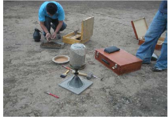
FIGURA 20.- Ensayo de densidad (Cono y arena) en la parte central del área a construir
