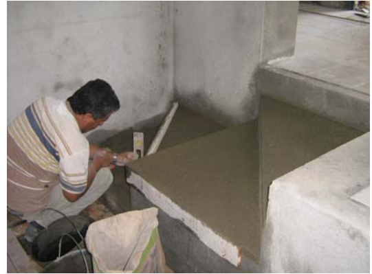
FIGURA 137.- Repello de gradas en concreto.
