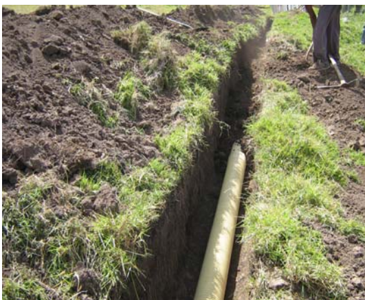
FIGURA 103.- Relleno de zanja
