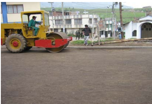
FIGURA 55.- Compactación de base en recebo
