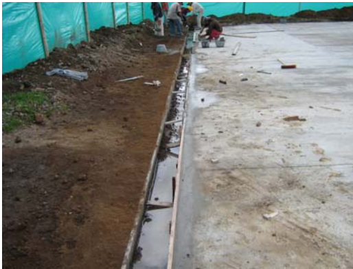
FIGURA 25.- Cunetas en concreto
