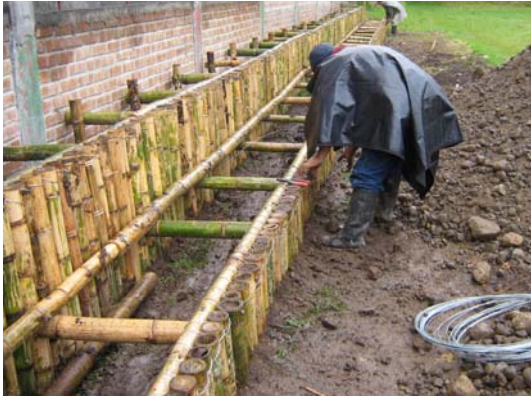
FIGURA 49.- Estructura en guadua de la gradería
