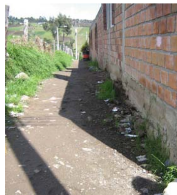
FIGURA 128.- Estado inicial del exterior del salón cultural.
