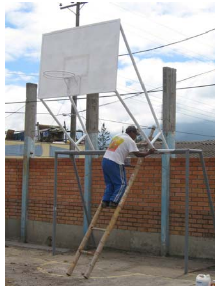
FIGURA 96.- Reparación de cancha múltiple ubicada en la parte sur del polideportivo.
