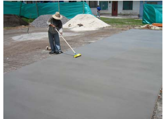
FIGURA 24.- Acabado final de placa en concreto ubicada a 6.66 m. del extremo oriental del polideportivo.
