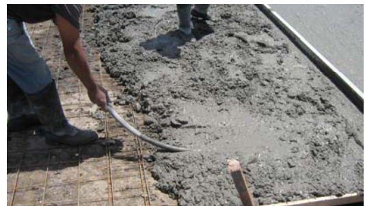
FIGURA 22.- Fundición placa en concreto
