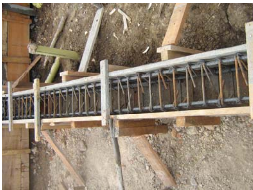
FIGURA 146.- Acero de refuerzo y formaleta de viga de cimentación.
