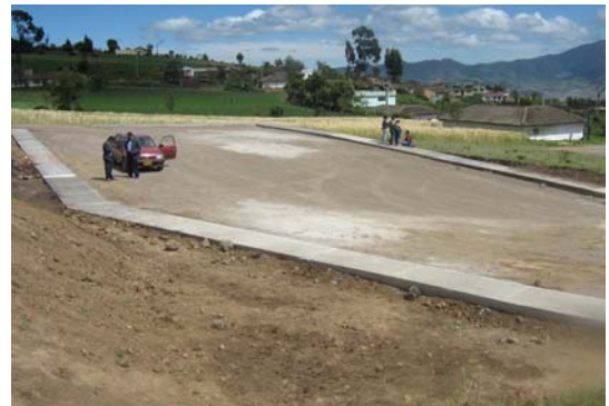
FIGURA 73.- Andenes terminados y base granular parqueadero e=0.20 m.
