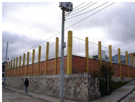
FIGURA 98.- Proyecto terminado, vista exterior, sentido norte sur
