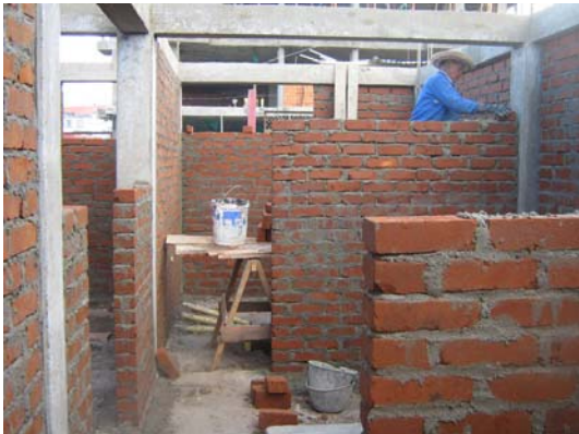
FIGURA 116.- Muros en mampostería de los baños.
