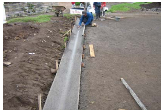
FIGURA 56.- Construcción de cuneta en concreto parte derecha sentido norte sur
