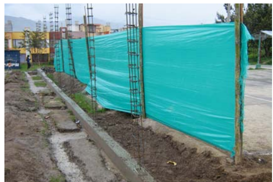
FIGURA 80.- Cimentación del cerramiento.
