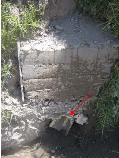
FIGURA 105.- Muro en concreto y descole de la tubería.
