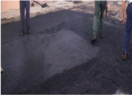
FIGURA 59.- Riego de asfalto sobre la base
