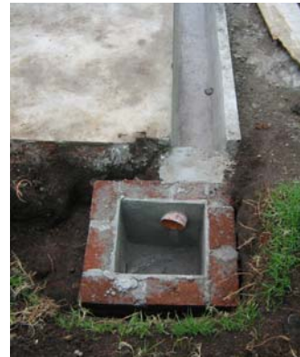
FIGURA 26.- Cuneta con conexión
