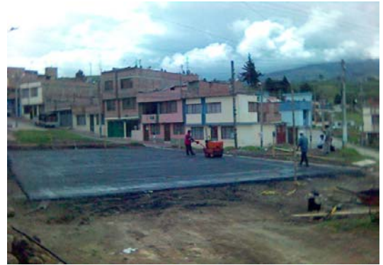
FIGURA 60.- Compactación de carpeta asfáltica vista norte sur
