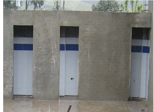
FIGURA 132.- Enchape de pared para baños y bodega (lado izquierdo)
