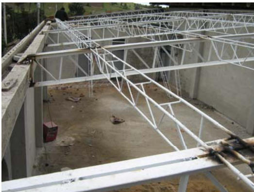
FIGURA 134.- Estructura metálica para cubierta.
