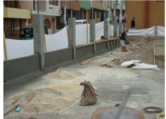
FIGURA 12.- Repello de muros
