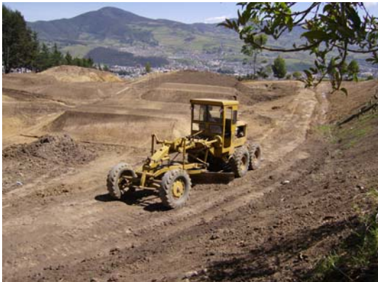
FIGURA 42.- Adecuación de acceso
