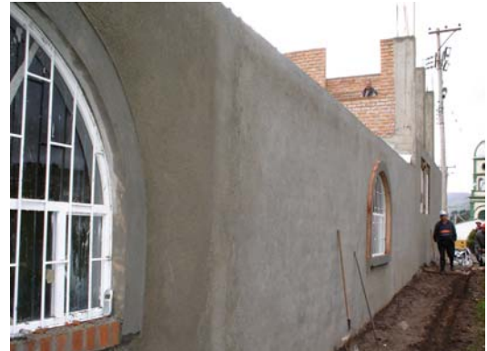
FIGURA 139.- Repello exterior de muros.
