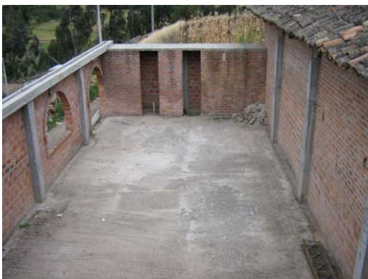
FIGURA 127.- Estado inicial del salón cultural, vista hacia el salón y baños.
