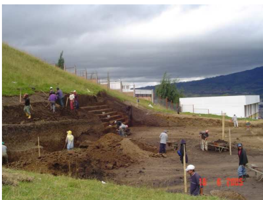
Figura 4. Excavación manual para graderías y relleno con material seleccionado.
