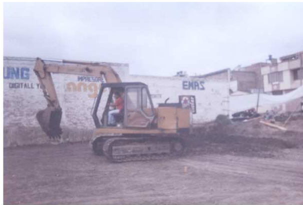
Figura 14 Excavación con retroexcavadora
