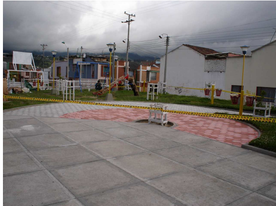
Figura 37 Instalación adoquín de colores
