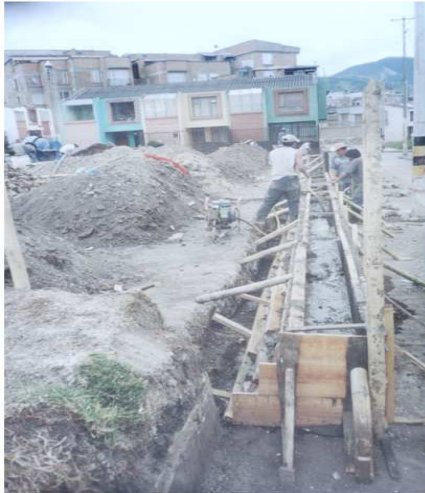
Figura 32. Fundición de muro en concreto ciclópeo e instalación de tubos de 2 ½" para cerramiento de protección de H=3.0 m
