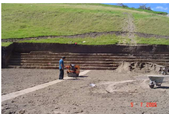
Figura 5. Extendida y compactación de la base en recebo
