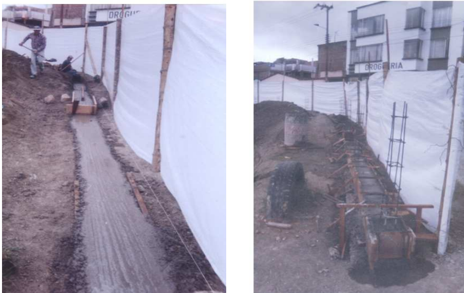
Figura 19 Fundición de viga de cimentación y construcción de castillos para muro de cerramiento.
