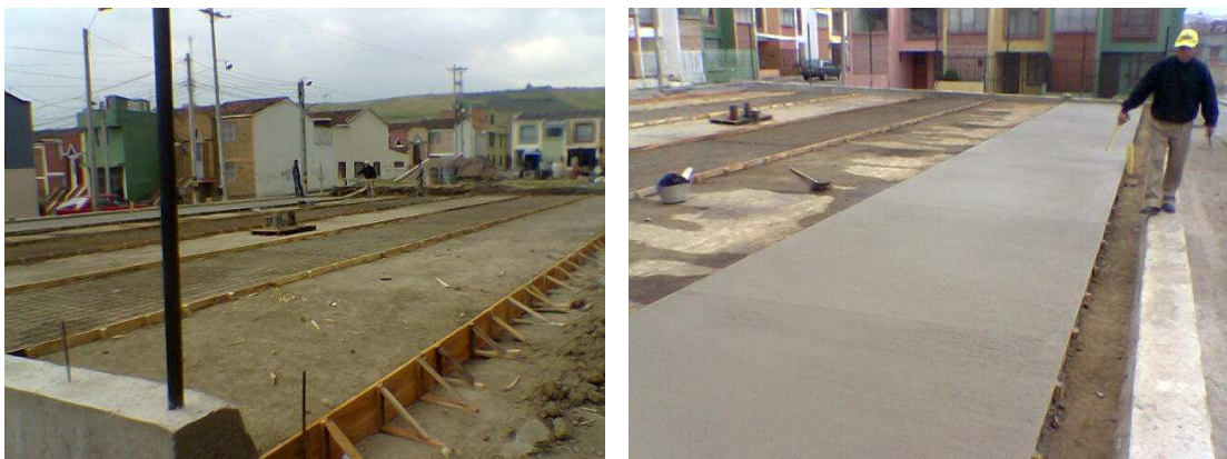
Figura 34 Enrielado y fundición de placa en concreto para polideportivo
