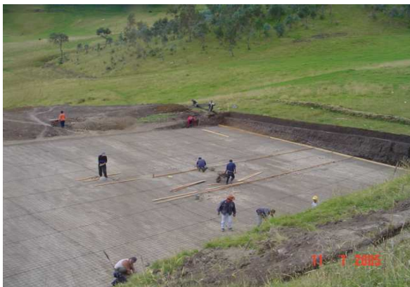
Figura 6 Construcción de formaleta para placa y colocación de malla electro soldada especificada sobre toda el área del polideportivo
