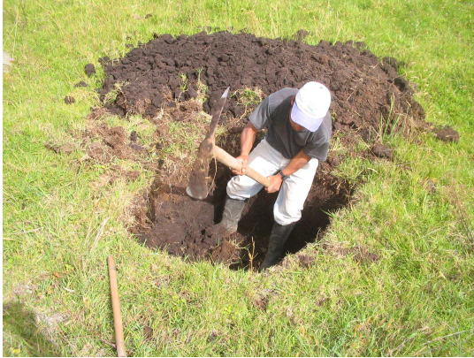
Figura 1. Realización de apiques
