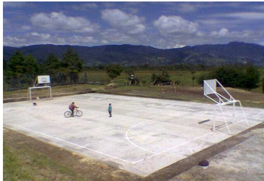
Figura 25. Instalación de canchas y líneas de demarcación
