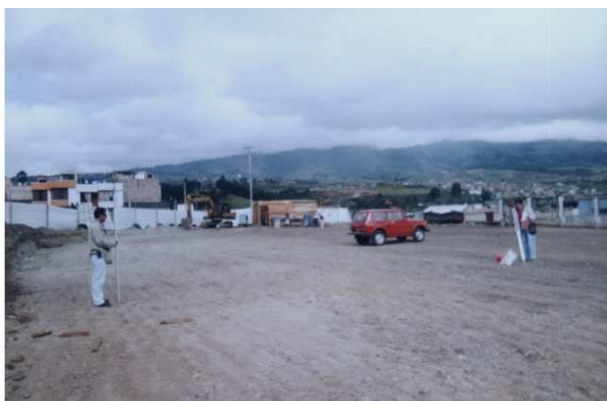
Figura 13. Nivelación del terreno
