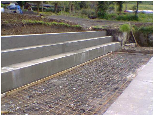
Figura 27 Instalación de malla electro soldada y la fundición de la losa
