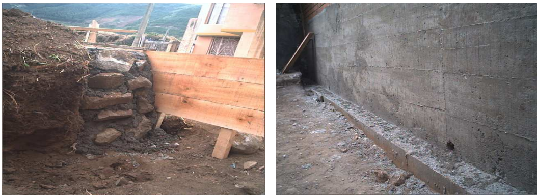
Figura 40 Construcción de Muro de contención y sobrecimiento para el muro de cerramiento
