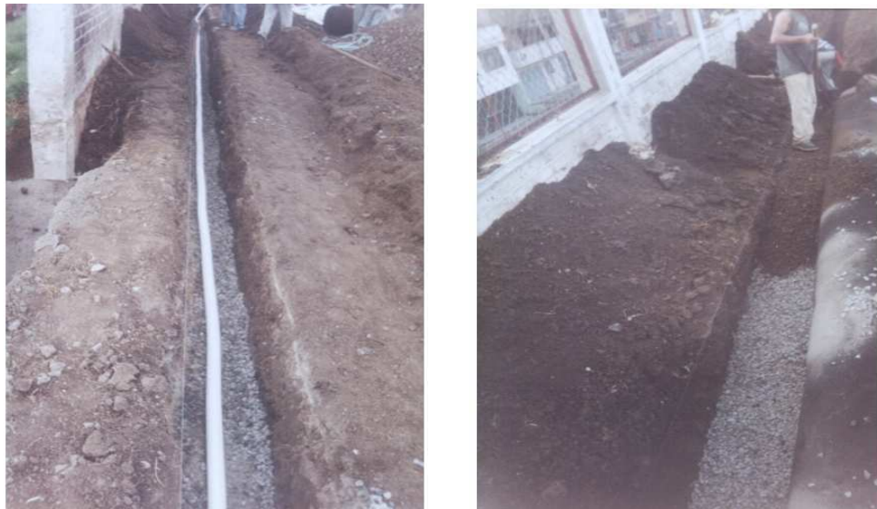
Figura 21. Instalación de tubería de 65 mm y grava para filtros.
