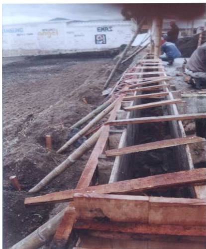
Figura 17. Construcción de formaleta y fundición de la corona del muro de contención en concreto ciclópeo, instalación de tubos de 2 1/2" para cerramiento de protección.
