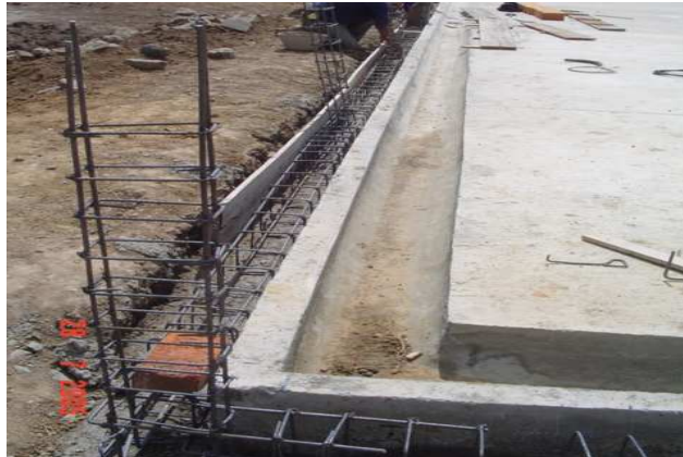
Figura 11 Construcción de cerramiento de protección
