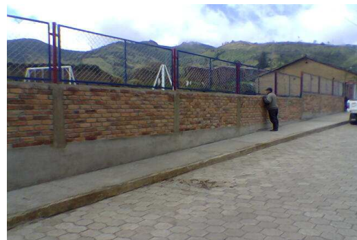
Figura 42 Instalación de cerramiento en malla y ángulo
