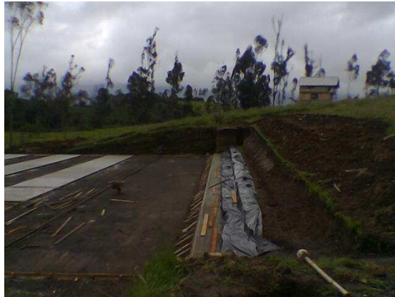
Figura 26 Base en recebo y excavación para el filtro
