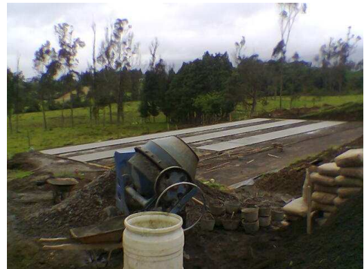
Figura 27 Instalación de malla electro soldada y la fundición de la losa
