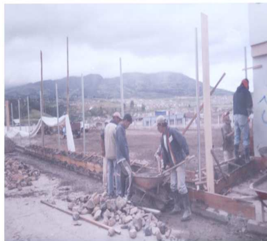
Figura 17. Construcción de formaleta y fundición de la corona del muro de contención en concreto ciclópeo, instalación de tubos de 2 1/2" para cerramiento de protección.
