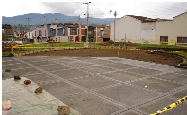
Figura 36. Plazoleta en concreto y sardineles en concreto para confinamiento del adoquín
