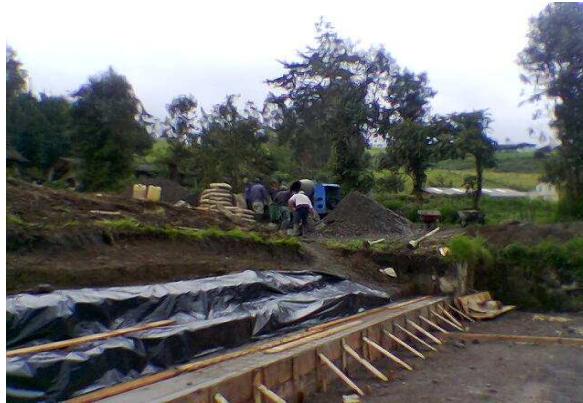
Figura 28. Construcción de las graderías en concreto, el material que se utiliza para el aislamiento y la impermeabilización
