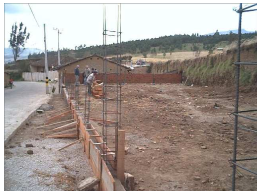
Figura 41 Construcción muro de ladrillo para cerramiento, columnas en todo el perímetro del parque
