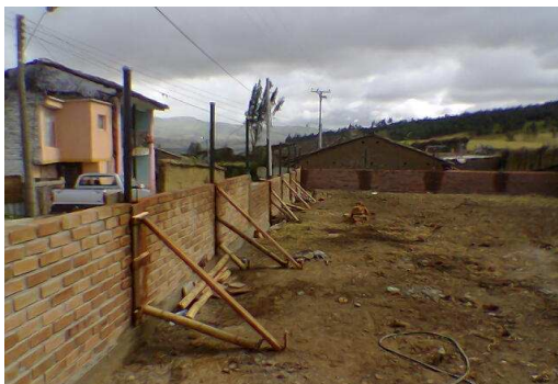
Figura 42 Instalación de cerramiento en malla y ángulo
