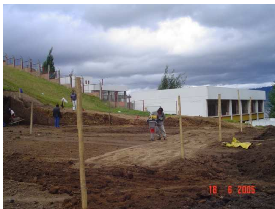
Figura 4. Excavación manual para graderías y relleno con material seleccionado.
