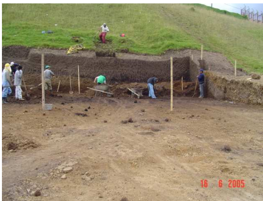
Figura 3. Excavación manual para la base en recebo, relleno y la placa en concreto realizada en toda el área a intervenir del lote.
