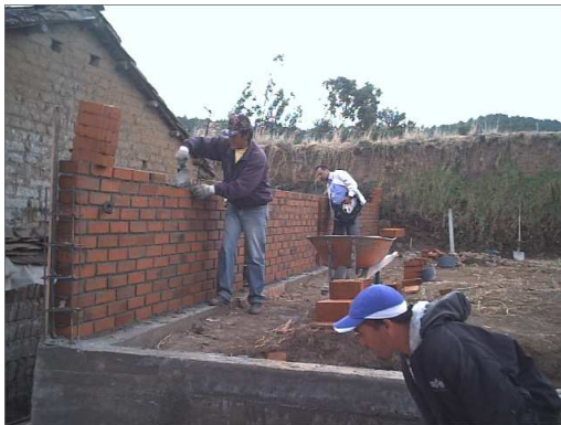
Figura 41 Construcción muro de ladrillo para cerramiento, columnas en todo el perímetro del parque
