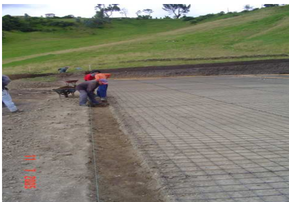
Figura 7 Excavación para cunetas
