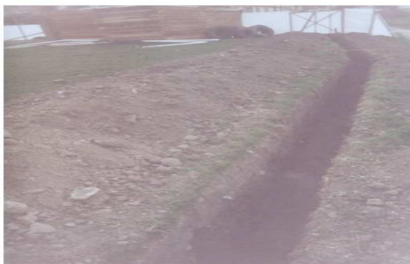
Figura 15. Excavación manual para cerramiento, profundidad promedio 1.10 m.
