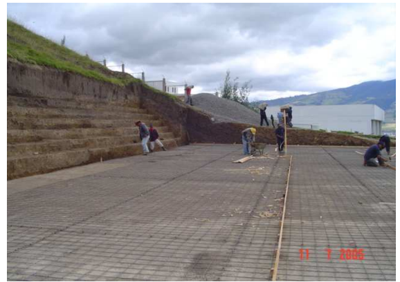
Figura 6 Construcción de formaleta para placa y colocación de malla electro soldada especificada sobre toda el área del polideportivo
