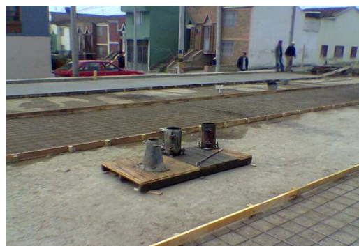
Figura 35. Instrumentos para el ensayo de Slump y toma de cilindros
