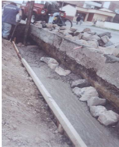
Figura 16. Fundición zarpa del muro en concreto ciclópeo
