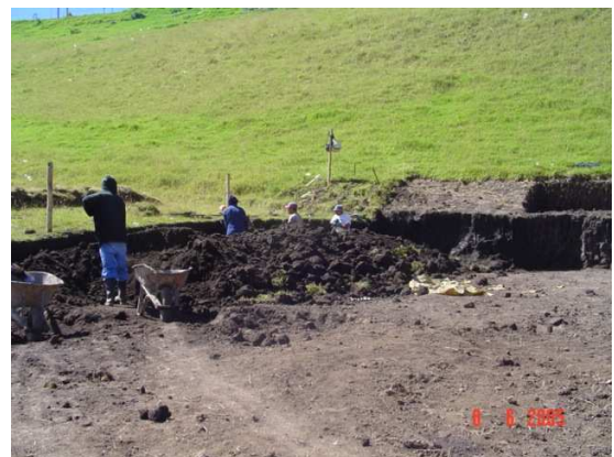
Figura 3. Excavación manual para la base en recebo, relleno y la placa en concreto realizada en toda el área a intervenir del lote.
