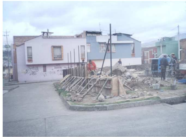
Figura 32. Fundición de muro en concreto ciclópeo e instalación de tubos de 2 ½" para cerramiento de protección de H=3.0 m
