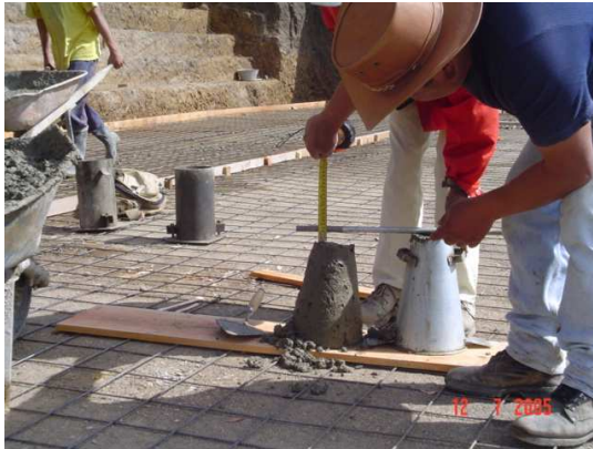
Figura 9. Ensayo de Slump y toma de cilindros
