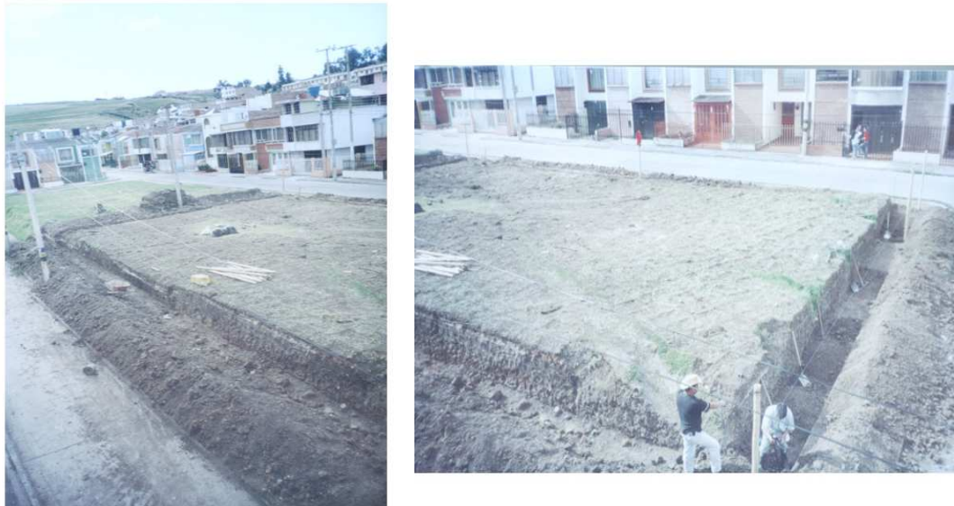
Figura 31. Excavación manual para fundición de muro de contención en concreto ciclópeo
