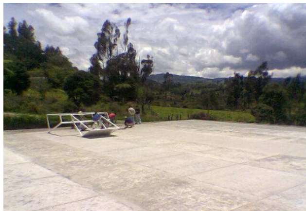
Figura 29. Instalación de las canchas multifuncionales
