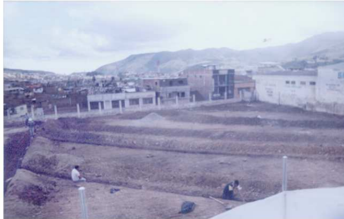
Figura 18. Excavación manual para filtros en geodrán,
