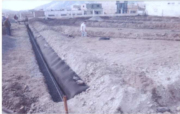
Figura 20 Instalación de geotextil (geodrén) para filtros de tipo espina de pescado
