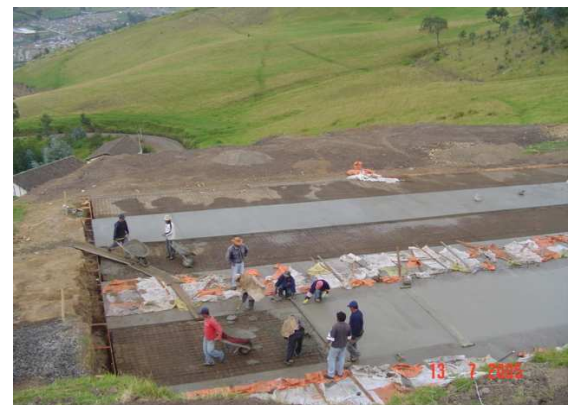
Figura 8 Fundición de placa en concreto
