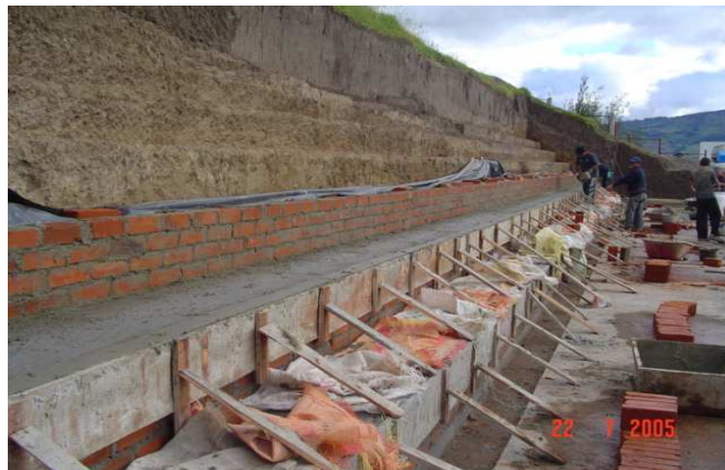
Figura 10. Construcción de gradería en mampostería y concreto (seis peldaños)
