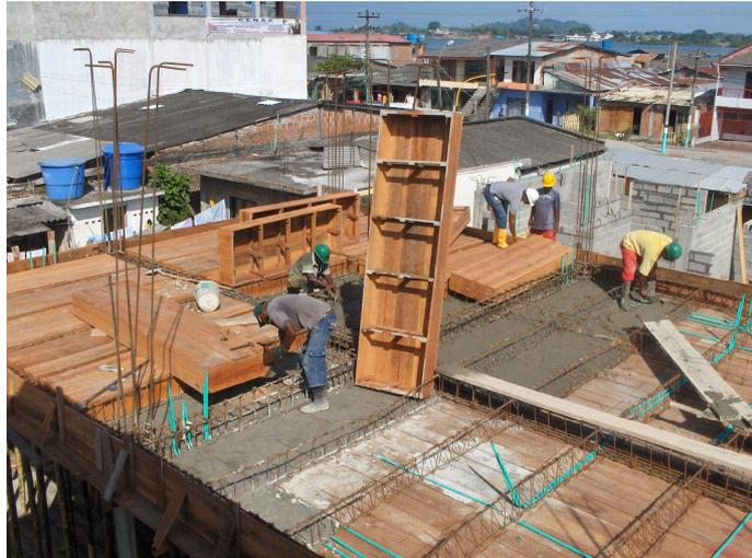
**Foto: 27 Fundición losa inferior e instalación de casetones.**
