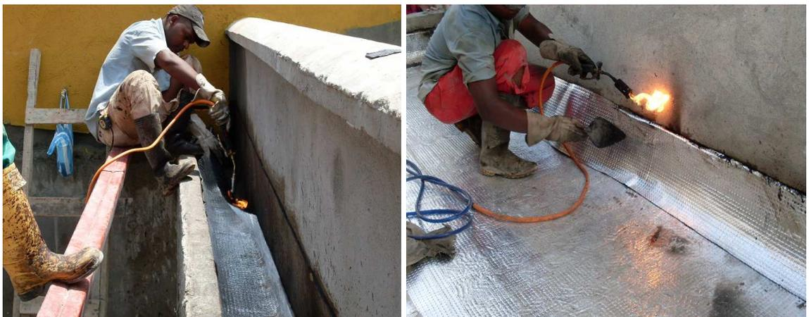
**Foto: 109 (1) Aplicación de manto edil en viga canal y (2) losa de entrepiso.**
