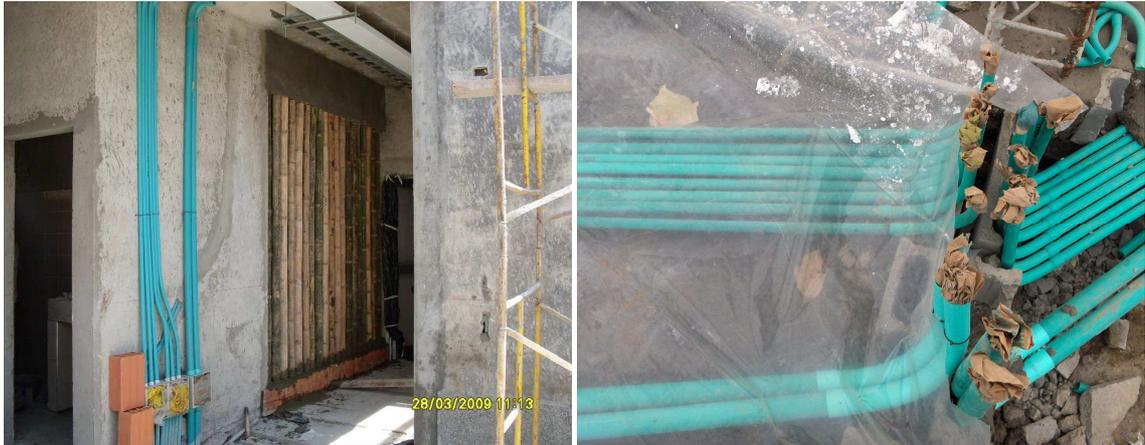
Foto: 68(1) Ductos eléctricos para mampostería y (2) placa de contrapiso.
