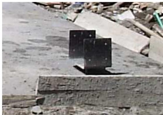
**Foto: 101 Platina para anclaje de estructura.**
