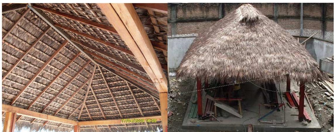
**Foto: 103(1) Entramado en madera y (2) cubierta en material paja.**
