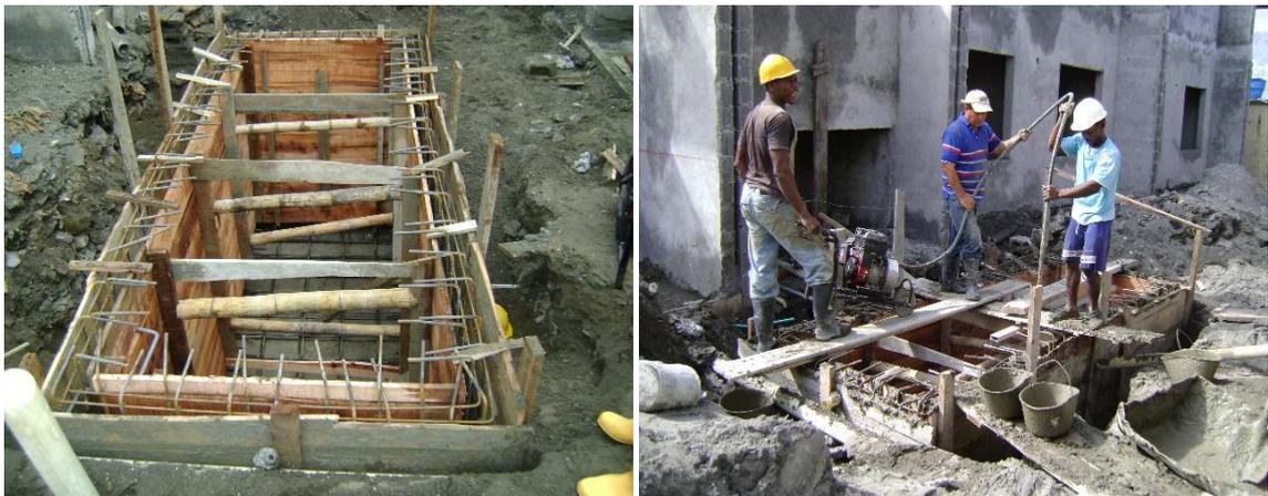
Foto: 45(1) Formateado, refuerzo y (2) fundición de tanque de abastecimiento.
