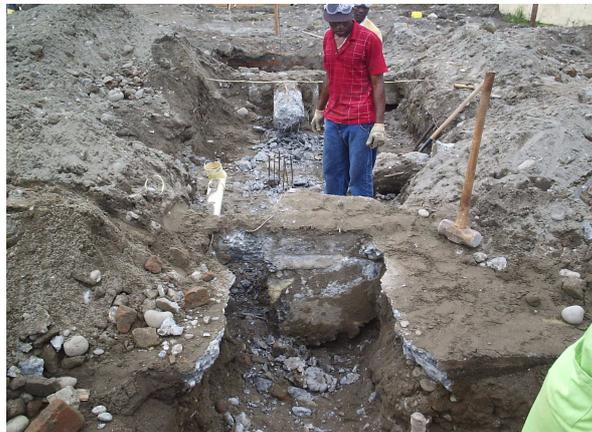
**Foto: 06 Demolición cimentación existente.**
