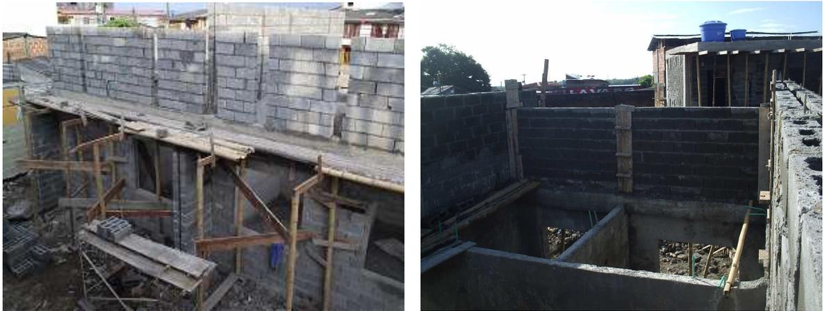
Foto: 80(1) Muro en celosía doble de espesor 30cm y (2) sencillo de espesor 15cm.
