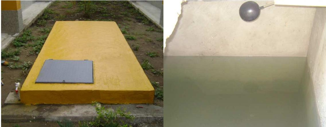
Foto: 46(1) Tanque de abastecimiento y (2) flotador de aire.
