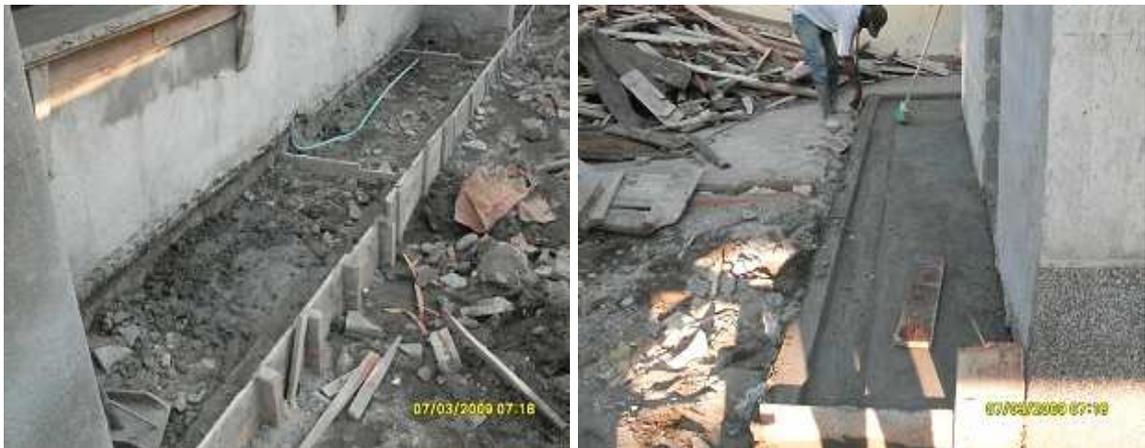
Foto: 145(1) Vaciado y compactación de recebo y (2) Moldeado de cañuela para anden perimetral.
