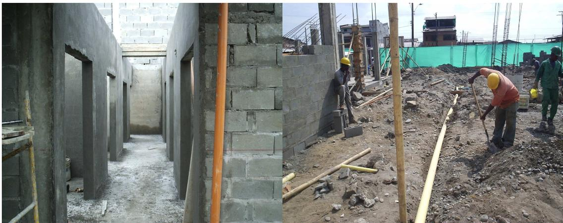
Foto: 41(1) Tubería pvc - lluvias 3" y (2) tubería pvc - lluvias 4".
