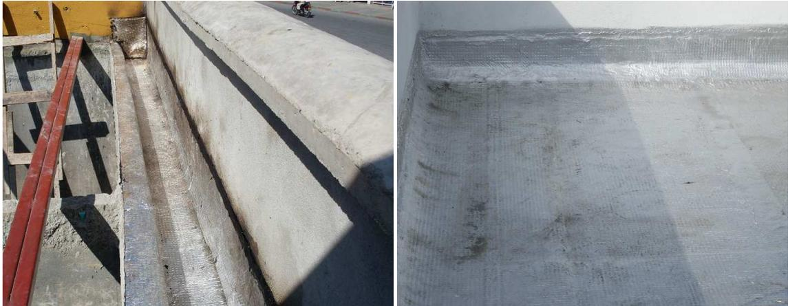
Foto: 110 (1) Manto edil instalado en viga canal y (2) losa de entrepiso.
