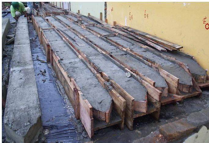
Foto: 09 Construcción de pilotes en concreto reforzado.
