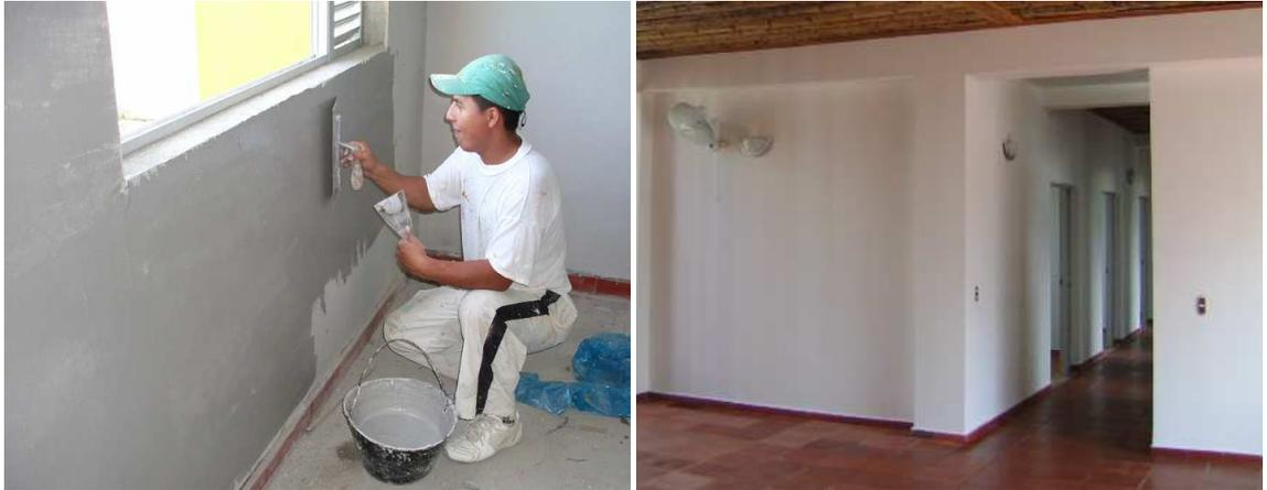
Foto: 93(1) Aplicación de estuco y (2) pintura para interiores.
