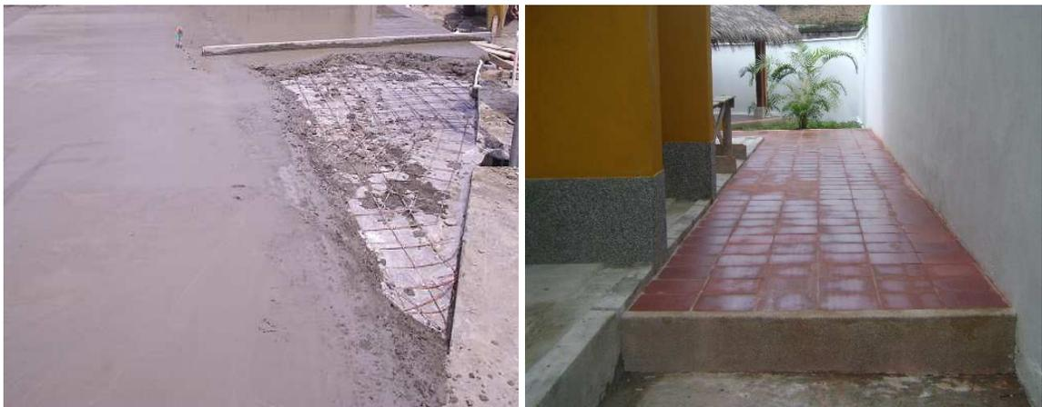
**Foto: 147 Losa de contrapiso en proceso de fundición y (2) Piso terminado.**
