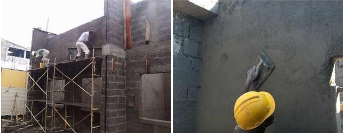
**Foto: 83(1) Pañete en muros fachada y (2) muros Interiores.**
