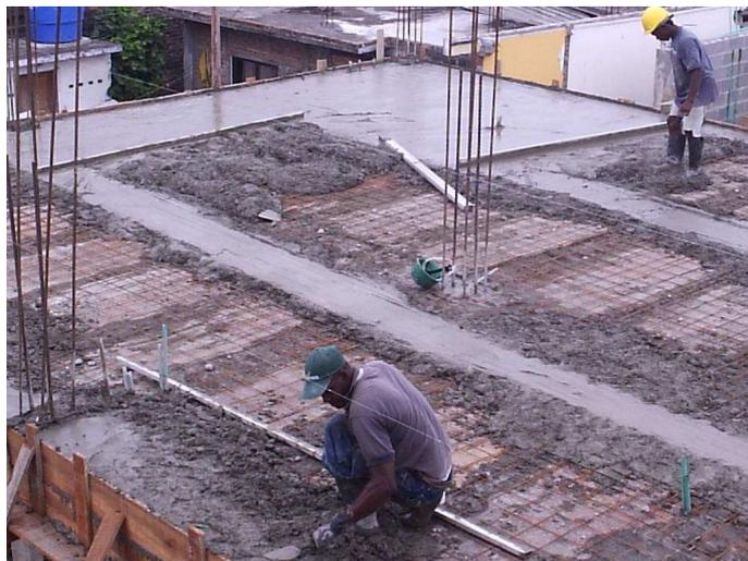
**Foto: 28 Fundición losa superior.**
