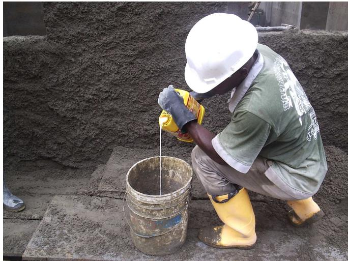
Foto: 82 Aditivo para impermeabilización de morteros.
