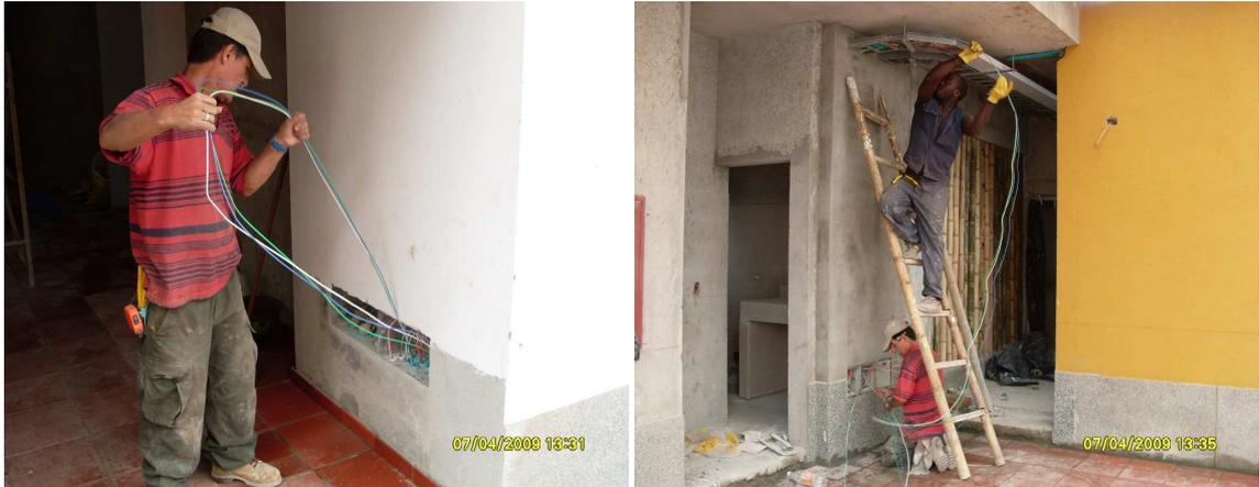
**Foto: 67(1) y (2) Cableado y alambrado de conductores.**
