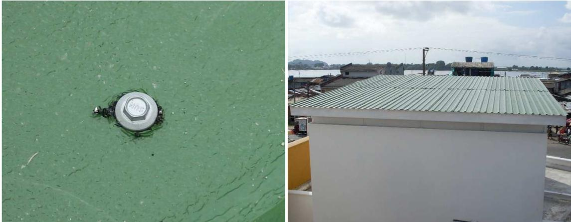
**Foto: 98(1) Instalación de cubierta con tornillo autopercutor y (2) cubierta instalada.**
