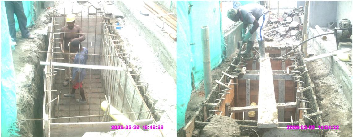
**Foto: 54(1) Amarre del refuerzo y (2) fundición del tanque séptico.**
