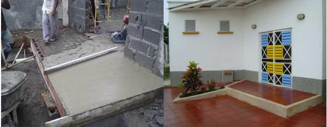
**Foto: 152(1) Rampa de acceso principal en construcción y (2) Terminado de piso.**
