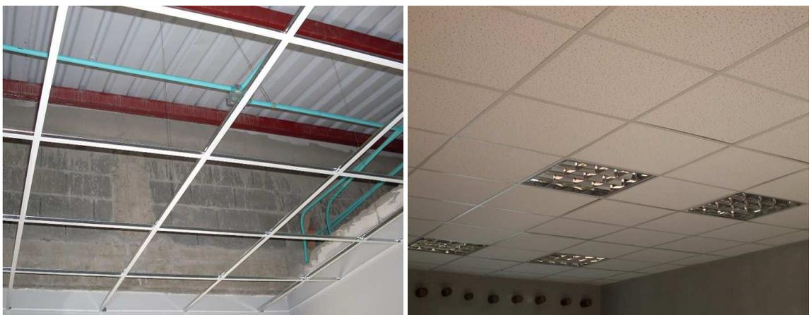
Foto: 111(1) Instalación de estructura en aluminio y (2) de los paneles en fibra mineral.
