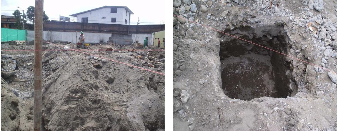
**Foto: 07(1) Toma de niveles para excavación y (2) excavación manual de cimientos.**
