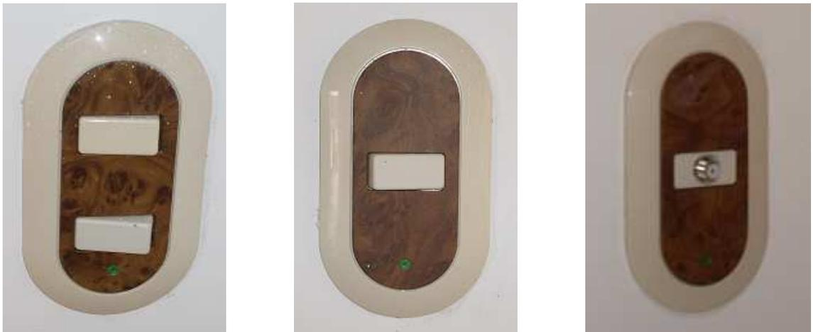
Foto: 65(1) Interruptor doble, (2) interruptor sencillo y (3) sistema antena de televisión.
