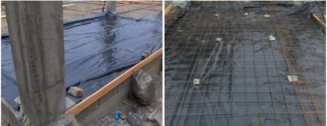
**Foto: 21(1) Formaleteado de losa, aplicación de polietileno y (2) ubicación de malla electrosoldada.**
