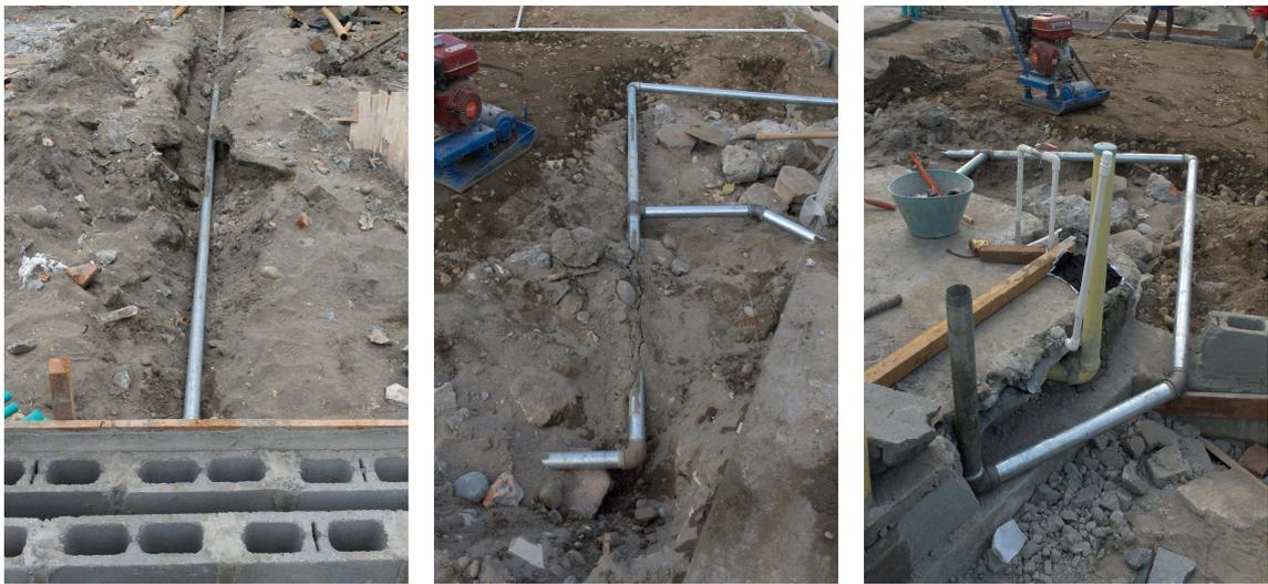
**Foto: 49 Tubería en acero galvanizado de 2".**
