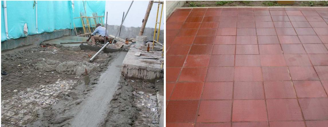
**Foto: 148 Losa de Entrada Principal en Etapa de Fundición y (2) Piso Terminado.**
