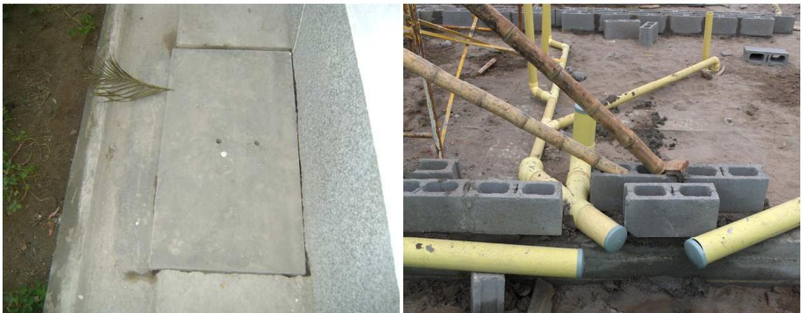
Foto: 52(1) Caja de inspección y (2) salidas sanitarias.
