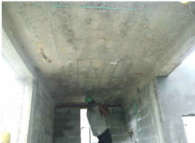
**Foto: 29 Losa maciza para cubierta.**
