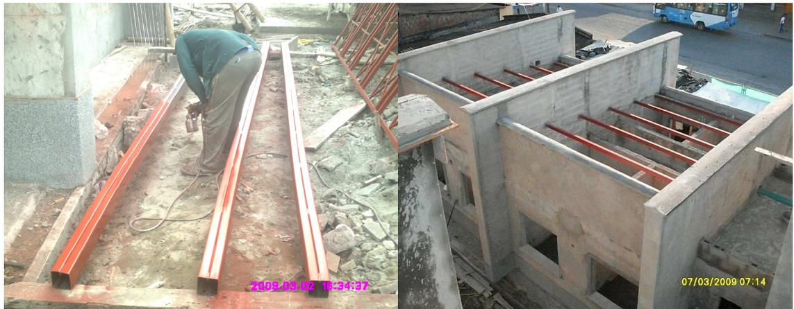
Foto: 99(1) Viga de soporte para cubierta y (2) vigas de soporte instaladas.
