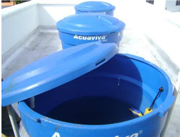
Foto: 48 Tanques plásticos y flotador de mercurio.
