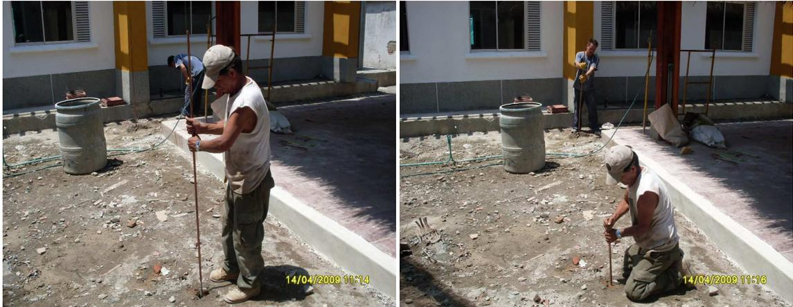
**Foto: 59(1) y (2) Ubicación en tierra de varillas de cobre.**
