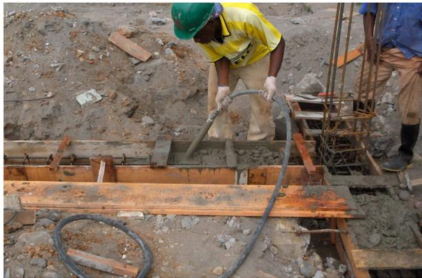
**Foto: 16 Fundición vigas cimentación.**
