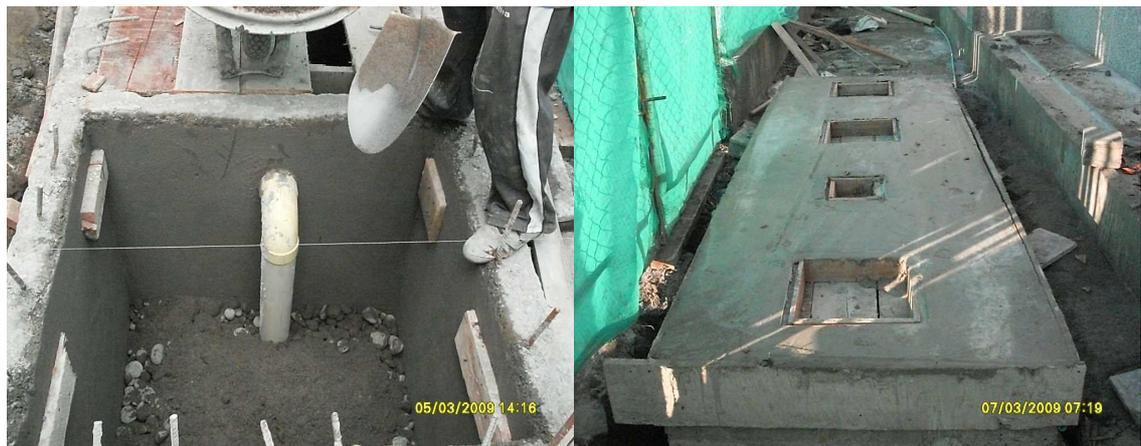
**Foto: 55(1) Llenado de filtro FAFA y (2) fundición de tapa para tanque séptico.**
