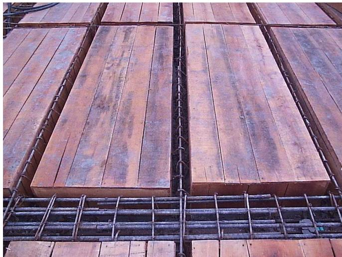
**Foto: 26 Acero de refuerzo y medición de casetones.**
