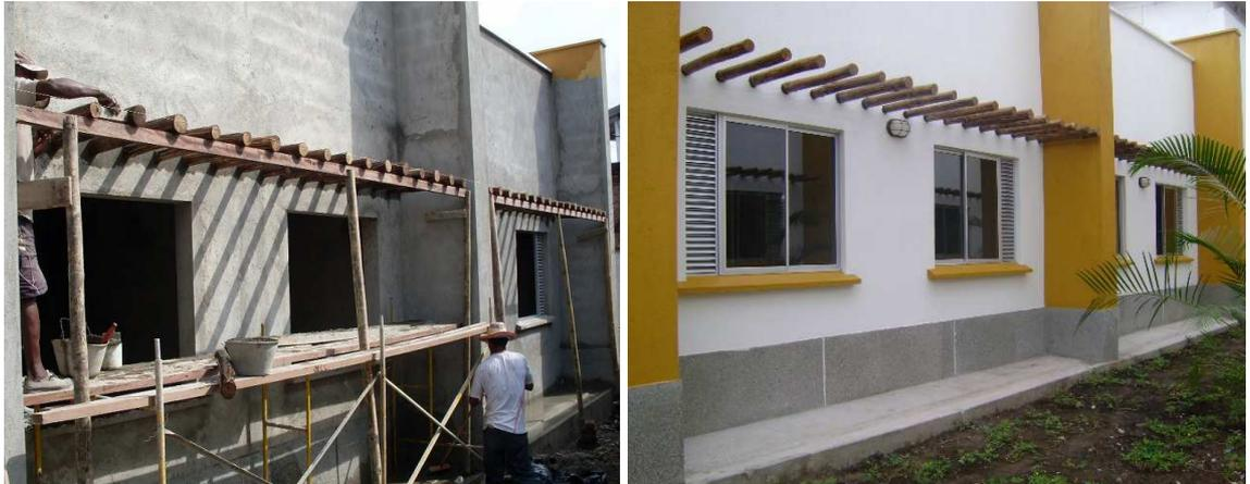
Foto: 125(1) Instalación y (2) acabado de cortasoles.
