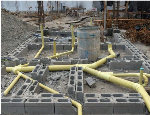
Foto: 42 Tubería sanitaria de 2" a 4".
