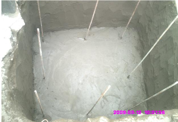
**Foto: 56 Pozo de infiltración.**
