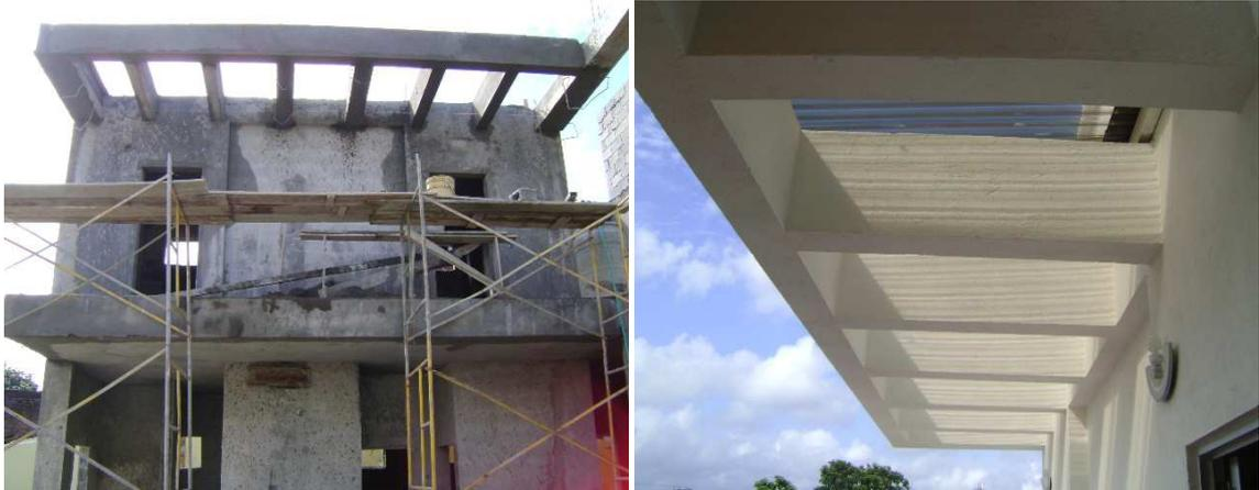
Foto: 106(1) Vigas pérgolas y (2) acabado e instalación de cubierta.
