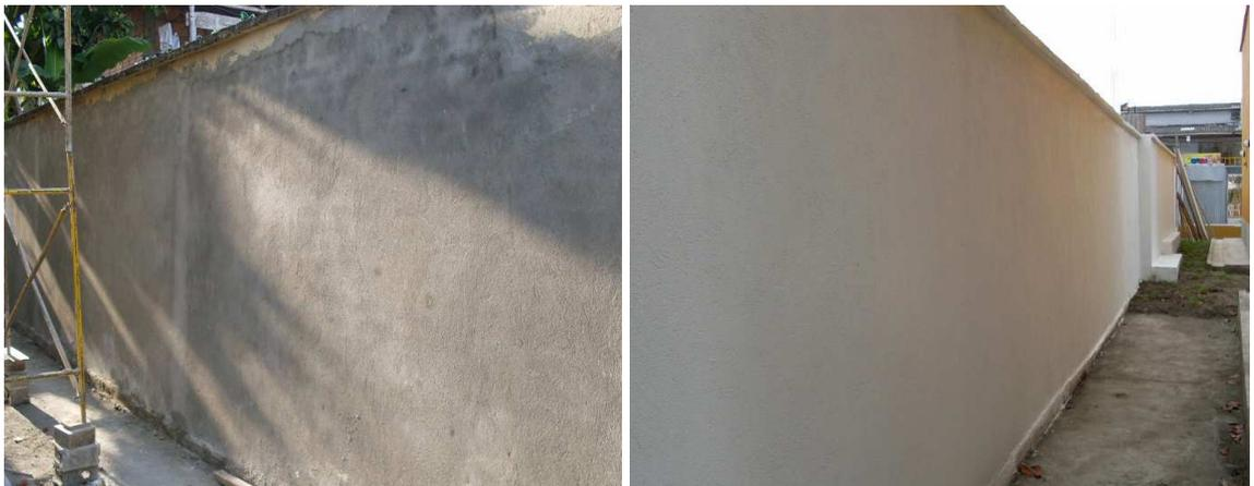
**Foto: 153(1) Muros Perimetrales Pañetados y (2) Terminados con pintura Koraza.**
