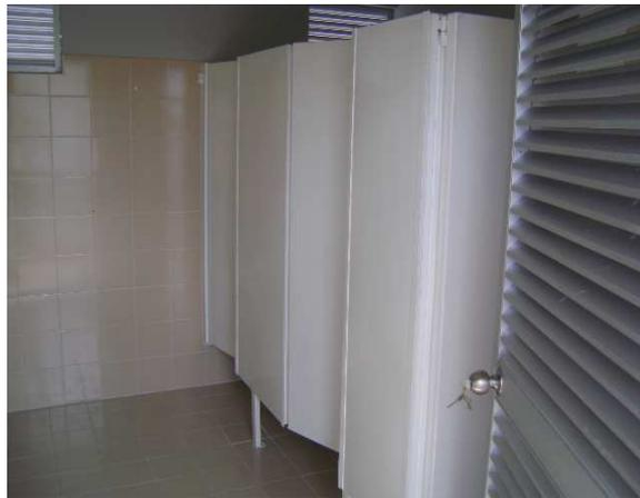
Foto: 120 Divisiones para Baño en Lamina Cold Rolled.
