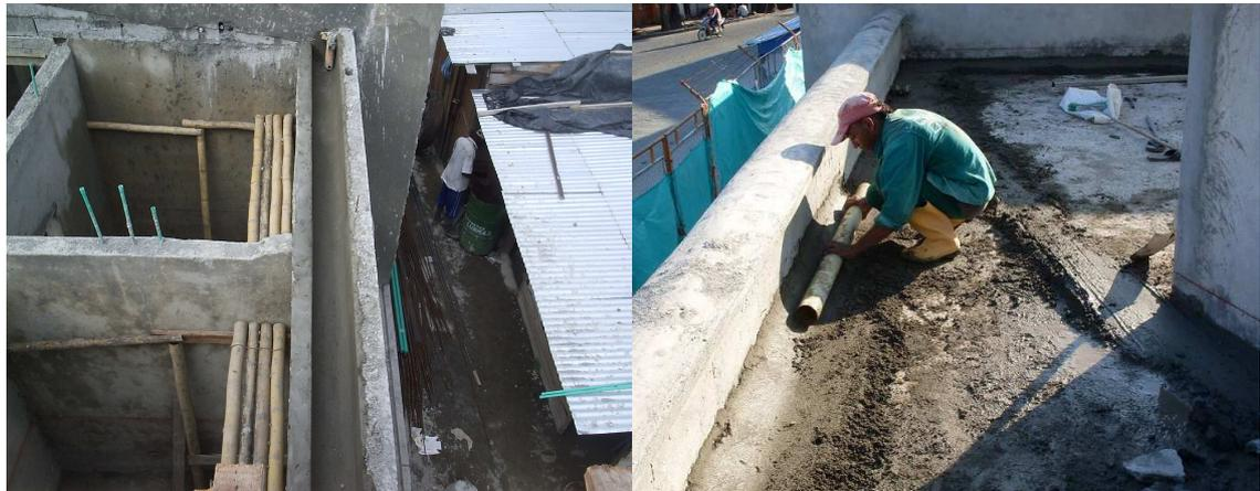
Foto: 107(1) Aplicación de mortero en viga canal y (2) losa de entrepiso.
