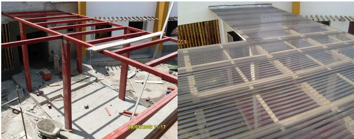
**Foto: 105(1) Estructura metálica y (2) teja acrílica instalada.**
