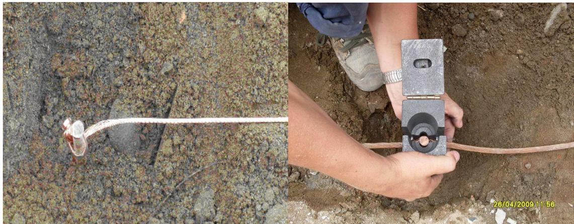
**Foto: 60(1) Unión en frío de cable mas varilla y (2) ubicación de molde para fundición.**
