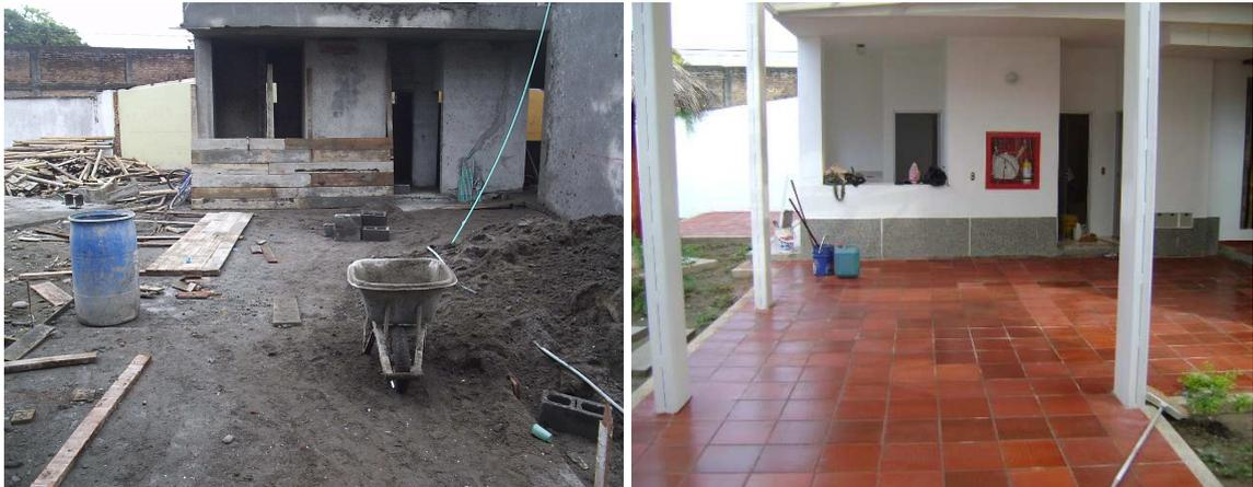
**Foto: 146(1) Losa de contrapiso cafetería en obra gris y (2) terminada.**
