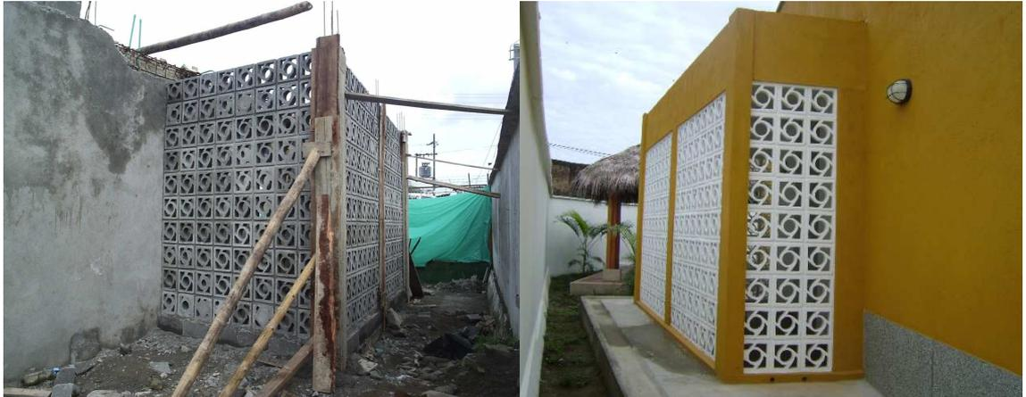
Foto: 81(1) Dovelas en muro calado y (2) acabados.
