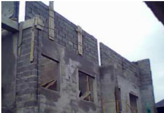
**Foto: 34 Dovelas para muros áticos.**
