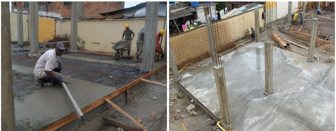
**Foto: 22(1) Fundición y (2) curado de losa de contrapiso.**
