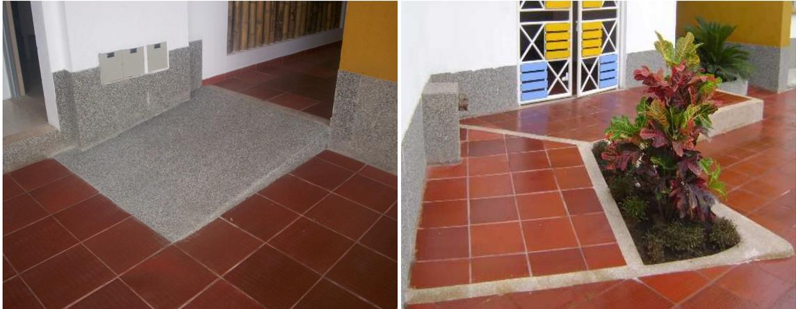
**Foto: 91(1) Rampas de acceso para discapacitados interior y (2) exterior.**
