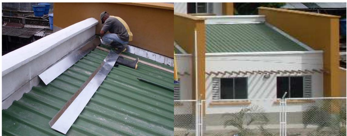
Foto: 100(1) Instalación de flanche y (2) cubierta Instalada.
