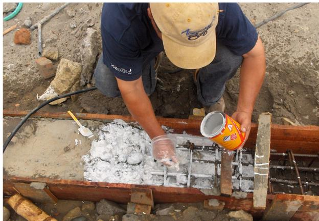
**Foto: 17 Aplicación de aditivo epóxico en viga de cimentación.**
