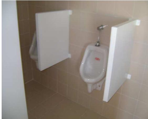
Foto: 121 Separador de orinales en Lamina Cold Rolled.
