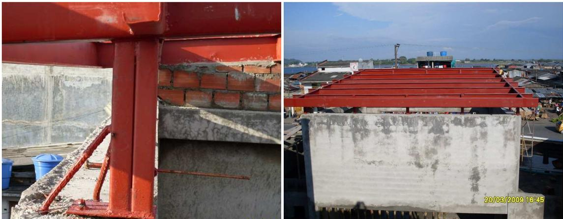
**Foto: 97(1) Anclaje a estructura de concreto y (2) estructura metálica sala de espera.**
