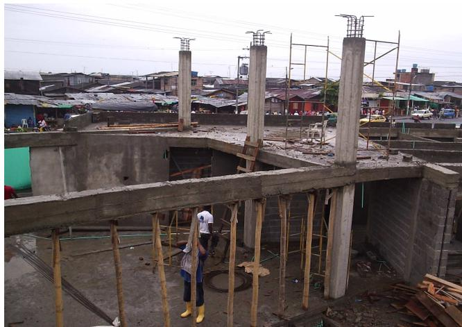
**Foto: 30 Losa maciza para cubierta.**
