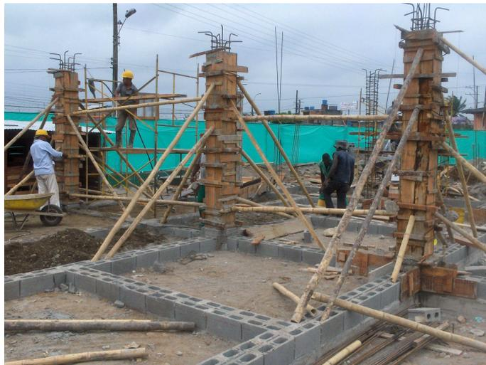
Foto: 20 Encofrado y fundición de columnas.
