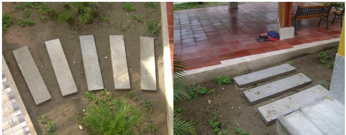
**Foto: 149(1) Pasos vaciados en concreto que conducen de cafetería a kiosco y (2) de kiosco a bloque izquierdo.**
