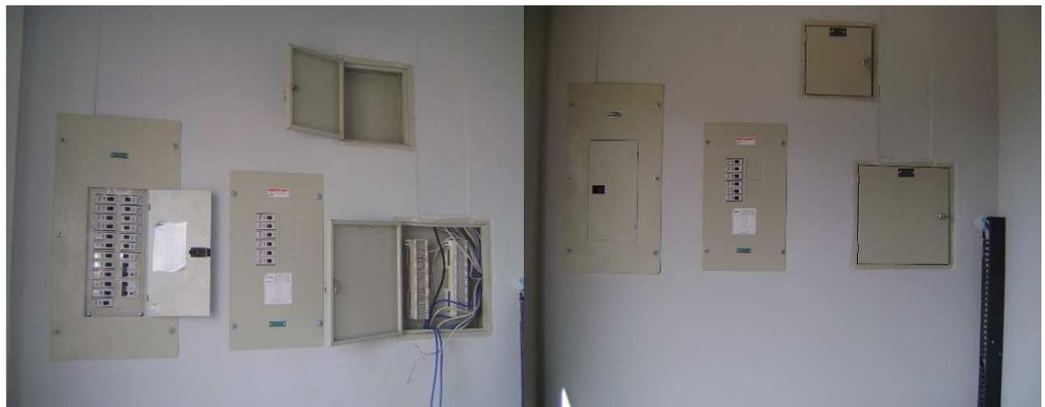
Foto: 62(1) y (2) Tableros monofásicos y cajas para empalmes telefónicos.
