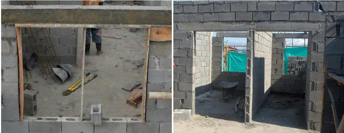
Foto: 84(1) Dintel en concreto reforzado para puertas y (2) ventanas.
