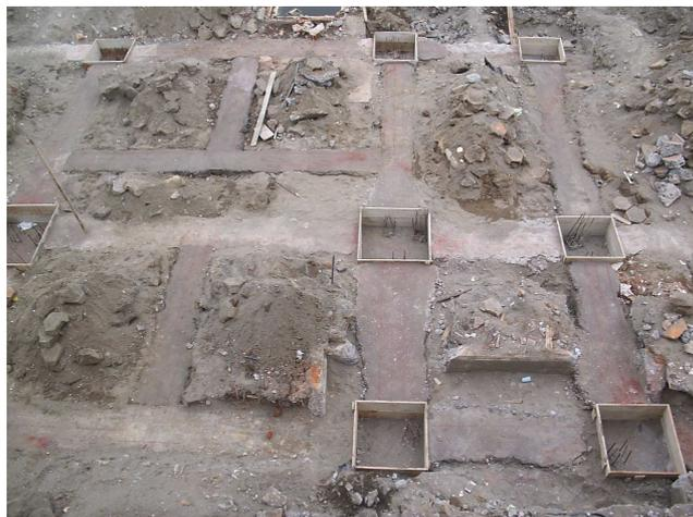
Foto: 13 Concreto de limpieza para vigas y zapatas.
