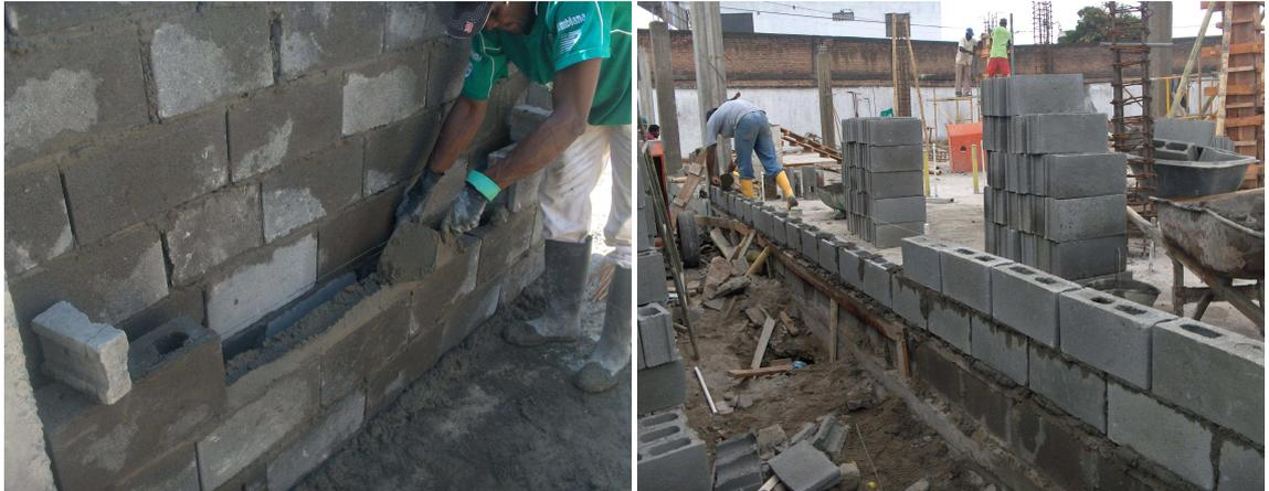
Foto: 79(1) Muro doble de espesor 30cm y (2) muro sencillo de espesor 15cm.
