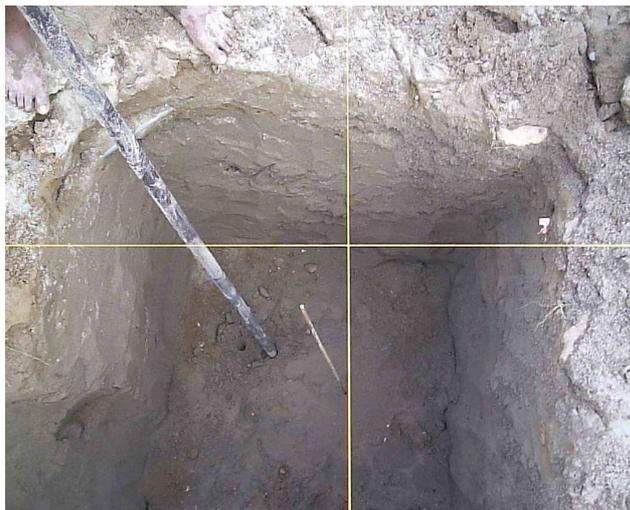
**Foto: 08 Replanteo para inca de pilotes.**
