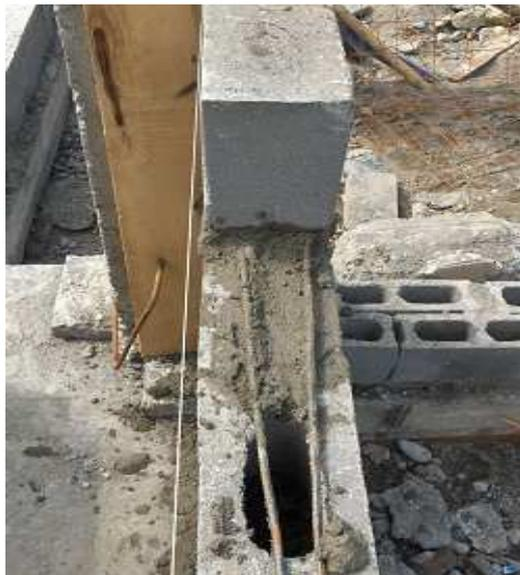
**Foto: 77 Anclaje de varillas.**
