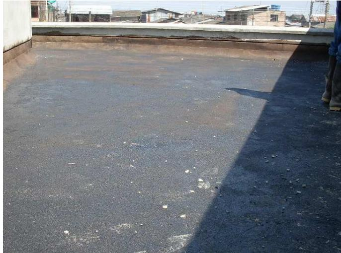
**Foto: 108 Aplicación de emulsión asfáltica.**
