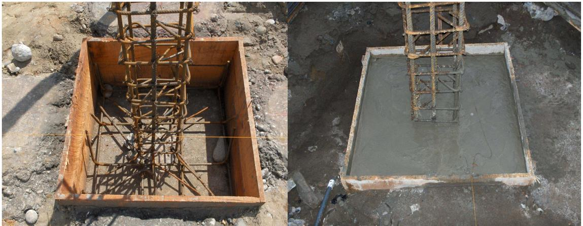
**Foto: 15(1) Armado de refuerzo para zapatas y (2) fundición de zapatas.**
