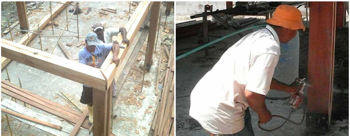
**Foto: 102(1) Armado de estructura y (2) inmunización de párales.**
