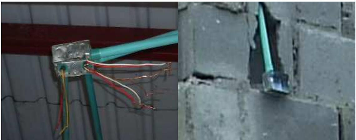
**Foto: 63(1) Caja para salida de alumbrados y (2) caja para tomas.**
