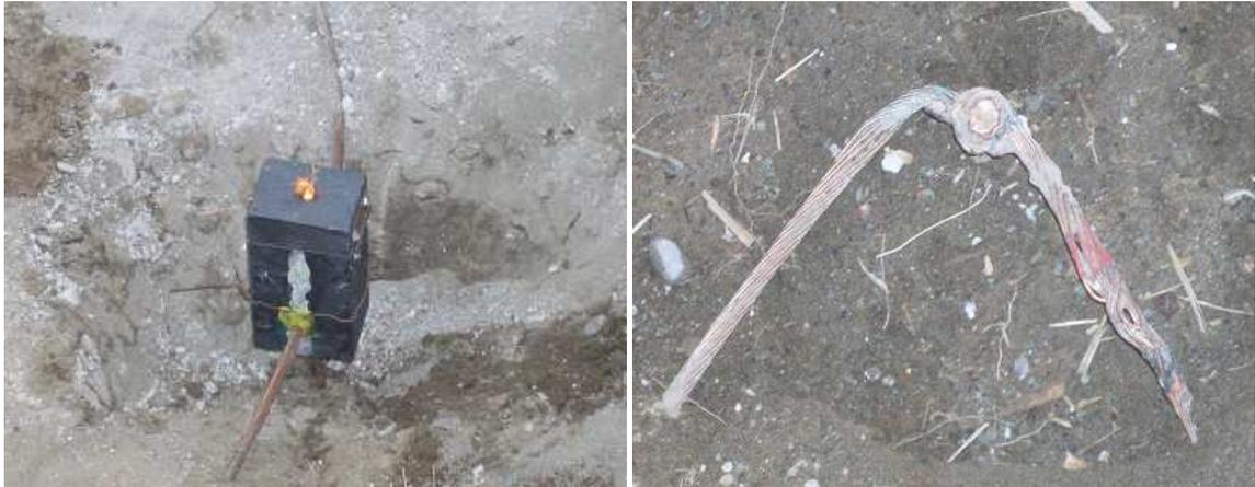
Foto: 61(1) Fundición de cable más varilla y (2) enlace equipotencial.
