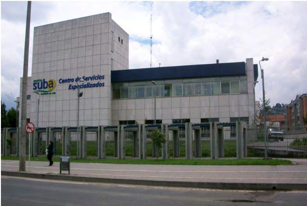
Imagen Fachada Hospital Suba 18
