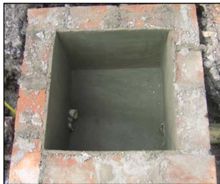
FIGURA 108.- CAJA DE INSPECCIÓN TERMINADA
