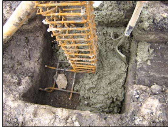
FIGURA 88.- COLOCACIÓN DE CONCRETO EN LAS ZAPATAS
