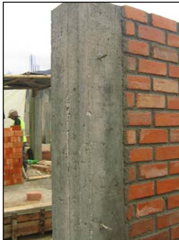
FIGURA 99.- CONECTORES PARA LA UBICACIÓN DE LA PUERTA
