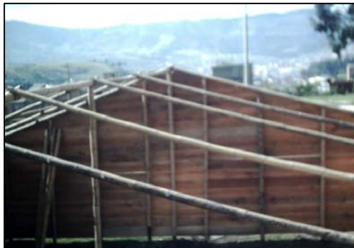
FIGURA 9.- COLOCACIÓN DE TIRANTES DEL TECHO
