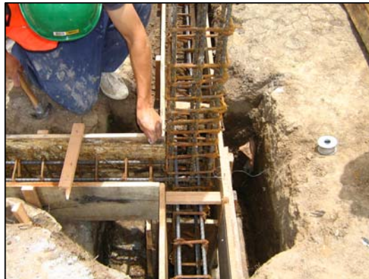
FIGURA 92.- ENCOFRADO DE VIGAS DE CIMENTACIÓN
