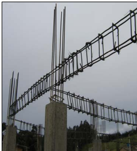
FIGURA 81.- REFUERZO DE VIGA AÉREA
