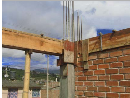
FIGURA 100.- ENCOFRADO DE VIGAS AÉREAS
