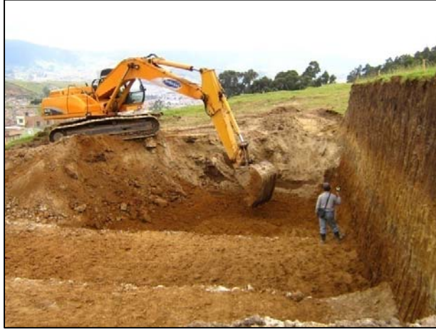
FIGURA 40.- DESCAPOTE Y TERRACEO DE LA PRIMERA ETAPA MANZANA D
