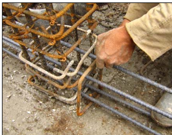
FIGURA 80.- COLOCACIÓN DE REFUERZO DE VIGAS DE CIMENTACIÓN
