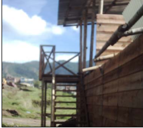
FIGURA 13.- DETALLE GRADAS CIERRE PERIMETRAL OFICINA
