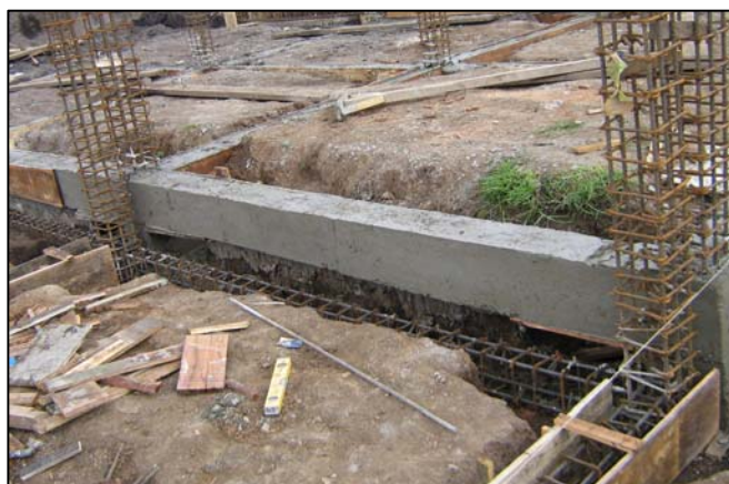
FIGURA 94.- VIGAS DE CIMENTACIÓN
