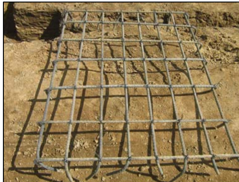
FIGURA 75.- PARRILLA DE ZAPATA
