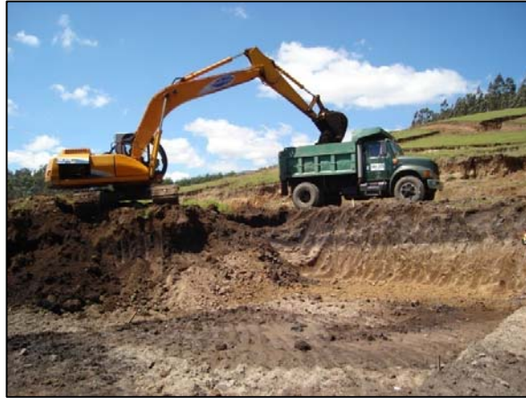
FIGURA 36.- DESCAPOTE Y TERRACEO DE LA PRIMERA ETAPA DE LA MANZANA B
