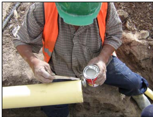
FIGURA 58.- APLICACIÓN DE SOLDADURA LIQUIDA DE PVC
