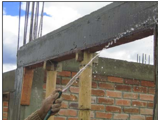
FIGURA 63.- CURADO DEL CONCRETO
