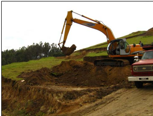
FIGURA 41.- DESCAPOTE Y TERRACEO DE LA SEGUNDA ETAPA MANZANA D
