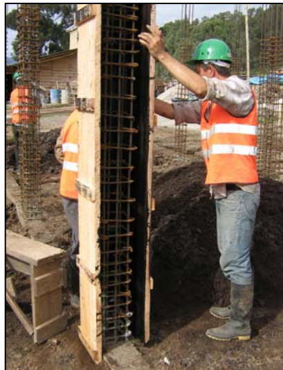
FIGURA 96.- ENCOFRADO DE COLUMNAS
