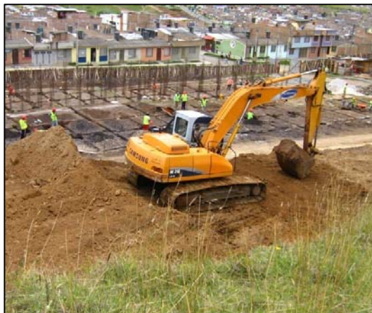
FIGURA 38.- DESCAPOTE Y TERRACEO DE LA PRIMERA ETAPA MANZANA C
