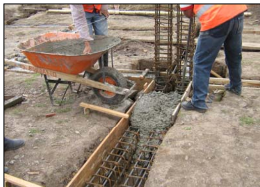
FIGURA 93.- COLOCACIÓN DE CONCRETO EN LAS VIGAS DE CIMENTACIÓN
