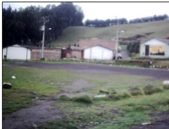
FIGURA 6.- ÁREA DE CONSTRUCCIÓN DE BODEGA
