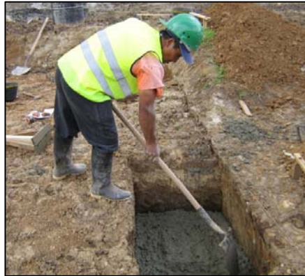
FIGURA 86.- FUNDICIÓN DE SOLADO DE LIMPIEZA EN LA BASE DE LAS ZAPATAS
