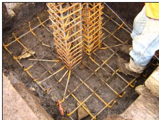
FIGURA 87.- UBICACIÓN DE PARRILLA DE ZAPATA Y REFUERZO DE COLUMNA
