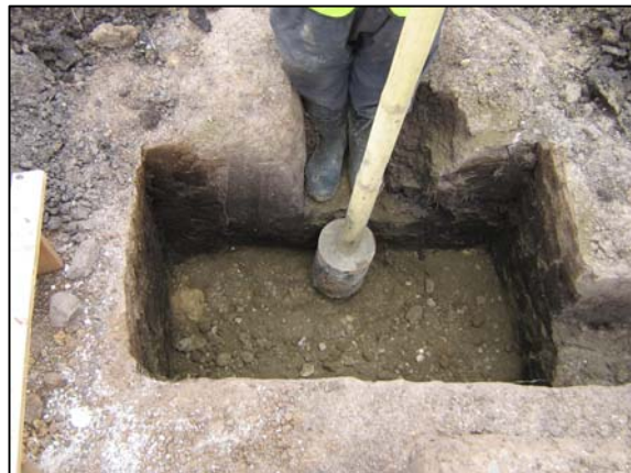
FIGURA 85.- MEJORAMIENTO DEL SUELO
