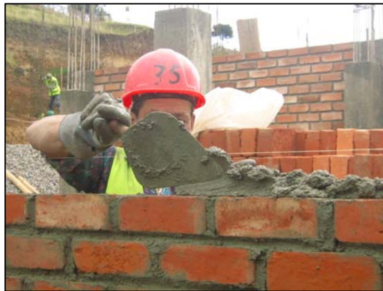
FIGURA 102.- MUROS EN MAMPOSTERÍA DE LADRILLO
