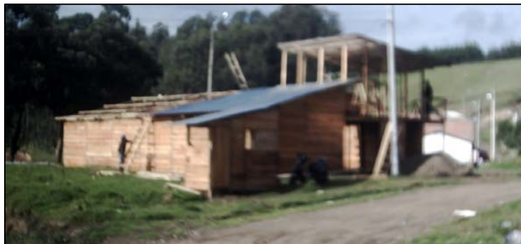
FIGURA 10.- ZONA DE BODEGA Y OFICINA EN CONSTRUCCIÓN
