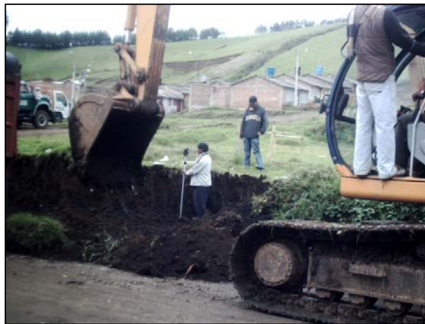
FIGURA 35.- DESCAPOTE Y TERRACEO DE LA MANZANA A
