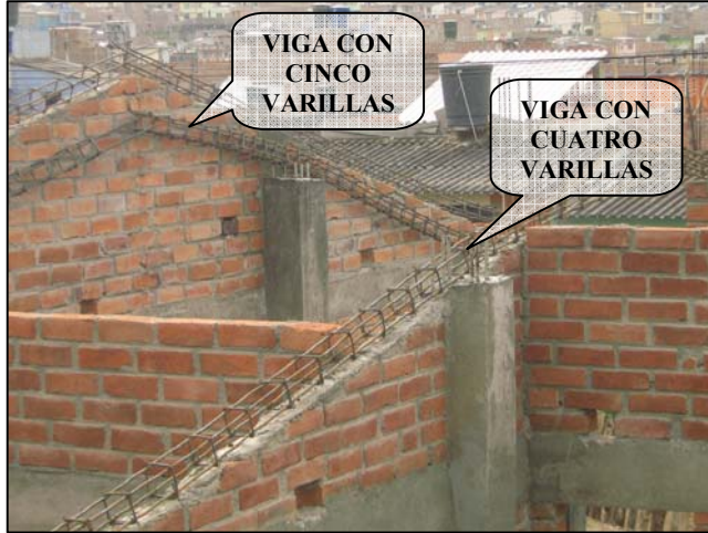
FIGURA 82.- REFUERZO DE VIGA CINTA
