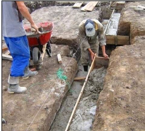
FIGURA 91.- FUNDICIÓN DE SOLADO DE LIMPIEZA EN LA BASE DE LAS VIGAS DE CIMENTACIÓN
