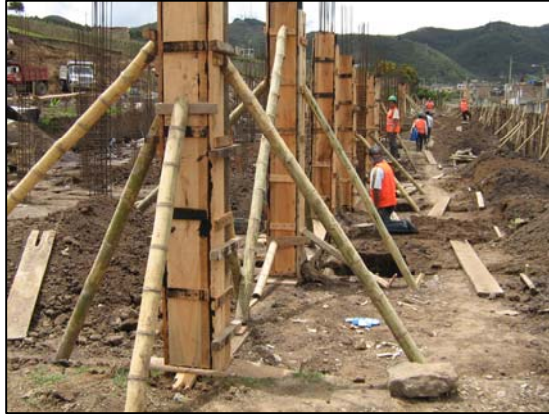
FIGURA 97.- FORMALETAS ASEGURADAS CON PUNTALES
