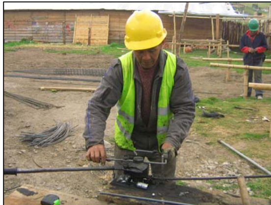
FIGURA 68.- FIGURADO DE REFUERZO TRANSVERSAL CON MANDRIL
