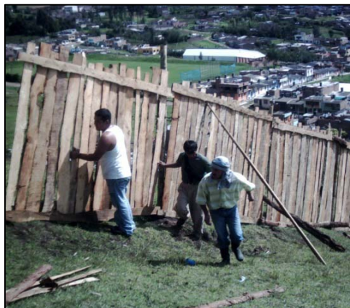
FIGURA 16.- CONSTRUCCIÓN DEL CIERRE DEL LOTE
