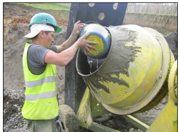
FIGURA 61.- MEZCLADORA CON CAPACIDAD DE UN BULTO Y MEDIO.
