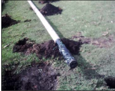
FIGURA 8.- GUADUA PROTEGIDA CON ADITIVO Y BOLSA
