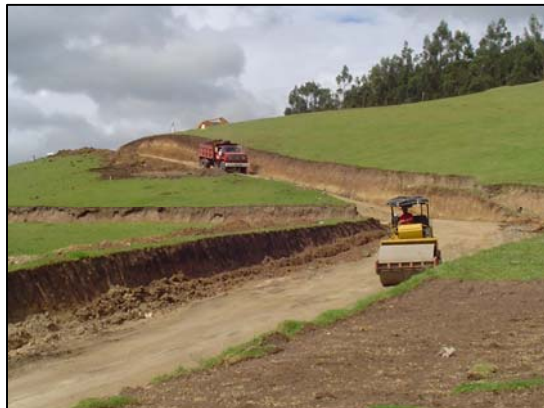
FIGURA 33.- CALLE 35 ENTRE CARRERA 32 Y CARRERA 32B SIENDO COMPACTADA
