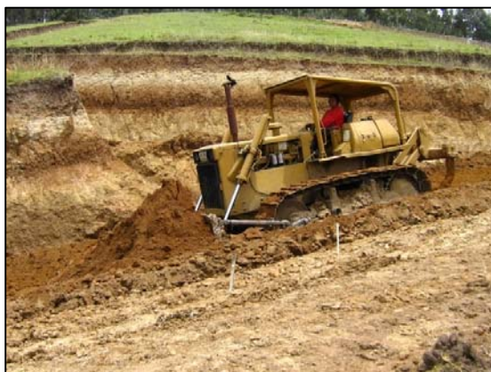
FIGURA 39.- DESCAPOTE Y TERRACEO DE LA SEGUNDA ETAPA MANZANA C
