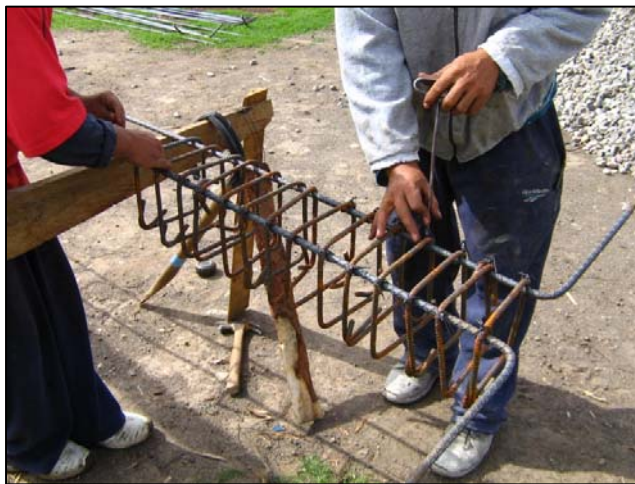
FIGURA 77.- ARMADO DE REFUERZO PARA COLUMNA
