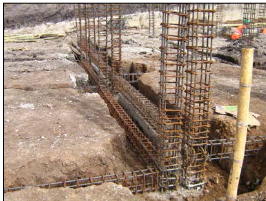
FIGURA 78.- DETALLE REFUERZO DE COLUMNAS COLINDANTES
