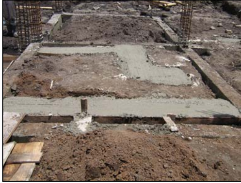
FIGURA 95.- CONCRETO CICLÓPEO
