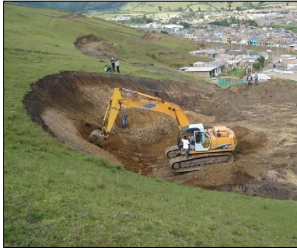
FIGURA 49.- ESCARIFICACIÓN DEL TERRENO
