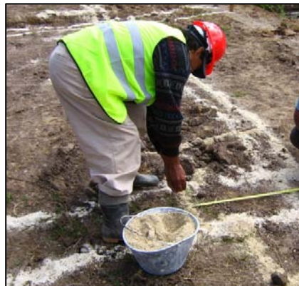
FIGURA 83.- TRAZADO DE VIGAS DE CIMENTACION Y ZAPATAS
