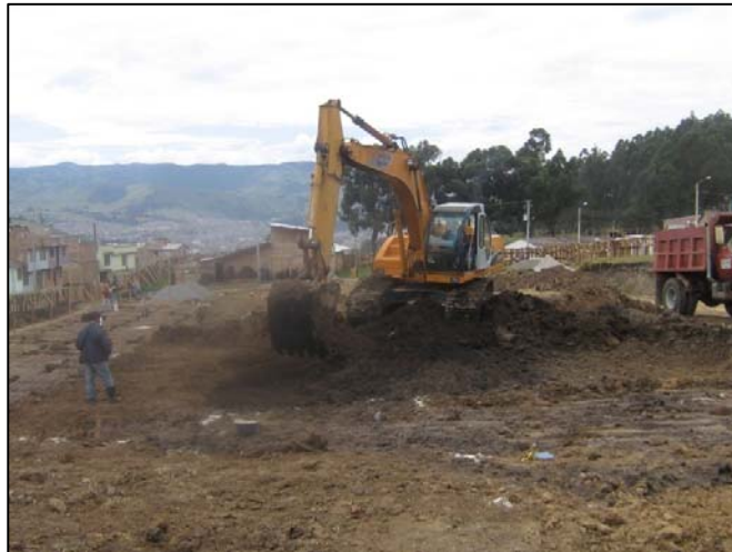
FIGURA 37.- DESCAPOTE Y TERRACEO DE LA SEGUNDA ETAPA DE LA MANZANA B
