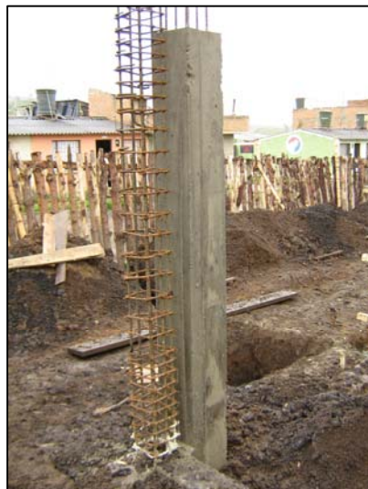
FIGURA 98.- JUNTA POR CONSTRUCCIÓN EN COLUMNAS COLINDANTES
