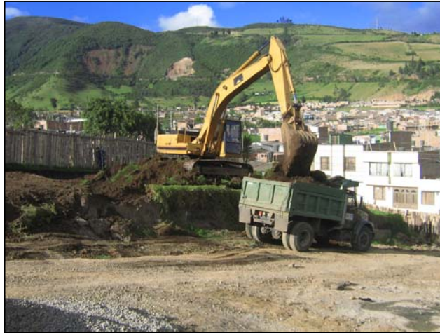
FIGURA 42.- DESCAPOTE Y TERRACEO DE LA MANZANA E
