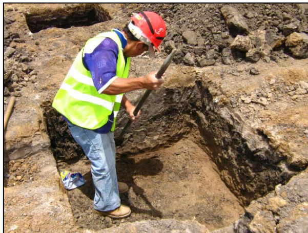
FIGURA 84.- EXCAVACIONES PARA LA CIMENTACIÓN
