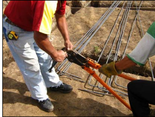
FIGURA 67.- CORTE DE REFUERZO
