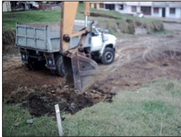
FIGURA 32.- CORTE Y CARGUE DE MATERIAL DE LA CALLE 35 ENTRE CARRERA 32 Y CARRERA 32B
