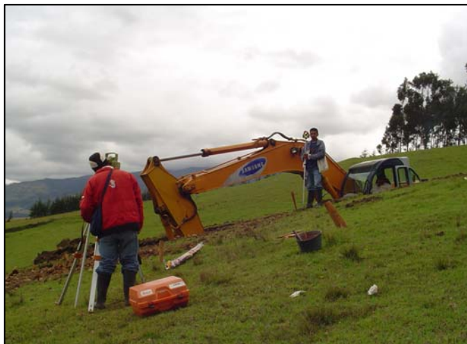
FIGURA 17.- LOCALIZACIÓN Y REPLANTEO DE LAS VÍAS
