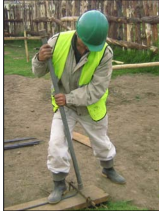
FIGURA 74.- FIGURADO DEL REFUERZO LONGITUDINAL
