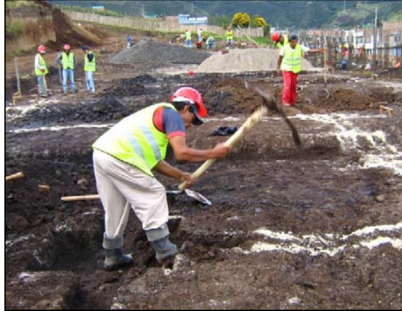
FIGURA 90.- EXCAVACIÓN PARA VIGAS DE CIMENTACIÓN
