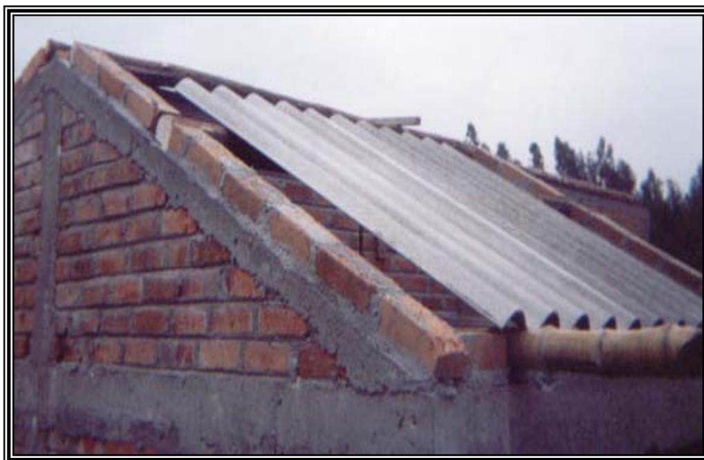
Figura 73. Colocación de teja asbesto - cemento
