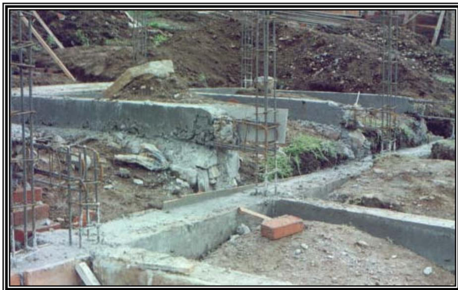
Figura 52. Desencofrado de vigas de cimentación
