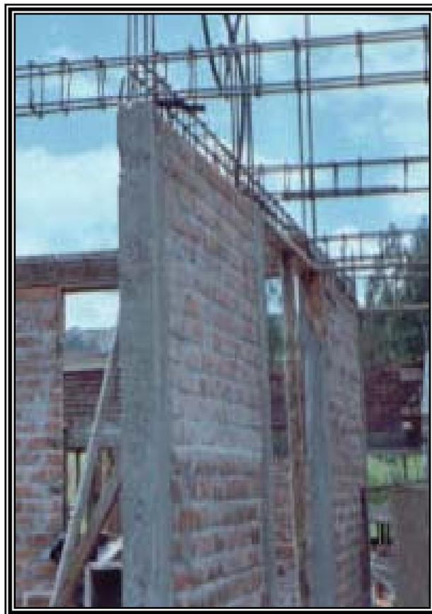
Figura 57. Columna terminada
