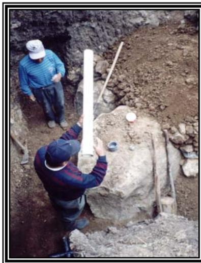
Figura 4. Tubería UZ PVC 3" RDE 21.
