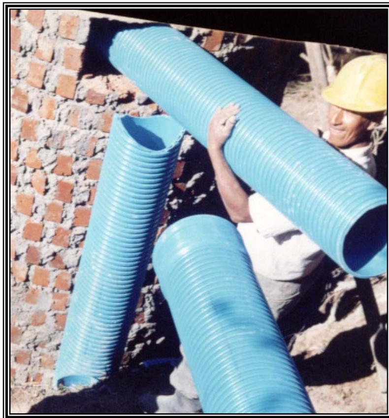
Figura 24. Corte y acople de los tubos en la construcción de una Tee.
