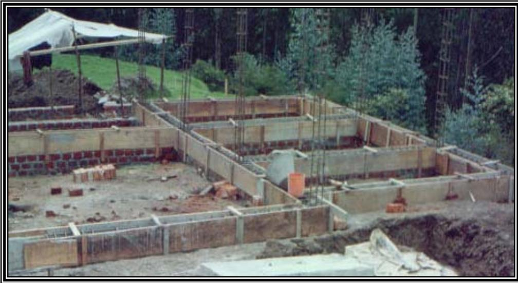
Figura 51. Formaletas para vigas de cimentación
