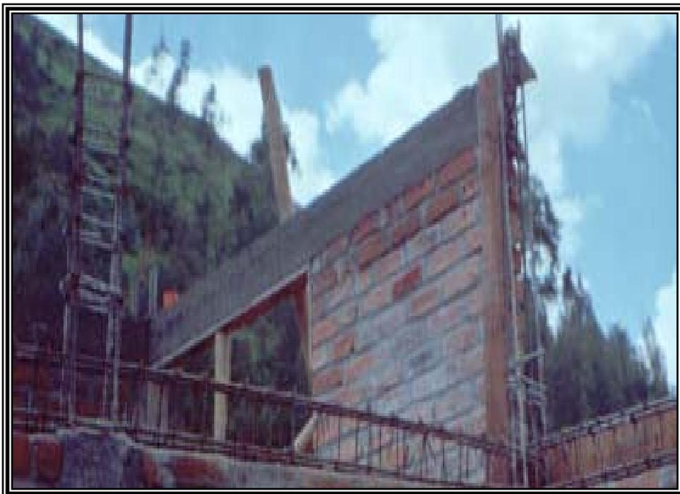
Figura 70. Desencofrado de viga de amarre
