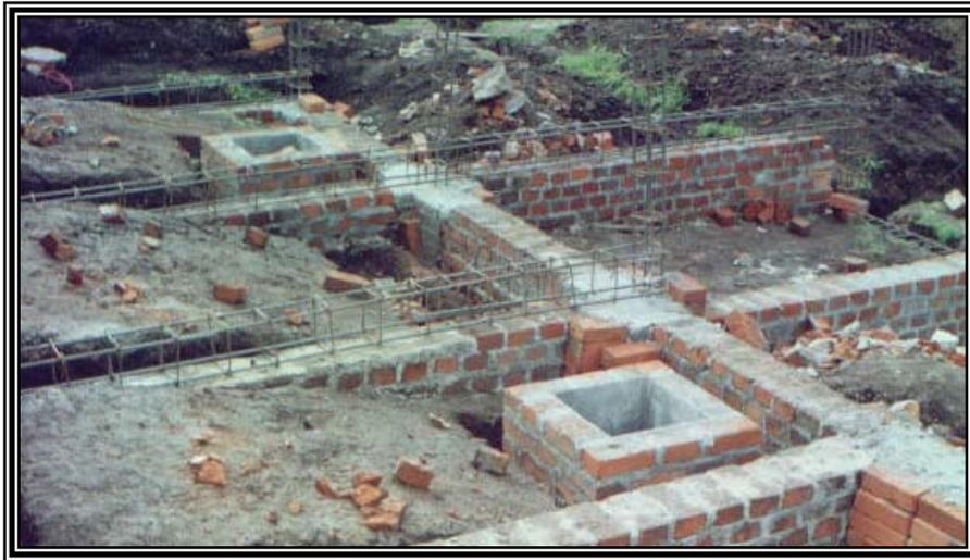
Figura 50. Ubicación acero de refuerzo en vigas de cimentación
