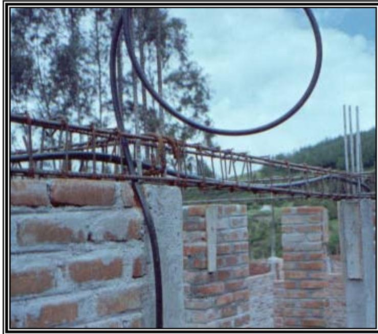
Figura 64. Instalación eléctrica antes de fundir vigas
