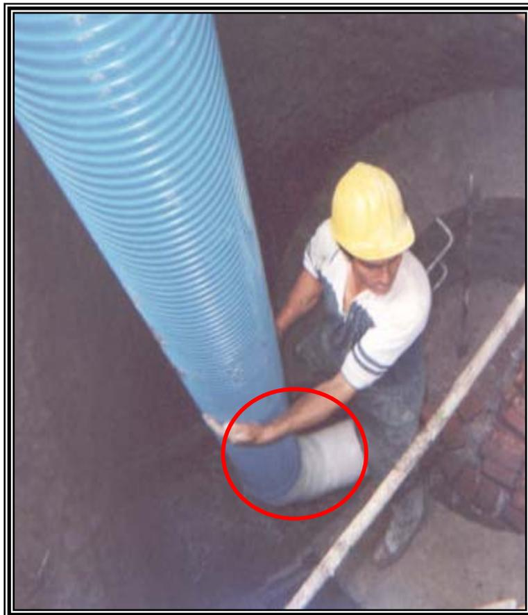
Figura 23. Detalle codo para cámara de caída
