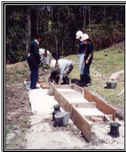
Figura 11. Construcción de tapas para válvulas.
