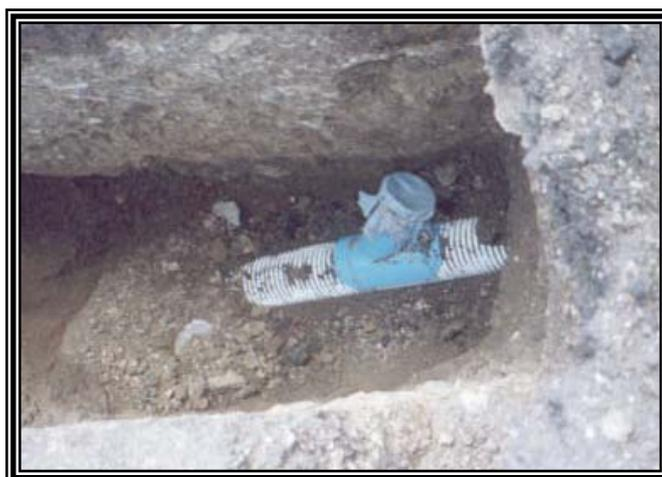
Figura 16. Silla tubería NOVAFORT.
