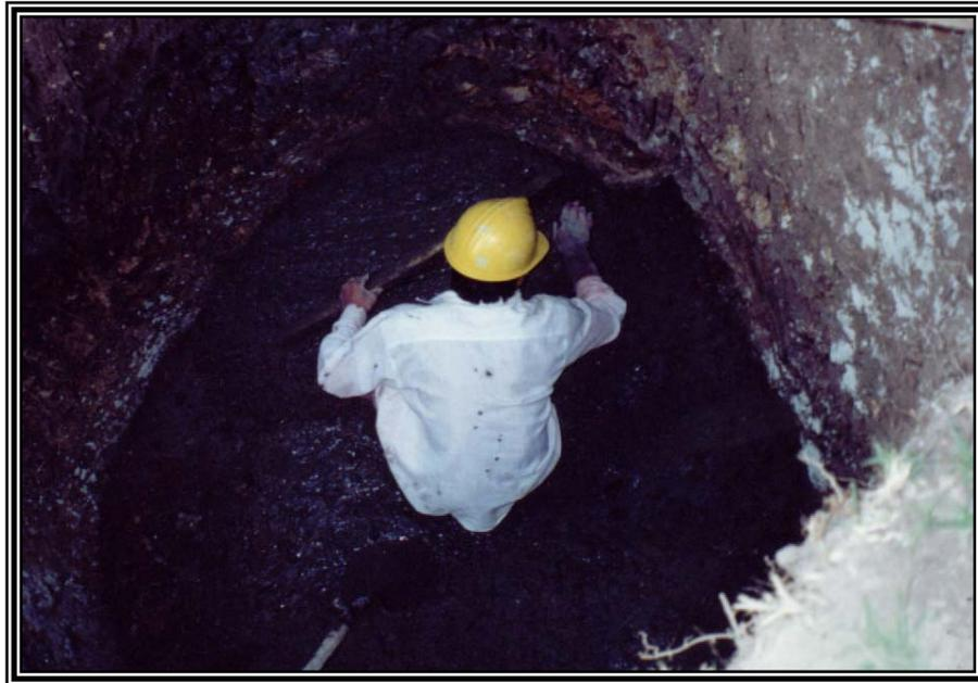
Figura 18. Excavación para cámara de caída
