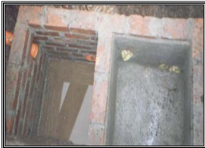
Figura 61. Detalle cajillas exteriores sin esmaltar
