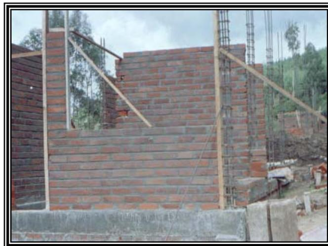
Figura 56. Conformación de formaleta para columna
