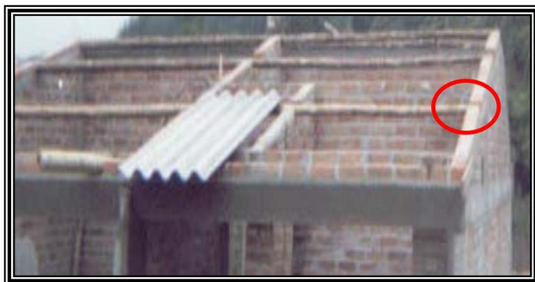
Figura 72. Detalle de colocación de madera rolliza
