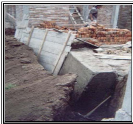
Figura 74. Construcción muro de contención en concreto
