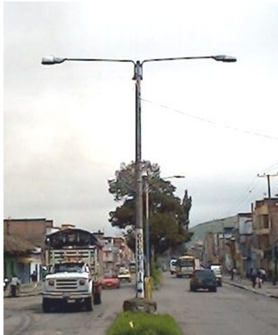
Foto 27. Luminaria Vial. Avenida Colombia.
