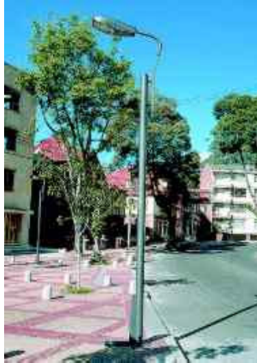
Foto 24. Luminaria peatonal Medellín.
