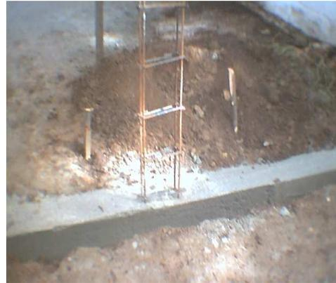
Posteriormente se instaló la tubería sanitaria en PVC de 3" que llevaría internamente el centro de acopio. Siguiendo el diseño sanitario se marcó previamente los puntos de los sifones con estacas para su correcta ubicación, así como el trazo de la ruta de la tubería hasta la caja de inspección de 0,6 \* 0,6 m .
