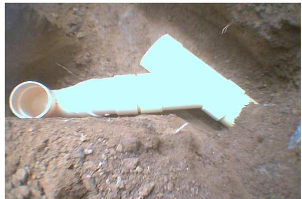
La tubería sanitaria de 3" y los diferentes accesorios fueron limpiados cuidadosamente, se les aplicó soldadura para su buen funcionamiento y adecuada adherencia. A continuación se rellenó y compactó la zanja.
