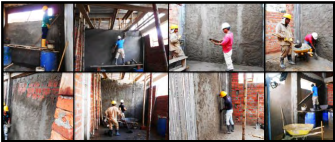
Figura 34. Repello de muros internos del bloque de alojamiento.
