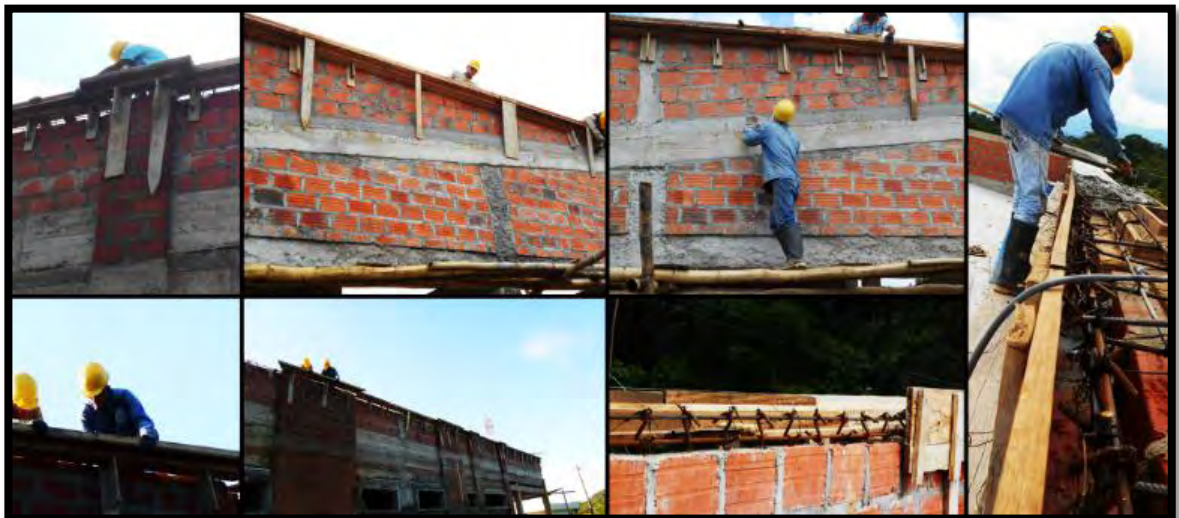
Figura 28. Proceso de construcción de alfajías del bloque de alojamiento.
