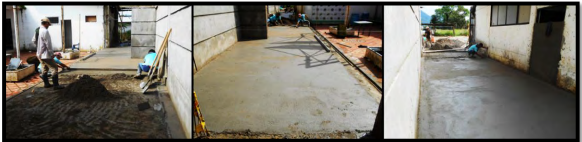
Figura 27. Construcción de andenes del bloque de alojamiento.
