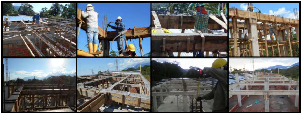
Figura 18. Proceso constructivo de vigas aéreas del bloque de alojamiento.
