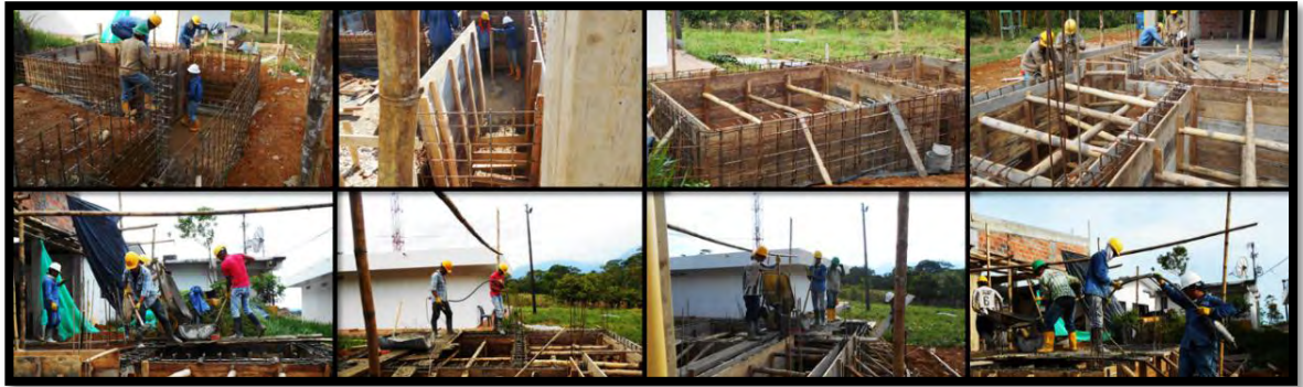
Figura 32. Fundición del tanque del bloque de alojamiento.
