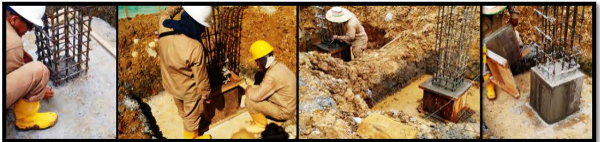
Figura 11. Proceso constructivo de pedestales del restaurante escolar.
