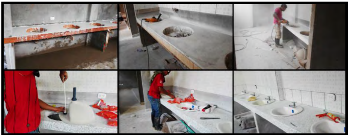
Figura 47. Proceso de instalación de lavamanos del bloque de alojamiento.
