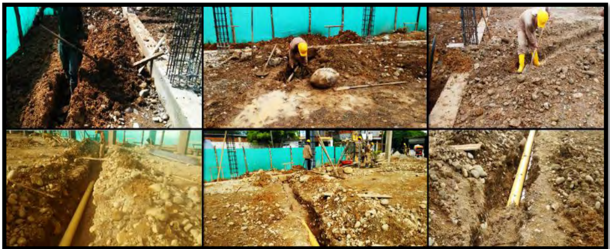
Figura 14. Instalación de tubería sanitaria del restaurante escolar.
