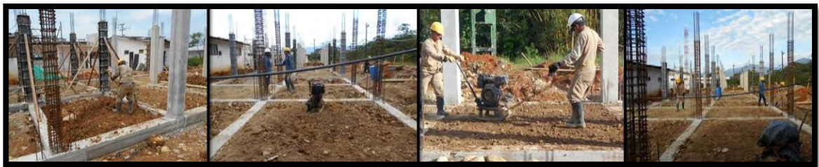
Figura 15. Compactación de la superficie del bloque de alojamiento.
