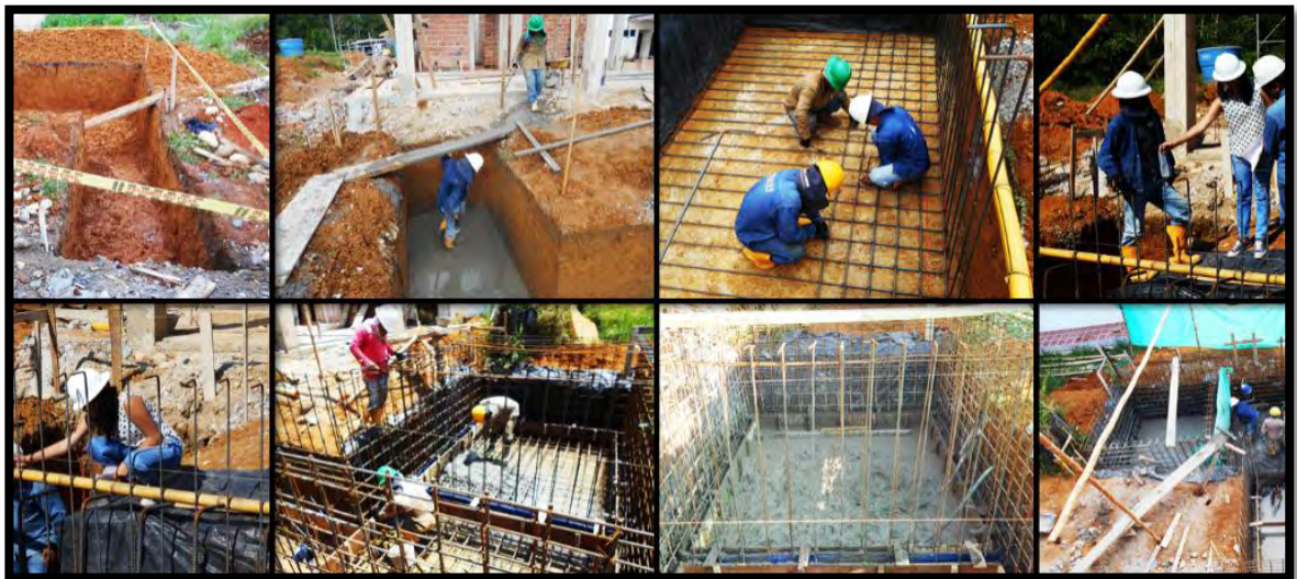
Figura 31. Construcción del tanque del bloque de alojamiento.
