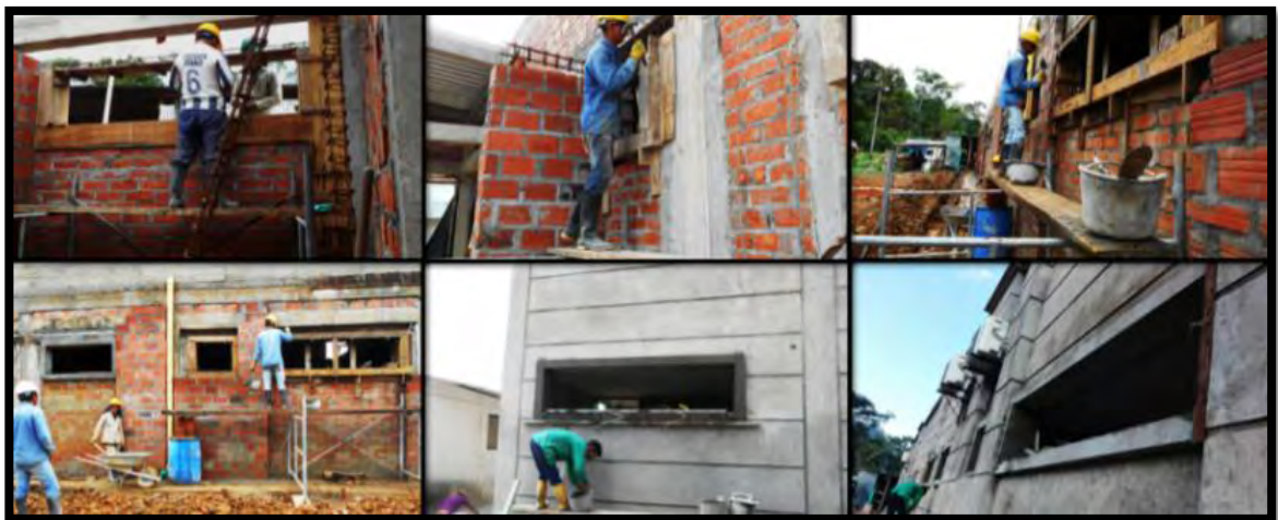
Figura 26. Construcción de dinteles del bloque de alojamiento.
