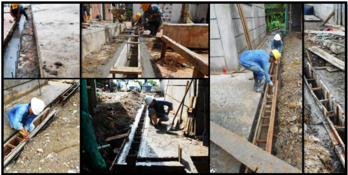
Figura 29. Construcción de cañuelas perimetrales del bloque de alojamiento.
