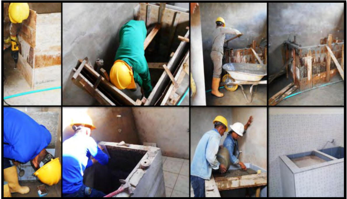
Figura 46. Construcción del lavadero del bloque de alojamiento.
