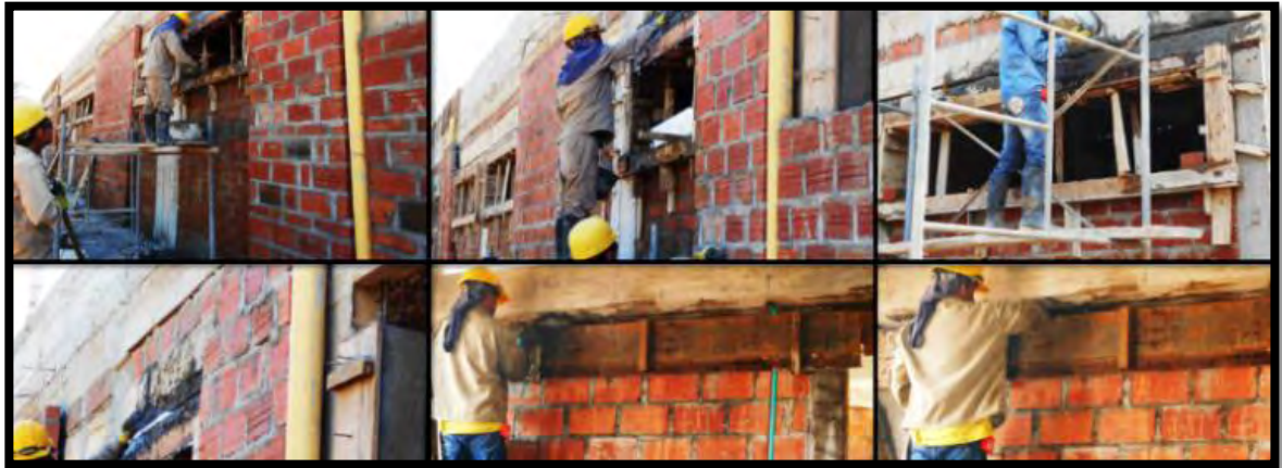
Figura 25. Fundición de viguetas del bloque de alojamiento.
