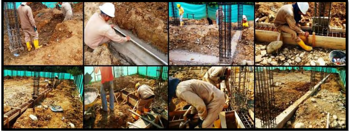
Figura 12. Construcción de vigas de cimentación del restaurante escolar.
