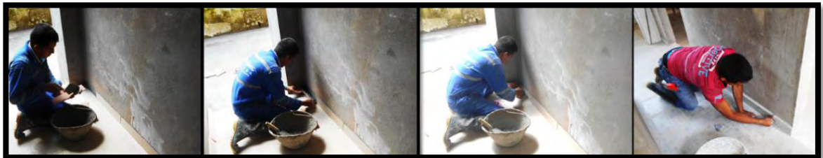
Figura 41. Instalación de guardaescobas en el bloque de alojamiento.
