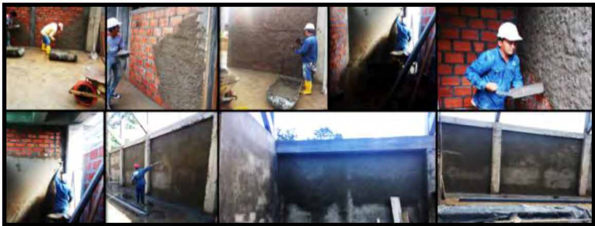
Figura 35. Repello de muros internos del restaurante escolar.
