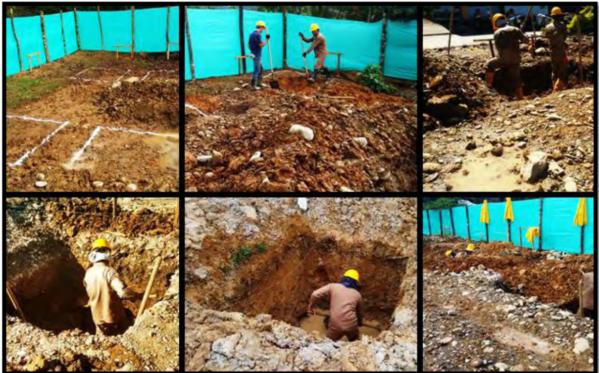
Figura 7. Excavaciones para zapatas del restaurante escolar.
