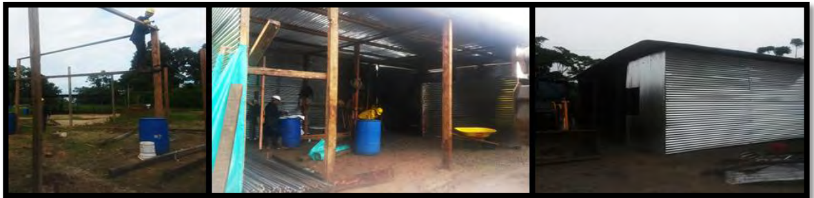
Figura 6 . Construcción del campamento del bloque de alojamiento.
