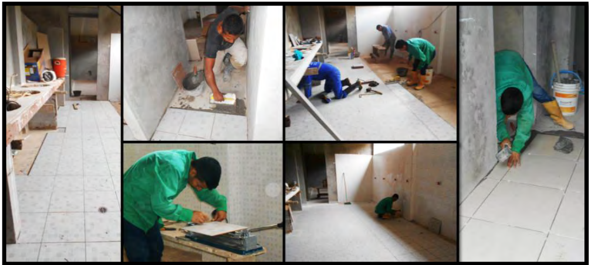
Figura 40. Instalación de enchape de pisos en el bloque de alojamiento.
