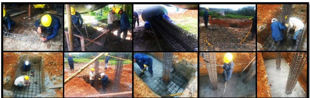
Figura 10. Proceso constructivo de zapatas del restaurante escolar.
