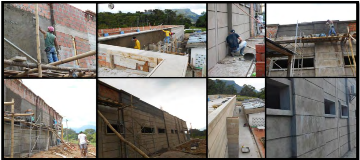
Figura 36. Repello de muros exteriores del bloque de alojamiento.
