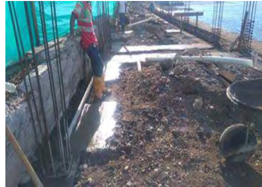
Foto 17.1. Relleno compactado con material
