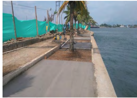
Foto 57. Fundición por paños
