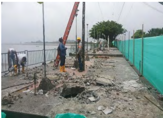
Foto 5. Retiro de postes de iluminación
