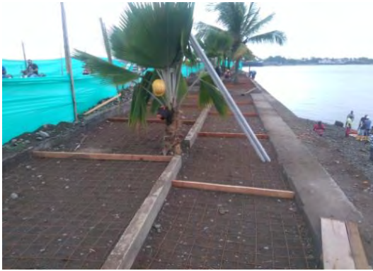
Foto 56. Instalación de malla eléctrosoldada
