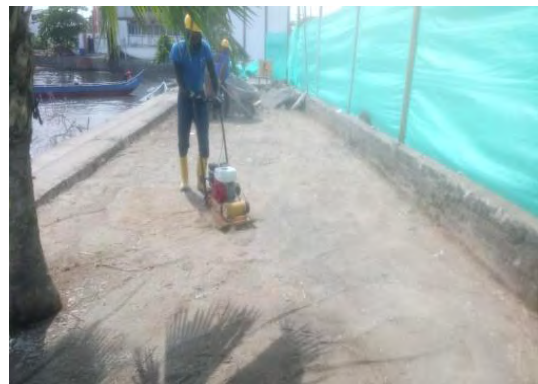
Foto 16. Compactación con placa vibratoria
