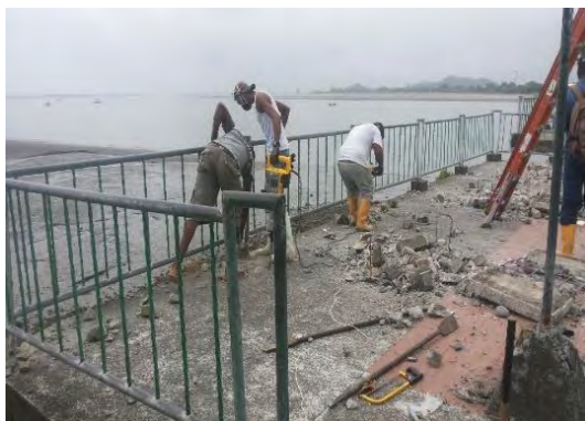
Foto 7. Demolición con taladro de punta
