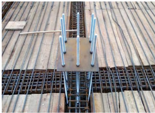
Foto 49. Soporte de estructura de cubierta
