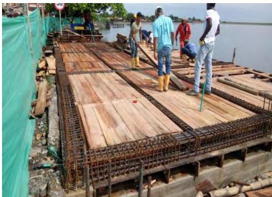
Foto 43. Formaleta en madera losa maciza
