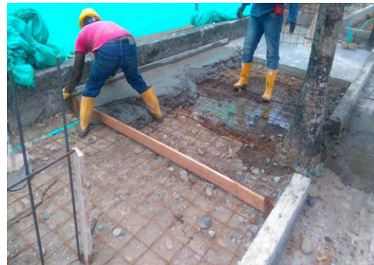
Foto 59. Nivelación con codal.
