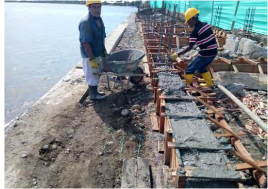
Foto 32. Fundición viga de cimentación
