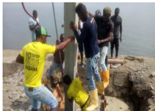
Foto 23. Hincado de pilotes.
