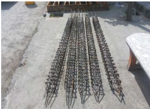
Foto 20. Acero de refuerzo pilotes.
