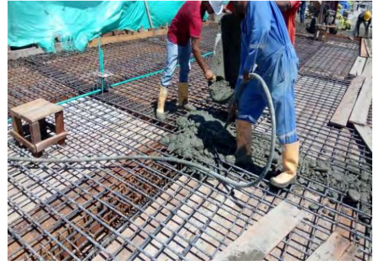
Foto 46. Vibrado del concreto.
