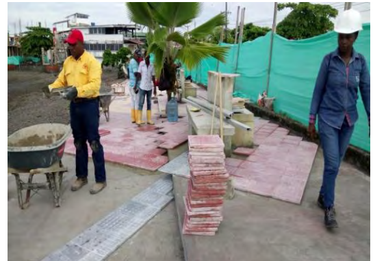
Foto 63. Piso cerámica mirador lado derecho.
