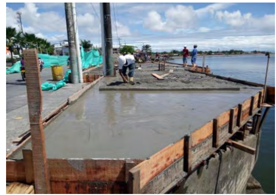
Foto 48. Nivel con codal metálico.
