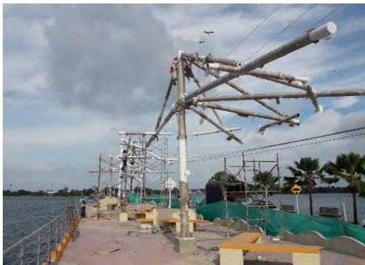
Foto 64. Estructura de cubierta
