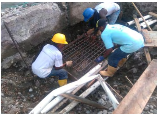
Foto 26. Instalación parilla zapata
