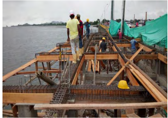
Foto 41. Formaleta de madera vigas aéreas.
