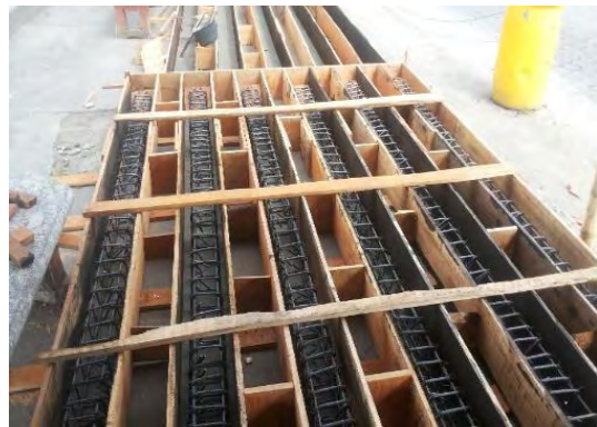
Foto 21. Formaleta de madera pilotes
