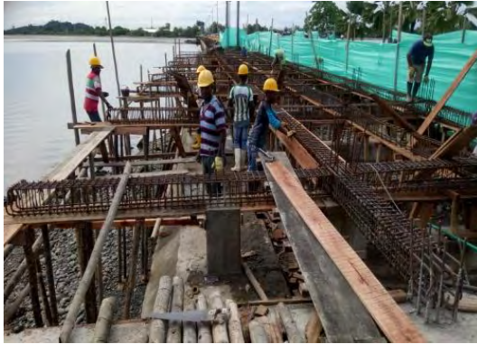
Foto 40. Acero de refuerzo vigas aéreas.
