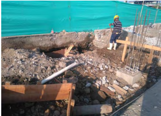
Foto 17. Relleno compactado con material
