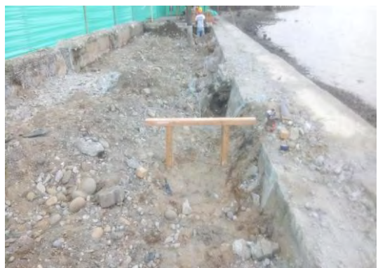
Foto 12. Localización y replanteo.
