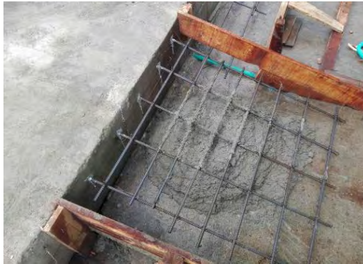
Foto 54. Rampas en concreto.
