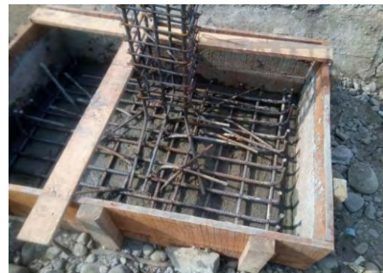
Foto 27. Instalación castillo columna
