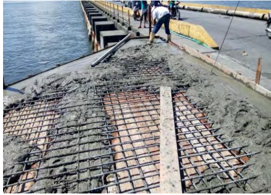
Foto 45. Fundición de vigas aéreas
