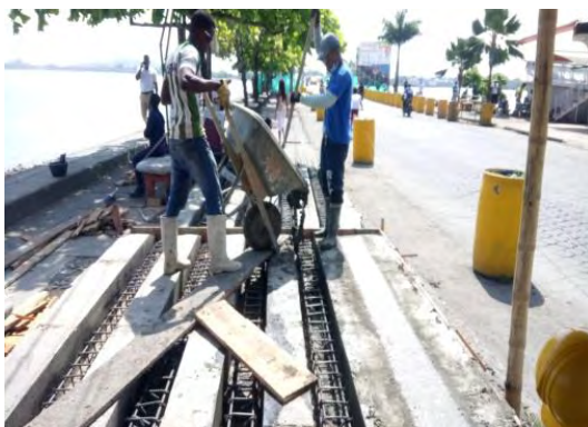
Foto 22. Fundición de pilotes
