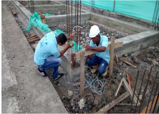
Foto 35. Toma de niveles columnas.
