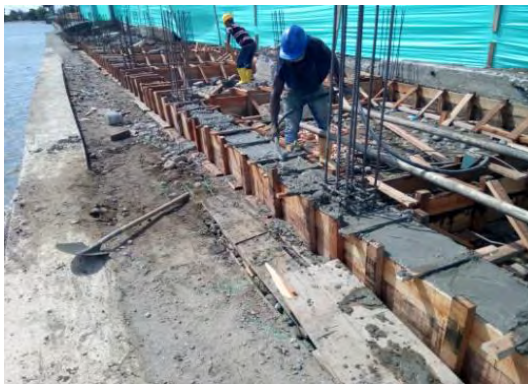
Foto 33. Vibrado del concreto
