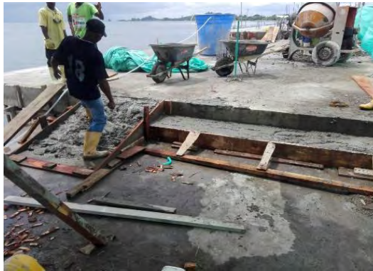
Foto 51. Escalera en concreto reforzado.
