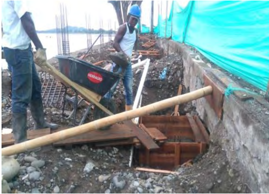
Foto 24. Fundición de solados.
