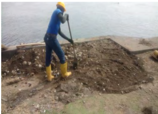
Foto 15. Relleno con súbase granular.
