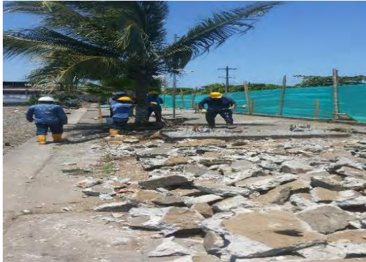
Foto 9. Demolición losa de contrapiso.
