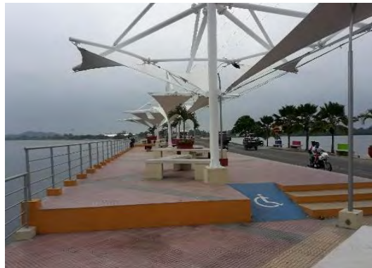
Foto 68. Pintura superficies en concreto.
