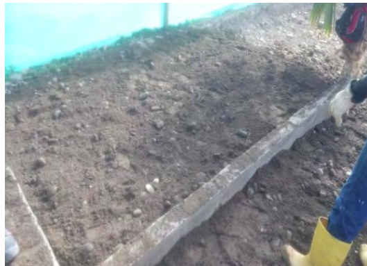
Foto 69. Sardinel concreto reforzado.
