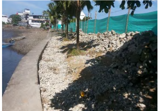
Foto 10. Demolición total losa.
