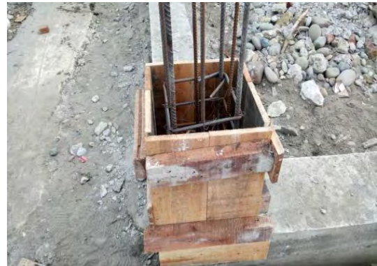
Foto 36. Formaleta y acero de refuerzo
