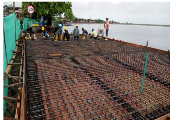
Foto 44. Acero de refuerzo losa maciza
