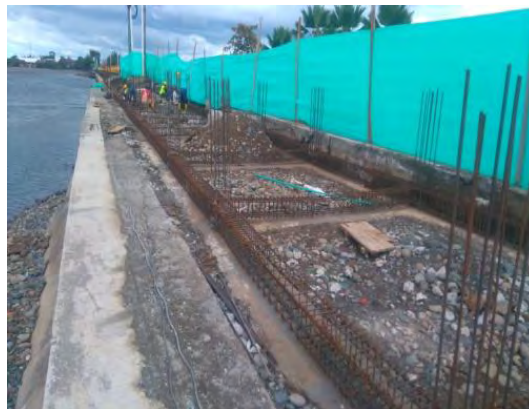
Foto 30. Acero de refuerzo viga de cimentación.
