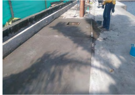
Foto 61. Alistado de piso mirador izquierdo
