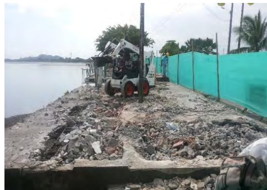
Foto 6. Demolición con bobcat
