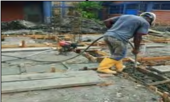
Foto 45. Vibrado de viga de cimentación
