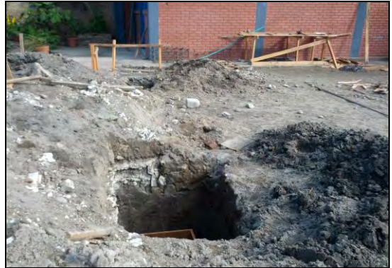
Foto 40. Excavación de zapatas
