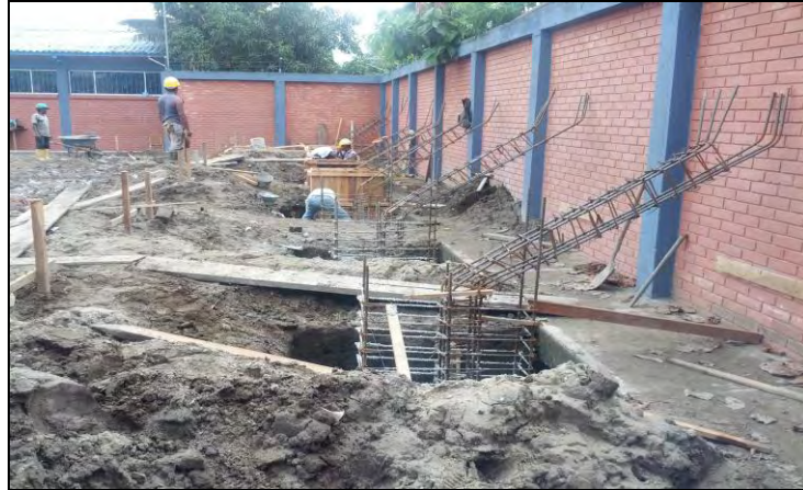
Foto 76. Proceso de fundición de viga inclinada
