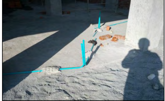
Foto 63. Instalación de tubería
