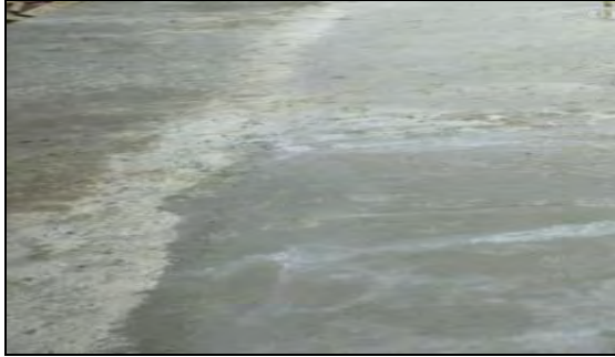
Foto 47. Losa de contrapiso
