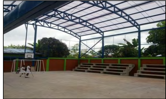
Foto 89. Estado final de la cubierta
