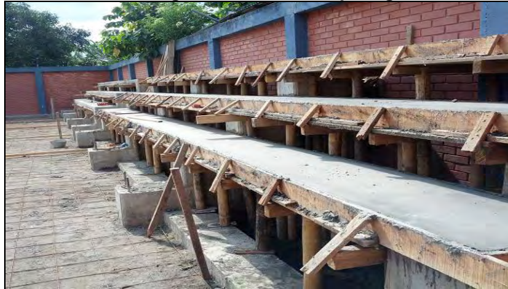
Foto 78. Viga de Cimentación para gradas
