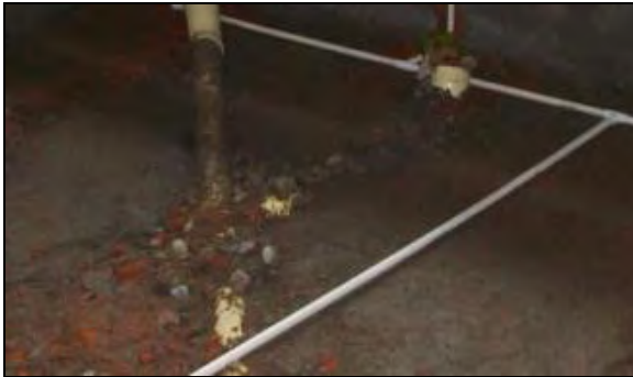
Foto 64. Red de distribución
