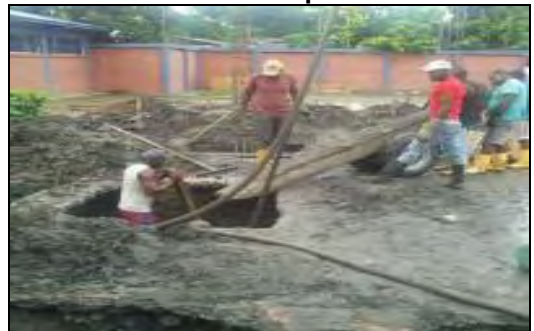
Foto 42. Hincado de pilotes
