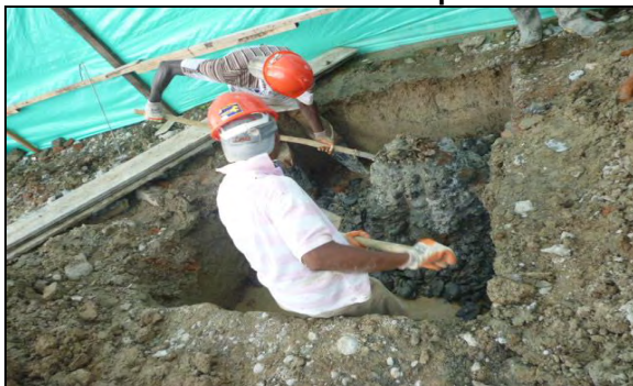
Foto 2. Excavación de zapatas
