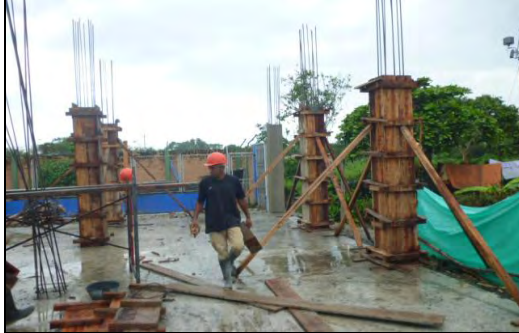
Foto 12. Encofrado de columnas para fundición
