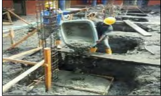
Foto 44. Fundición de zapata
