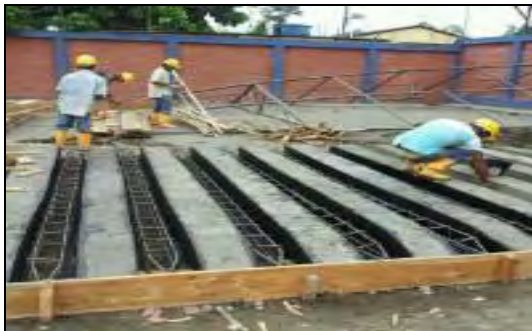
Foto 41. Pilotes construidos en sitio
