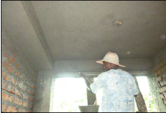
Foto 27. Pañete sobre ladrillo común
