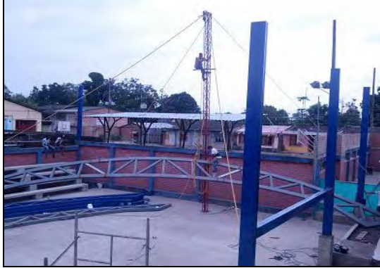
Foto 82. Construcción de estructura metálica
