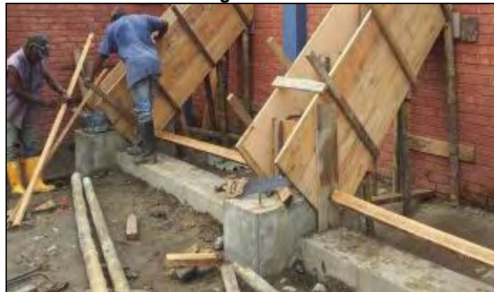
Foto 77. Viga de cimentación
