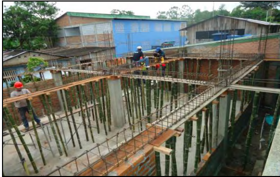
Foto 19. Armado de viga
