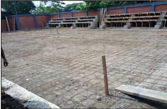
Foto 79. Tendido de malla electrosoldada
