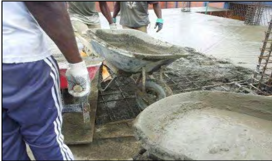
Foto 55. Proceso de fundición de losa
