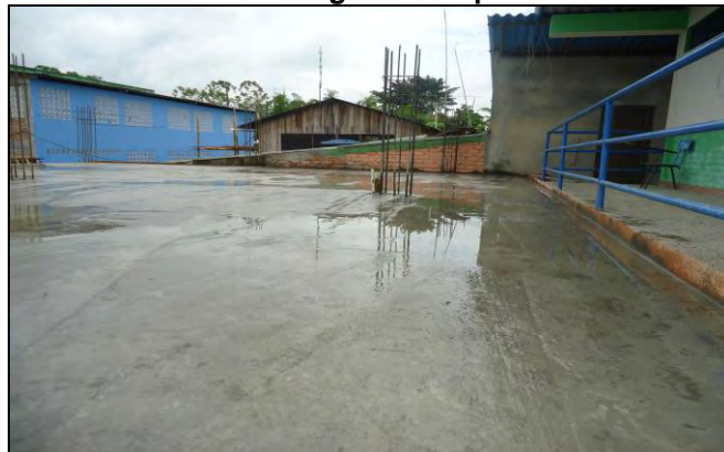
Foto 18. Pega de mampostería
