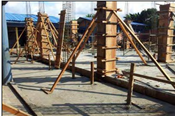
Foto 49. Columnas con formaletas
