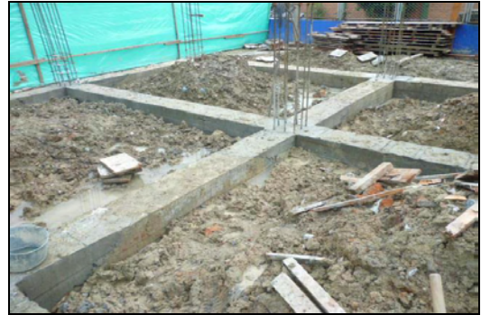
Foto 7. Viga de cimentación fundida
