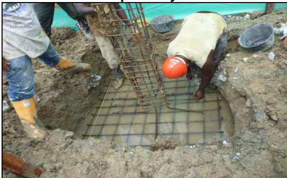
Foto 4. Acero de parrilla y columna
