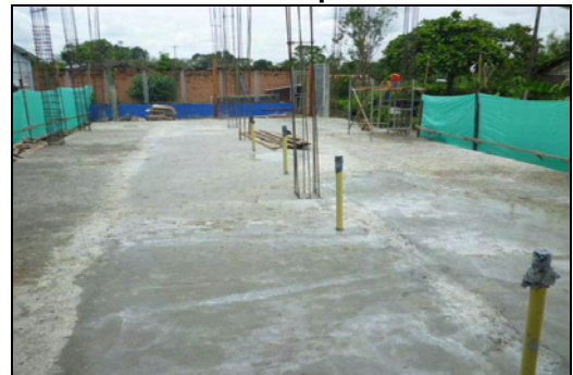
Foto 11. Losa de contrapiso fundida
