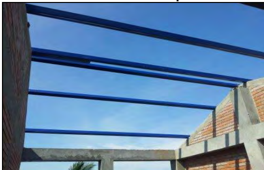
Foto 60. Estructura metálica para cubierta en perlin
