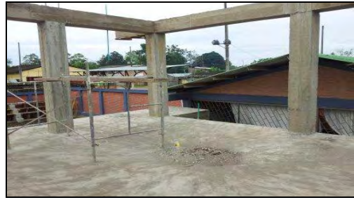
Foto 52. Vigas aéreas fundidas
