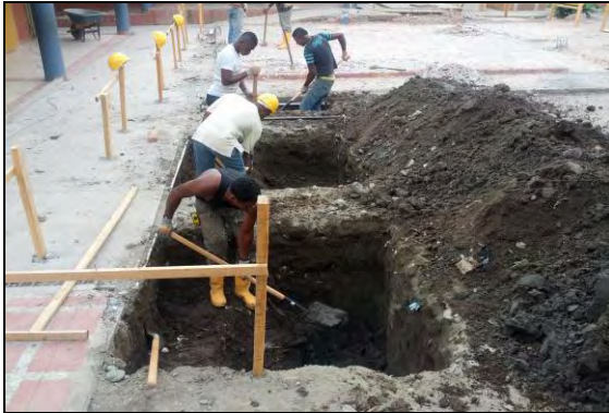
Foto 39. Excavación de zapatas
