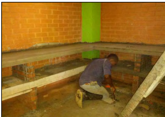
Foto 69. Construcción del Mesón
