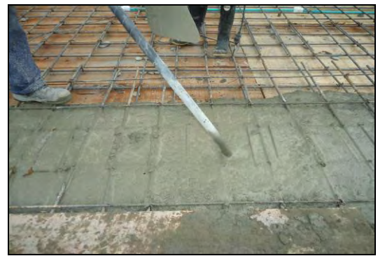
Foto 17. Vibrado de concreto
