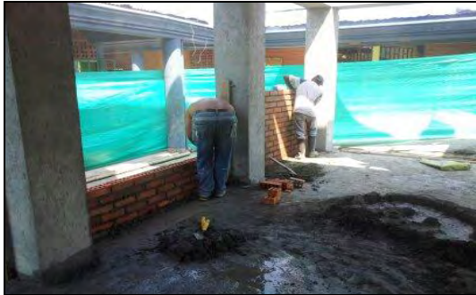
Foto 53. Formaleta para vigas aéreas
