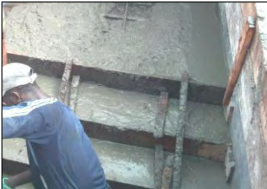
Foto 57. Fundición de escalera
