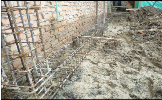
Foto 6. Armado de hierro
