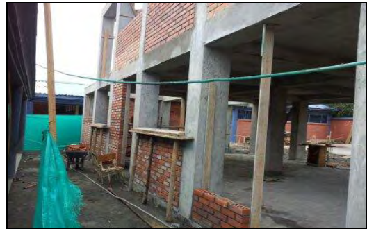
Foto 54. Vigas aéreas fundidas
