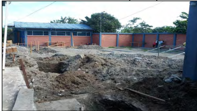
Foto 74. Excavación a mano para zapata
