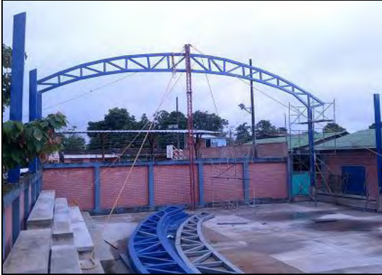
Foto 84. Instalación de cerchas
