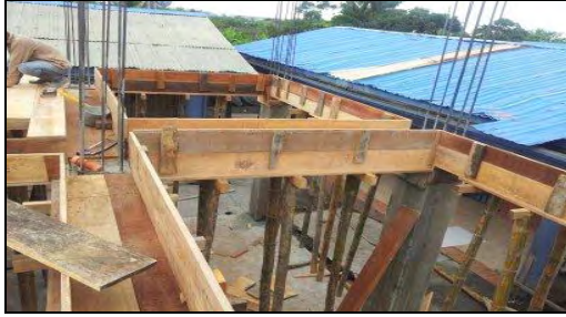
Foto 51. Formaleta para vigas aéreas
