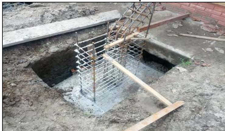
Foto 75. Fundición de zapata
