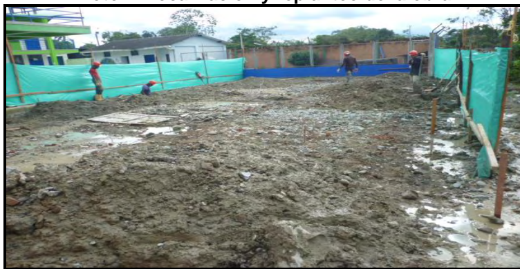
Foto 1. Localización y replanteo de la obra
