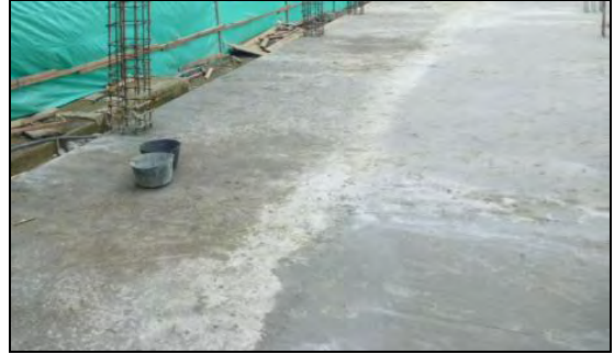
Foto 48. Losa de contrapiso
