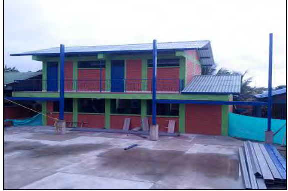
Foto 83. Construcción de estructura metálica
