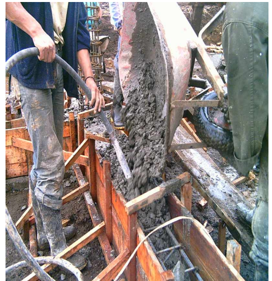
FIGURA 10. Fundición de las vigas de cimentación Bloque 3.
