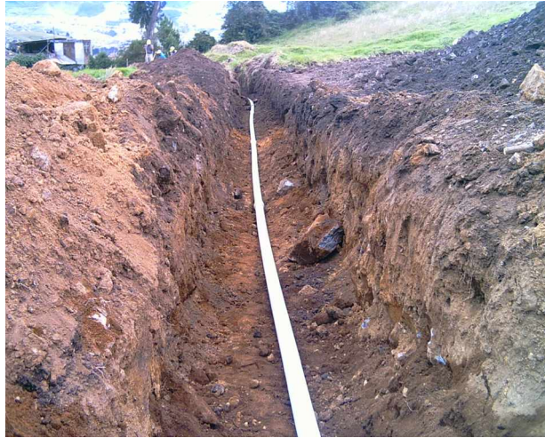
FIGURA 42. Instalación de red hidráulica.
