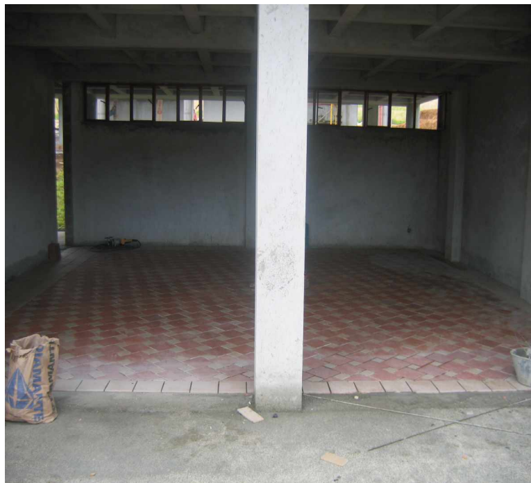
FIGURA 58. Vista general de pisos en el bloque 3
