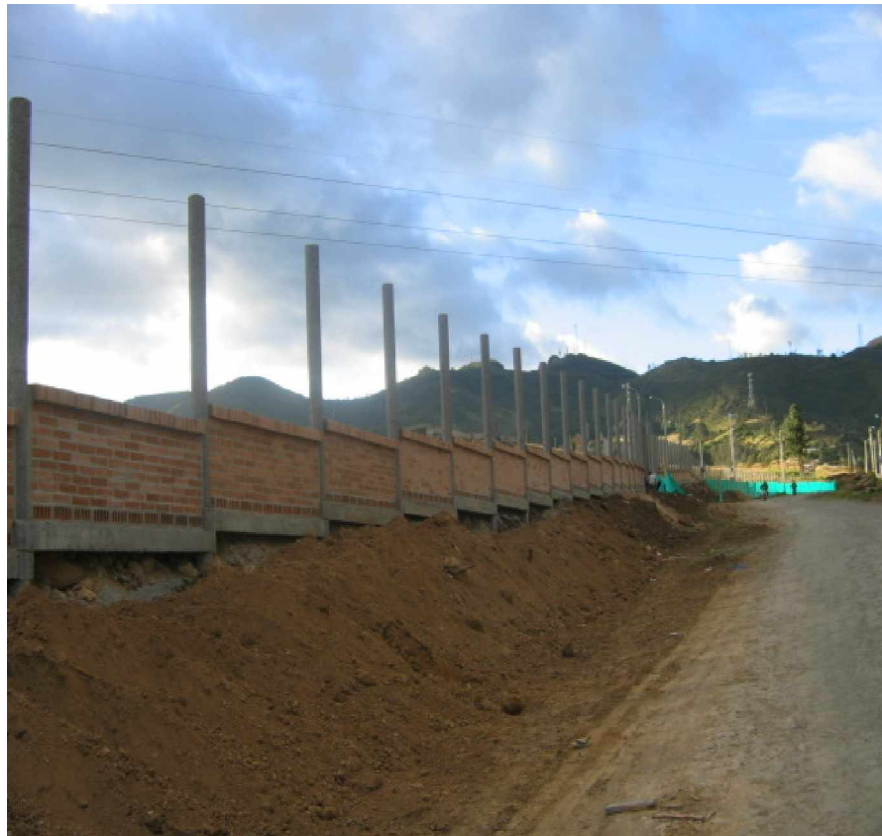
FIGURA 31. Vista general de mampostería de muro de cerramiento
