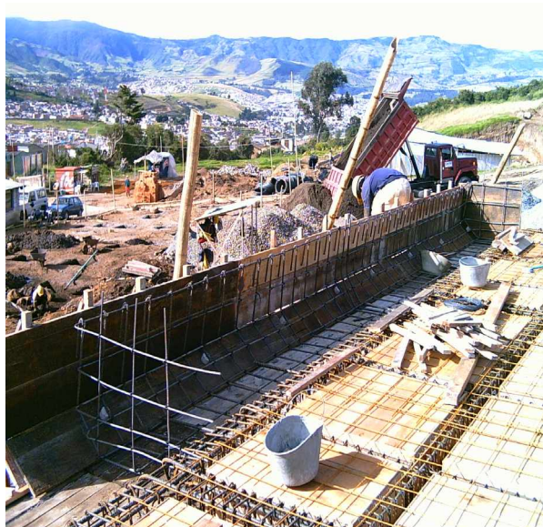
FIGURA 23. Vista general de encofrado viga canal bloque 3
