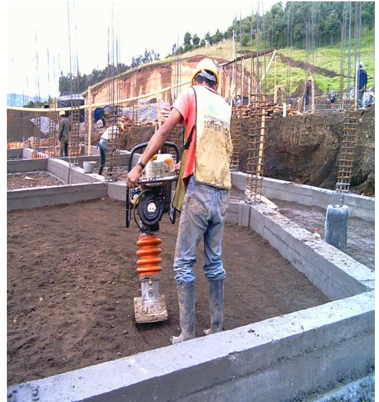
FIGURA 12. Relleno en capas con recebo en el Bloque 2.
