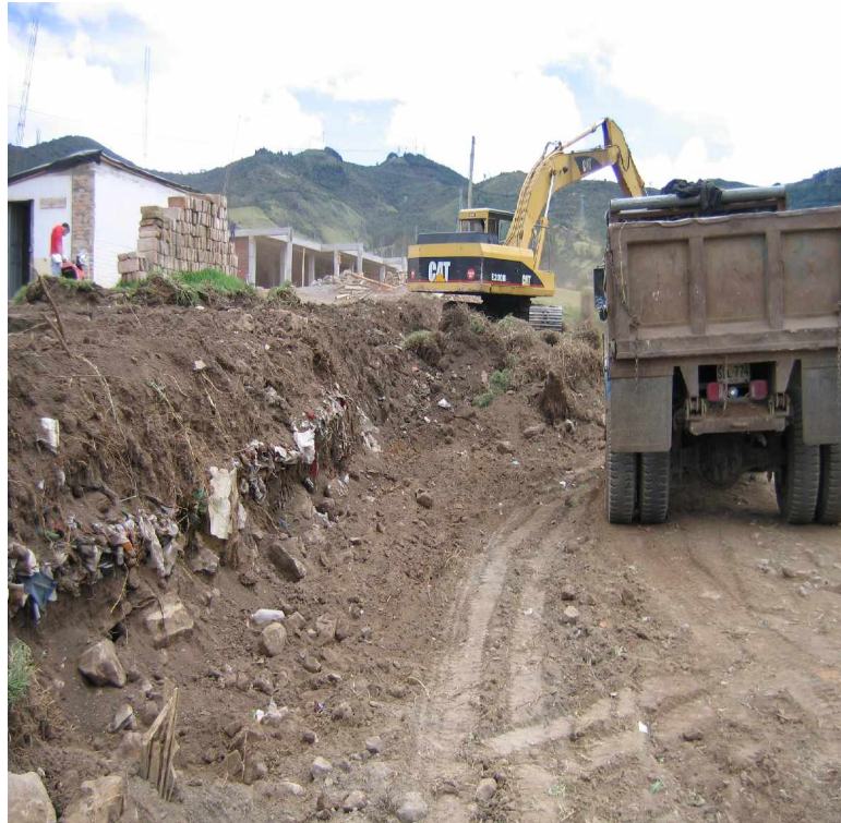
FIGURA 27. Excavación y desalojo de material para nivelación de muro de cerramiento.
