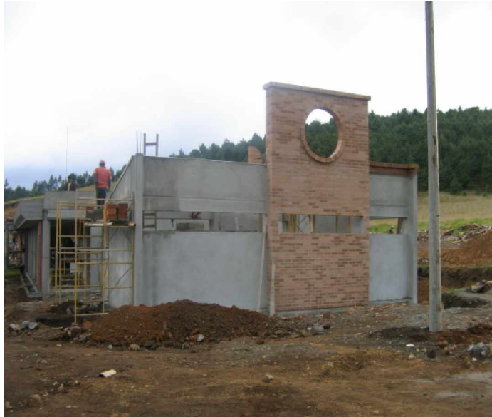
FIGURA 39. Acabado de repello y mampostería en ladrillo visto. Batería sanitaria.
