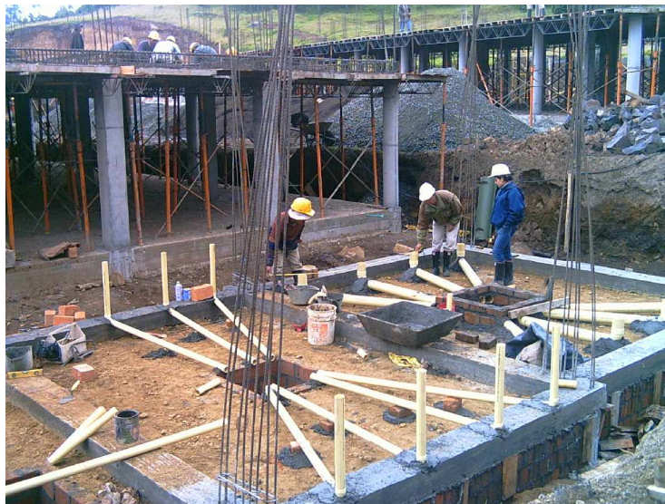
FIGURA 40. Instalación de tubería de 2" y 4" con desagües a Cajas de inspección en batería sanitaria niños.
