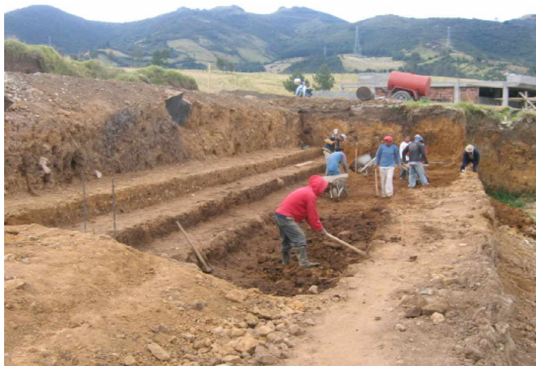
FIGURA 47. Tallado manual de graderías. Zona deportiva
