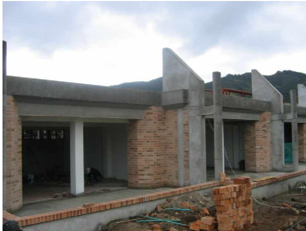
FIGURA 34. Acabado de ladrillo visto bloque 2.
