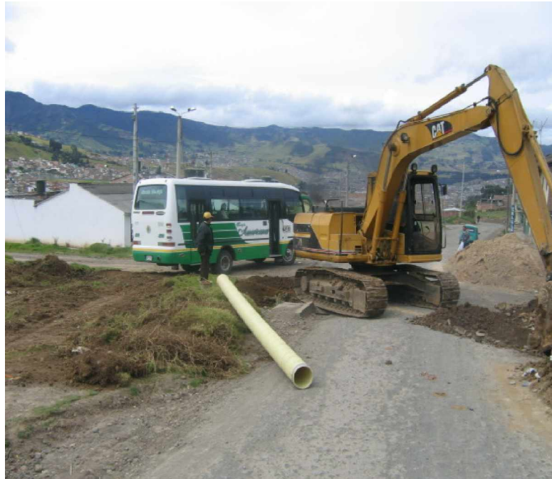
FIGURA 44. Conexión al alcantarillado existente en tubería Novafort de 8" (Alcantarillado sanitario)
