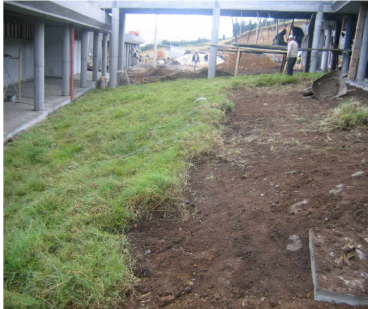
FIGURA 57. Adecuación con césped entre bloque 2-3
