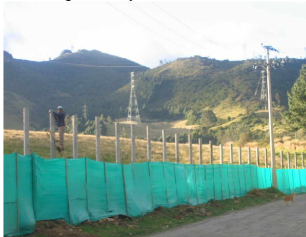
FIGURA 29. Vista general de columnas de muro de cerramiento
