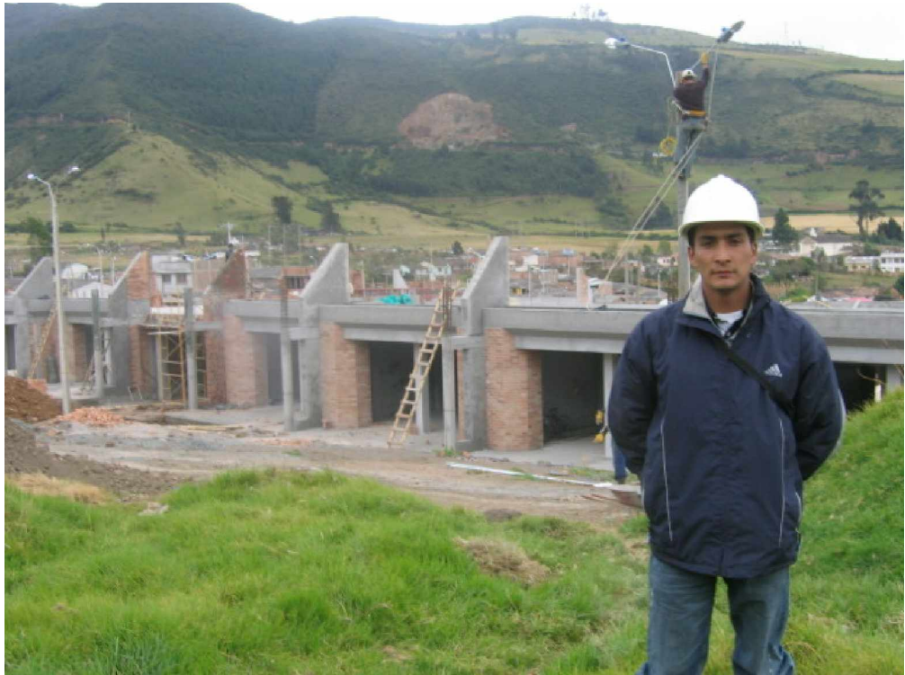
FIGURA 62. Vista general de los bloques 3-4
