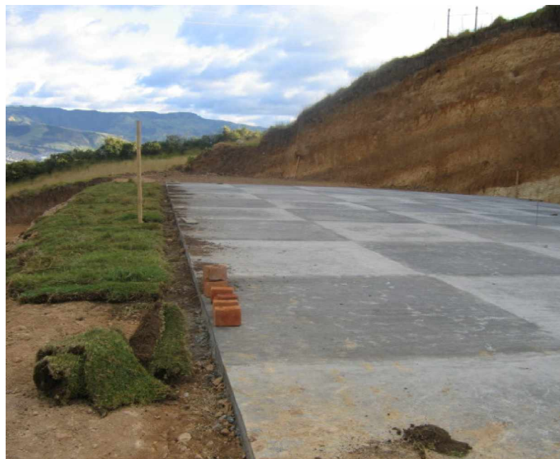
FIGURA 50. Vista general acabado de placa polideportivos
