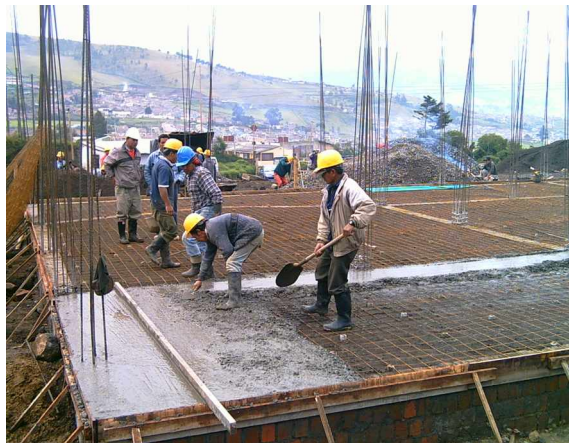
FIGURA 14. Fundición de placa de contrapiso. Bloque 4. (Concreto mezclado en obra).
