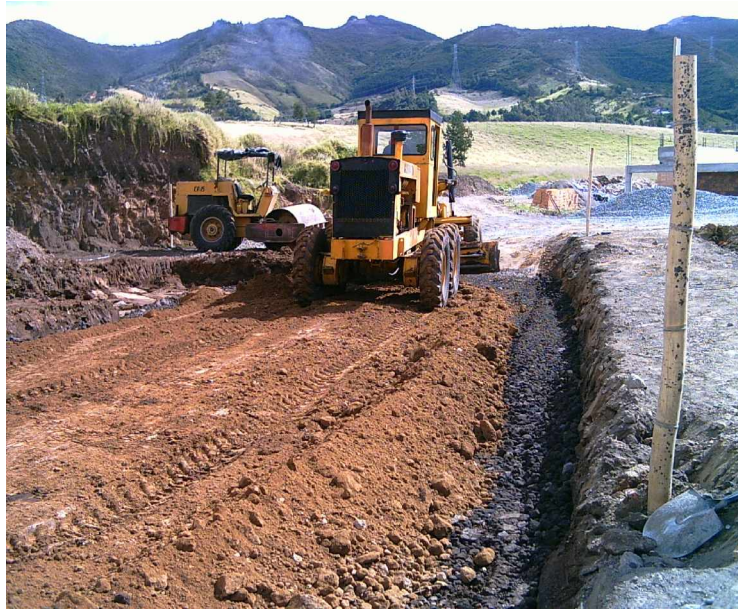
FIGURA 45. Nivelación y compactación. Zona de polideportivos
