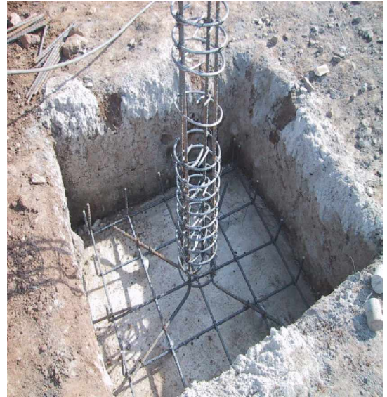
FIGURA 08. Vista parcial de parrillas y hierro de para zapata y columnas, Bloque 4
