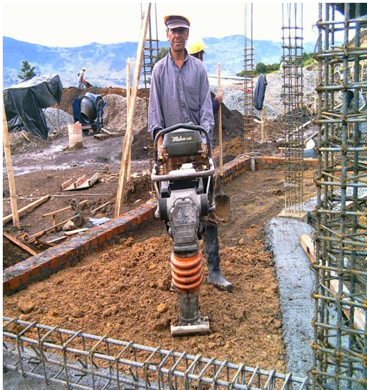
FIGURA 11. Relleno y compactación con material de sitio (Tierra amarilla) en el Bloque 3.
