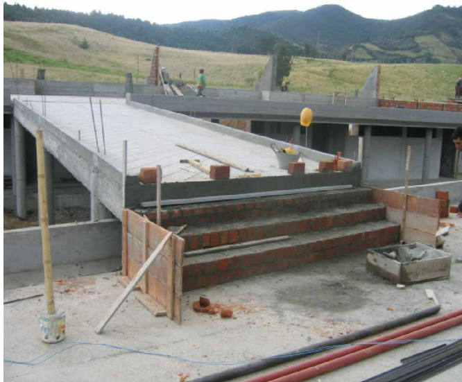
FIGURA 55. Vista general de puente entre bloque 2-3
