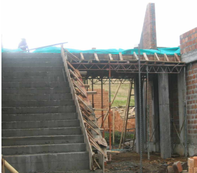
FIGURA 56. Acabado de gradas de acceso al puente entre bloque 2-3
