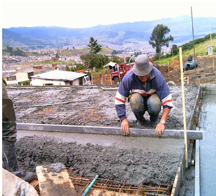
FIGURA 21. Tallado de concreto en fundición losa aligerada del Bloque 1.
