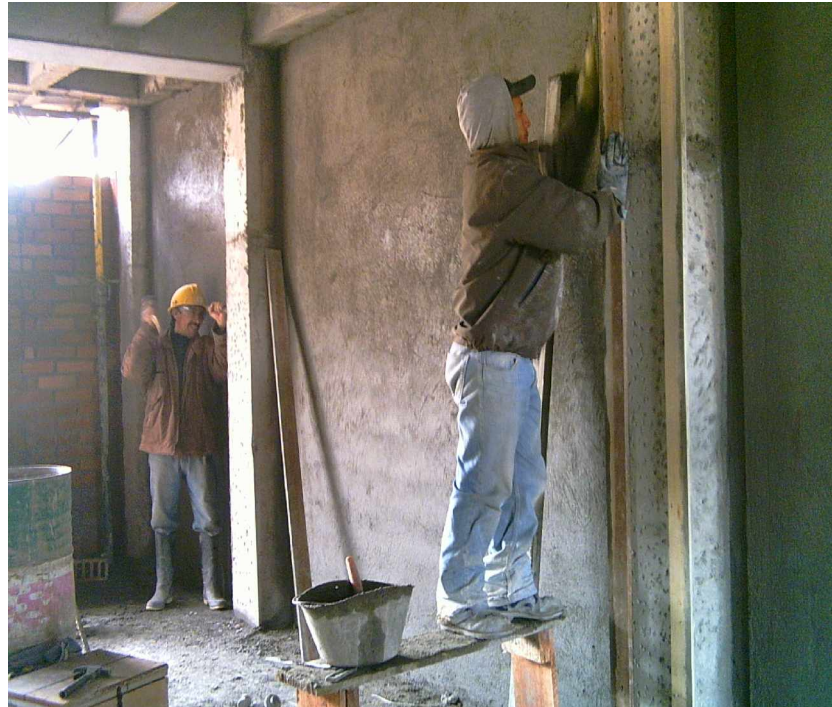
FIGURA 38. Repello de mampostería interna. Bloque 2.
