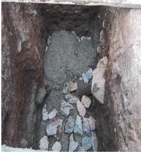
FIGURA 04. Fundición en concreto ciclópeo.
