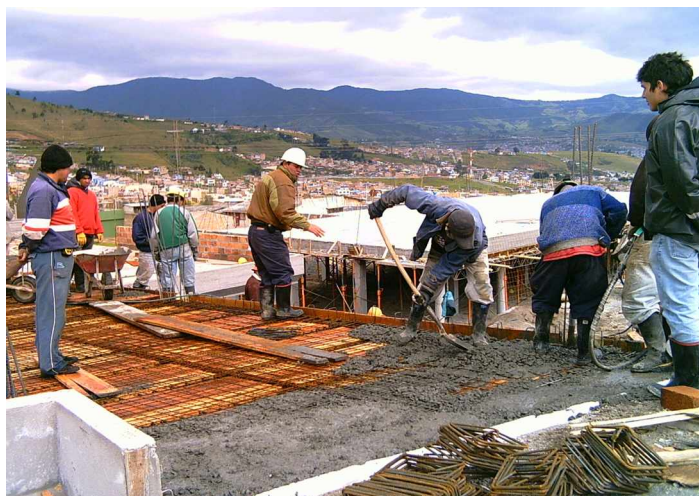
FIGURA 54. Fundición de puente entre bloque 2-3
