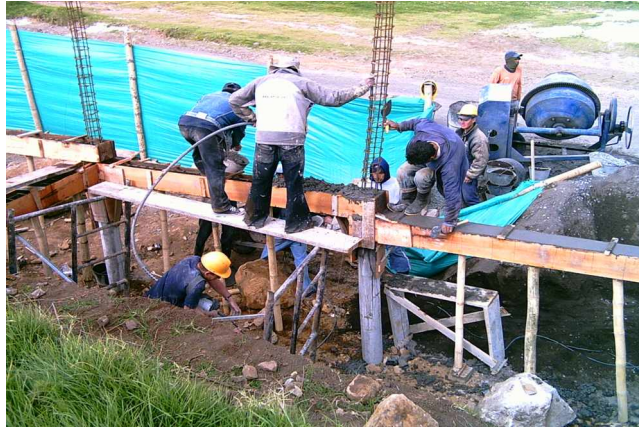
FIGURA 28. Fundición de vigas de cimentación muro de cerramiento.
