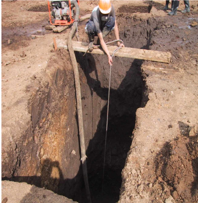
FIGURA 03. Vista parcial de excavación a mano con bombeo (Zapata Bloque 4)
