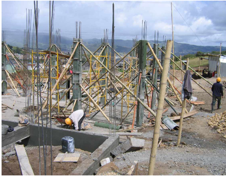
FIGURA 16. Colocación de formaleta metálica para de columnas del Bloque 1.
