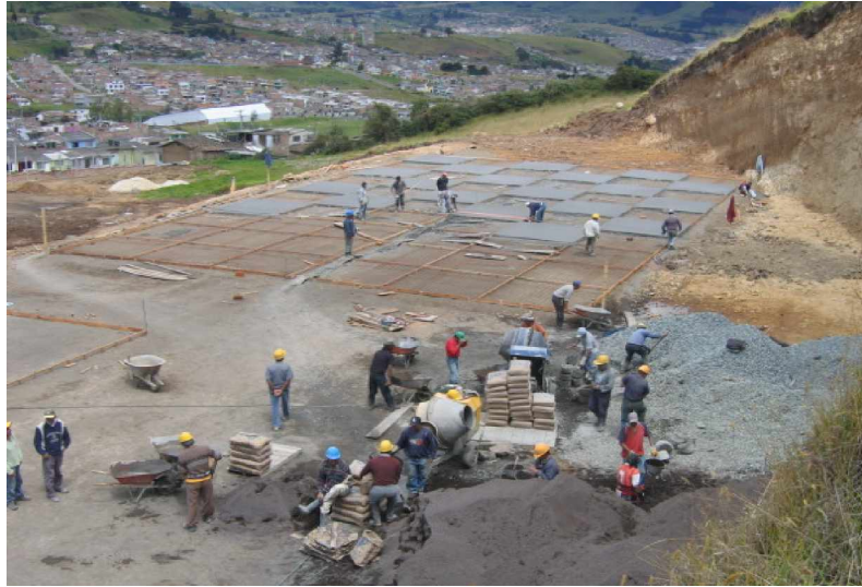
FIGURA 49. Vista general de fundición placa polideportivos.
