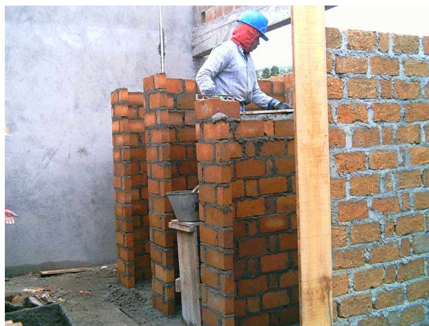
FIGURA 35. Instalación de ladrillo común en baterías sanitarias.
