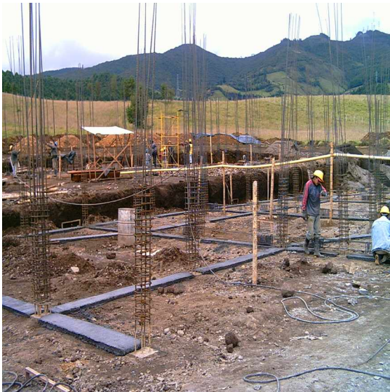
FIGURA 09. Vista general del solado para las vigas de cimentación en el Bloque 2.
