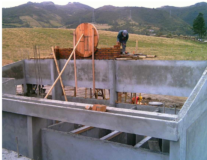
FIGURA 25. Vista general batería sanitaria niñas (acabado de viga canal).
