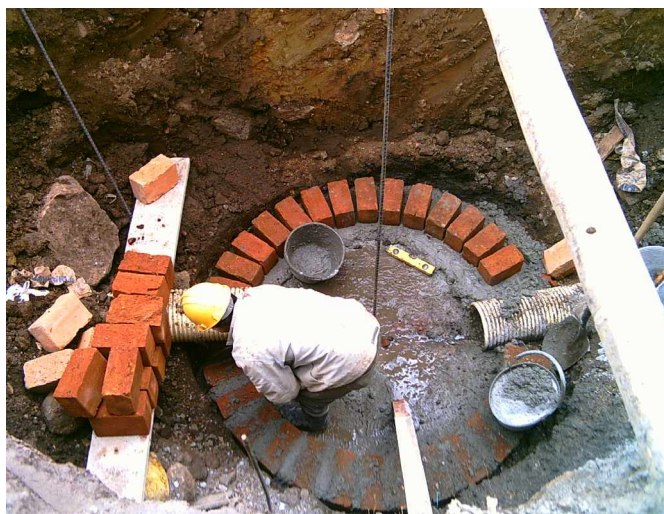
FIGURA 43. Construcción pozos de inspección con diámetro de 1.20m
