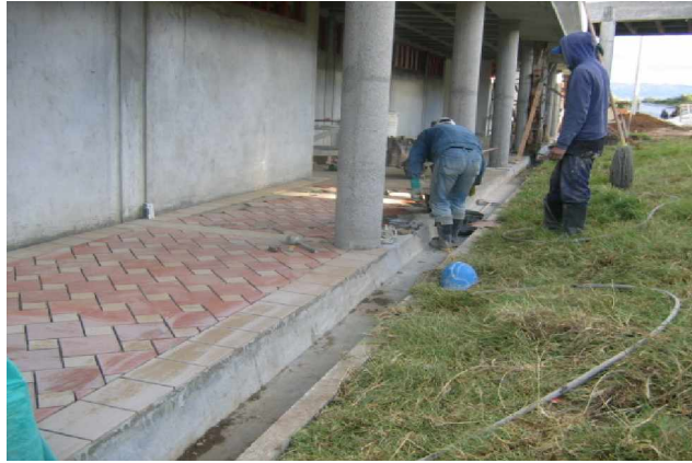
FIGURA 59. Instalación de pisos en corredores del bloque 2
