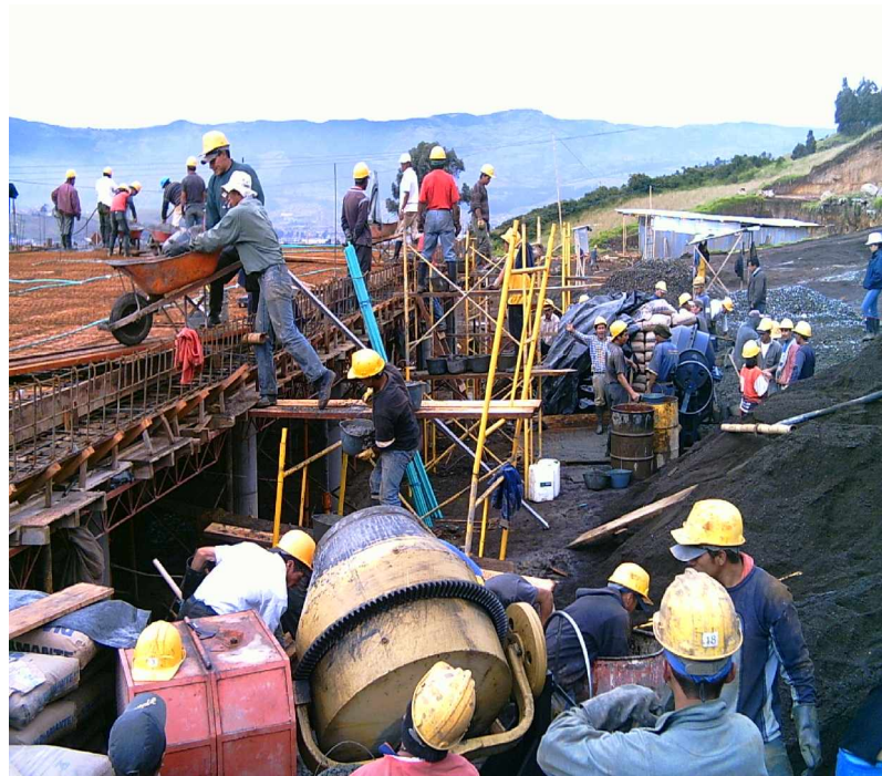
FIGURA 19. Fundición de losa previo de armado de casetón, instalación de malla electrosoldada e instalaciones eléctricas
