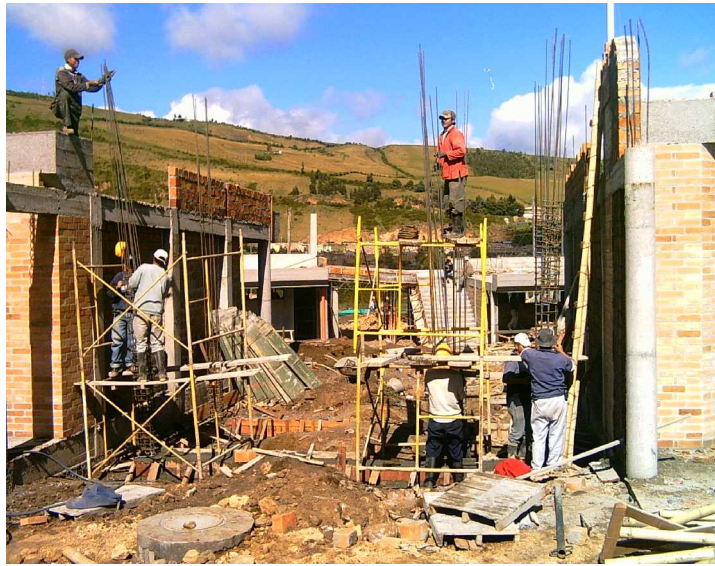
FIGURA 51. Armado de columnas para puentes Bloque 3-4
