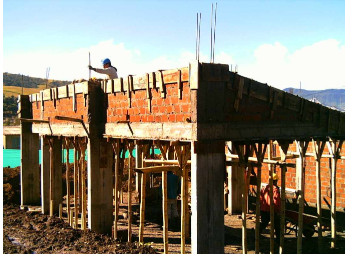
FIGURA 24. Vista general batería sanitaria (formaleta vigas de corona y cinta de culata).
