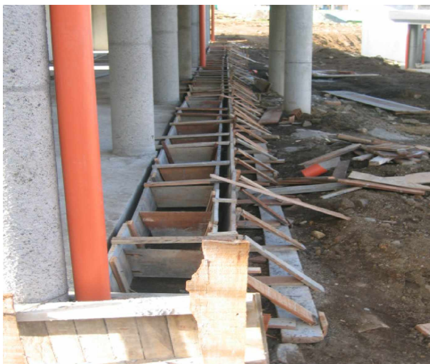
FIGURA 41. Tubería de Aguas lluvias de 4" para los bajantes bloques 3.
