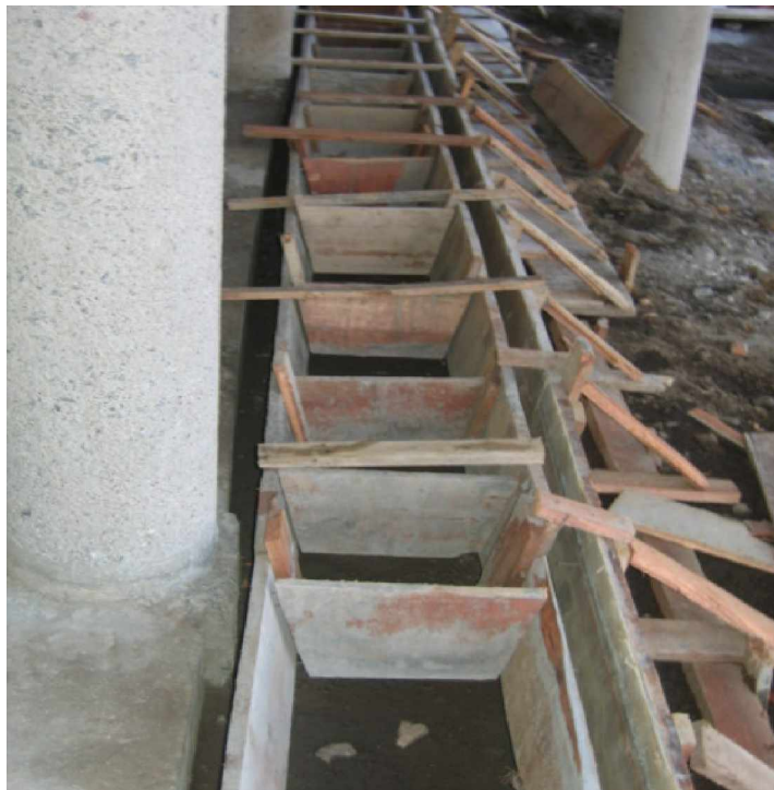
FIGURA 26. Encofrado del canal perimetral de losa de entepiso bloque 4.
