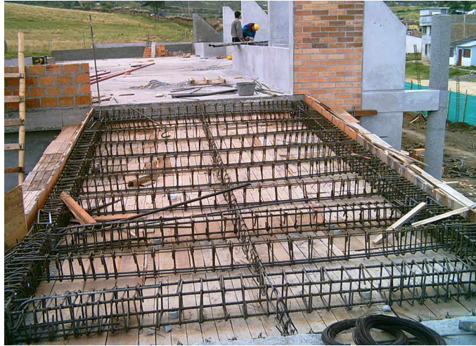
FIGURA 53. Vista general de acero de refuerzo de vigas y viguetas para Puente bloque 1-2
