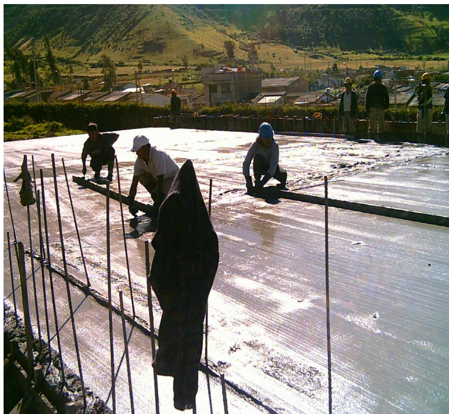
FIGURA 36. Tallado de repello con mortero impermeabilizado losa de cubierta Bloque 2.
