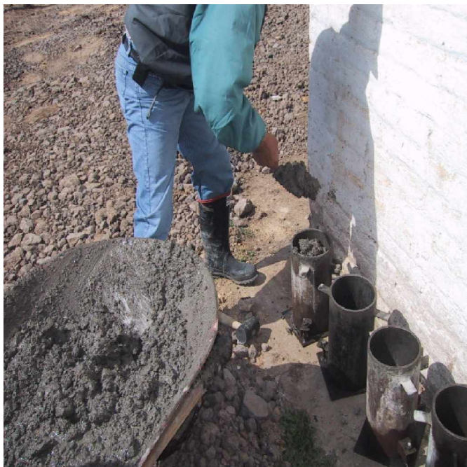
FIGURA 06. Elaboración de cilindros para control de concretos.
