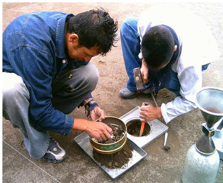
FIGURA 13. Toma de densidades en campo con el cono de arena.
