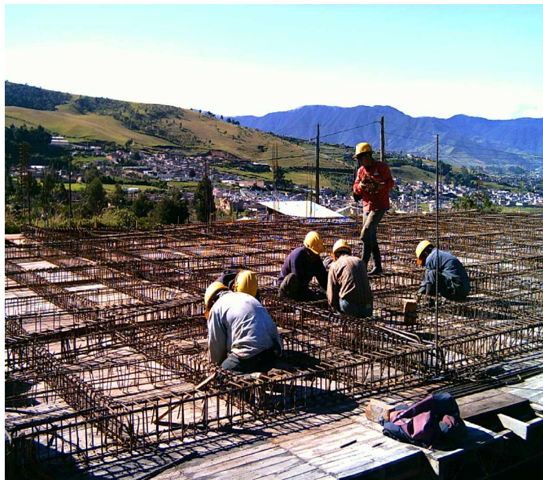
FIGURA 18. Armado de vigas de losa. Bloque 1
