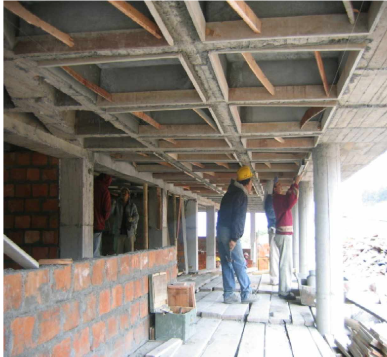
FIGURA 37. Enriado de cieloraso para repello. Bloque 2.
