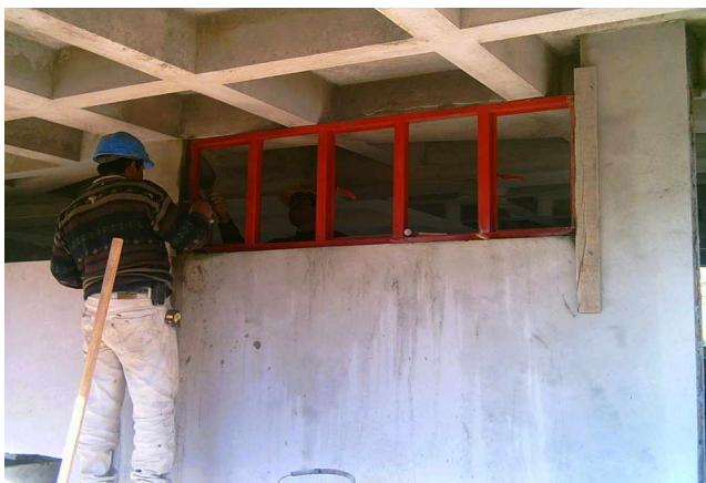
FIGURA 61. Instalación de carpintería metálica, ventanas bloque 2
