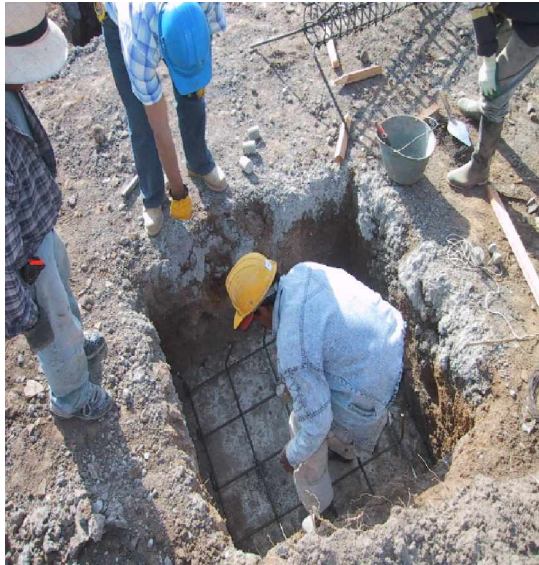
FIGURA 07. Instalación de parrillas para las zapatas en el Bloque 4.
