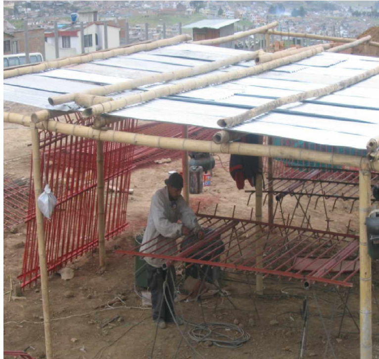
FIGURA 32. Carpintería metálica para muro de cerramiento.
