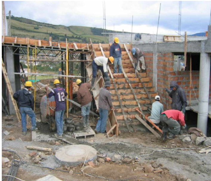
FIGURA 52. Vista general de formaleta de puente y gradas. Bloque 1-2
