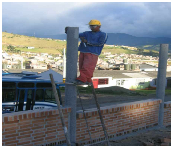
FIGURA 30. Terminado abusardado columnas circulares muro de cerramiento.
