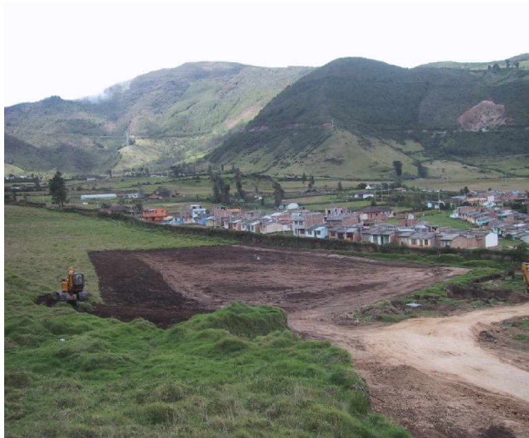
FIGURA 01. Descapote inicial del terreno y área de trabajo.
