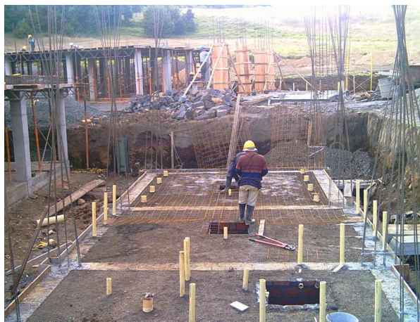
FIGURA 15. Instalación de malla electrosoldada. Batería sanitaria niños.
