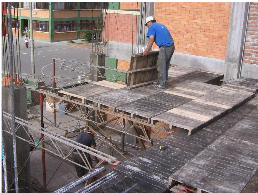
Figura 233. Instalación formaleta losa segundo nivel
