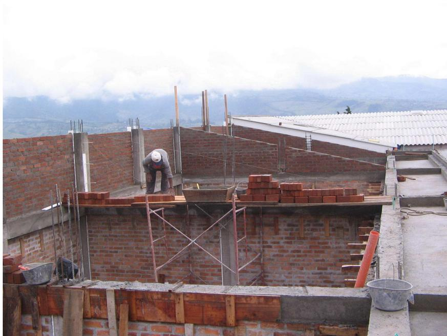
Figura 77. Formaleta losa batería sanitaria
