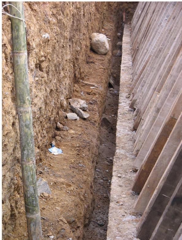
Figura 17. Instalación formaleta segundo muro
