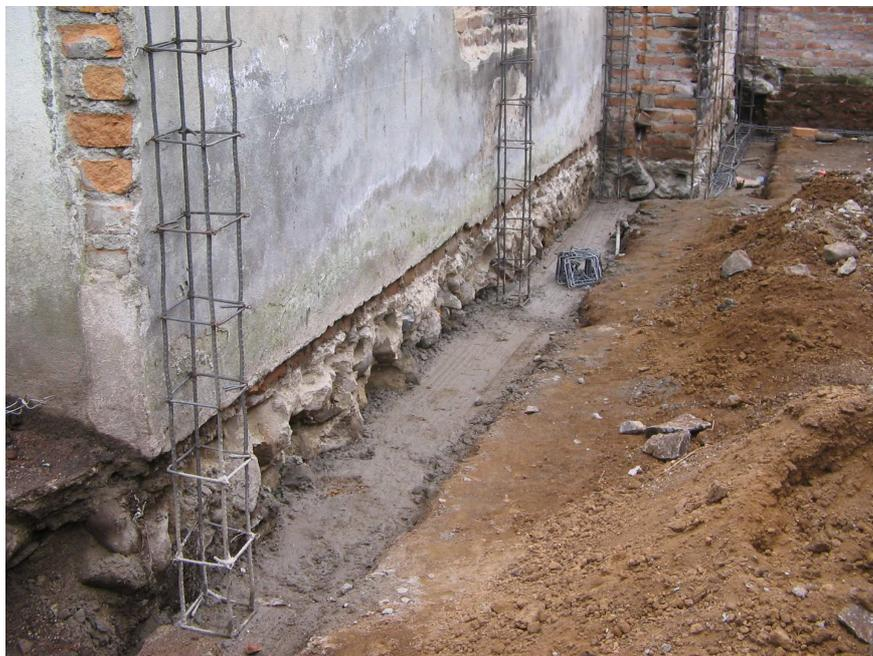
Figura 134. Hierro de vigas de cimiento y columnas
