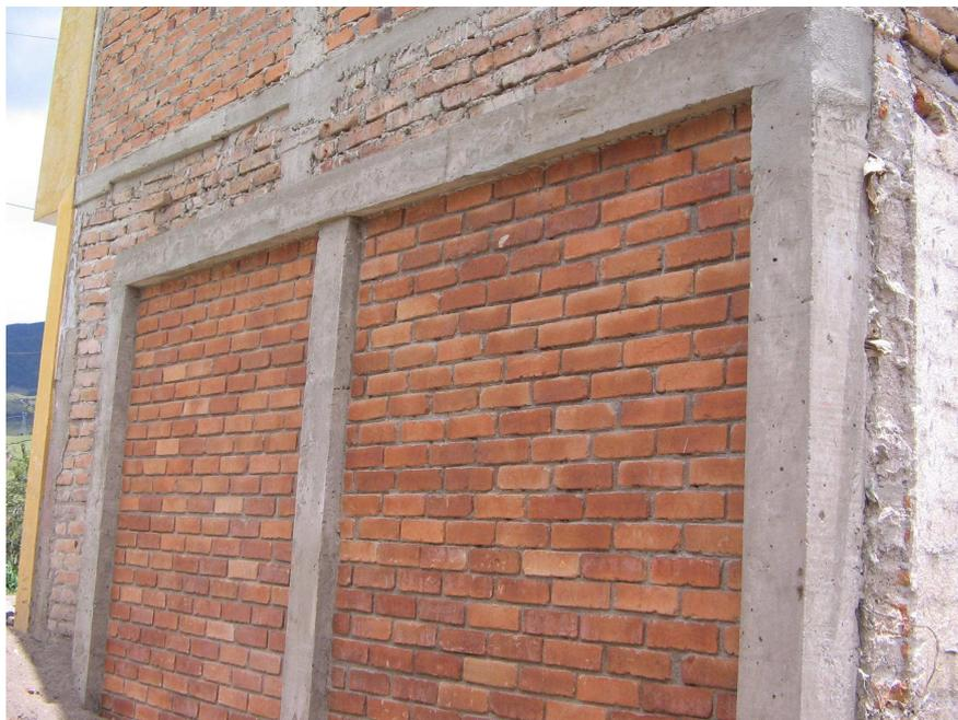
Figura 147. Muro de cierre terminado
