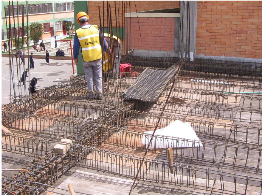
Figura 238. Formaleta para losa de entpiso
