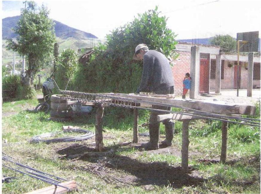
Figura 182. Armado de refuerzo de columnas
