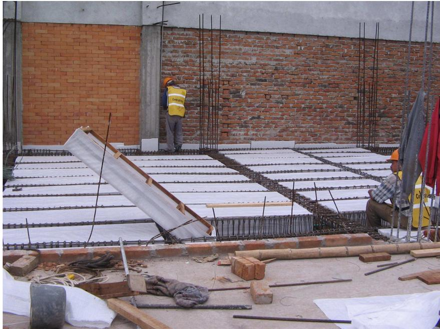
Figura 240. Instalación de casetones
