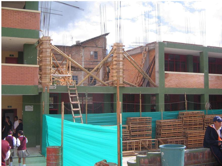
Figura 231. Encofrado de columnas
