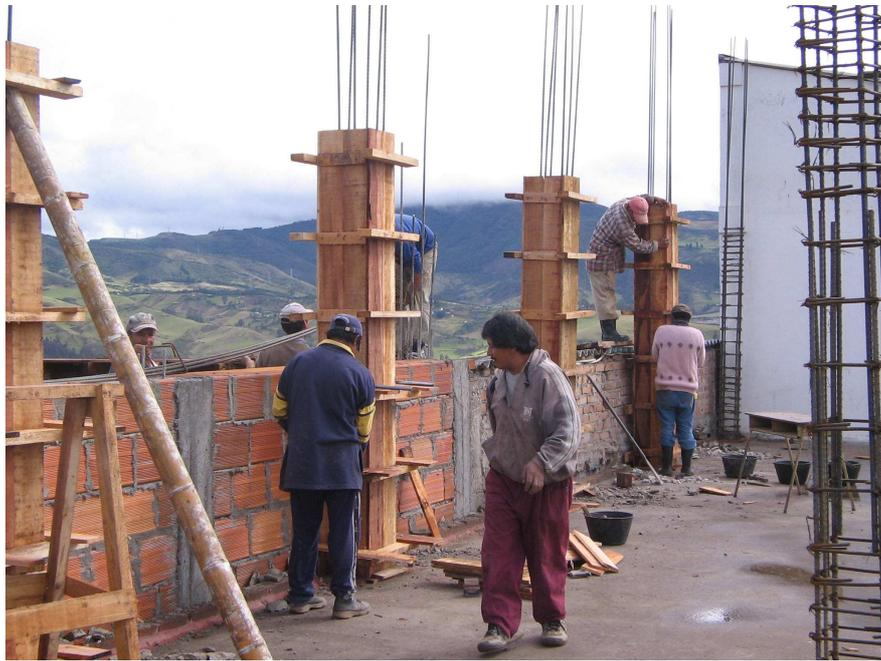
Figura 52. Encofrado de columnas
