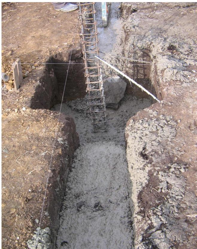
Figura 186. Fundición viga de cimiento
