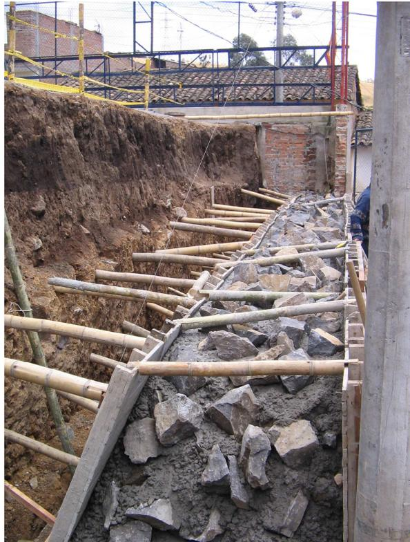
Figura 16. Excavación filtro
