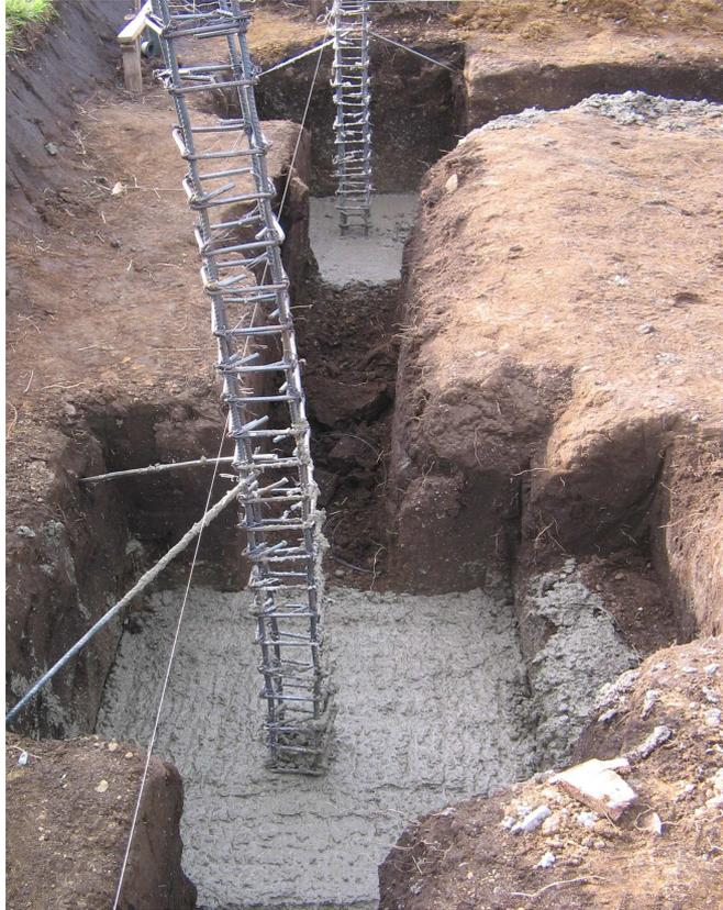
Figura 184. Fundición de zapatas
