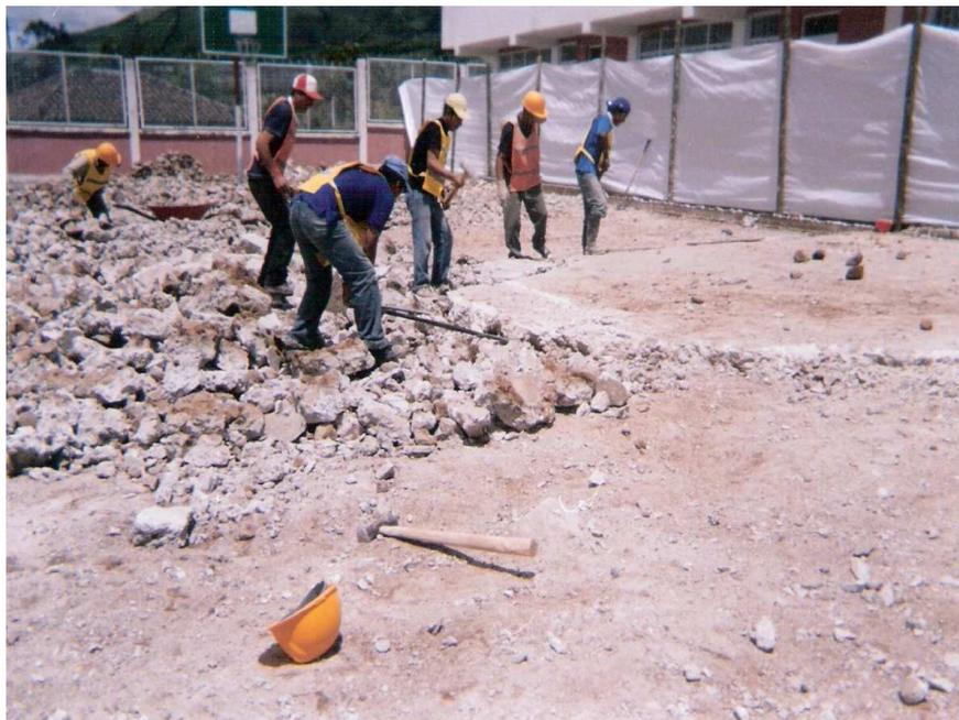
Figura 93. Excavación para muro de contención.
