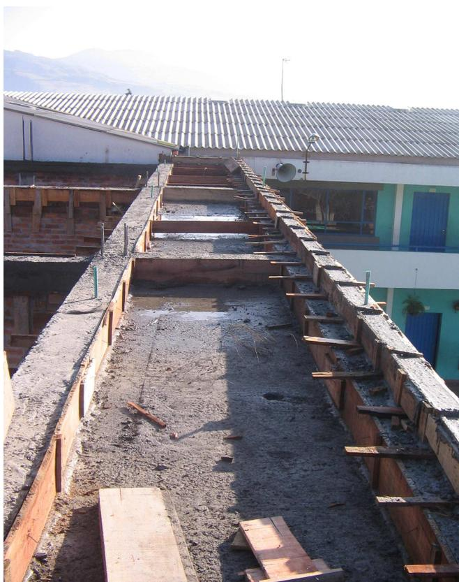
Figura 73. Desencofrado tanque de almacenamiento
