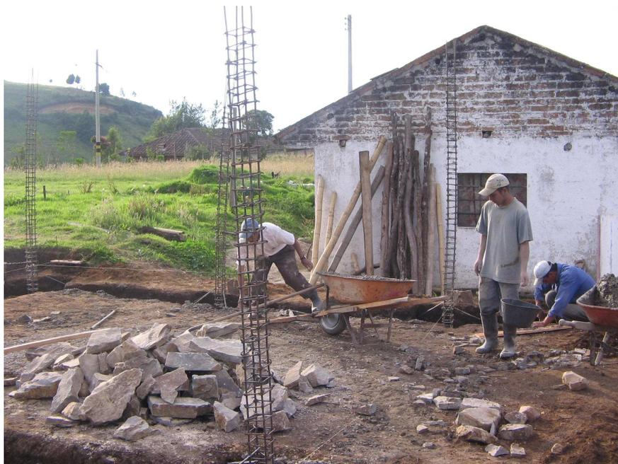
Figura 183. Parrilla de zapatas y castillo de columnas
