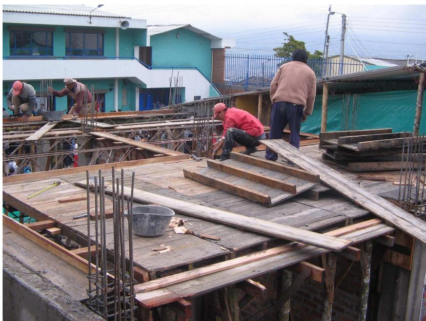
Figura 78. Losa canal
