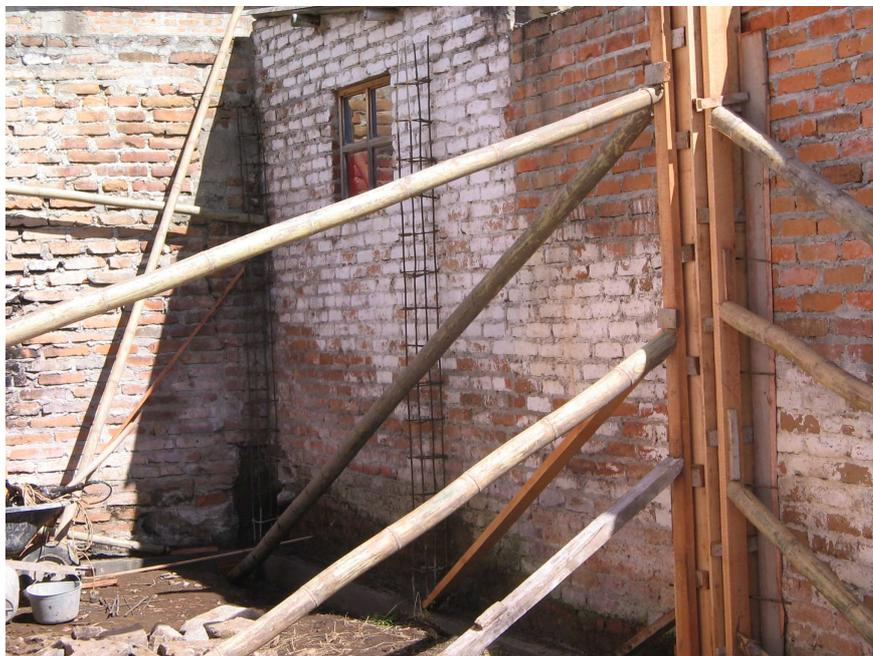
Figura 138. Encofrado de columnas
