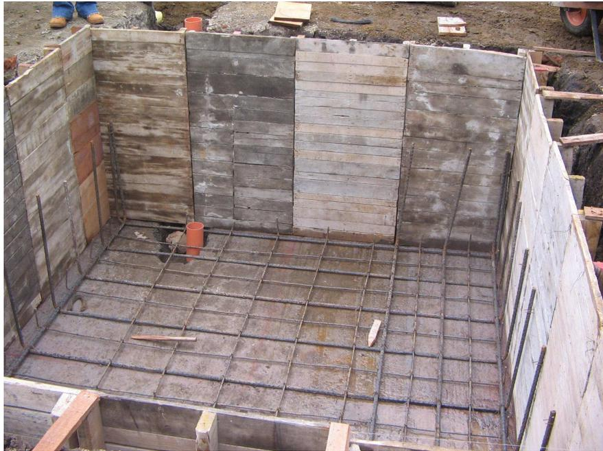
Figura 67. Encofrado viga corona
