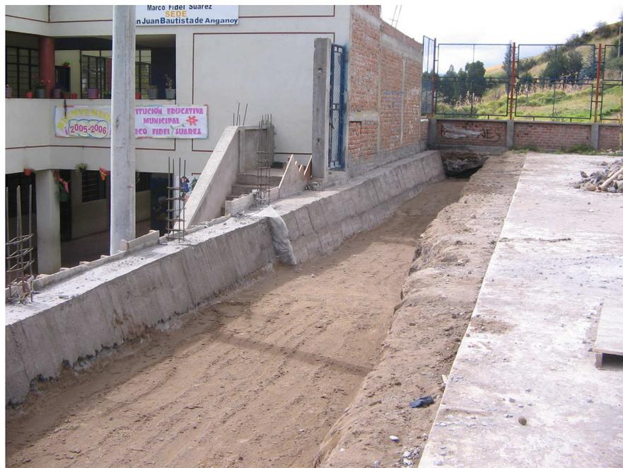
Figura 26. Excavación para conexión a pozo de inspección
