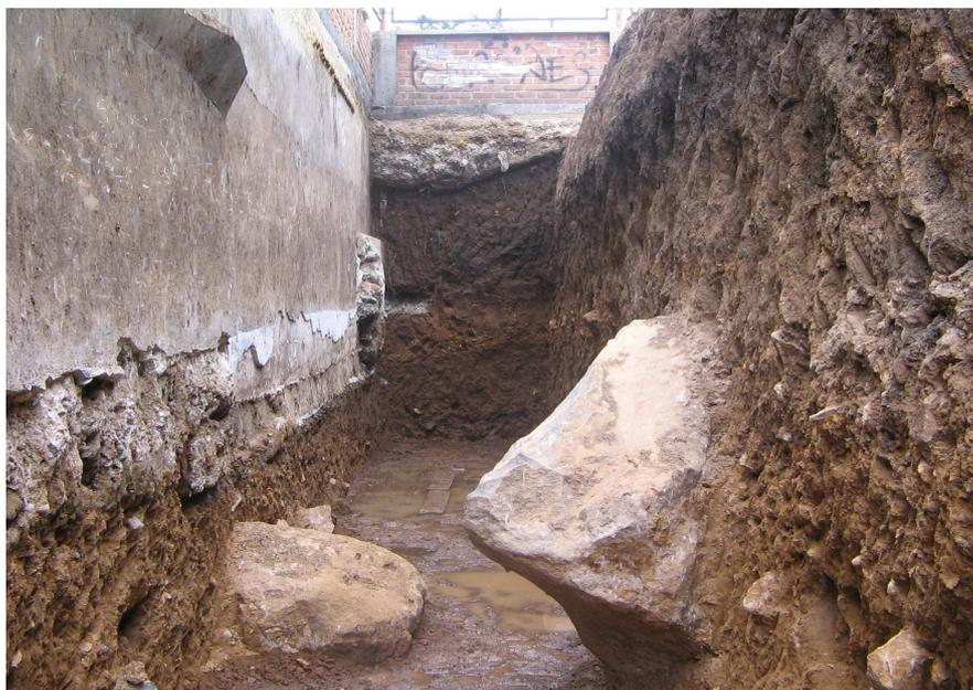
Figura 3. demolición zapatas
