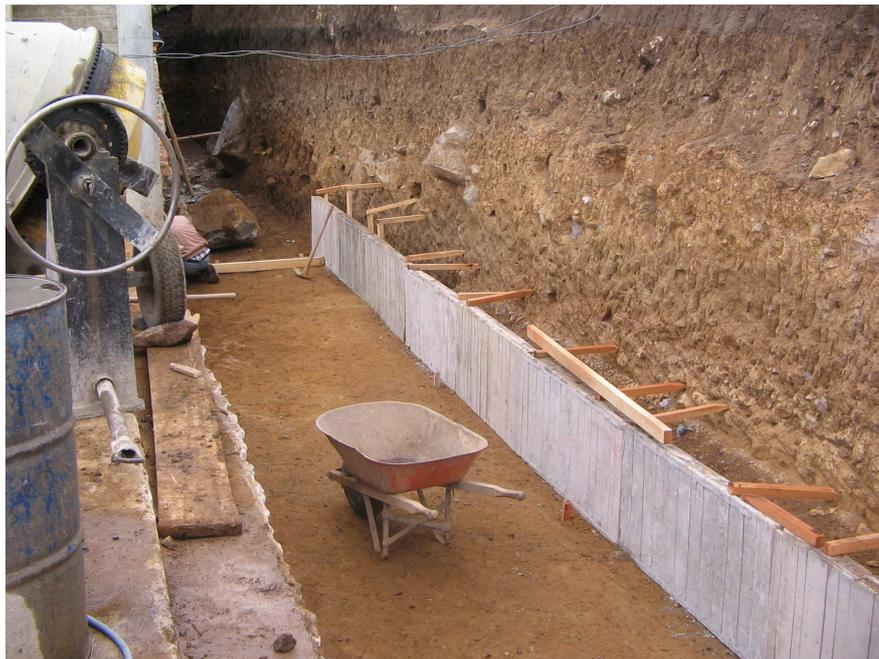
Figura 9. Fundición solado
