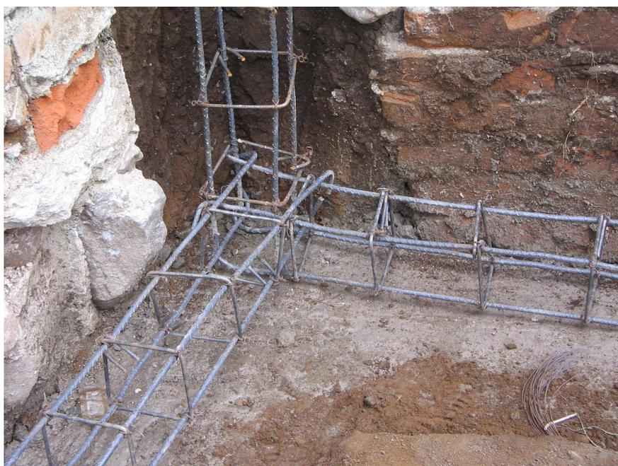
Figura 135. Viga de cimentación
