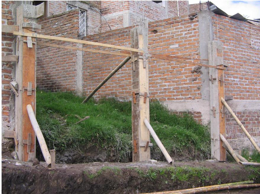
Figura 223. Encofrado muro de contención
