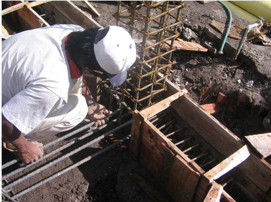
Figura 59. Formaleta viga de cemento para batería sanitaria
