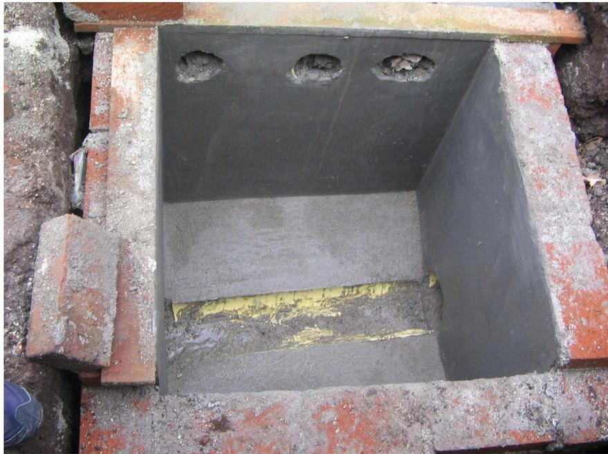
Figura 65. Excavación para desagüe del tanque de almacenamiento.
