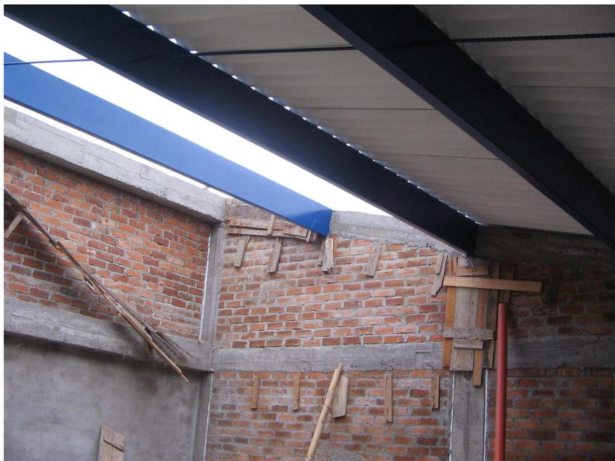
Figura 84. instalación tejas en asbesto cemento
