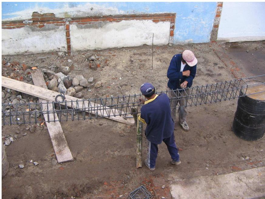
Figura 50. Traslapos de refuerzo columnas
