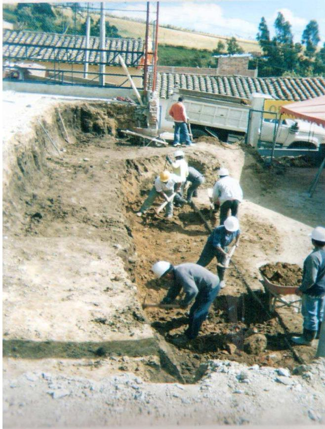
Figura 2. Excavación (piedras de gran tamaño)
