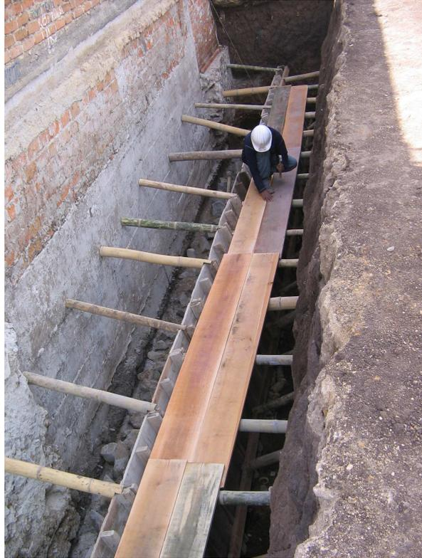
Figura 18. Instalación filtro
