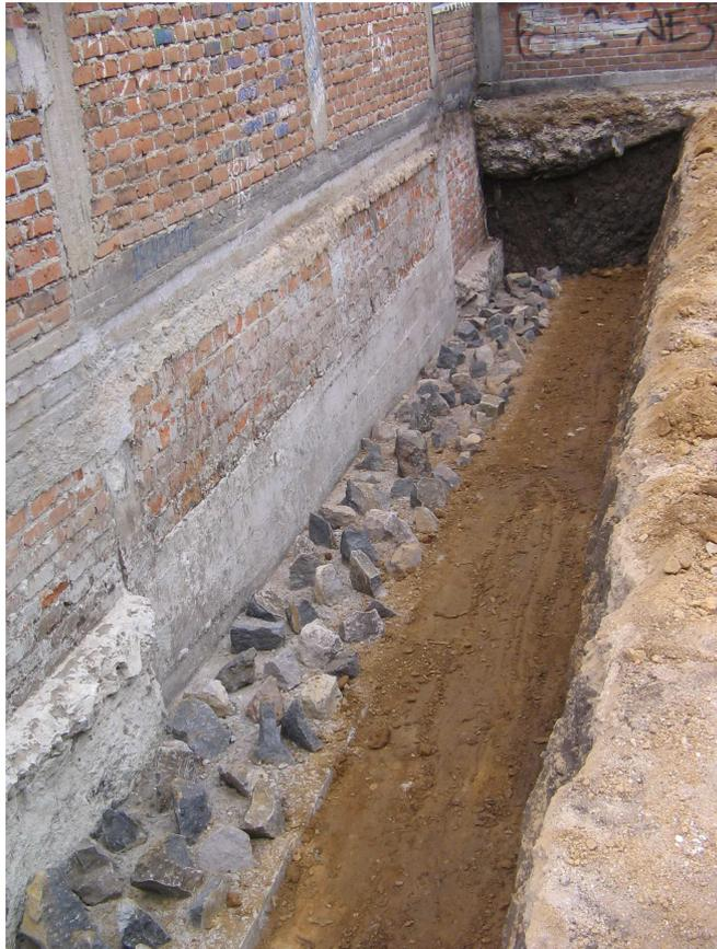
Figura 22. Excavación para caja de inspección.
