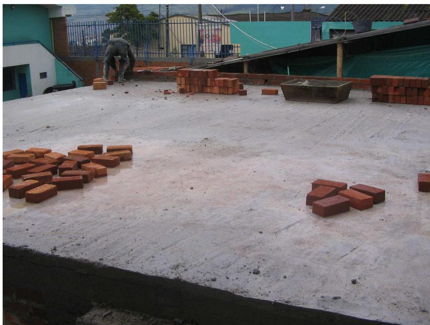
Figura 81. Encofrado cinta de culata
