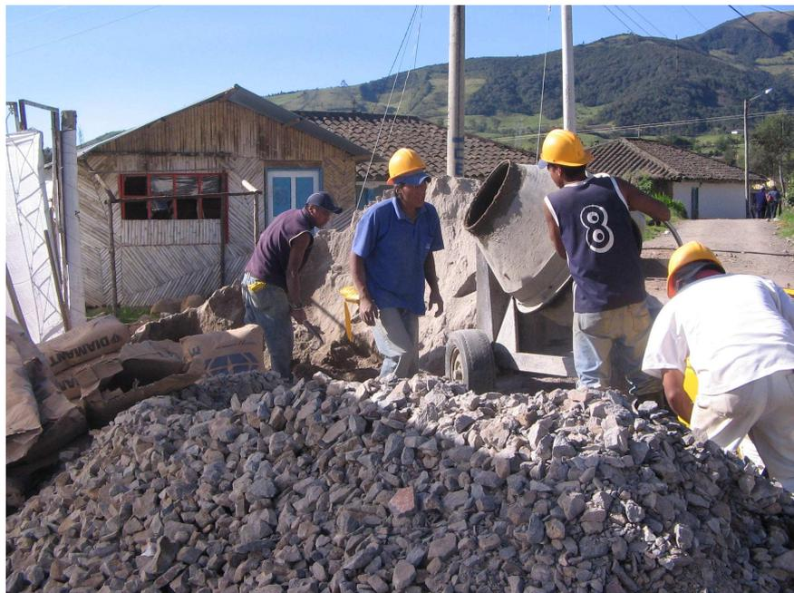
Figura 96. Fundición elevaciones del muro de contención.
