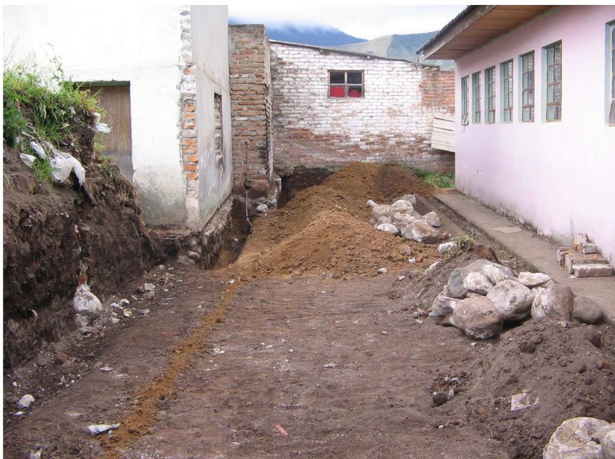
Figura 132. Excavaciones para cimientos
