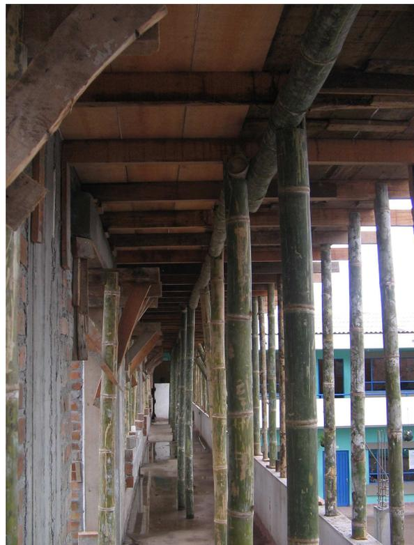
Figura 70. Encofrado losa canal
