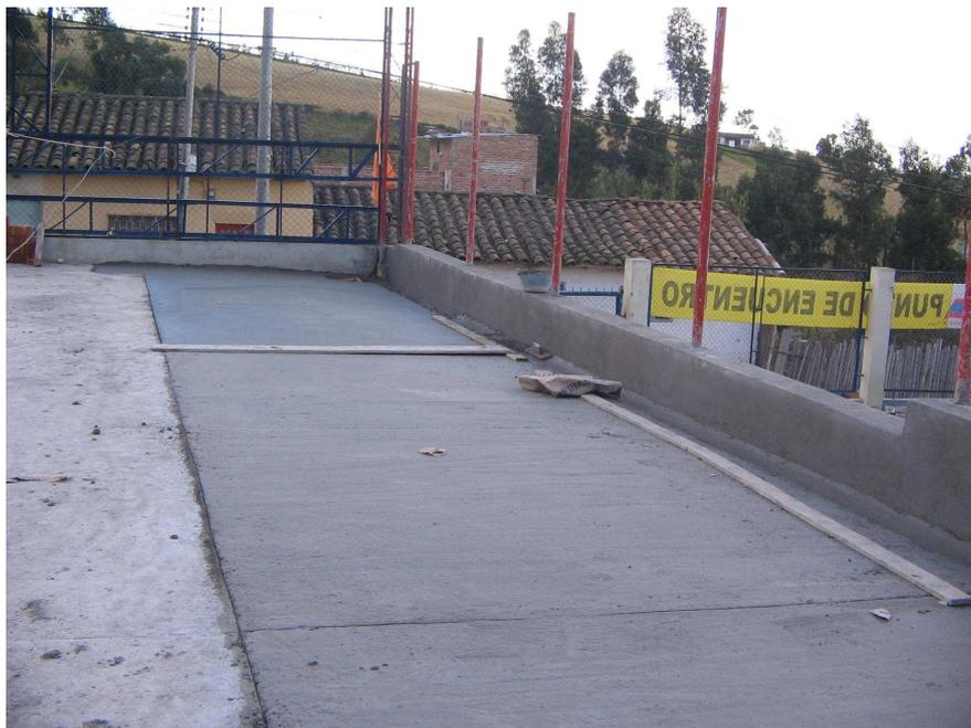
Figura 36. Muro repellado
