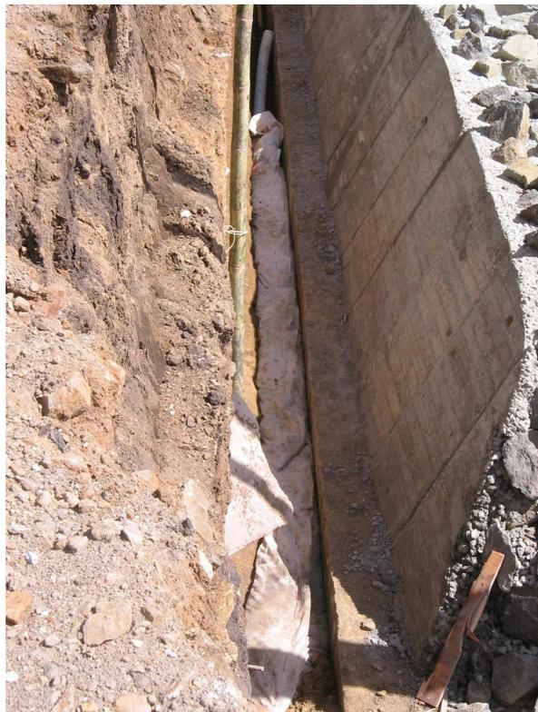
Figura 19. Fundición zarpa segundo muro
