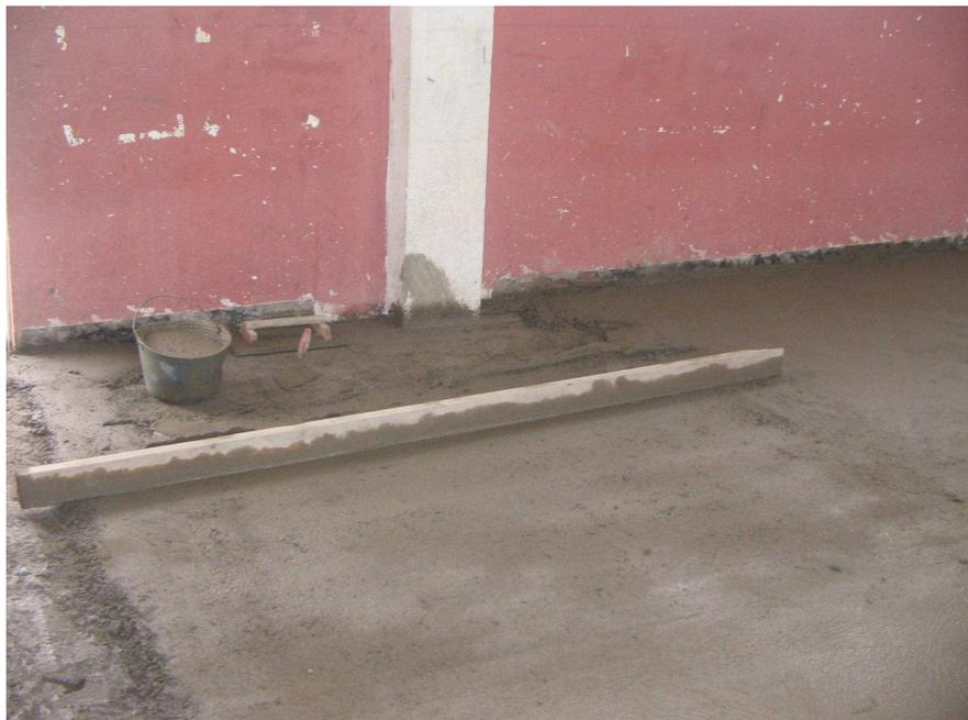
Figura 114. Enchape de piso en aulas con tableta de gres
