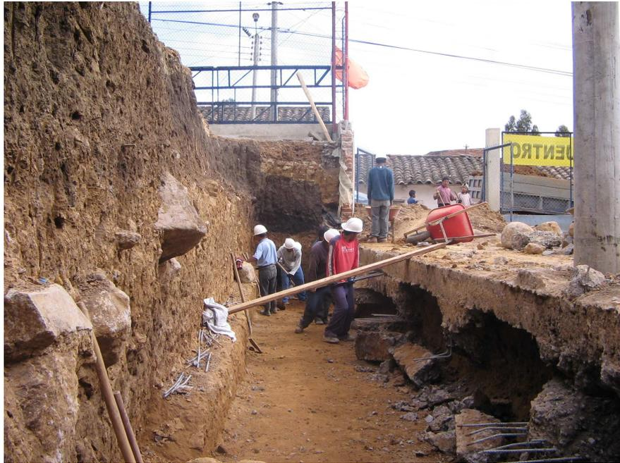
Figura 4. Demolición zapatas
