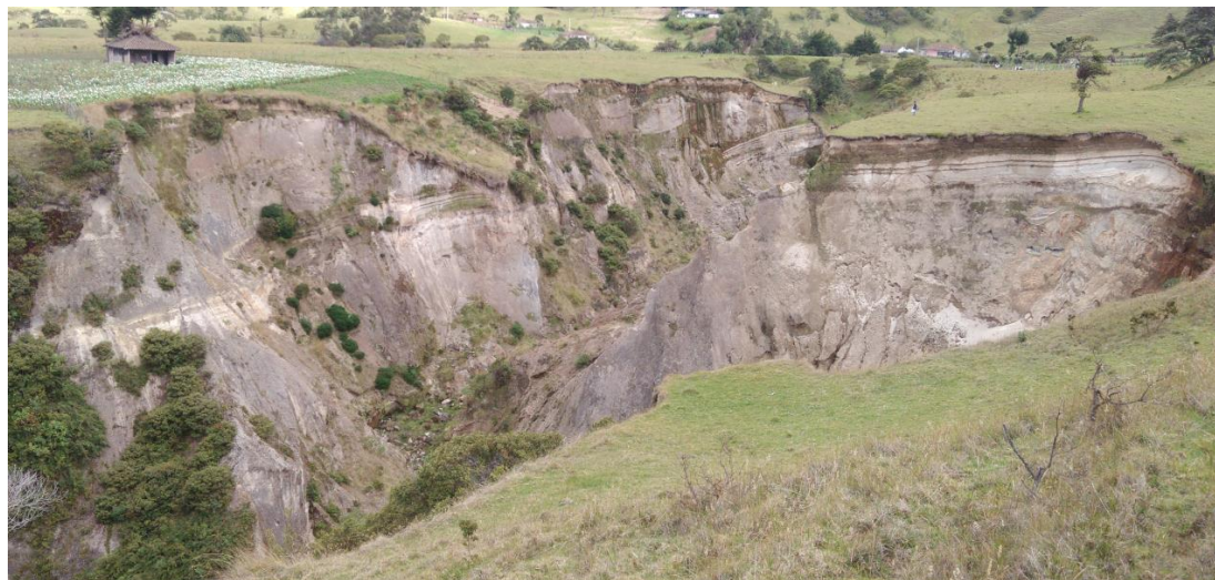
Figura 58. Zona de deslizamiento en la vereda La Palma. Fuente: esta investigación
