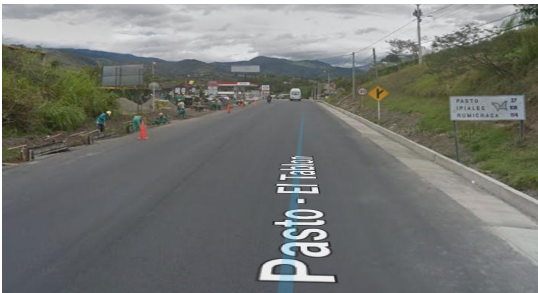
Figura 3. Punto de finalización de la obra, Aeropuerto Antonio Nariño, Chachagüí
