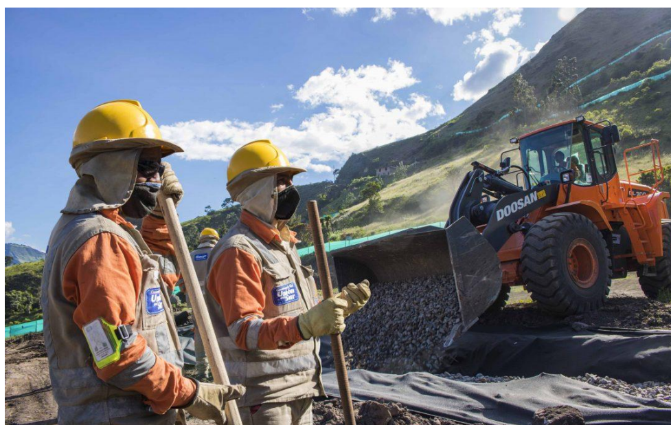
Figura 4. Personal de apoyo en el tramo de la obra, Pedregal-Catambuco
