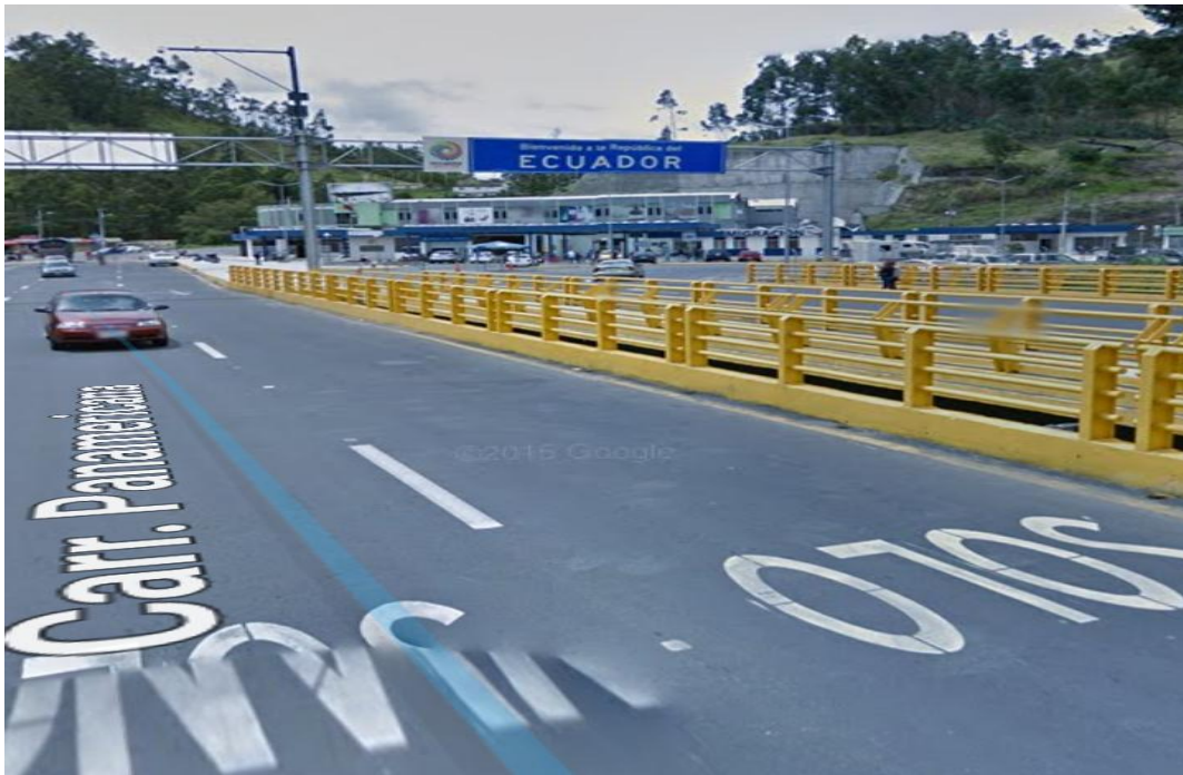
Figura 2. Punto de inicio de obra, Puente internacional de Rumichaca
