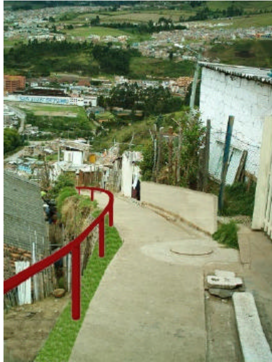
Figura 47. Equipamiento urbano pasamanos
