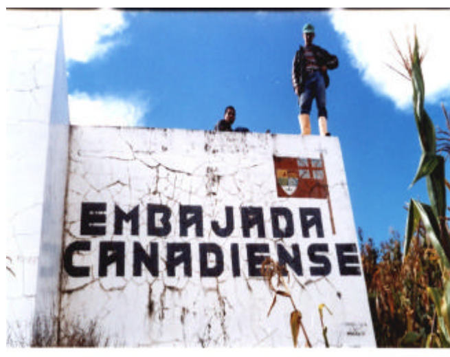
Figura 21. Tanque de abastecimiento
