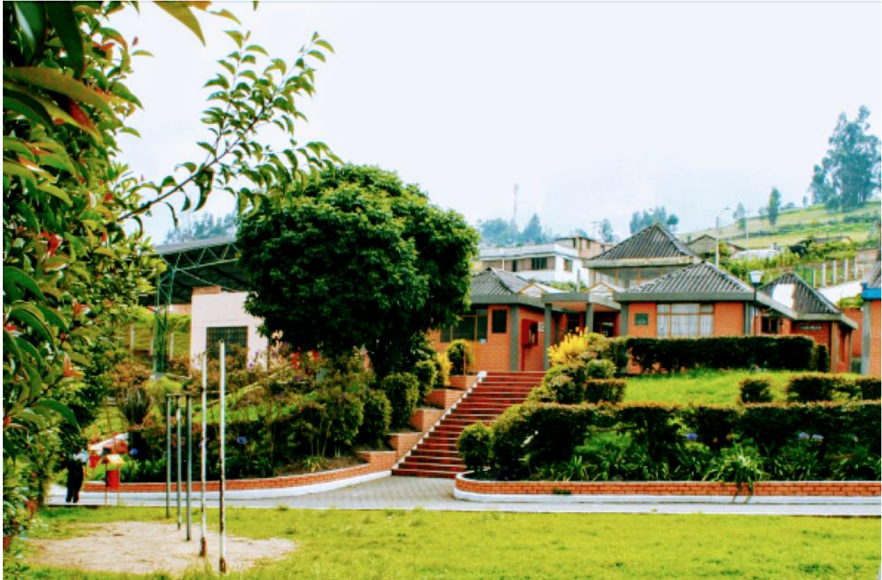
IMAGEN 1: CENTRO ADMINISTRATIVO I.E.M. CIUDADELA DE PASTO
