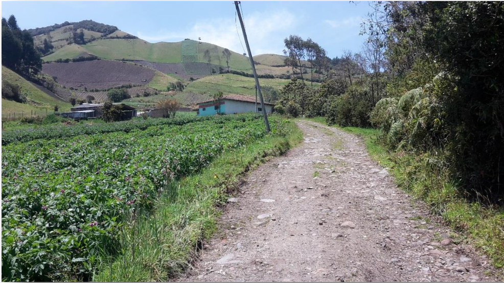
Figura 21 Infraestructura (Vial, Vivienda) dentro de la ronda hídrica de la Quebrada Miraflores
