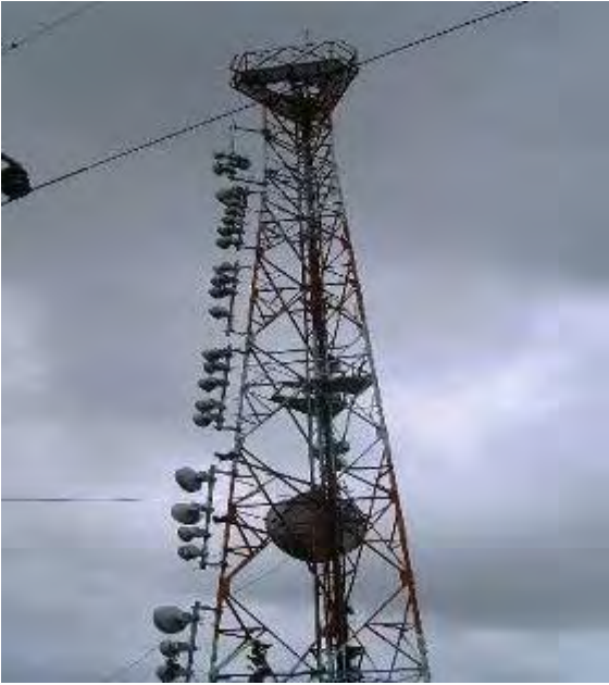
Vista general de la torre
