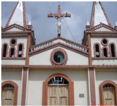
Foto No 36: Iglesia de la Llanada
