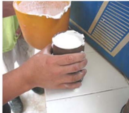
Foto 142: Yeso vertido sobre moldes e. Vaceado y fraguado de yeso
