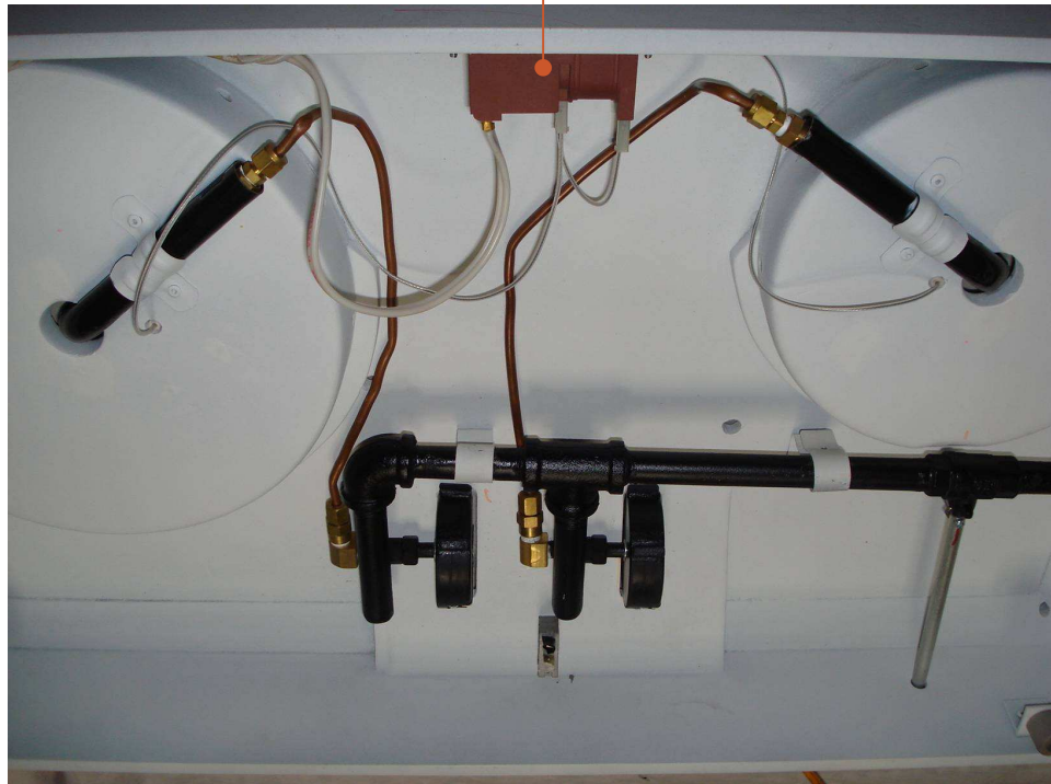
Detalle del piezo eléctrico
