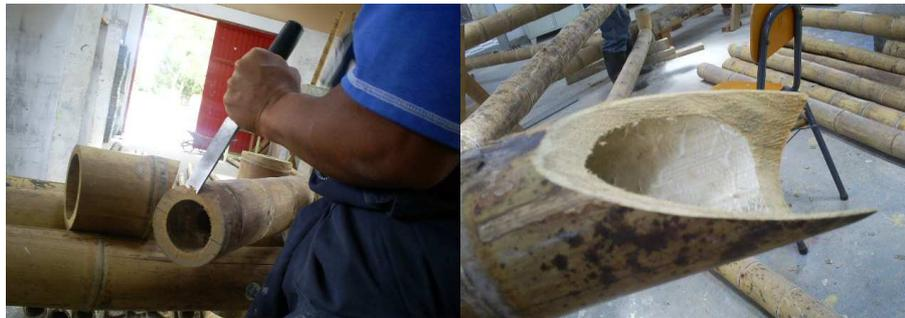
**Tallado de empalmes.** Luego de ver trazado los ejes y ver dibujado los cortes que se van a tallar, nos ayudamos con un martillo o un mazo de madera y un formón, para poder tallar de forma artesanal los empalmes.
