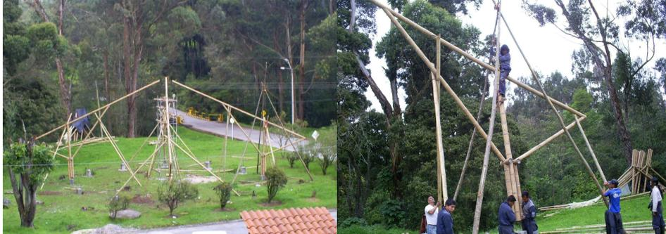
Los 12 pórticos son levantados con winches o diferenciales, este sistema puede levantar hasta dos toneladas, con esto se reduce esfuerzo físico gracias a su mecanismo de engranaje que posee.
