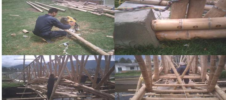
Figura 94. Fundición de pisos, colocación de esterilla y diagonales
