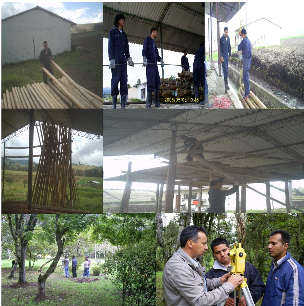
**REPLANTEO PARA LA CONSTRUCCION DE UN KIOSCO.** Es pasar las medidas del plano al terreno y para este procedimiento se utilizó herramientas como decámetro, cinta métrica, plomada, martillo y por supuesto del plano.
