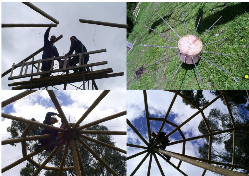
El centro de la construcción es apoyada por una columna que se ubica debajo del rey, esta columna servirá de soporte mientras se termina de armar la estructura del kiosco, que consiste en colocar 12 pórticos, 11 anillos que van alrededor de la estructura que servirán de apoyo de las tejas y a si mismo impedir movimientos laterales que puedan hacer que colapse.
