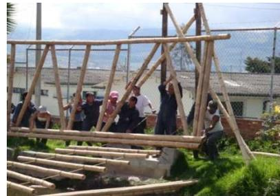
**Diseño y construcción de estribos.** Los estribos son soportes en hierro y concreto que sirven para anclar una estructura, en este caso la estructura en guadua del puente.
