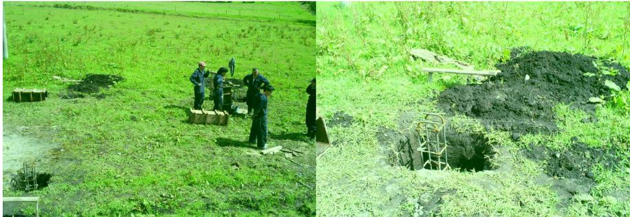
**Fundición de zapatas y columnas.** Aquí se realizó una excavación de 12 huecos para fundición de zapatas y columnas, las zapatas ayudan a mantenerla firme a la estructura en caso de movimientos, las columnas ayudan a la estructura evitándole que se llene de hongos por causa de la humedad.
