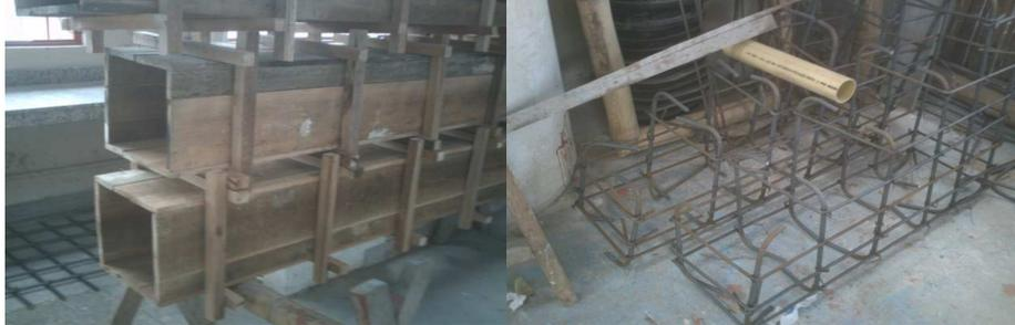
**Formaletas para fundición de columnas.** Son moldes en tabla que se hacen para poder vaciar el concreto, el diseño y medidas pueden variar de acuerdo a las exigencias y composición estructural del diseño.
