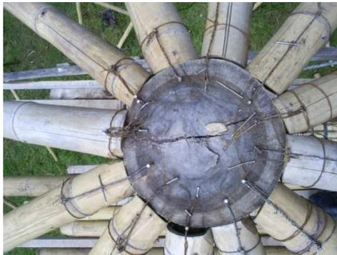
Es un cilindro de madera que tiene 12 radios de varillas de hierro de 3/8 a cada radio le llegara una parte de la estructura de guadua que se fundirán con cemento, arena y grava (piedra pequeña) el rey actúa como centro de gravedad de la estructura soportando movimientos, impidiendo que colapse.
