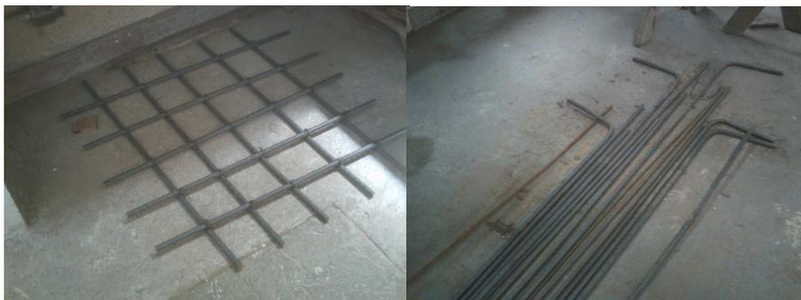
**Zapatas para columnas y estribos.** Diseño de zapatas de 0,60mx0,60m, varilla de  $\frac{1}{2}$  pulgada, espacios de 0,10cm sirven para evitar hundimientos de la estructura y para anclaje de las columnas. Se utiliza a varilla corrugada de  $\frac{1}{2}$  pulgada.
