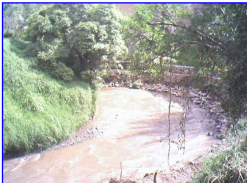
Figura N. 32 Construcción en terrenos no aptos
