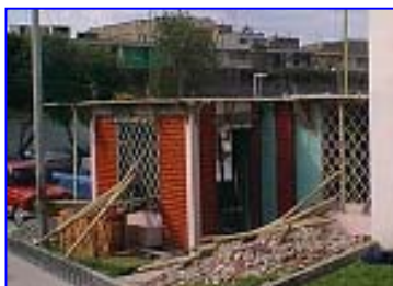
Figura N. 9 Cambio de techo a losa
