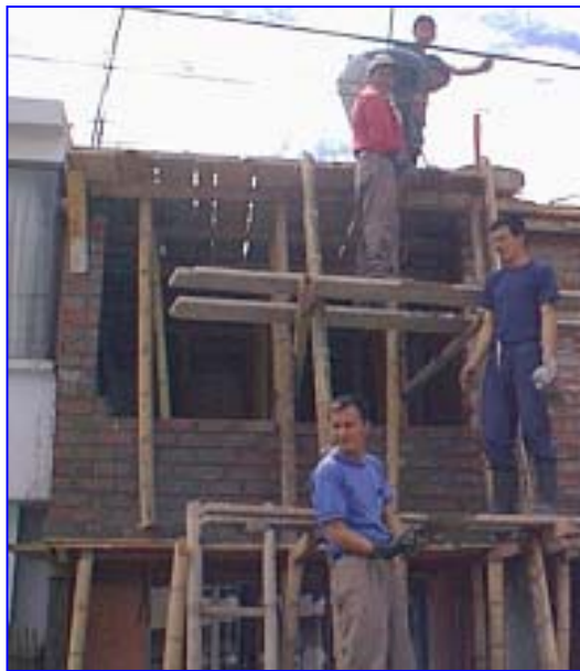
Figura N. 14 Cambio de fachada
