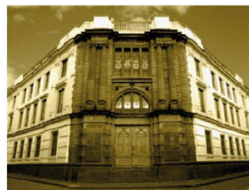
► Fachada principal edificio central UDEPAR-Fac. de Derecho
