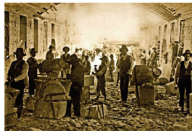
► Construcción del edificio central de la UDEPAR.
