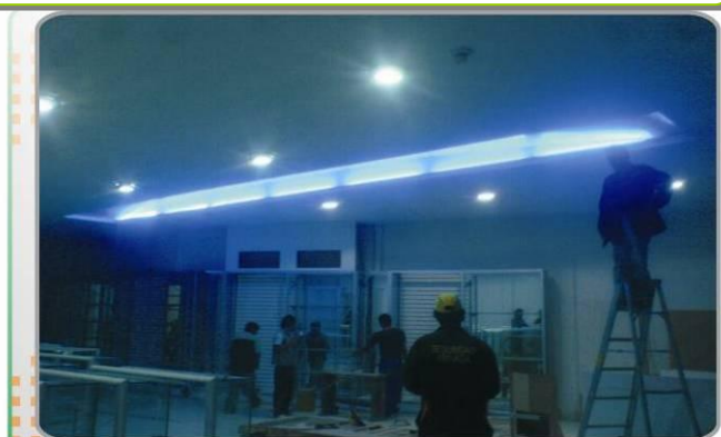
Instalación de iluminación eléctrica y vitrinas de pared.
