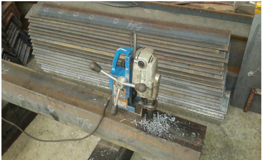
Figura 29. Proceso de perforación con taladro magnético
