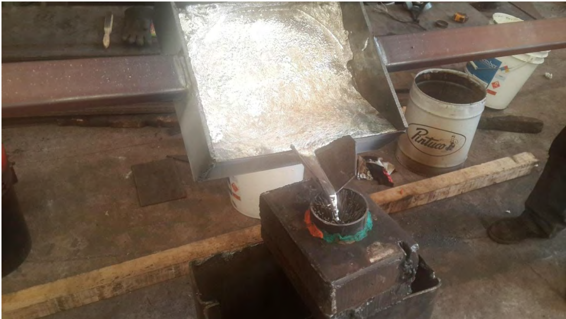
Figura 51. Fundición con zinc del bloque de acero y cable
