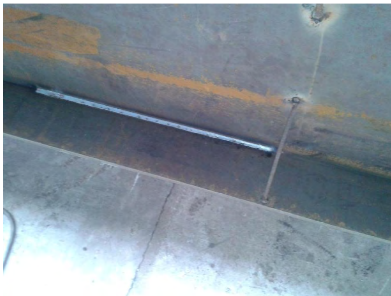
Figura 11. Soldadura de empate aleta alma de la viga
