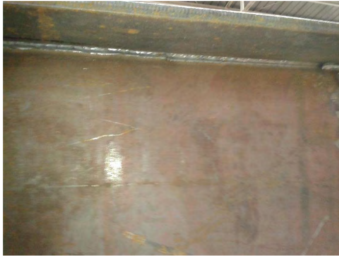
Figura 14. Cordón de soldadura completo
