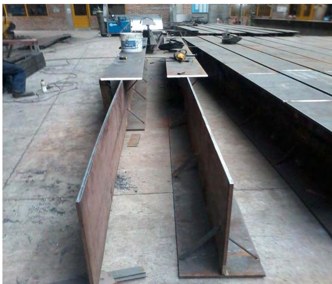
Figura 7. Proceso de armado de la viga IPE - 700
