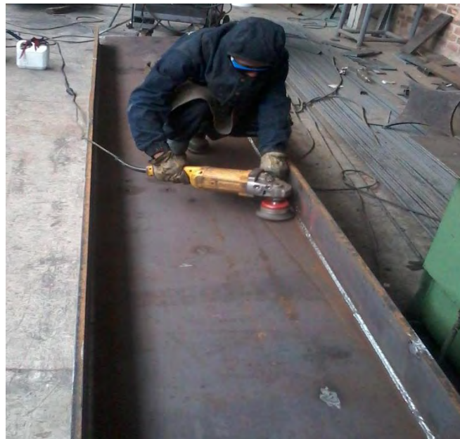
Figura 20. Limpieza mecánica sobre vigas
