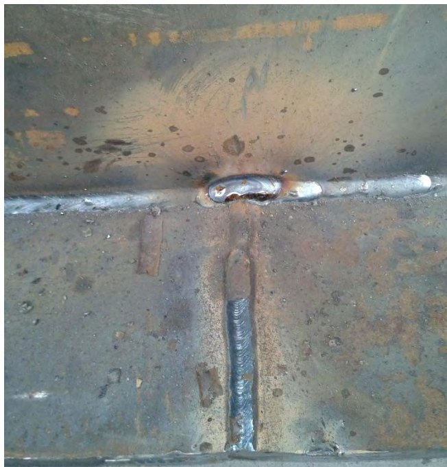
Figura 15. Soldadura en empates de aletas
