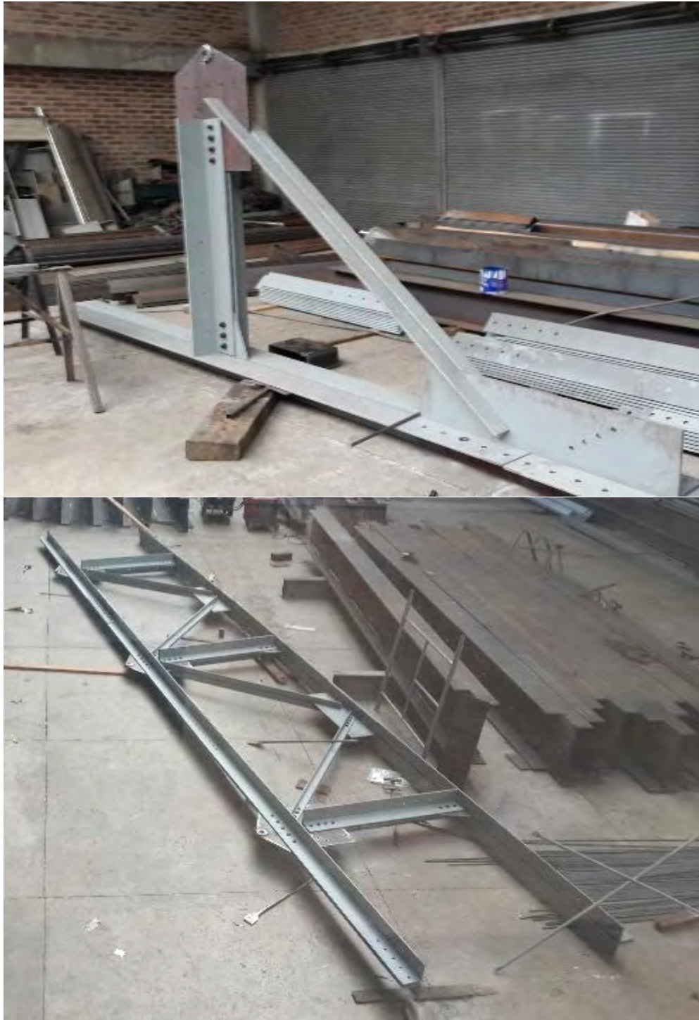
Figura 32. Armado de la viga de rigidez en planta
