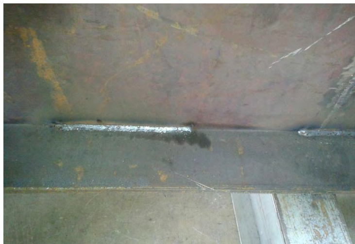
Figura 13. Cordones de soldadura alternados
