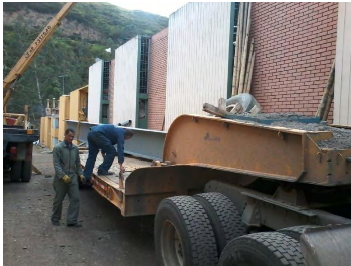
Figura 24. Transporte de vigas a obra
