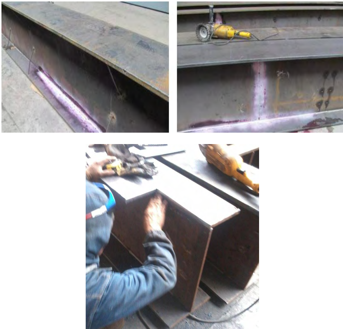
Figura 17. Inspección con líquidos penetrantes
