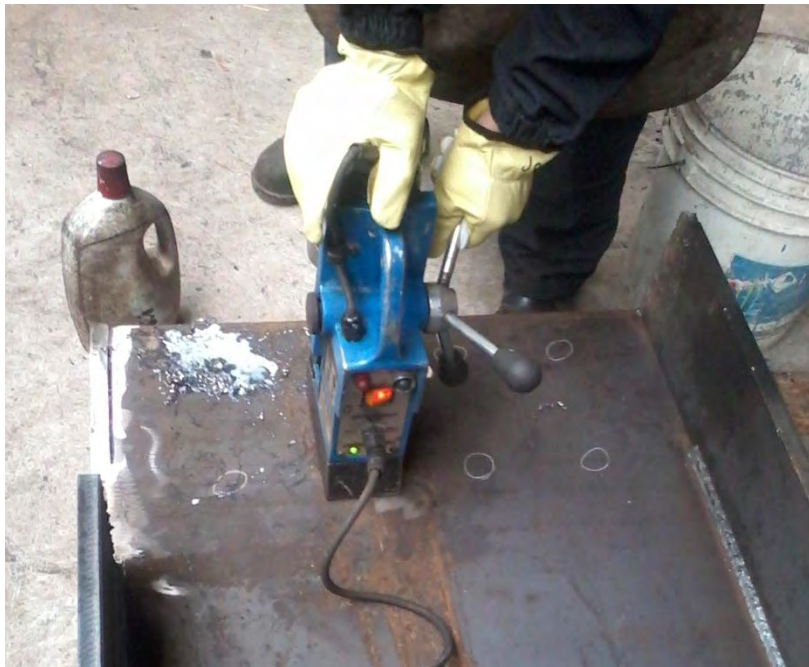
Figura 22. Perforación con ayuda del taladro magnético
