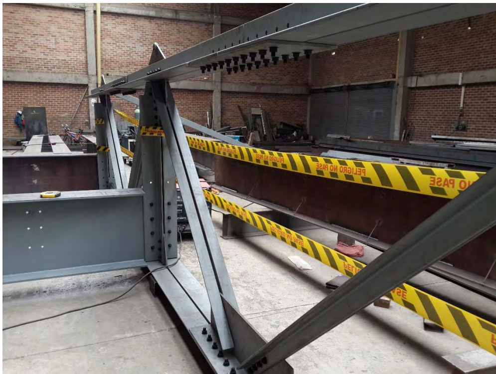
Figura 55. Estado actual de la obra civil en concreto
