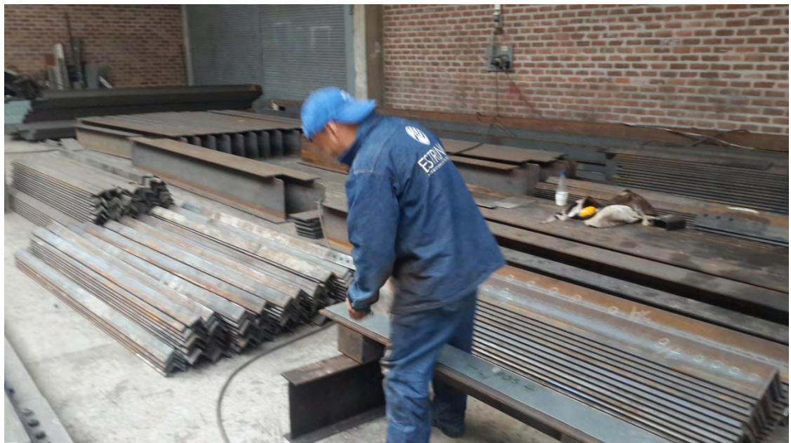
Figura 27. Ángulos centro punteados listos para instalar
