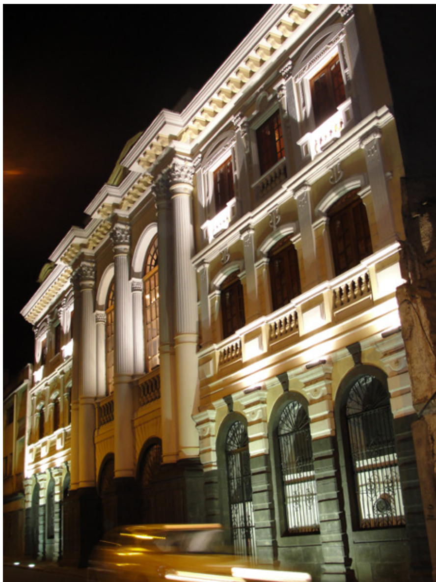
Figura 70 Iluminación de la Fachada del Teatro Imperial
