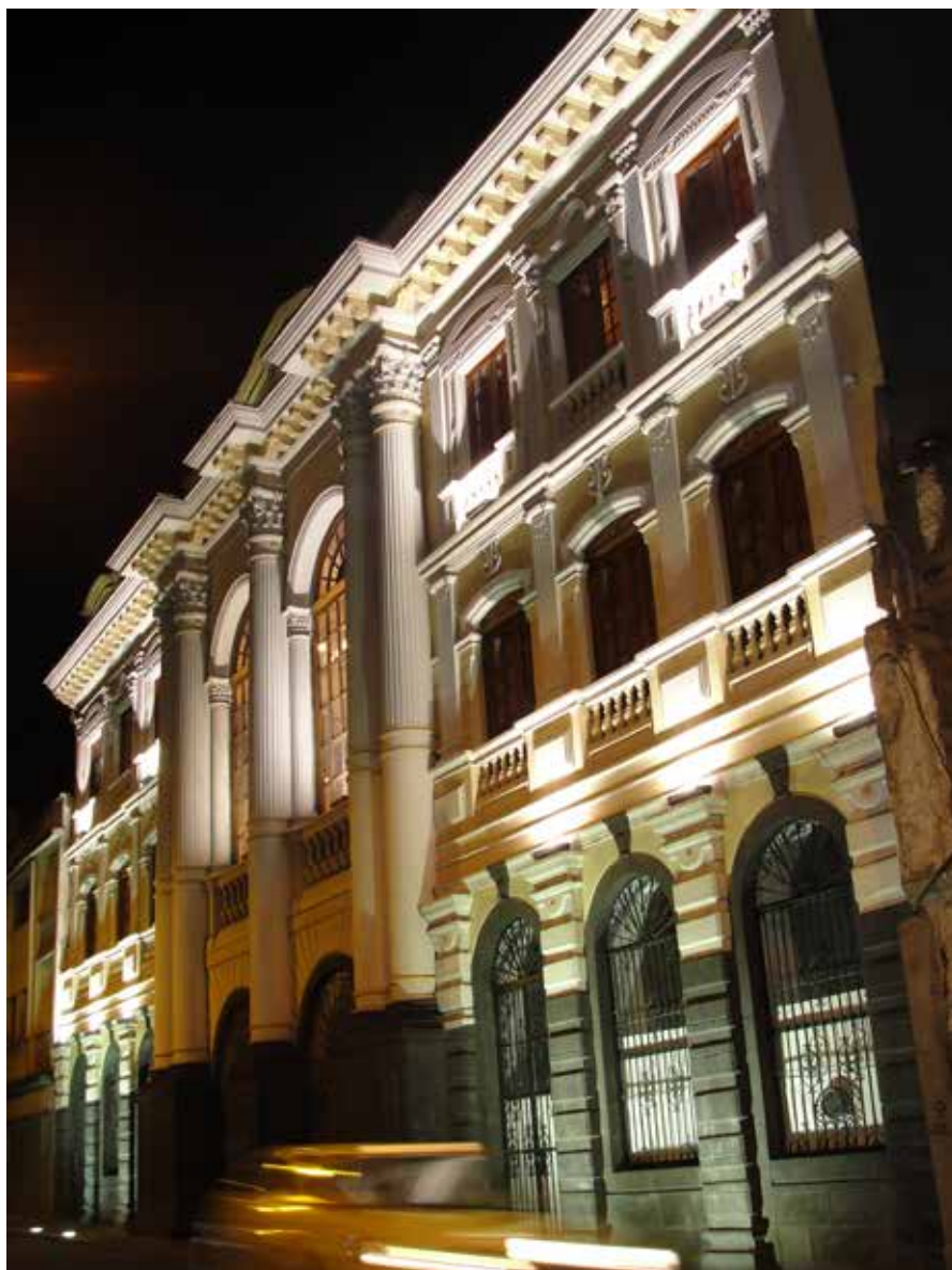
Figura 70 Iluminación de la Fachada del Teatro Imperial
