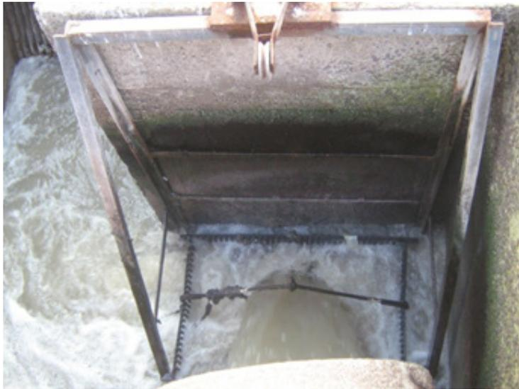
**Figura 4.7.** Canasta para retención de sólidos de gran tamaño a la entrada del afluente a la planta de tratamiento de aguas residuales de Ilha Solteira, estado de São Paulo-Brasil.
