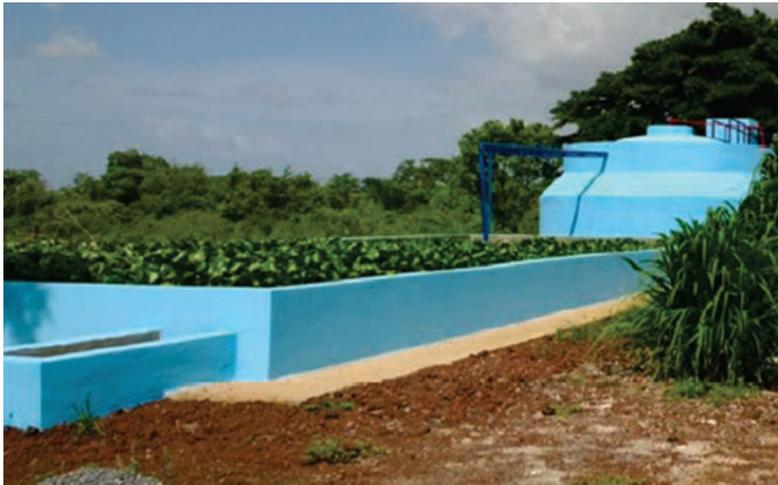
*Figura A.3.15.* Tanque de distribución del agua residual hacia los reactores anaerobios. Fuente: Reuter et al. (2022).
