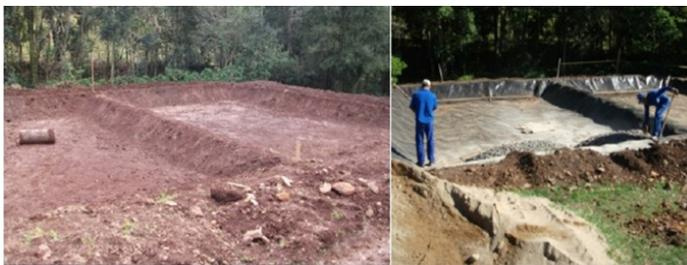
**Figura A.3.31.** Sistema wetland de flujo horizontal, excavación e impermeabilización de la unidad. Fuente: Rodrigues y van Kaick (2021).
