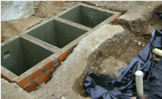
*Figura A.3.26.* . Tanque homogenizador y tubería de salida hacia el *wetland*.
