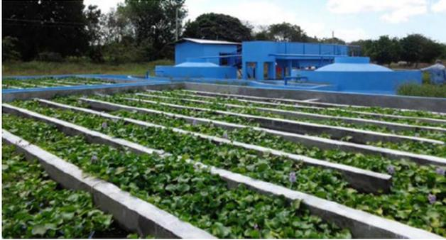
*Figura A.3.16.* Reactores anaerobios cilíndricos seguidos de los humedales de macrófitas flotantes. Fuente: Reuter et al. (2022).
