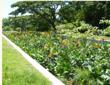
**Figura 4.57.** Humedales artificiales de flujo subsuperficial horizontal que conjuntamente con el humedal de flujo superficial trata el efluente de las lagunas de estabilización.
