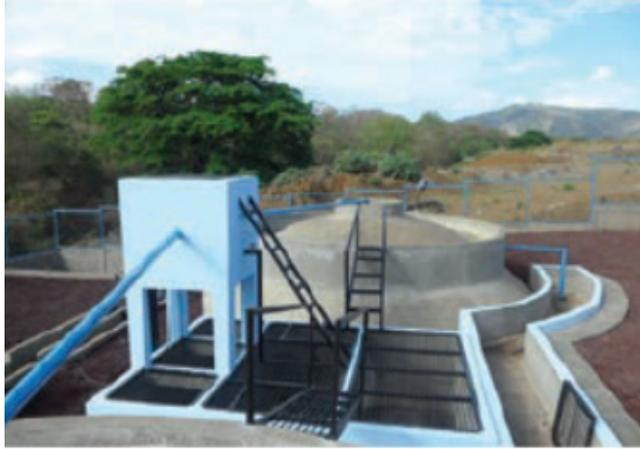
*Figura A.3.14.* Tanque de distribución del agua residual hacia los reactores anaerobios. Fuente: Reuter et al. (2022).
