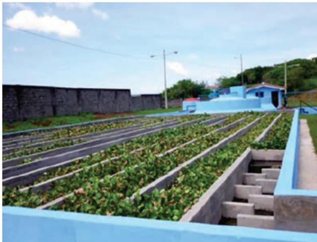
*Figura A.3.17.* Macrófitas flotantes y canal para disposición final. Fuente: Reuter et al. (2022).
