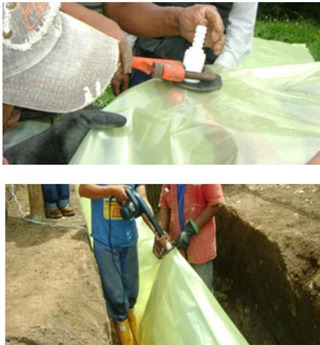
*Figura A.3.24.* Montaje del biodigestor: Instalación válvula de salida del biogás producido (izquierda). Prueba de estanqueidad del biodigestor (derecha).
