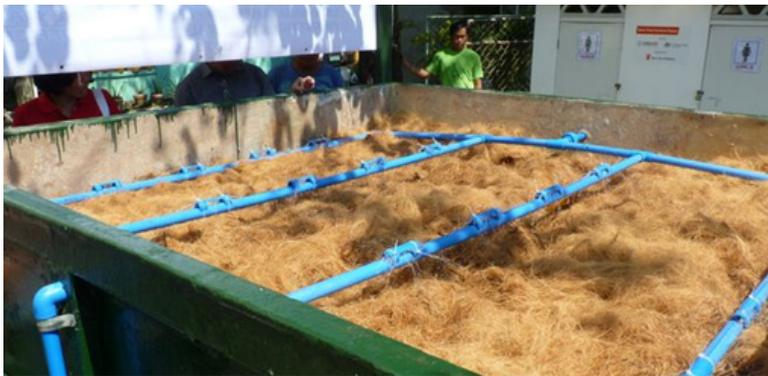
*Figura 4.60.* Biofiltro de fibra de coco para la escuela primaria de Putatan, ciudad de Muntinlupa, Filipinas.
