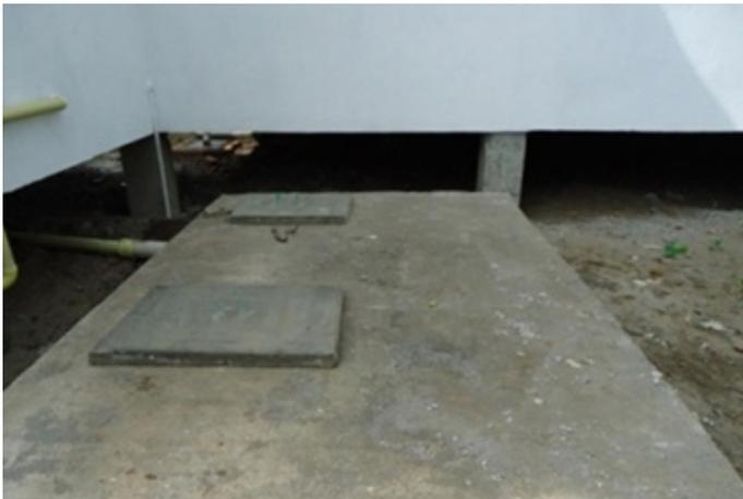
**Figura 4.29.** (a) Colocación de la malla de refuerzo para paredes y fondo de un tanque séptico construido para una escuela rural en el municipio de Tumaco, departamento de Nariño, Colombia (b) losa de cubierta del tanque con tapas de acceso a las cámaras
