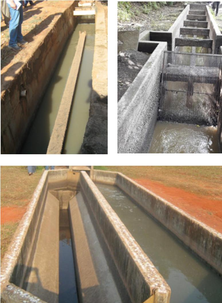
**Figura 4.12.** Desarenador con dos cámaras en paralelo funcionando de manera simultánea en las PTAR del municipio Santa Fé do Sul, Sao Paulo-Brasil (a) y Ginebra, Valle del Cauca-Colombia (b); Desarenador con dos cámaras en paralelo funcionando de manera alternada en la PTAR de Ilha Solteira, São Paulo-Brasil.
