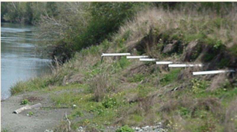
**Figura 3.4.** . Zanjas de infiltración instaladas demasiado cerca de un río.
