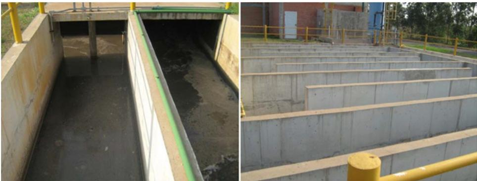
**Figura 4.68.** Sistema de desinfección del efluente de una planta de tratamiento de aguas residuales en Presidente Prudente, São Paulo-Brasil a) zona de aplicación del cloro b) canal de contacto.
