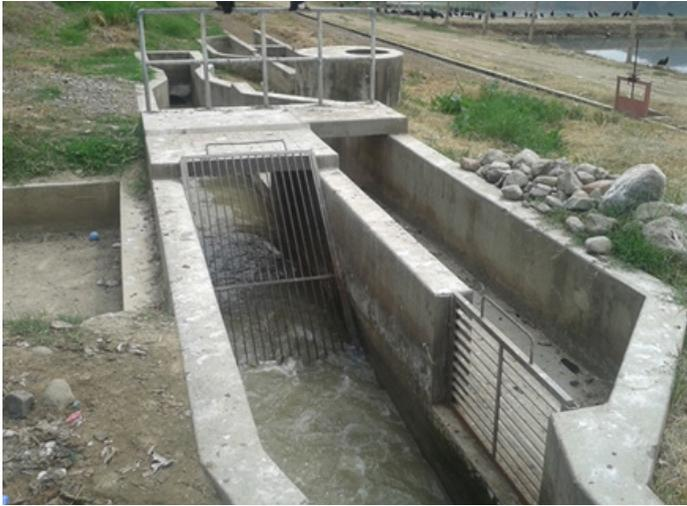
*Figura 4.13.* Unidad de rejillas y desarenador en la PTAR del municipio de Jaén, departamento de Cajamarca-Perú.
