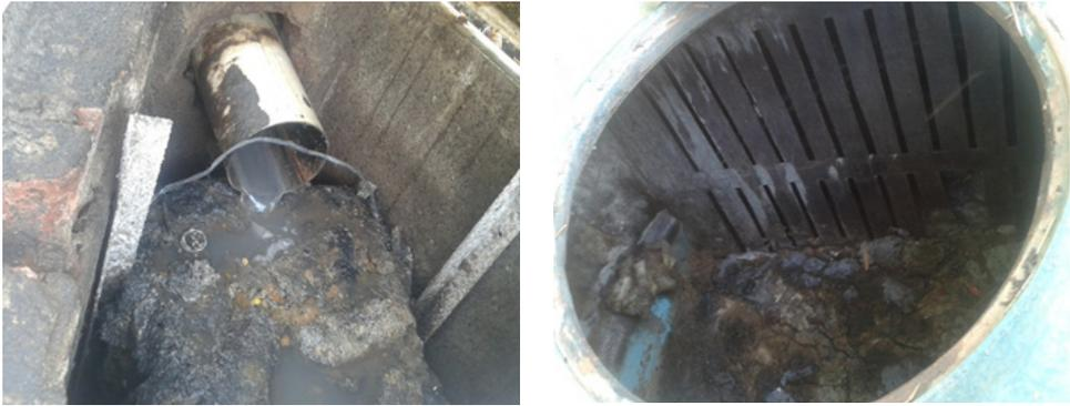
**Figura 4.9.** Canastilla metálica para retención de sólidos en la PTAR del barrio Romão dos Reis, y rejilla dispuesta en un sistema prefabricado de la PTAR del barrio Coelhas, ambas plantas de tratamiento en el municipio de Viçosa, estado de Minas Gerais-Brasil.
