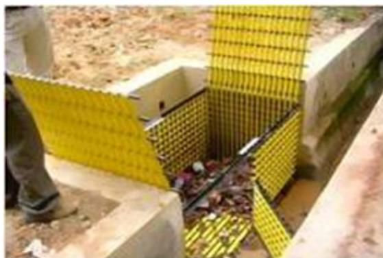
*Figura 4.11.* Trampa de residuos sólidos para alcantarillados canalizados.
