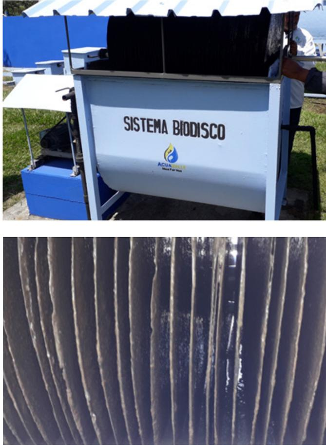
**Figura 4.65.** Sistema de contactor biológico rotativo para tratamiento de un caudal de 0,1 L/s (izquierda); detalle de la disposición de los biodiscos giratorios en relación con el nivel del agua residual en la PTAR de Ginebra, Valle del Cauca-Colombia.
