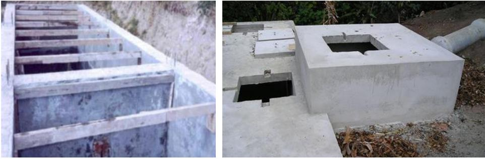
**Figura 1.6.** Pantalla para separación de cámaras en pozo séptico (A). Cámara de entrada y vista parcial de losa de cubierta de un pozo séptico (B). Obras localizadas en el entorno rural del departamento de Nariño – Colombia.
