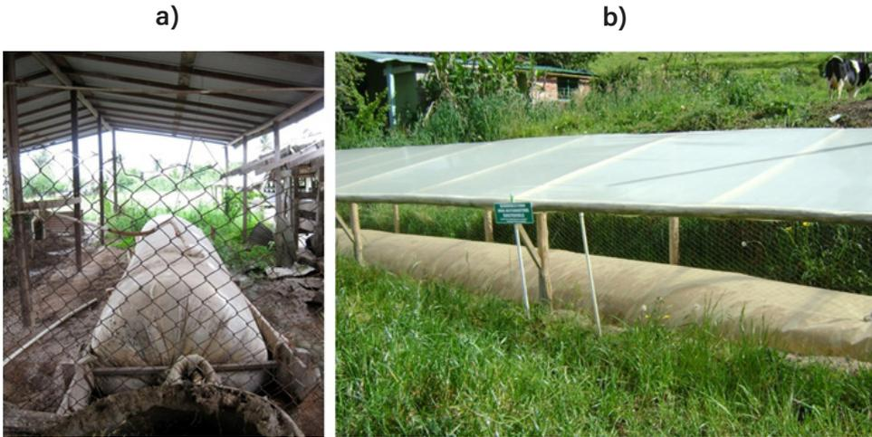
**Figura 4.32.** Digestores anaerobios plástico del tipo de flujo pistón, con protección adecuada de techo y cerco (a) en Guyana y (b) en el departamento de Nariño, Colombia.
