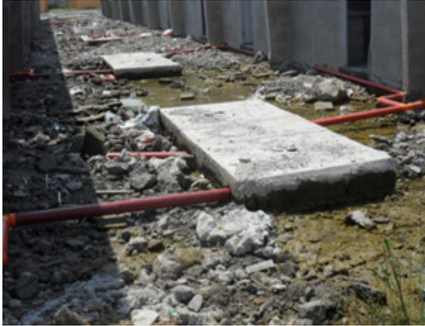
**Figura 4.19.** Construcción de alcantarillados que carecen de pozos de limpieza y accesorios sanitarios adecuados, complicando su operación y mantenimiento.
