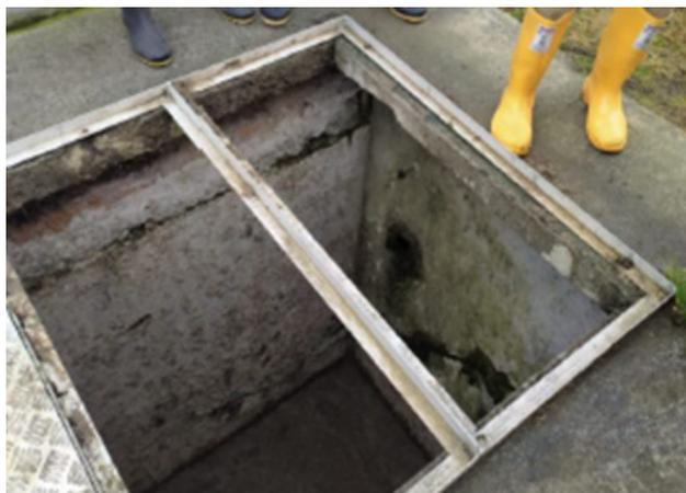
*Figura A.3.7.* Sedimentador primario para el efluente de la planta de sacrificio.
