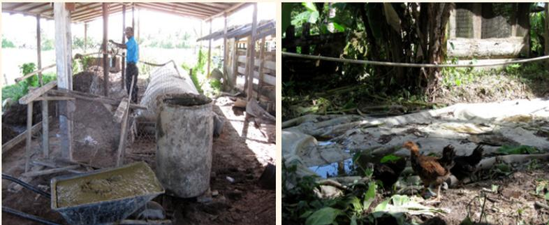
**Figura 3.28** . . Biodigestores tubulares mostrando medidas de acceso y protección adecuadas (a la izquierda) e inexistentes (a la derecha) en Guyana.
