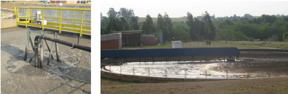
**Figura 4.63.** Reactor de lodos activados (izquierda) y sedimentador secundario (derecha), en la modalidad de sistema convencional de la PTAR de Presidente Prudente, Sao Paulo-Brasil.
