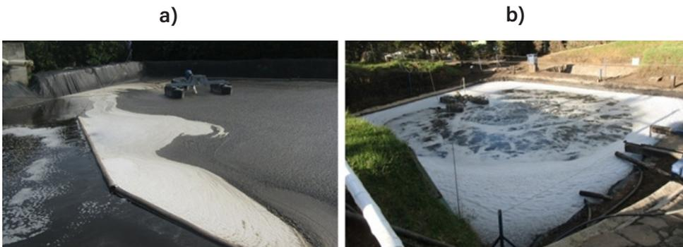
**Figura 4.54.** Usos de las lagunas aireadas en el tratamiento de aguas residuales en el municipio de Pasto, Nariño-Colombia (a) para tratamiento de efluentes de una planta de sacrificio de ganado (b) en el tratamiento de lixiviados del relleno sanitario municipal.
