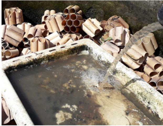
*Figura 4.59.* Biofiltro percolador para tratamiento de un caudal de 0,1 L/s (izquierda); tipo de medio soporte sintético con reúso de tubería de PVC (derecha) en la PTAR de Ginebra, Valle del Cauca-Colombia.
