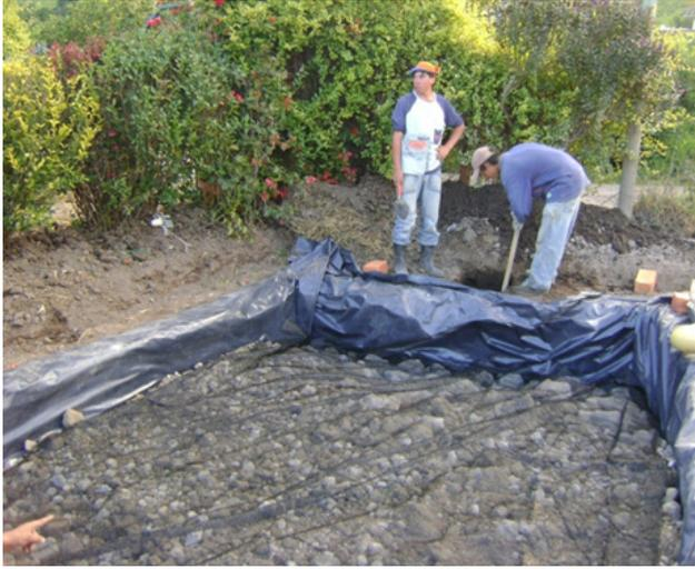
*Figura A.3.27.* Capa plástica impermeabilizante y lecho de grava en el *wetland*.
