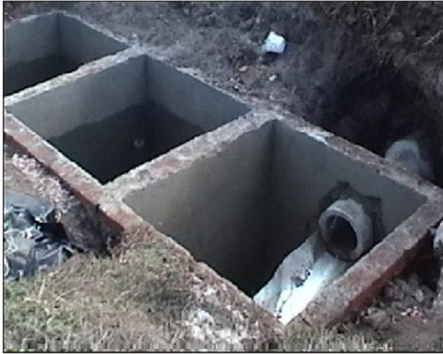
Figura A.3.18. Unidad de sedimentación primaria.
