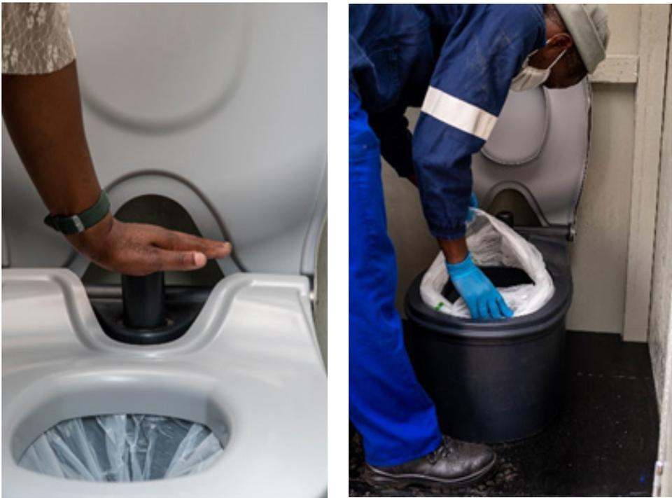
**Figura 4.6.** Imágenes de sistemas de inodoros secos *LooWatt* en Durbán, Suráfrica. (Fuente: Mikhael, 2023). a) Un usuario presiona el botón de descarga del inodoro *LooWatt*, b) Un funcionario desmonta la bolsa plástica para su reemplazo en un inodoro *LooWatt*.<sup>7</sup>
