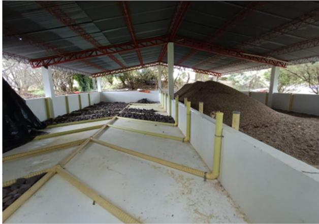
*Figura A.3.12.* Pilas de compostaje para estabilización de residuos sólidos.
