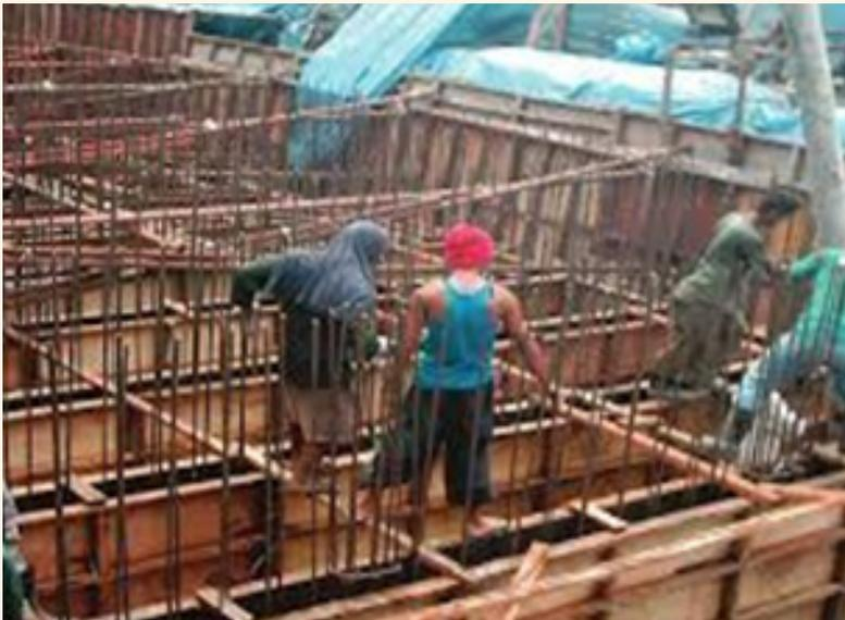
*Figura 2.7 . Filtro de fibra de coco y reactor anaerobio con deflectores + filtro de flujo ascendente durante la construcción.*
