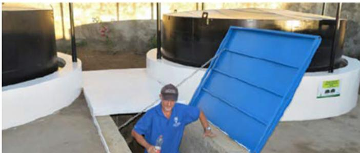
**Figura A.3.1.** Acceso de servicio al reactor de biogás de campana flotante. Fuente: Reuter et al. (2022)
