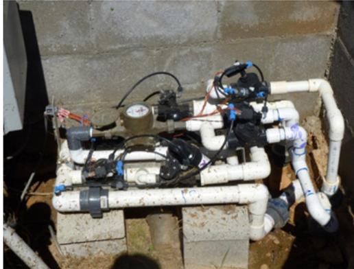
*Figura 4.43.* . . Equipo mecánico para irrigación por goteo mostrando válvulas solenoides que controlan la distribución del líquido.
