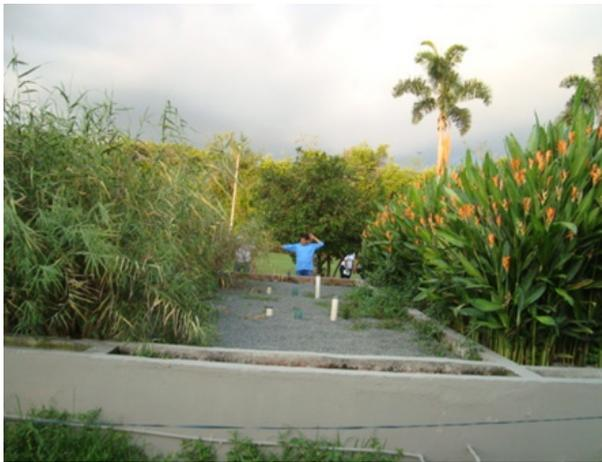
Figura 4.46. . . Fotografía de humedales de flujo subsuperficial horizontal en el municipio de Ginebra, Valle del Cauca-Colombia.
