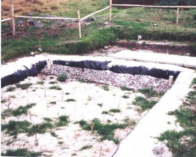
*Figura A.3.20.* Implementación del vegetal depurador de aguas residuales.
