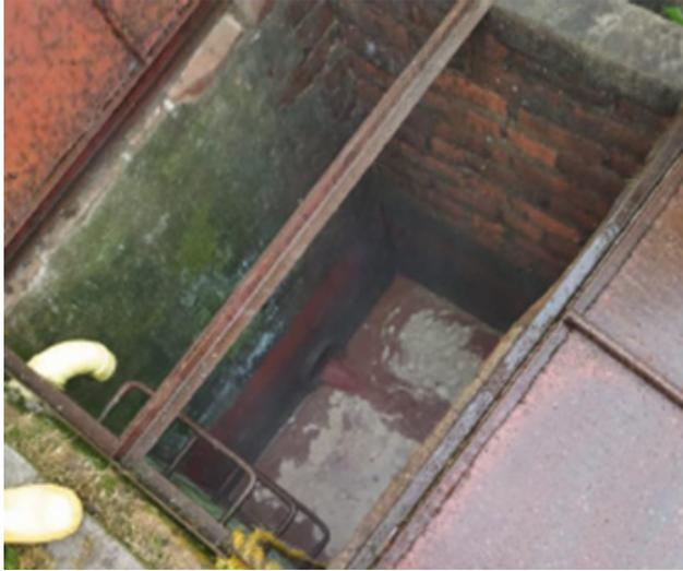
*Figura A.3.6.* Trampa de grasas para el efluente de la planta de sacrificio.
