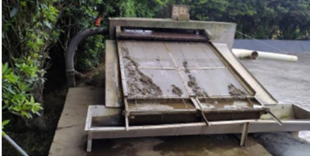
*Figura A.3.8.* Cámara de homogenización y distribución de caudal.
