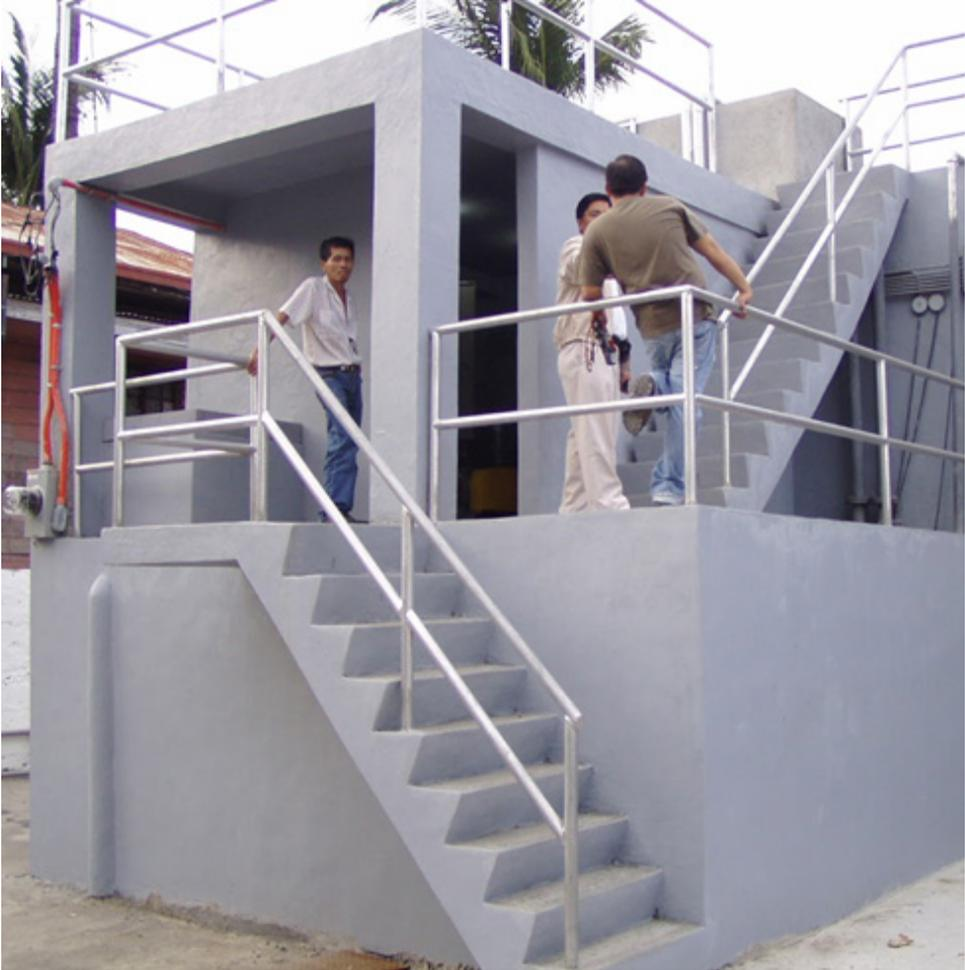
**Figura 5.1.** Planta para tratamiento de aguas residuales con Reactor Discontinuo Secuencial para la plaza de mercado y centro comercial en la ciudad de San Fernando, La Unión, Filipinas. Este es un ejemplo de cómo la limitada disponibilidad de terreno puede ser el factor clave en el proceso de toma de decisiones para seleccionar la tecnología para SDMAR
