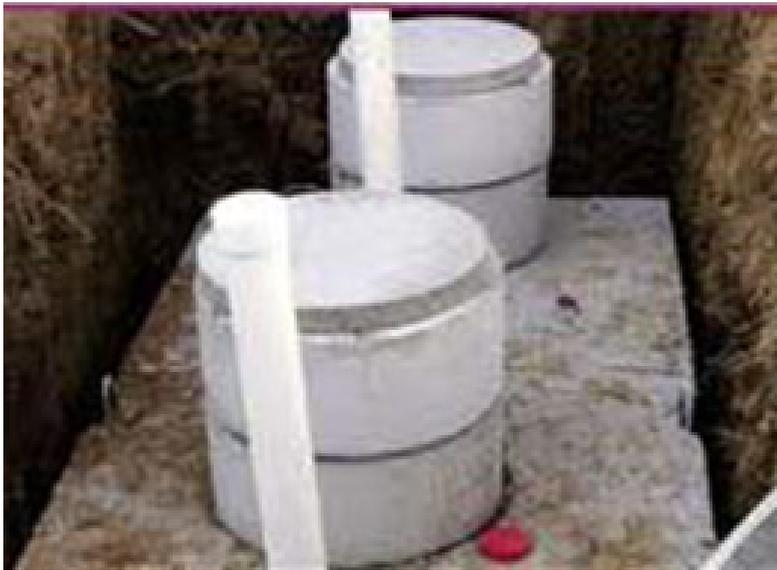
*Figura 3.26*. Tanque séptico antes de una prueba de fugas mostrando cómo las tapas y tuberías verticales son selladas antes de la prueba con masilla de silicona no retráctil.
