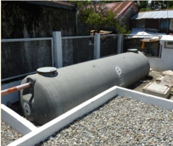
*Figura 2.8.* . SDMAR comunal que usa un tanque de tratamiento EcoTank™ seguido por un filtro de grava, ciudad de San Fernando, Filipinas.
