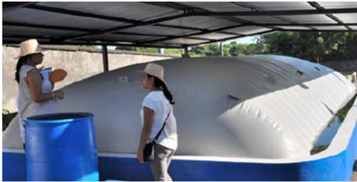
*Figura A.3.2.* Reactor anaerobio con deflectores cubierto con carpa de membrana. Fuente: Reuter et al. (2022)
