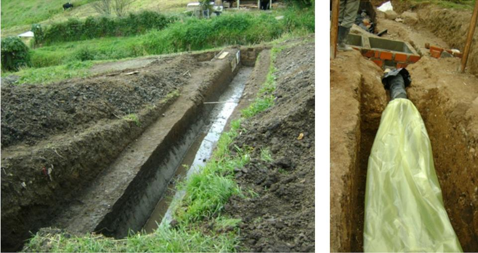
*Figura A.3.23.* Zanja excavada en material férreo (izquierda), montaje del biodigestor (derecha).
