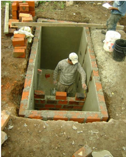
*Figura A.3.22.* Cámara de recepción de efluentes domésticos y pecuarios y distribución para el biodigestor.
