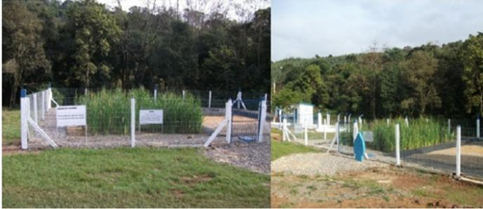
*Figura A.3.32.* Sistema wetland de flujo horizontal, unidad plantada en operación. Fuente: Rodrigues y van Kaick (2021).
