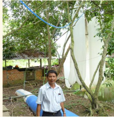
**Figura 4.33.** Digestor tubular de flujo pistón en Vietnam. (Fuente: Thomson, 2013).
