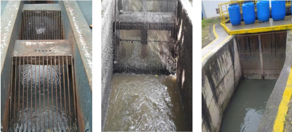
**Figura 4.8.** Sistemas de rejilla para limpieza manual a la entrada de PTARs.
