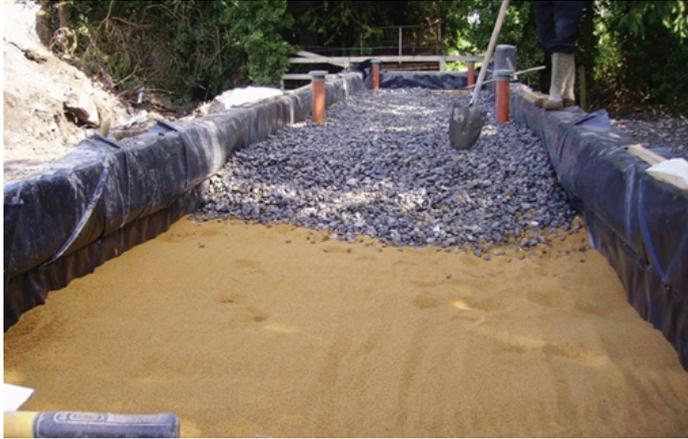
*Figura 4.66.* Filtro lento de arena en construcción, mostrando los lechos de grava y arena, cerca de Tullamore, Irlanda (Fuente: Molloy, 2013)
