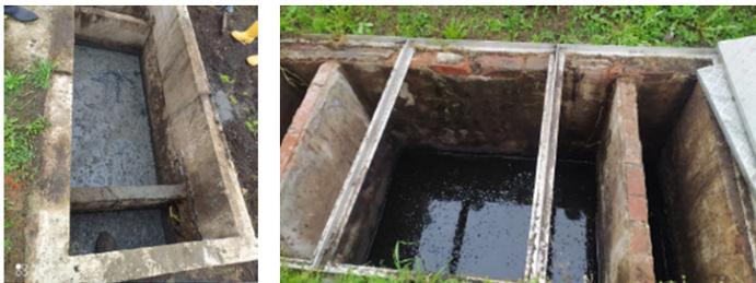
*Figura A.3.5.* Pretratamiento para separación de material flotante y sedimentable proveniente de los corrales.
