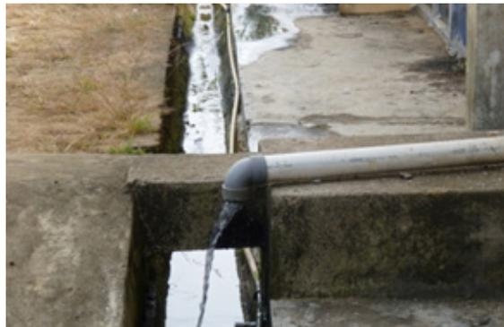
**Figura 2.5.** . Aguas grises separadas en la fuente y descargadas en una zanja de drenaje al aire libre, Palembang, Indonesia.
