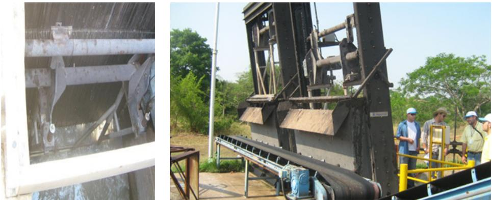
**Figura 4.10.** Rejilla para retención de sólidos de limpieza mecanizada en la planta de tratamiento de aguas residuales del municipio Presidente Prudente, estado de São Paulo-Brasil.
