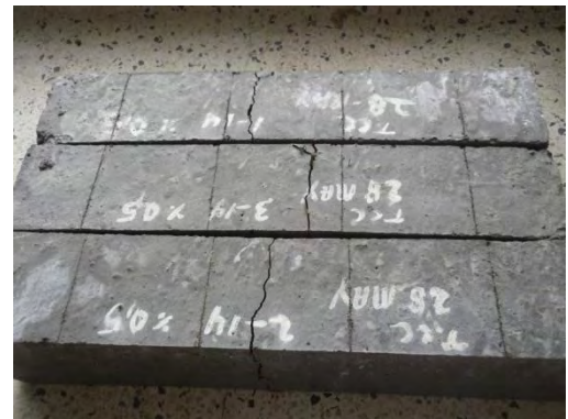
Figura 26. Vigas falladas al tercio
