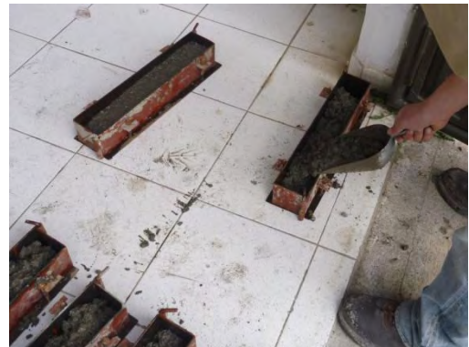
Figura 14. Vaciado de vigas
