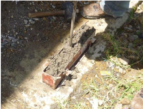
Figura 14. Compactación de vigas
