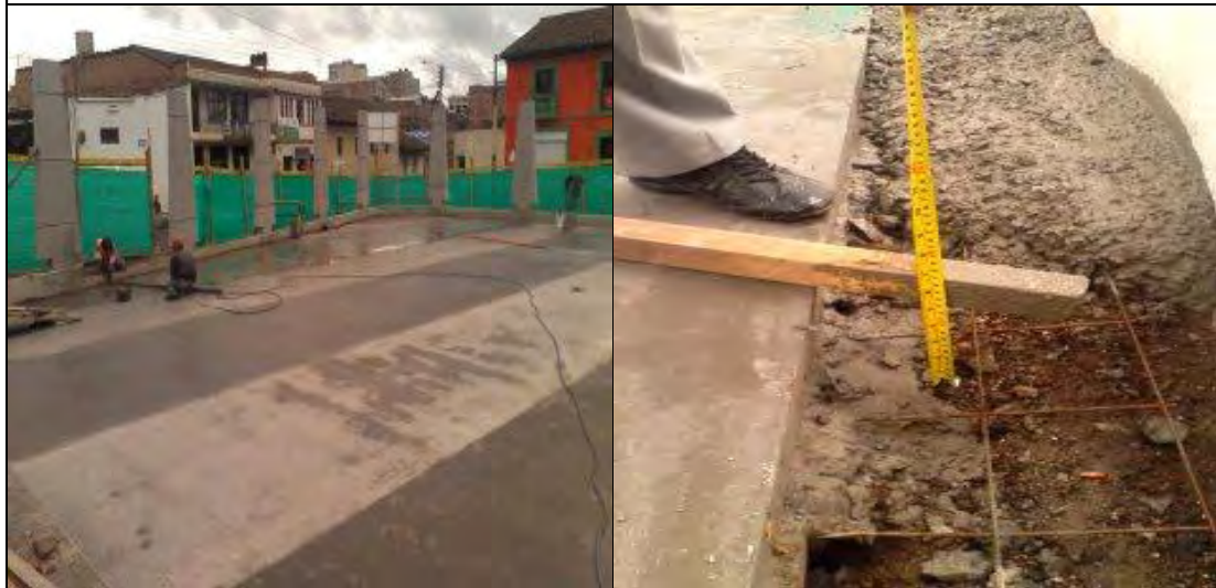
FOTO: 47 FOTO: 48 LOSA EN CONCRETO CANCHA MULTIFUNCIONAL LOSA EN CONCRETO E=10CMS CANCHA MULTIFUNCIONAL + MALLA ELECTROSOLDADA
