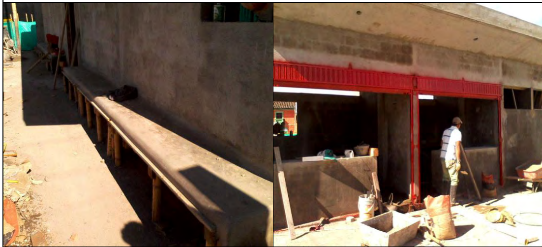
FOTO: 87 FOTO: 88 GRADA EN CANCHA DE VOLEIBOL VIGAS Y COLUMNAS SECTOR LOCALES COMERCIALES
