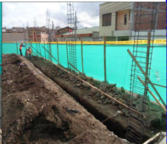
FOTO: 8 UBICACIÓN DE COLUMNAS
