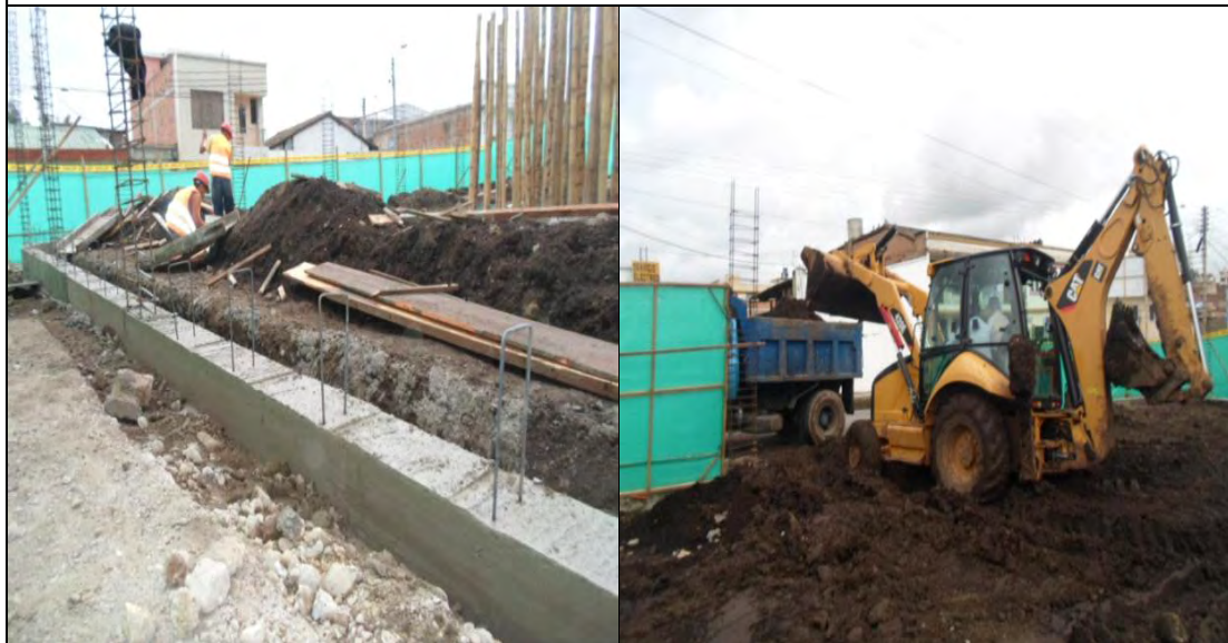
FOTO: 19 FOTO: 20 BORDILLO SOBRE VIGA DESALOJO DE MATERIAL
