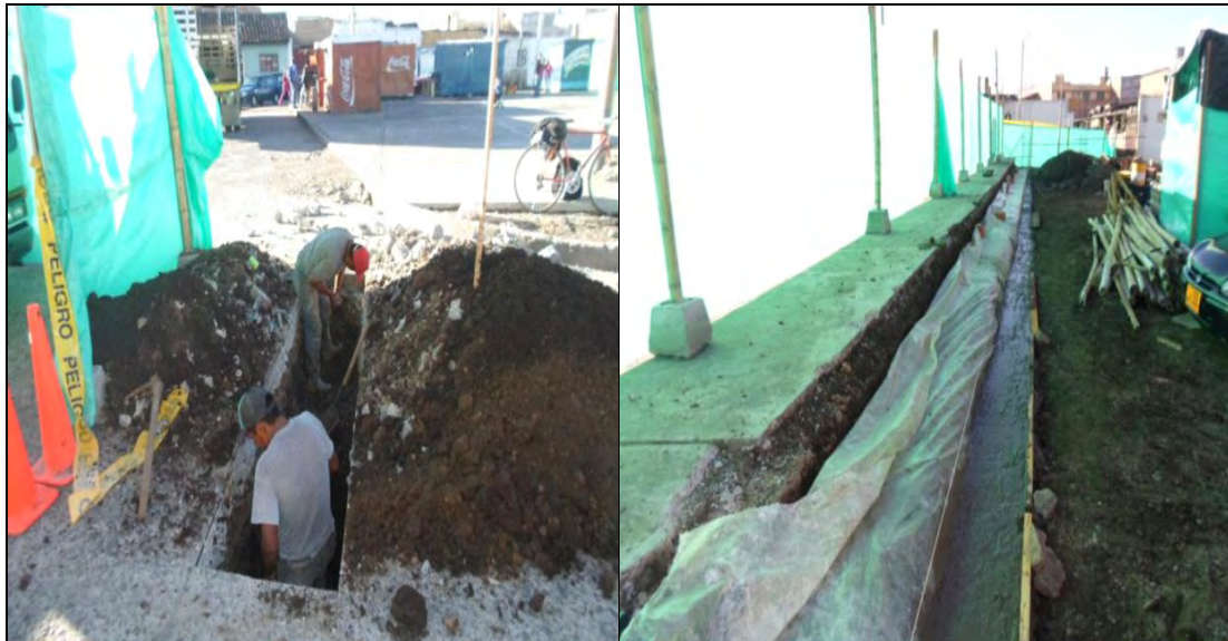
FOTO: 17 FOTO: 18 DEMOLICIÓN Y EXCAVACIÓN PARA ACOMETIDAS HIDRÁULICAS VIGA PARA GRADERIA
