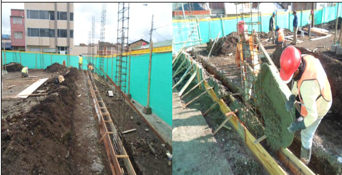
FOTO: 15 FOTO: 16 FORMALETA DE VIGA DE CIMENTACIÓN FUNDICIÓN DE VIGA DE CIMENTACIÓN
