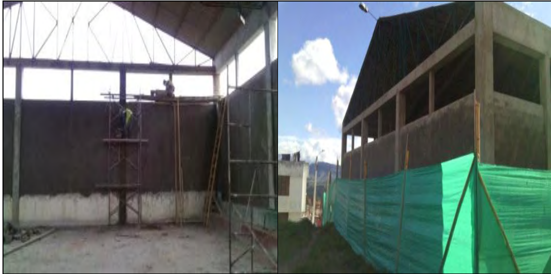
FOTO: 17 FOTO: 18 REPELLO LISO SOBRE MAMPOSTERIA, COLUMNAS Y VIGAS REPELLO LISO DE EXTERIORES
