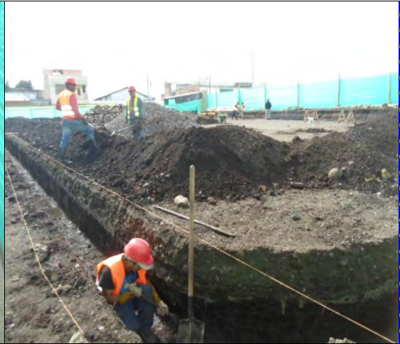
FOTO: 6 REPLANTEO Y EXCAVACIONES A MANO PARA CIMENTACIONES
