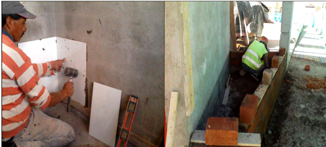
FOTO: 85 FOTO: 86 ENCHAPE EN CABINAS DE VENTAS CONSTRUCCIÓN JARDINERA ADYACENTE A CABINAS DE VENTAS
