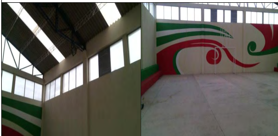
FOTO: 27 FOTO: 28 INSTALACIÓN DE TEJADOS TRASLÚCIDOS Y VENTANERÍA JUEGO DE ARCO Y CANCHA PARA MICROFUTBOL Y BALONCESTO
