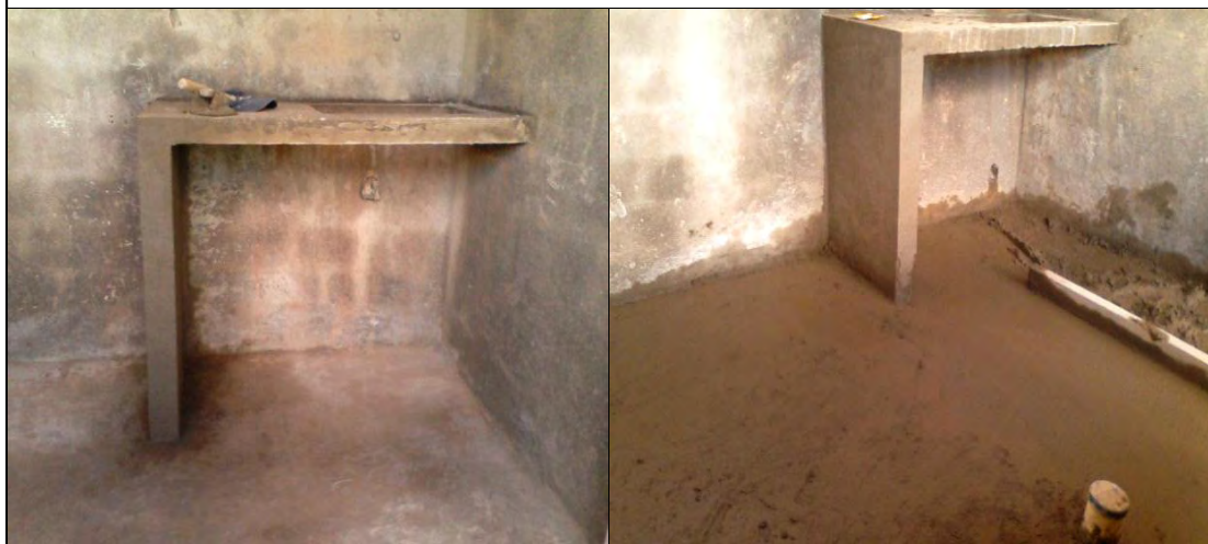
FOTO: 83 FOTO: 84 MESÓN PARA LAVAPLATOS EN CABINAS DE VENTAS AFINADO DE PISOS EN CABINAS DE VENTAS
