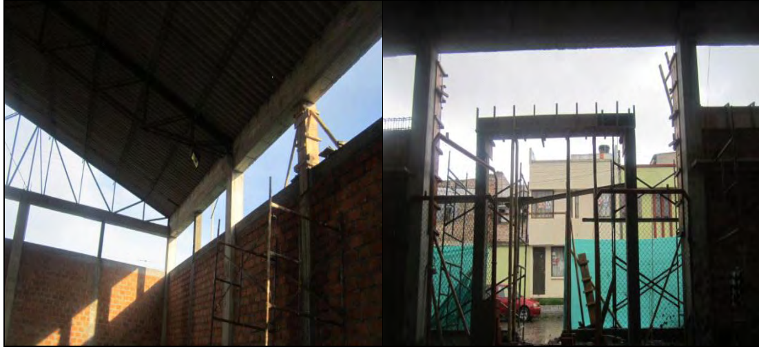
FOTO: 13 FOTO: 14 FUNDICIÓN DE COLUMNETAS COLUMNAS Y VIGAS DE FACHAS PRINCIPAL
