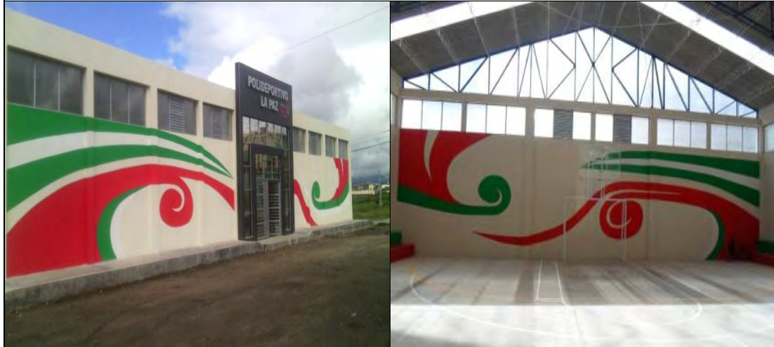
FOTO: 35 FOTO: 36 PANORÁMA EXTERIOR DEL POLIDEPORTIVO LA PAZ TERMINADO PANORÁMA INTERIOR DEL POLIDEPORTIVO LA PAZ TERMINADO
