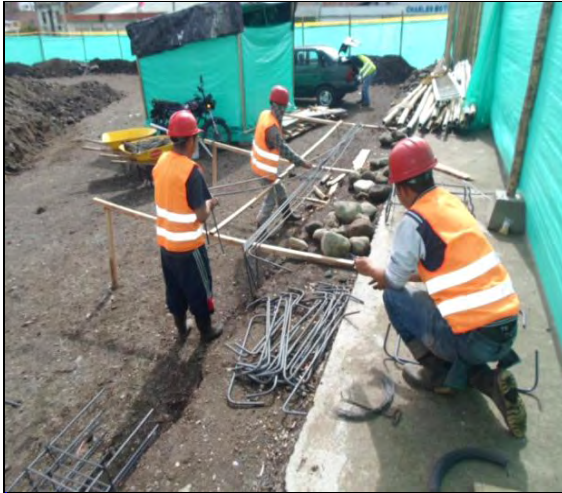
FOTO: 5 CORTE Y MODELADO DE ACERO PARA ZAPATAS Y COLUMNAS
