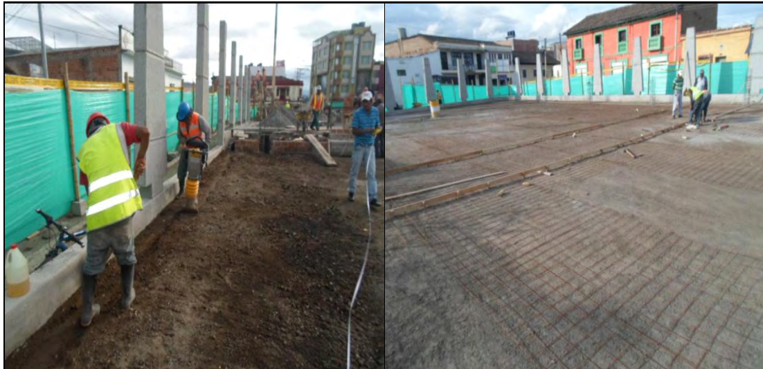
FOTO: 45 FOTO: 46 RELLENO COMPACTADO ZONAS DE VIGAS MALLA ELECTROSOLDADA PARA LOSA E:10 CM
