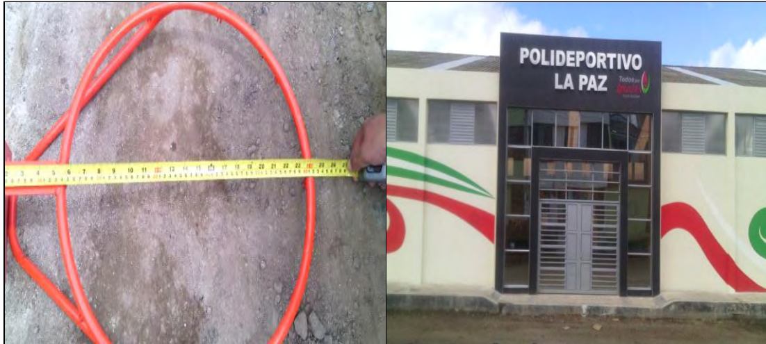
FOTO: 33 FOTO: 34 ARCOS INSTALACIÓN DE LOGOS Y VENTANERÍA EN LA FACHADA PRINCIPAL
