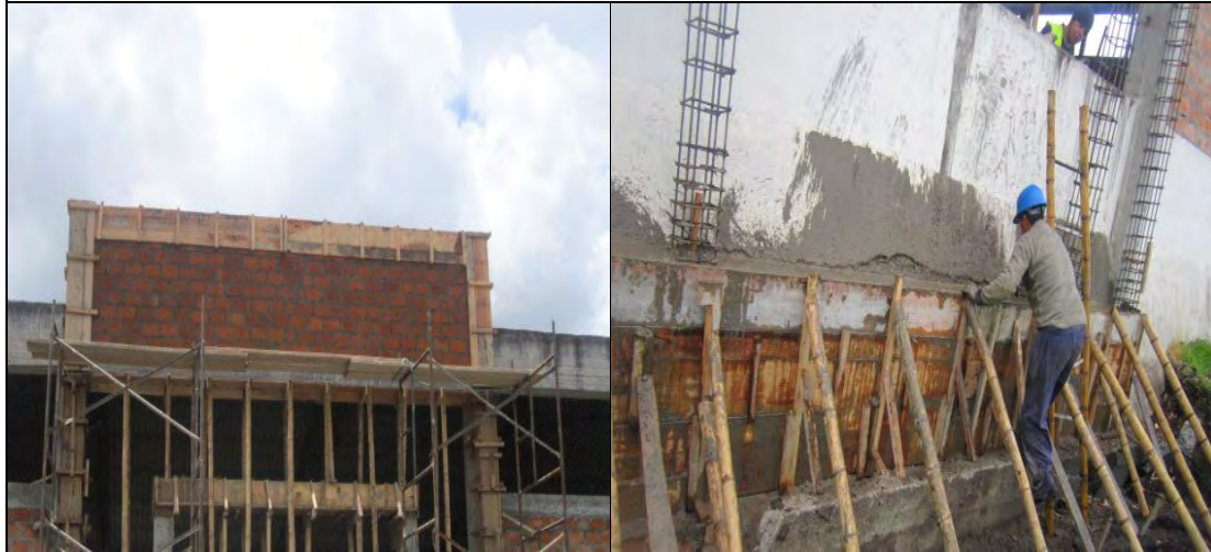
FOTO: 15 FOTO: 16 MAMPOSTERIA EN FACHADA PRINCIPAL FUNDICIÓN COLUMNAS Y VIGA PARA FACHADA POSTERIOR
