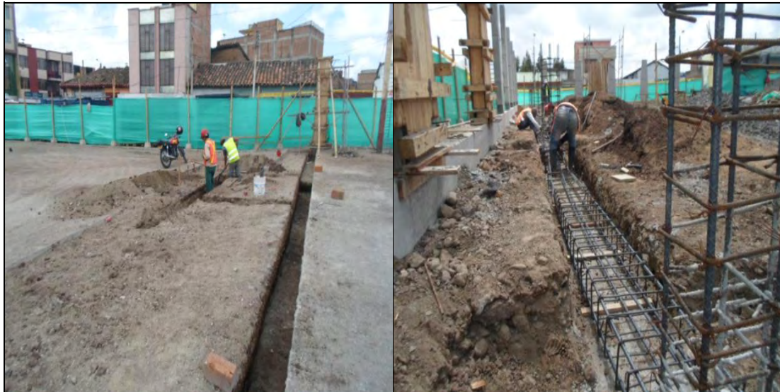
FOTO: 37 FOTO: 38 EXCAVACIÓN PARA VIGA SECTOR LOCALES COMERCIALES VIGA DE CIMENTACIÓN ENTRE PEDESTALES
