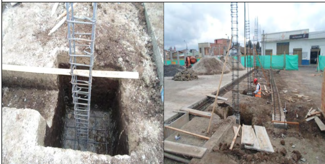
FOTO: 39 FOTO: 40 ACERO DE COLUMNA Y ZAPATA SECTOR LOCALES COMERCIALES VIGAS Y COLUMNAS SECTOR LOCALES COMERCIALES
