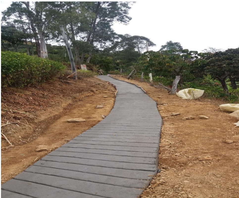
Foto 6. Mejoramiento caminos veredales
