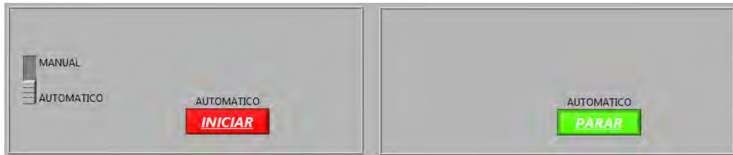
Figura 30. Selector Automático/manual en modo automático
