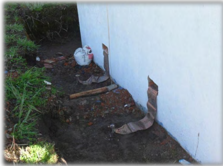
Figura 28. Varillas de puesta a tierra
