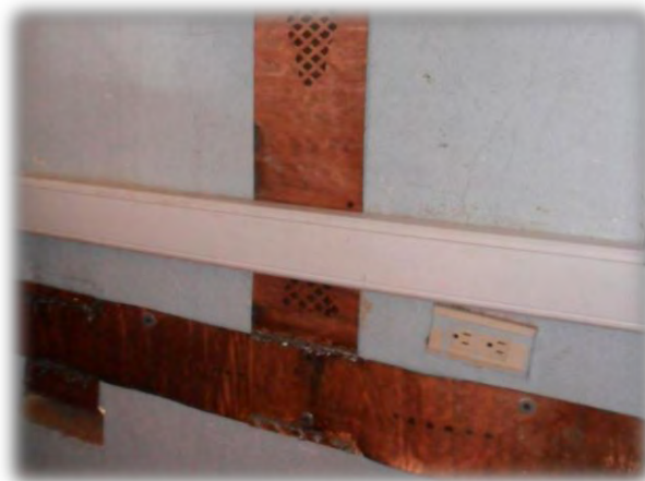
Figura 27. Instalación de puesta a tierra
