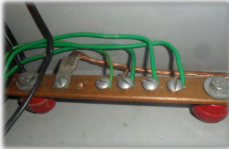
Figura 43. Barraje de protección a tierra
