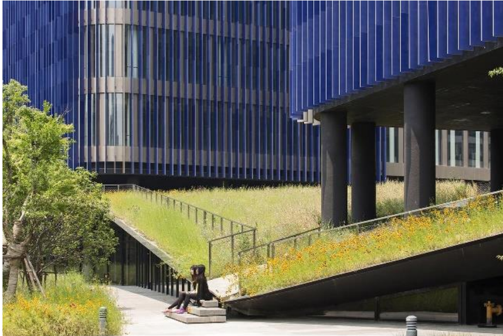
Figura 29. Vista exterior espacio público complejo de oficinas Yidian Fuente. Archdaily, s.f
