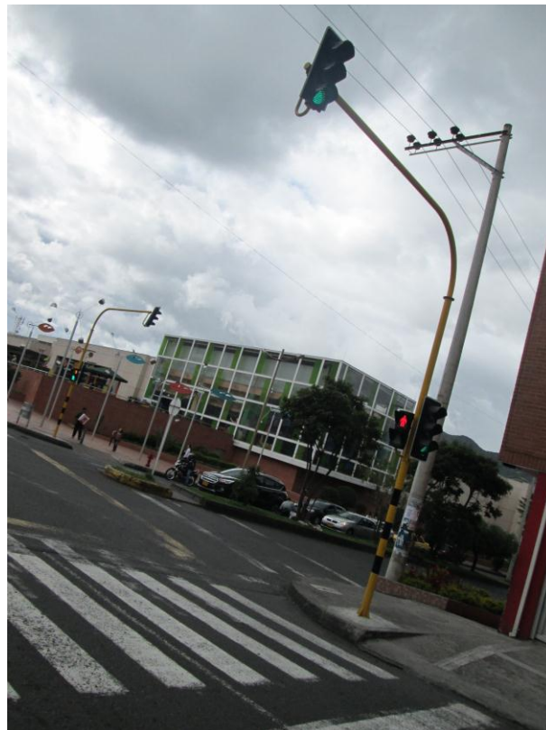
Ilustración 2. Semáforo Unicentro Pasto
