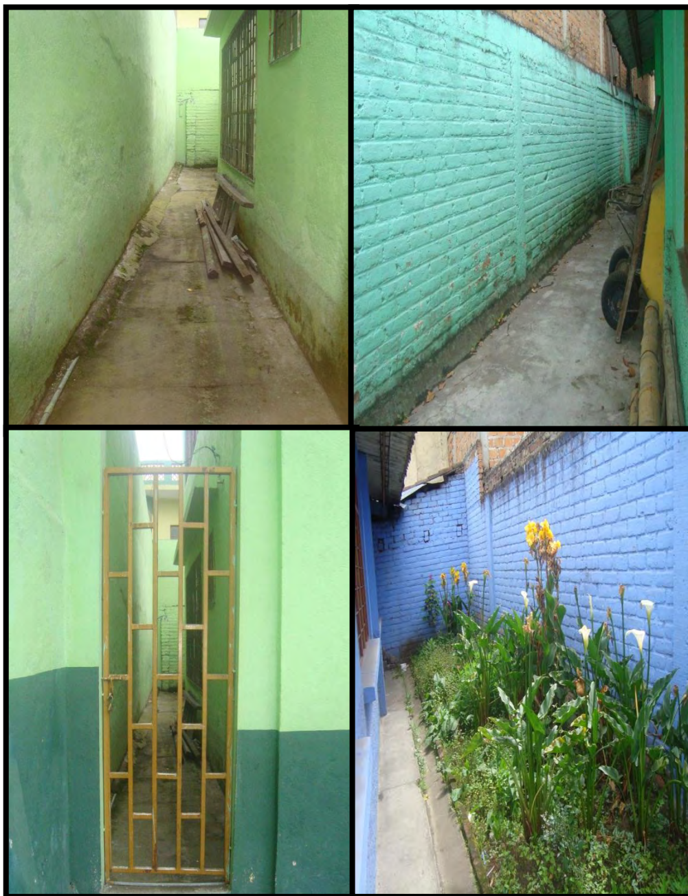
Figura 17. Registro fotográfico final
