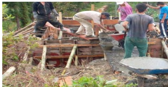
Figura 14. Fundición de los muros tanque de almacenamiento
