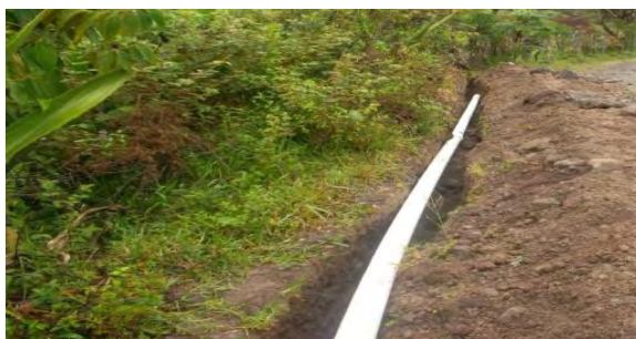
Figura 16. Instalación red de distribución.
