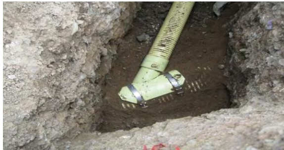
Figura 21. Construcción acometida domiciliaria.
