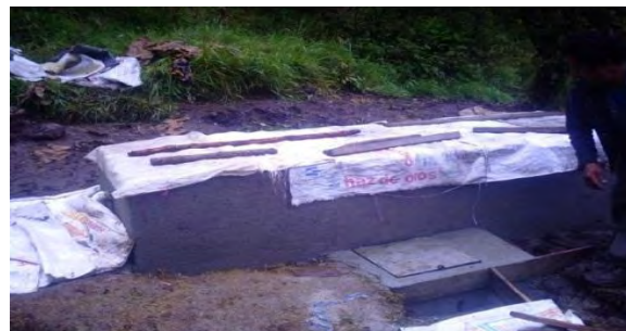
Figura 4. Terminado del desarenador la Merced
