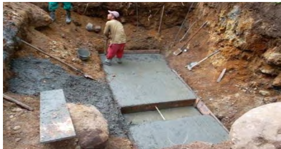
Figura 7. Excavación y fundición placa de piso.
