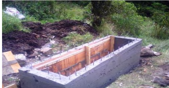
Figura 3. Formaleta muros del desarenador la Merced.
