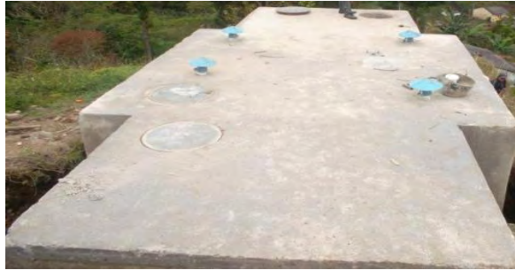
Figura 15. Colocación de accesorios y acabado del tanque Bellavista.
