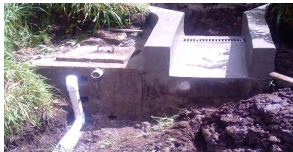
Figura 2. Vista general acabados bocatoma la Merced
