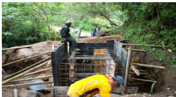
Figura 8. Amarrado, figurado de refuerzo y colocación de formaleta.
