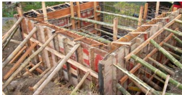
Figura 13. Armado del refuerzo y colocación de formaleta del tanque
