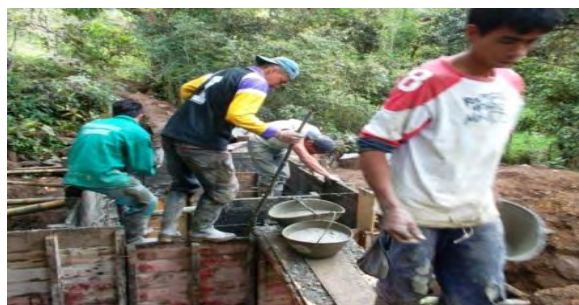
Figura 9. Fundición de muros
