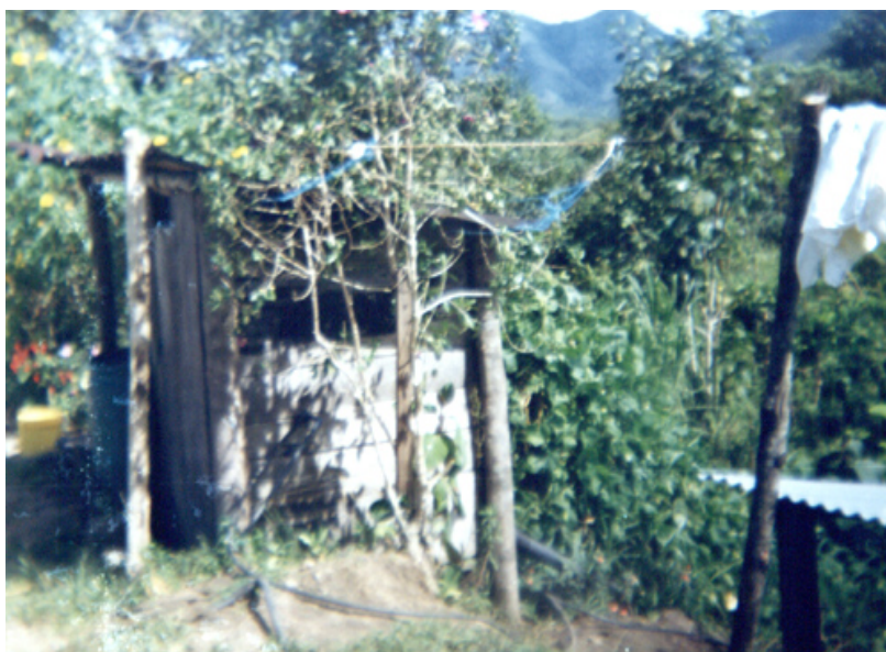
Foto 6. Vista lateral unidad sanitaria
