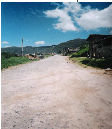
Figura 11. Antigua vía al norte Comuna 10. Municipio de Pasto.
