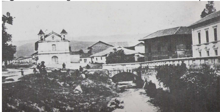
Figura 12. Antigua Avenida Santander Municipio Pasto
