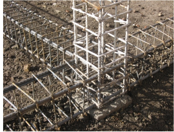
Fotografía 29. Detalle amarre viga de cimentación - columna
