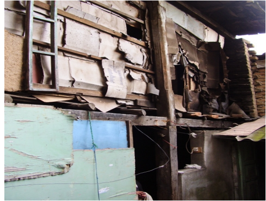
Fotografía 137. Piso colapsado nivel de calle
