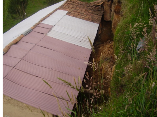
Fotografía 154. Vista superior de Talud
