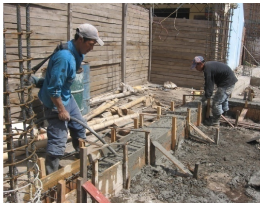
Fotografía 32. Vibración concreto en vigas de cimentación
