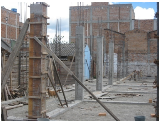
Fotografía 37. Retiro de formaleta de columnas
