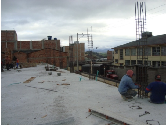
Fotografía 54. Armado vigas
