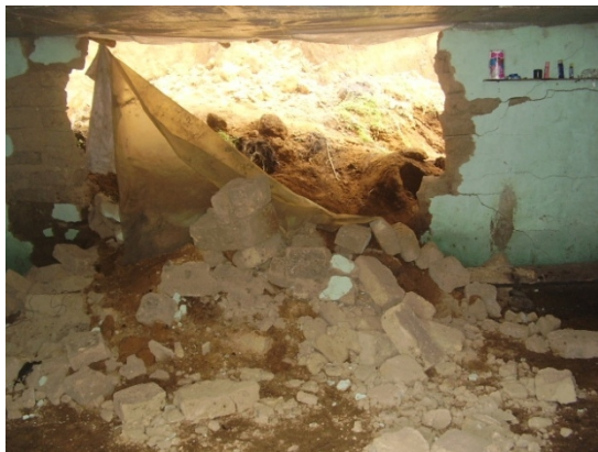
Fotografía 155. Vista Interior del muro
