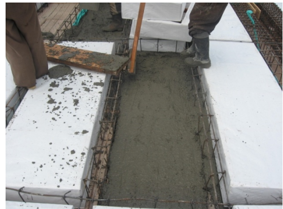
Fotografía 51. Fundición losa entrepiso
