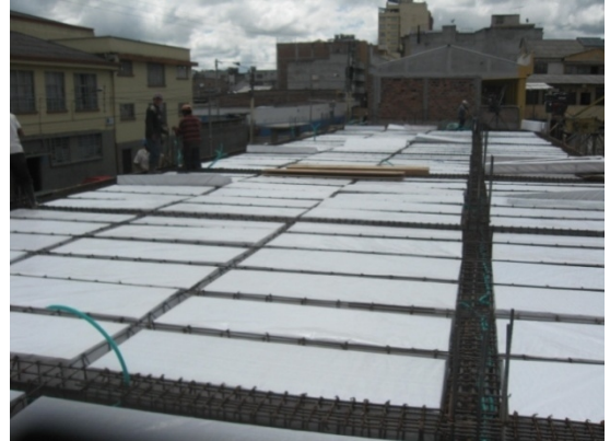
Fotografía 47. Colocación casetones
