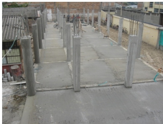
Fotografía 41. Fundición losa contrapiso terminada
