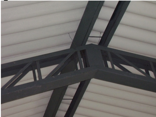
Fotografía 64. Detalle unión Cercha –Correa
