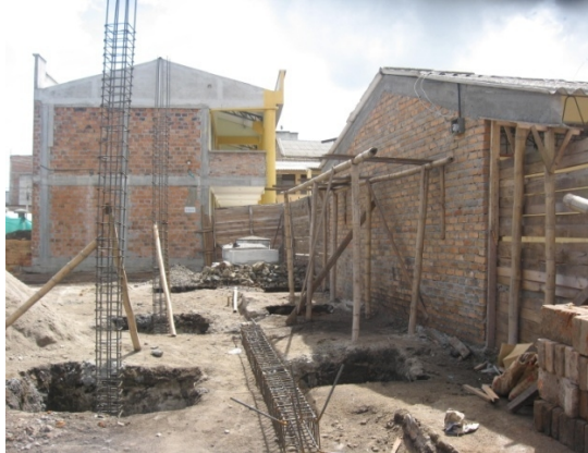
Fotografía 14. Reconstrucción de Muro
