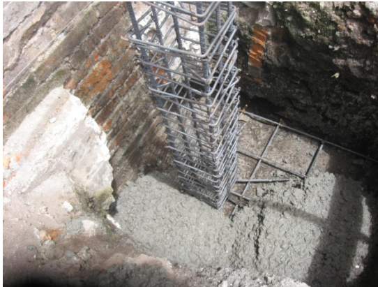
Fotografía 18. Inicio de vaciado para zapata
