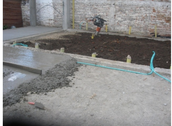
Fotografía 40. Fundición losa contrapiso
