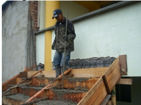
Fotografía 84. Vibrado de concreto
