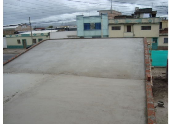
Fotografía 102. Losa de cubierta terminada
