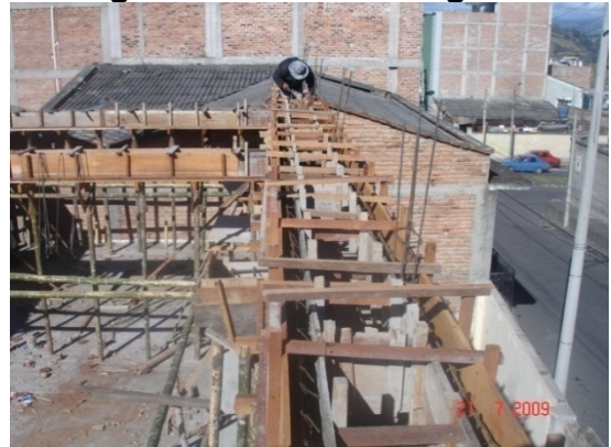
Fotografía 55. Armado viga canal
