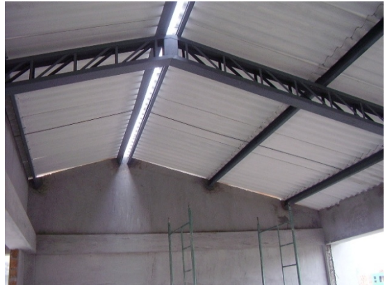
Fotografía 64. Detalle unión Cercha –Correa
