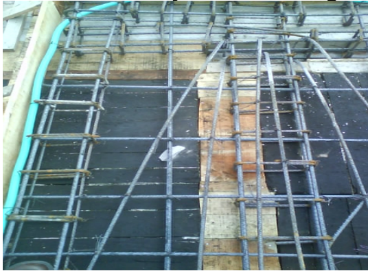
Fotografía 103. Parrilla, distanciadores y armado de vigas
