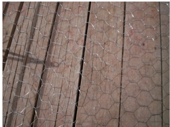
Fotografía 45. Detalle malla de cielo raso
