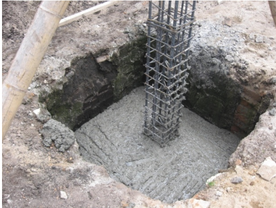
Fotografías 20 y 21. Zapatas fundidas
