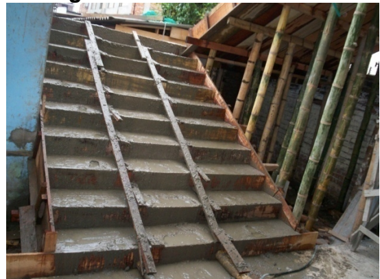
Fotografía 83. Fundición escaleras
