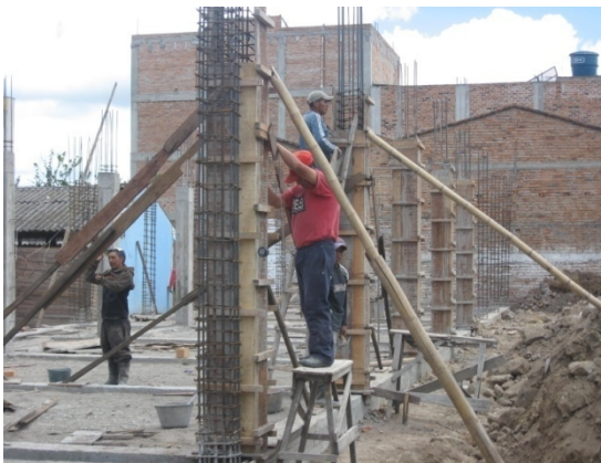
Fotografía 37. Retiro de formaleta de columnas
