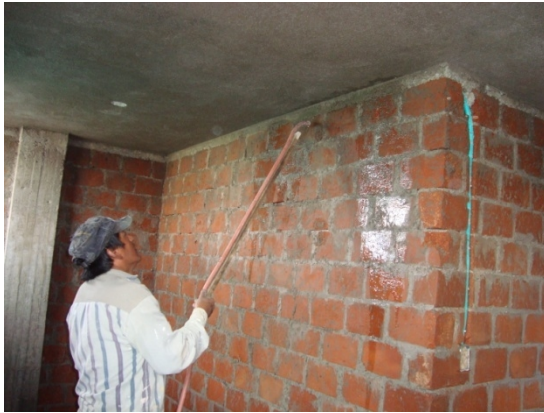
Fotografía 109 y 110. Pañetes muros externos
