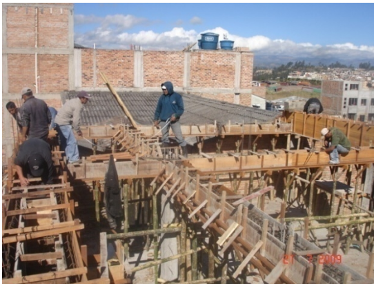
Fotografía 54. Armado vigas
