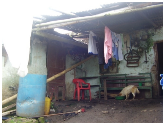
Fotografía 128. Construcción posterior en adobe
