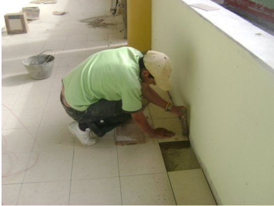
Fotografía 76. Asentamiento de cerámica mediante golpes
