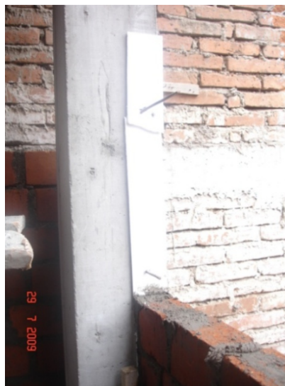
Fotografía 66. Dilatación en poliuretano y anclaje en muro
