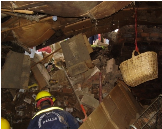
Fotografía 136. Colapso entrepiso en madera
