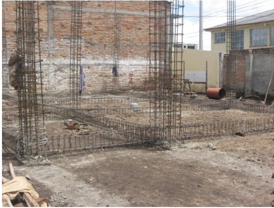
Fotografía 28. Vigas de cimentación B5.
