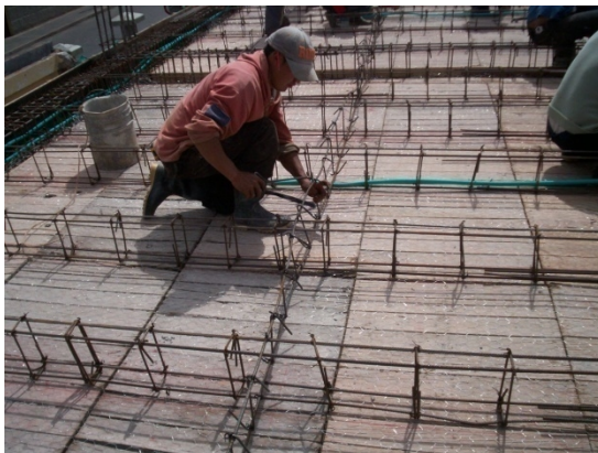
Fotografía 44. Instalación malla de cielo raso
