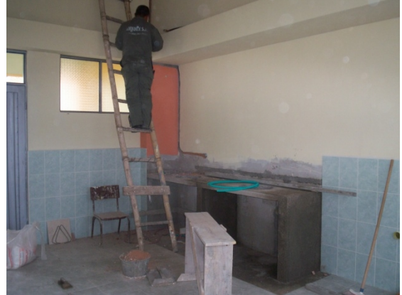
Fotografía 77. Enchape baño y construcción mesón
