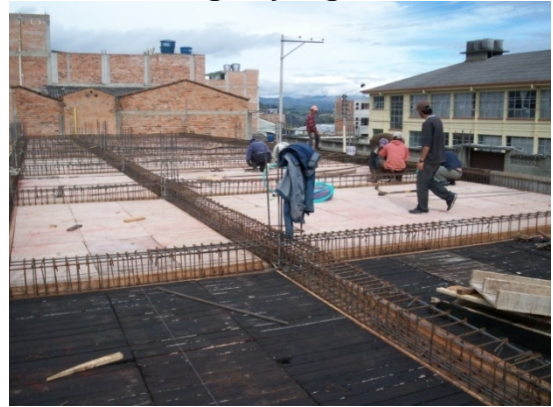
Fotografía 43. Armado del refuerzo de vigas y viguetas
