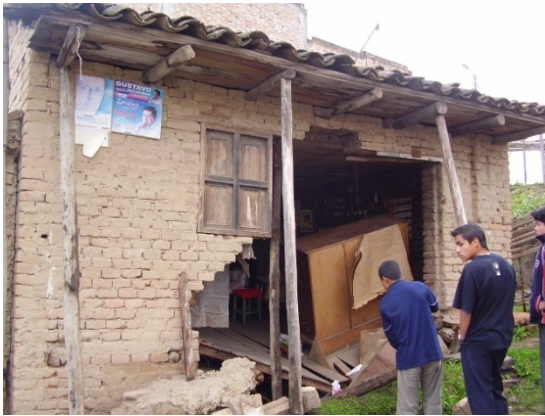
Fotografía 136. Colapso entrepiso en madera
