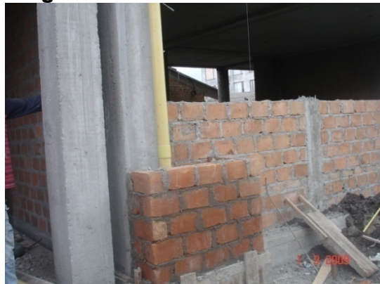
Fotografía 69. Construcción buitrones
