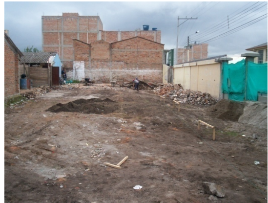
Fotografía 8 y 9. Localización y replanteo
