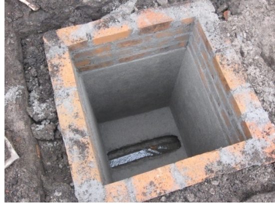
Fotografía 27. Caja de inspección terminada
