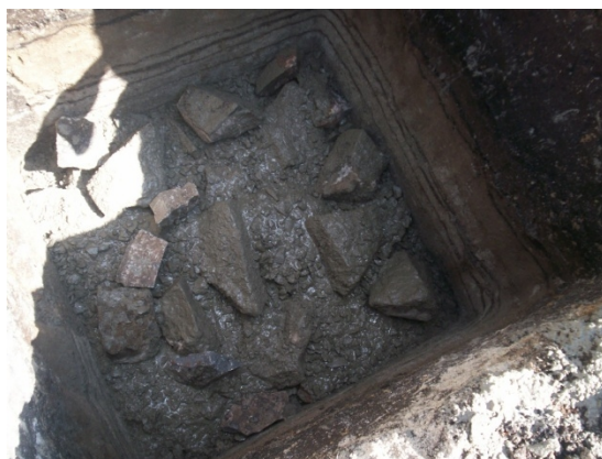
Fotografías 16 y 17. Concreto ciclópeo
