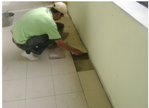
Fotografía 75. Instalación cerámica para piso
