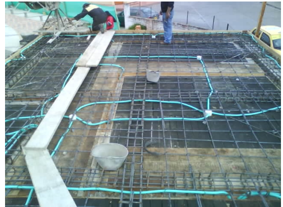
Fotografía 104. Instalación eléctrica
