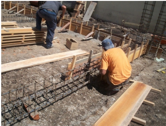
Fotografía 30. Formaleta vigas de cimentación.
