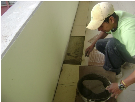
Fotografía 74. Aplicación mortero sobre piso
