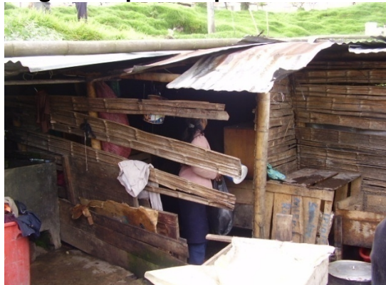
Fotografía 139. Construcción en guadua parte superior vivienda
