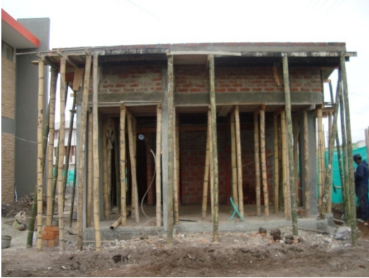
Fotografía 101. Mampostería sobre vigas aéreas
