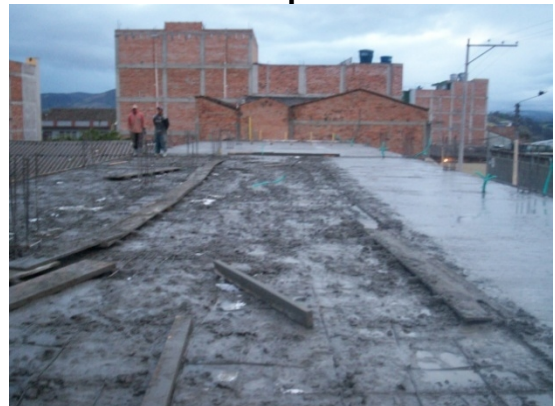
Fotografía 51. Fundición losa entrepiso
