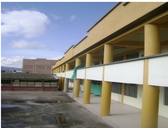
Fotografía 72. Pintura muros externos
