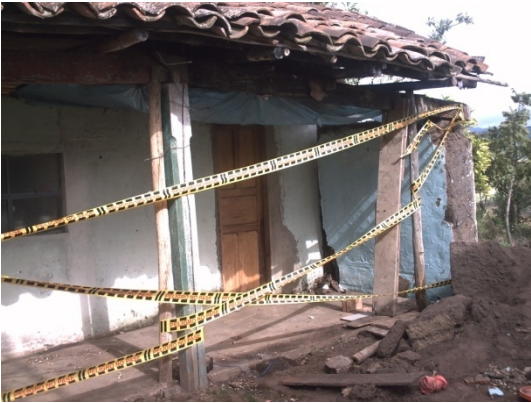
Fotografía 148, 149, 150, 151 Y 152. Asentamiento de muro por desestabilización de Talud
