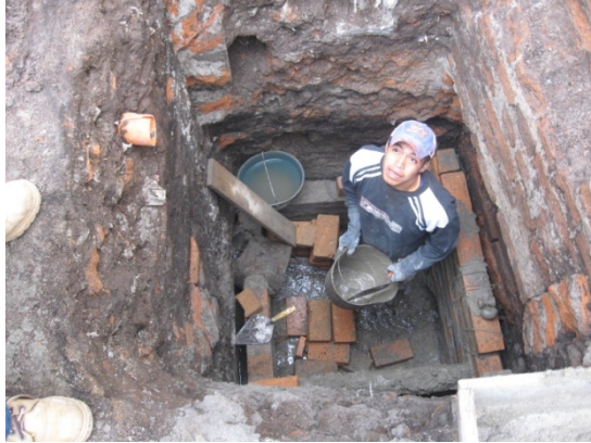
Fotografía 26. Construcción caja de inspección
