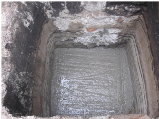
Fotografía 15. Solado concreto 1:3:5 (concreto pobre)
