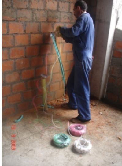
Fotografía 65. Regatas para instalaciones eléctricas
