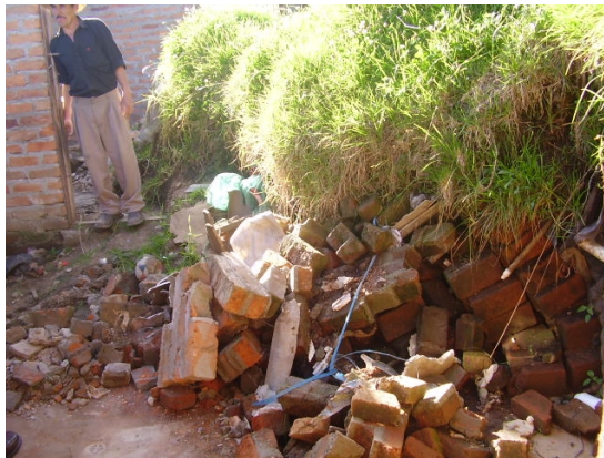
Fotografía 132. Muro colapsado
