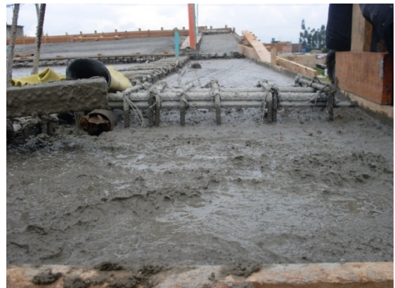
Fotografías 105 Y 106. Fundición losa
