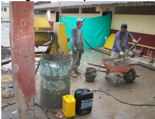
Fotografía 82. Preparación mezcla
