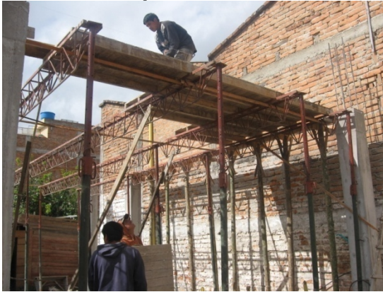
Fotografía 42. Instalación formaleta para losa.
