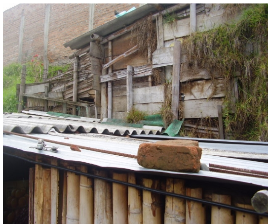
Fotografía 129. Cubierta provisional
