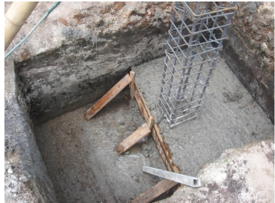
Fotografías 20 y 21. Zapatas fundidas
