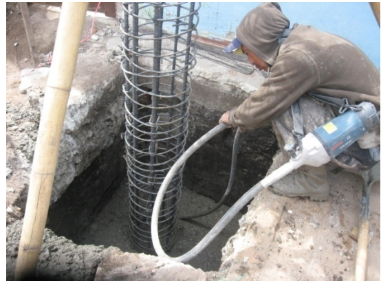
Fotografías 20 y 21. Zapatas fundidas
