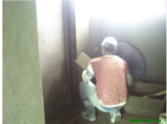
Fotografía 108. Pañetes en muros Interiores
