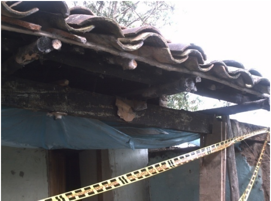
Fotografía 148, 149, 150, 151 Y 152. Asentamiento de muro por desestabilización de Talud
