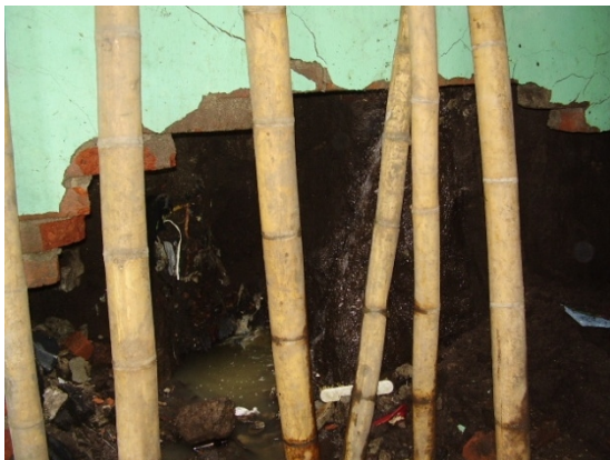
Fotografía 140. Muro colapsado
