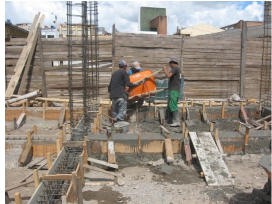
Fotografía 31. Fundición vigas de cimentación.
