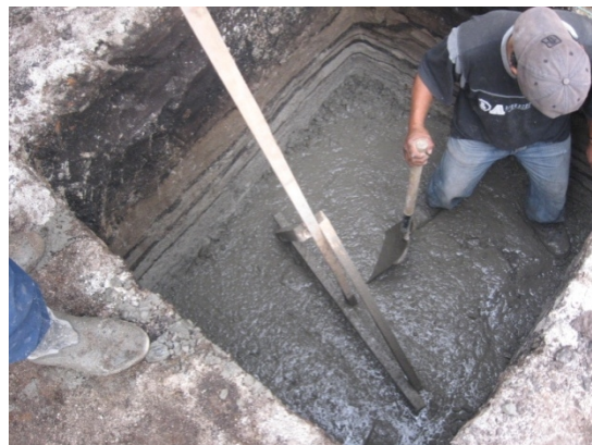
Fotografías 16 y 17. Concreto ciclópeo
