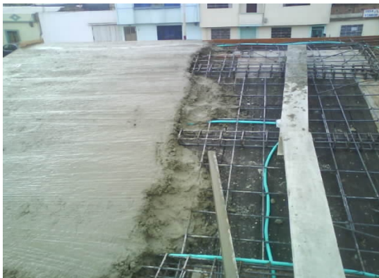
Fotografías 105 Y 106. Fundición losa
