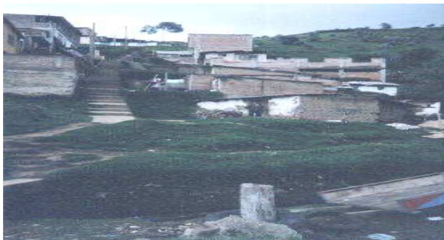
Figura 12. Viviendas cuyo material predominante es latas y cartón, sector ojo de agua, Comuna 10. Municipio de Pasto.
