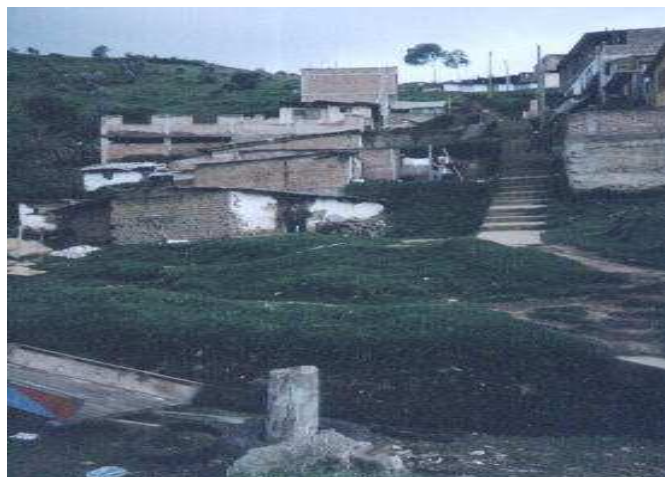
Figura 2. Viviendas ubicadas en áreas de alto riesgo
