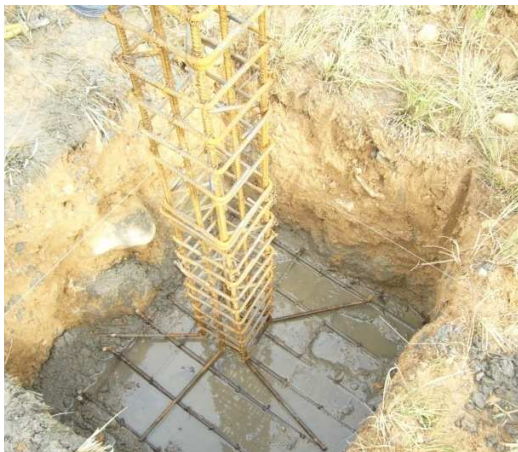
Fig. 35 Parrilla de refuerzo zapata sobre solado
