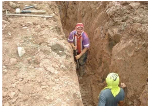
Fig. 53 Excavaciones de tipo manual
