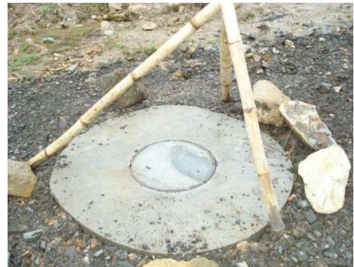
fig. 58 Aspecto en planta cámara finalizada
