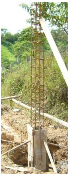
Fig. 41 Refuerzo columnas
