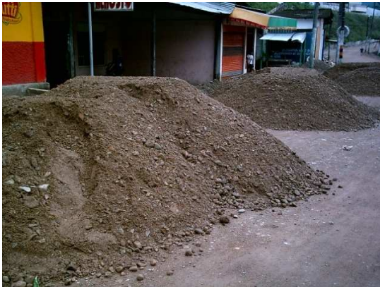
Fig. 72 Material dispuesto para subbase
