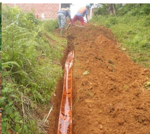
Fig. 2 Relleno con material de sitio
