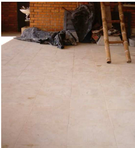
Fig. 49 Enchape de piso en cerámica tráfico 5
