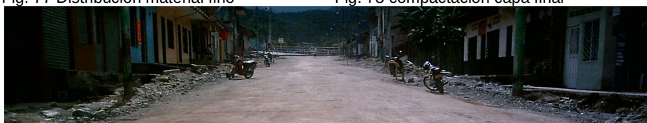
Fig. 79 Aspecto final subbase
