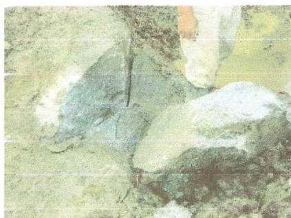
Ruptura de piedras manualmente
