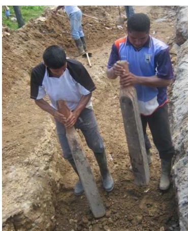
Fig. 61 Relleno final compactado manualmente
