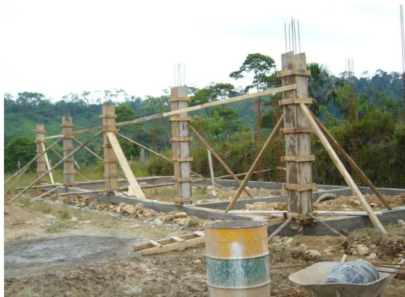
Fig. 42 Columnas con formaleta y apuntaladas
