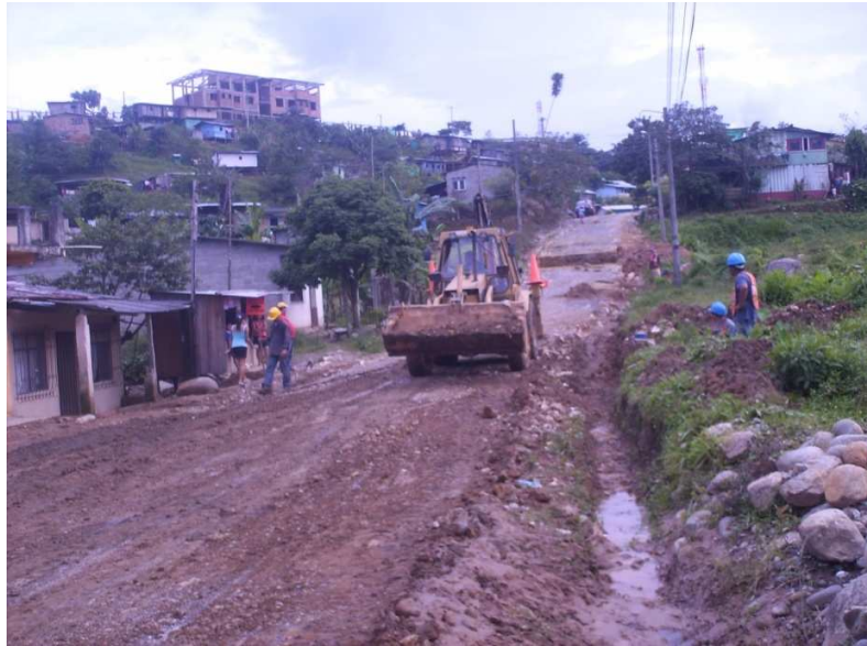
Fig. 7 Apertura de cunetas y desalojo de material
