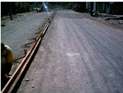
Fig. 82 Colocación formaleta longitudinal
