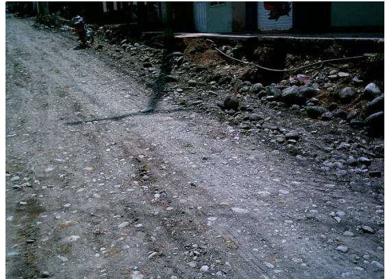
Fig. 73 Aspecto perfilado y compactado de la vía
