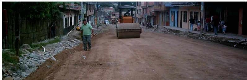
Fig. 75 Compactación vibrocompactador
