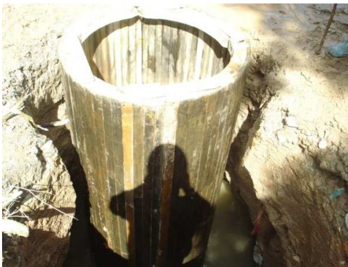
Fig. 57 Aspecto cámara con formaleta posterior al fundido
