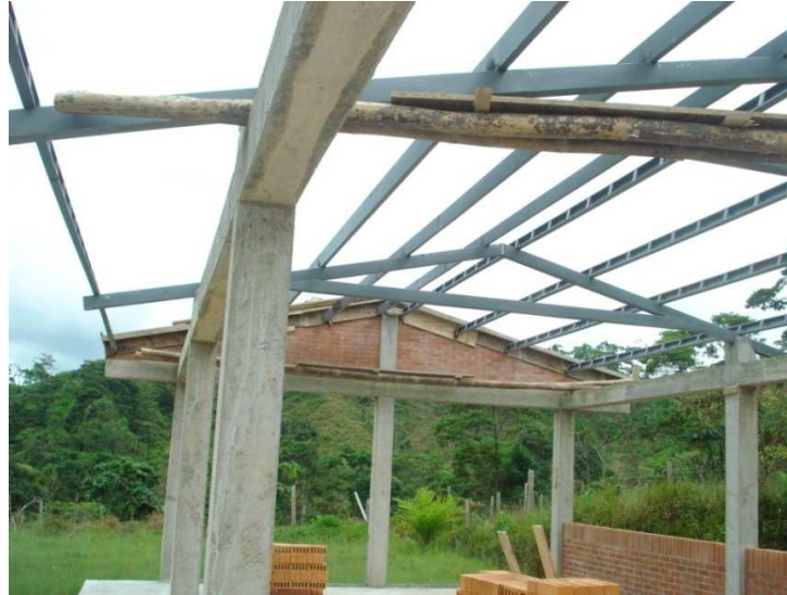
Fig. 45 Cercha metálica y correas
