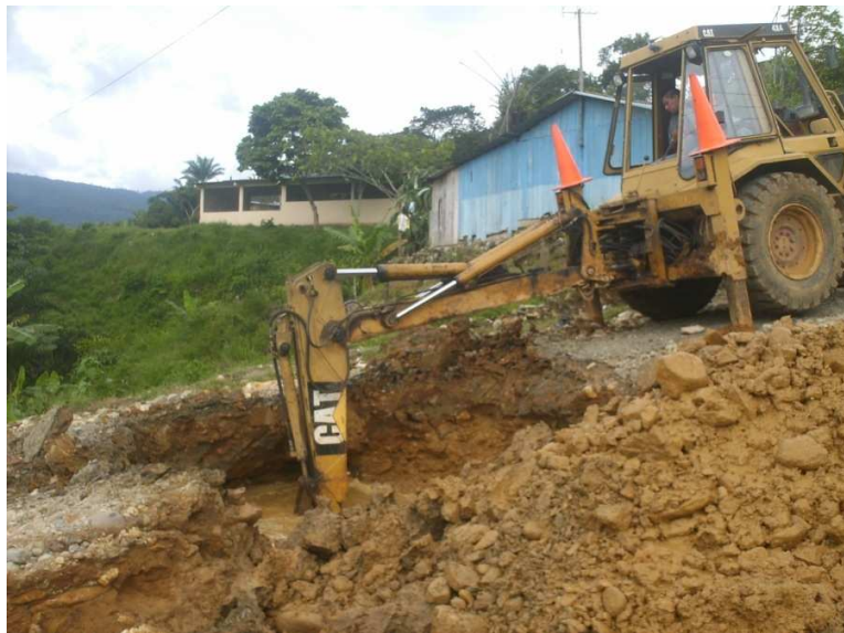
Fig. 6 Destape con retroexcavadora
