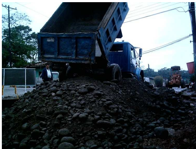
Fig. 71 Material para pedraplen para mejora de subrasante
