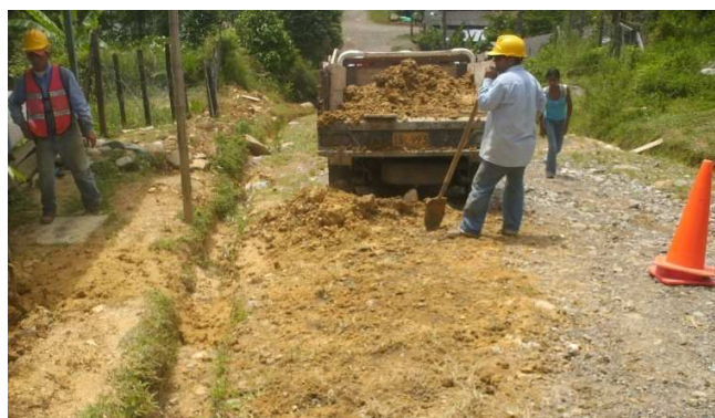
Fig. 3 Limpieza y recolección de escombros
