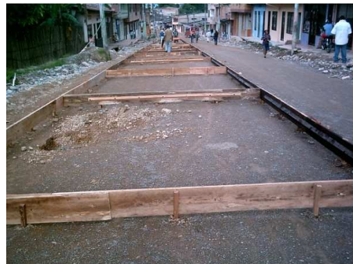
fig. 83 Colocación formaleta para división de placas
