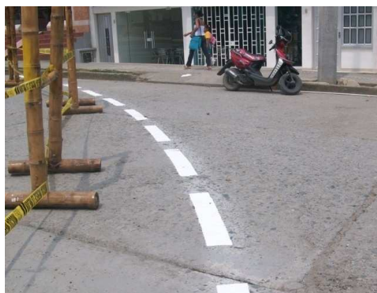
Fig. 31 Delineación de obstáculos para líneas de pare
