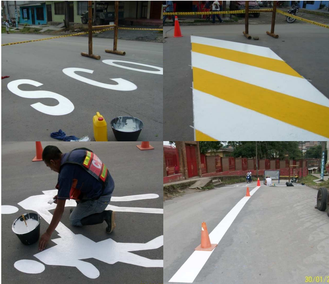
Fig. 22 Pintura letras, pictogramas, líneas de eje y franja de reducción de velocidad
