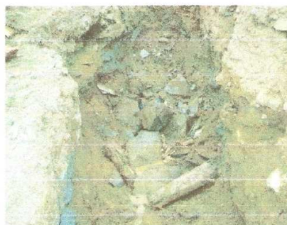
voladura de piedras con explosivos
