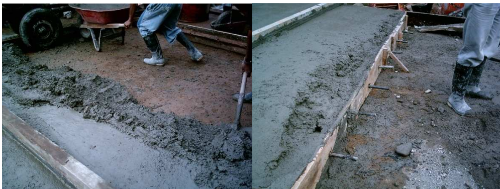
Fig. 86 Vaciado del concreto
