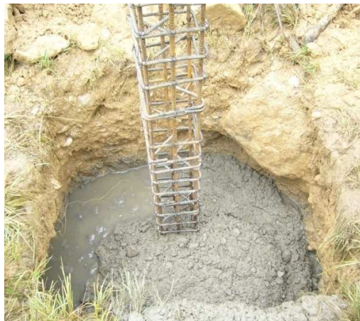
Fig. 36 Fundición de zarpa en concreto de 3000 PSI
