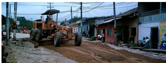
Fig. 74 Distribución de material para subbase
