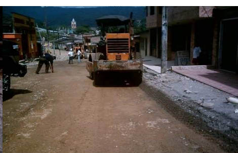
Fig. 78 compactación capa final
