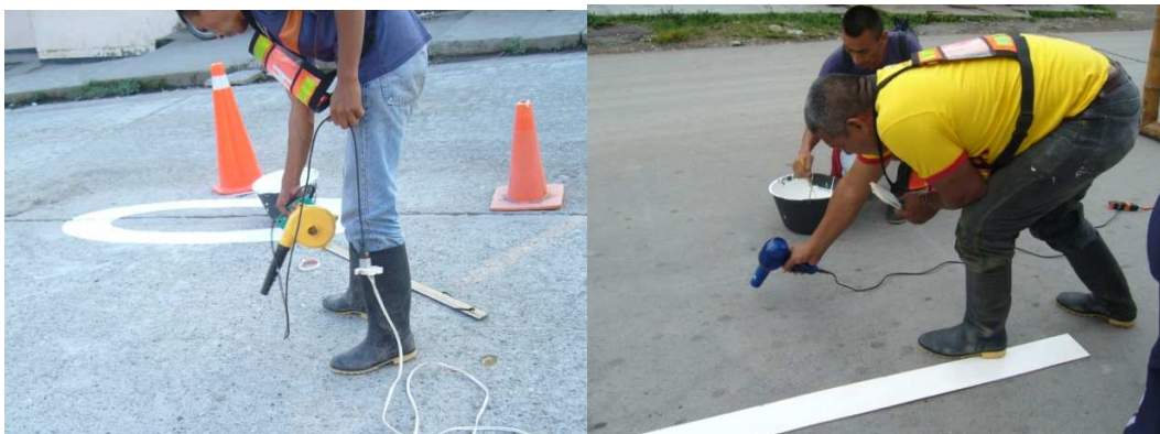
Fig. 18 Secado de superficie húmeda y eliminación de polvo
