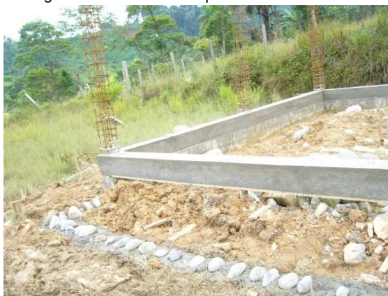
Fig. 38 Concreto ciclópeo
