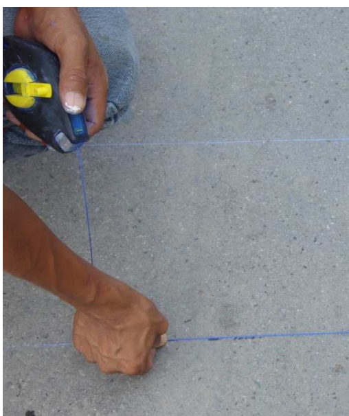
Fig. 19 Demarcación de franjas con cimbra
