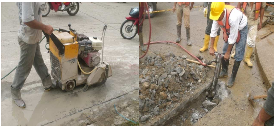
Fig. 8 Corte con cortadora mecánica y demolición con martillo hidráulico
