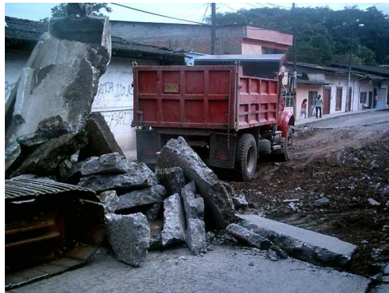
Fig. 70 Desalojo de material de excavación y demolición
