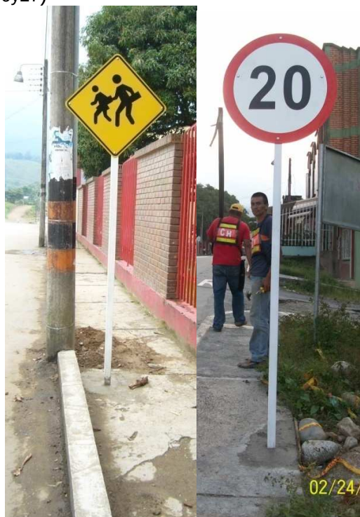
Fig. 27 Señales verticales instaladas
