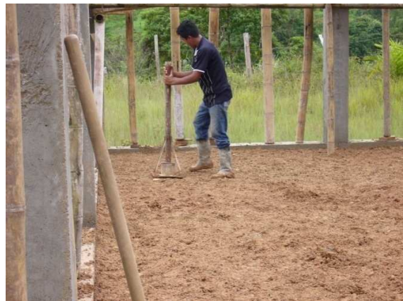
Fig. 40 Compactación manual con pisón
