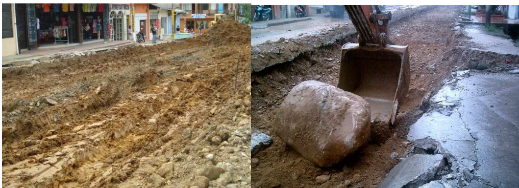
Fig. 69 Excavaciones con retroexcavadora
