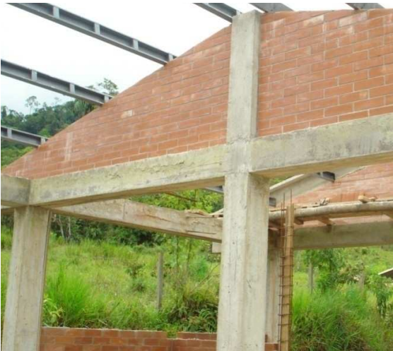
Fig. 46 Ladrillo visto para tímpanos
