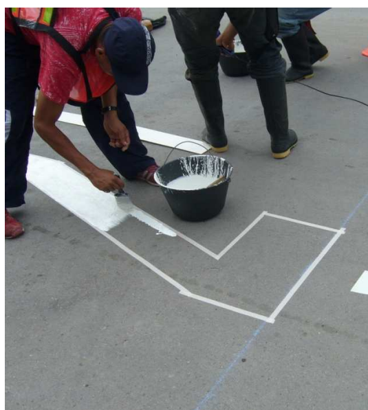
Fig. 20 Demarcación de letras con cinta de enmascarar
