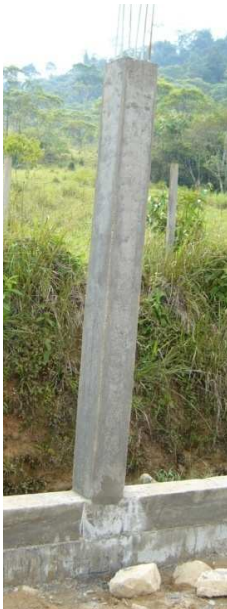
Fig. 43 Columna fundida
