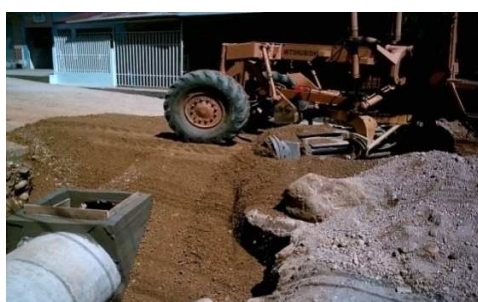
Fig. 77 Distribución material fino
