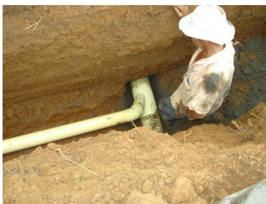
Fig. 60 Conexión domiciliar con silla yee de 8" a 4"
