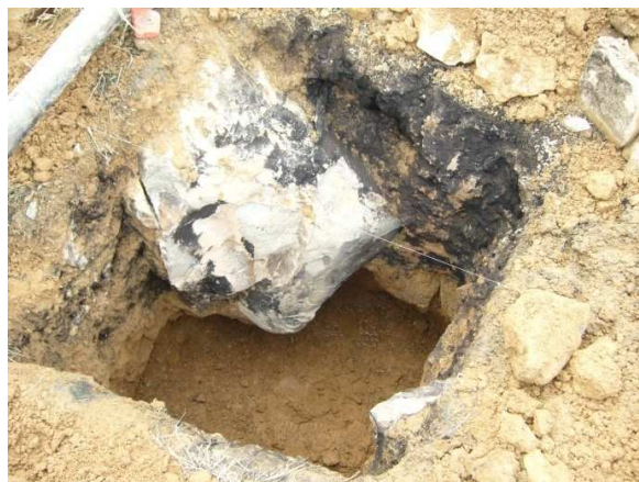
Fig.34 Quema de piedras en el proceso de excavación
