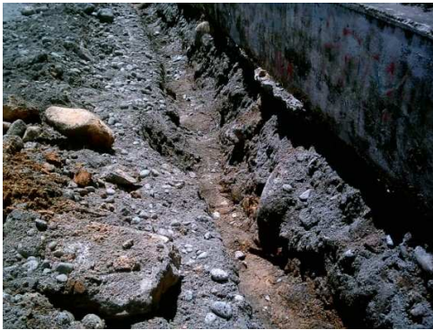
Fig. 80 Cajeo para pedraplen
