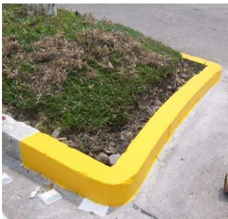
Fig. 30 Delineación de obstáculos sobre bordillos
