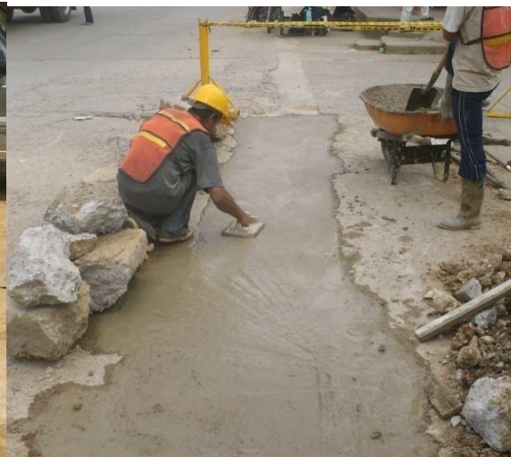
Fig. 10 Reposición de pavimento y acabado final
