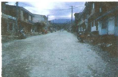
Subbase terminada previo capa fina
