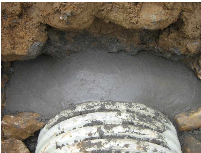
Fig. 59 Empalme con mortero impermeabilizado
