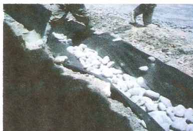
Filtro con geotextil y piedra
