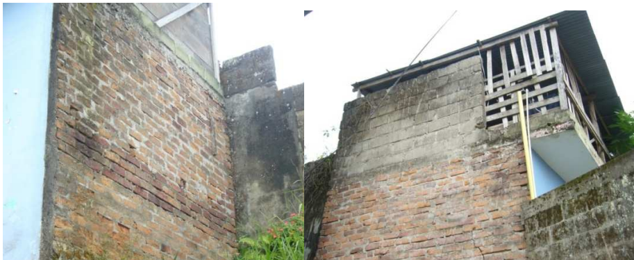
Fig. 14. Vista lateral vivienda colindante
