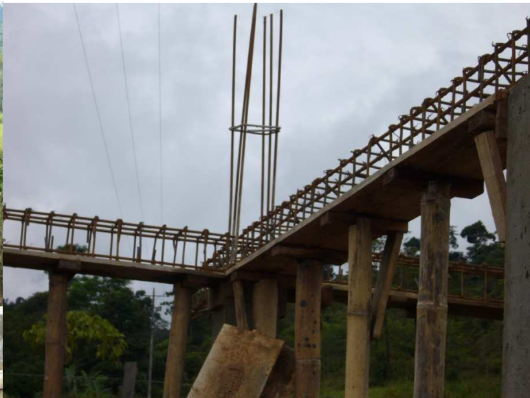
Fig. 44 Apuntalamiento y refuerzo de vigas aéreas
