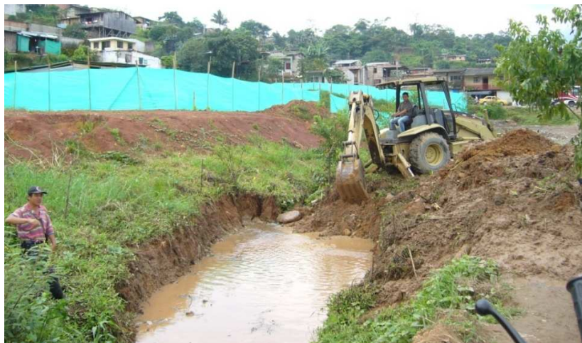
Fig. 13 Excavación para canalización
