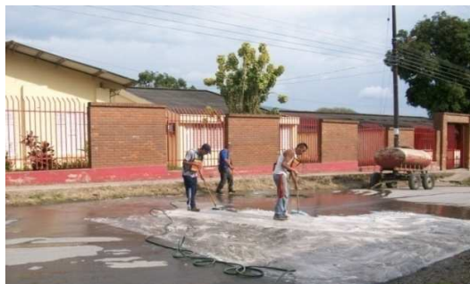
Fig. 17 Lavado con agua y detergente
