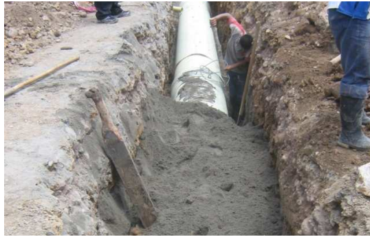
Fig. 56 Capa final con arena de rio posterior a atraque y relleno inicial
