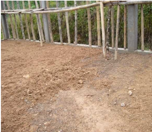
Fig. 39 Aplicación de recebo en capas e=0.10\text{cm}
