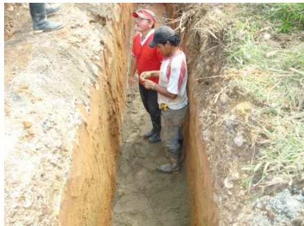
Fig. 54 Encamado con capa fina en arena de rio
