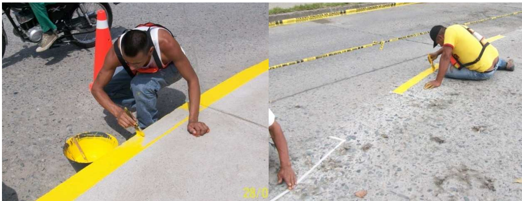
Fig. 28 Demarcación y pintura de bordillos y líneas de eje
