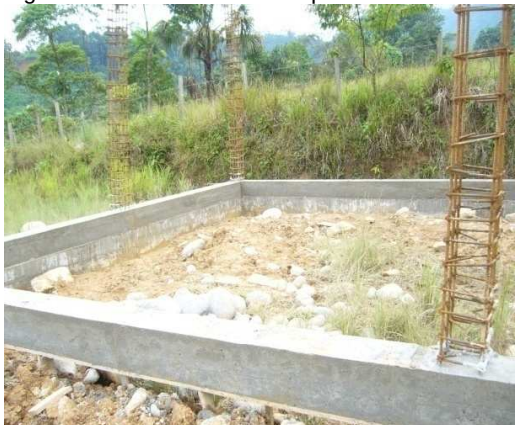
Fig. 37 Viga de cimentación fundida
