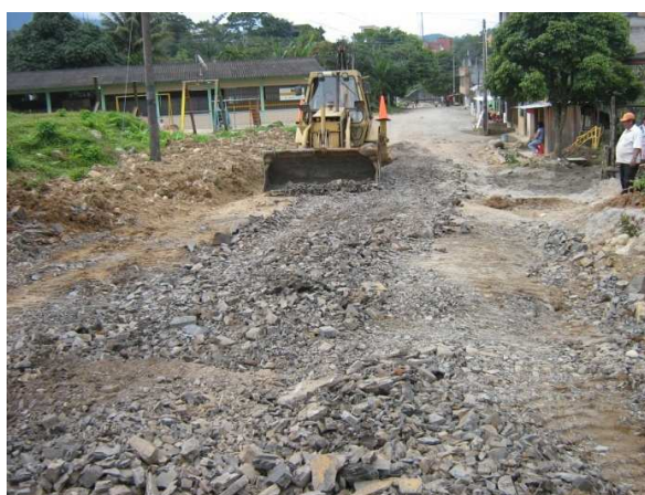
Fig.62 Riego de material seleccionado previo a la compactación
