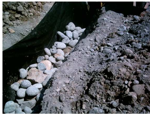
Fig. 81 Geotextil y piedra para pedraplen
