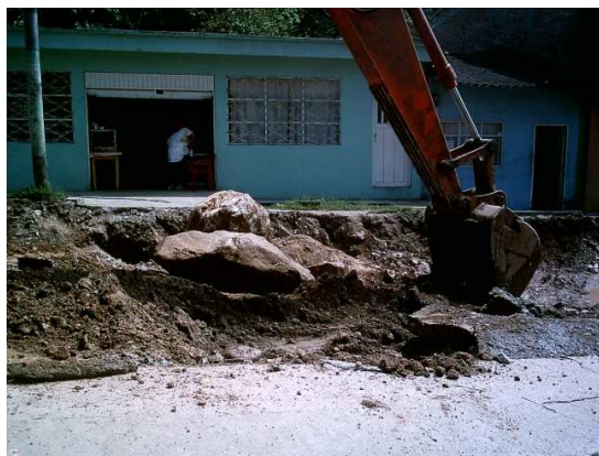
Fig. 68 Demolición con retroexcavadora
