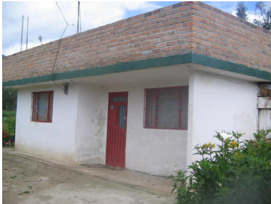
Figura 13. Vivienda que se pretende ampliar
