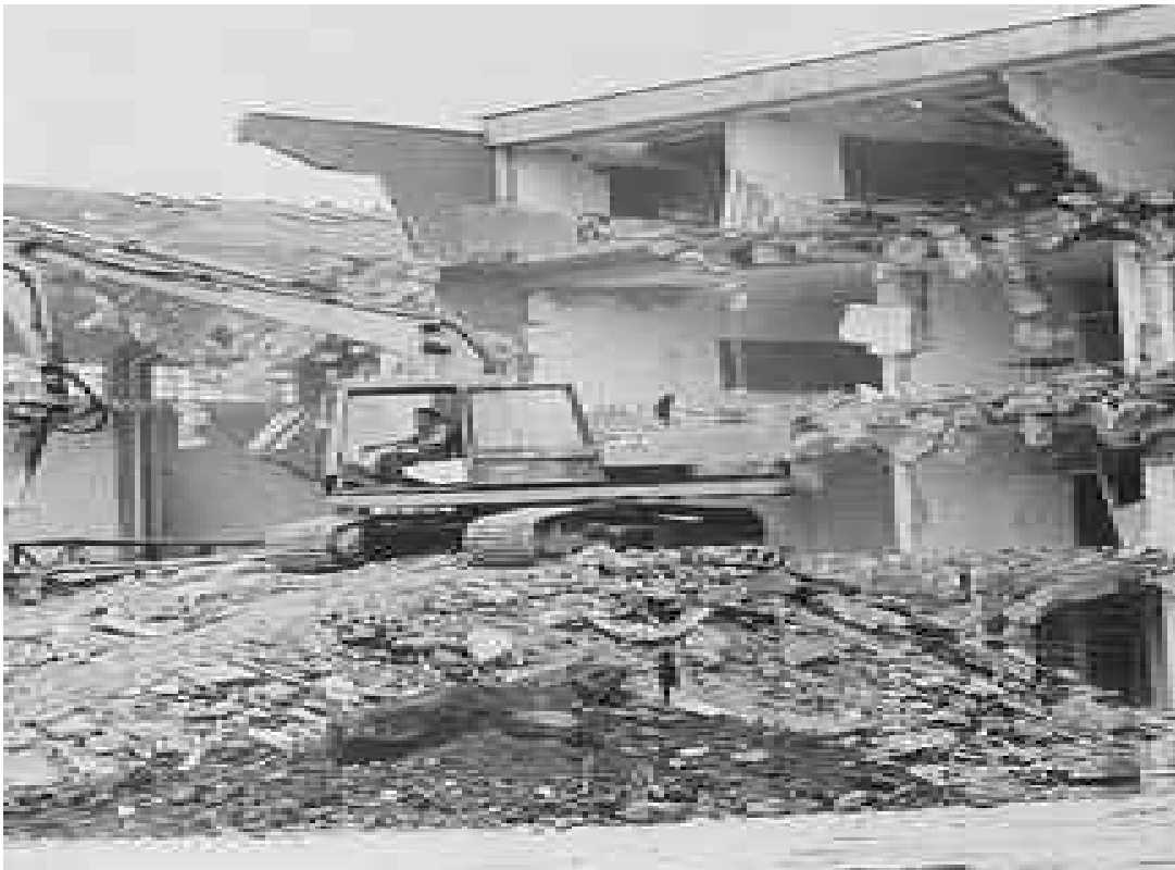
Figura 1. Remoción de escombros dejados por el sismo del Eje Cafetero. FUENTE: Internet
